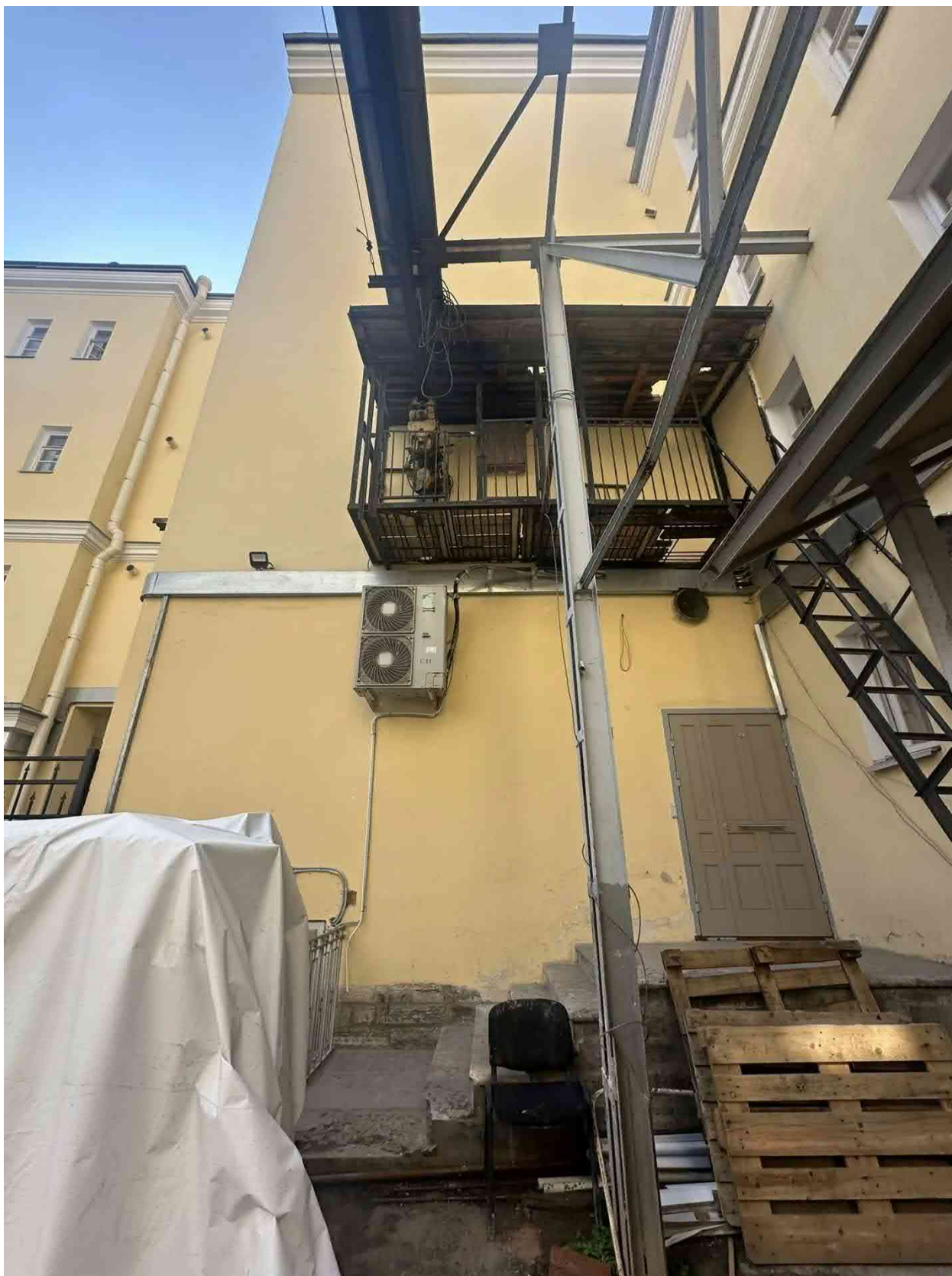
Фото 3. Установленный наружный блок кондиционера на дворовом фасаде здания театра
