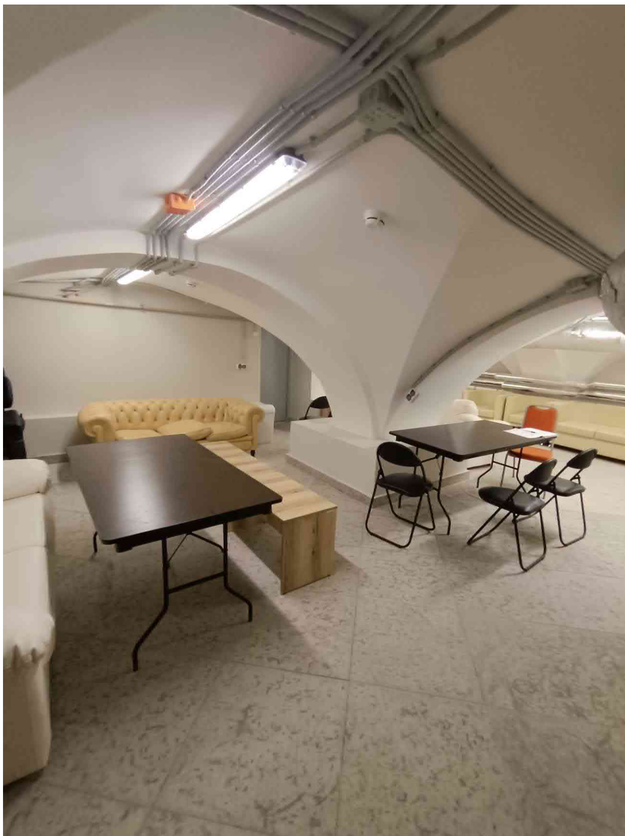
Фото 7. Помещение F 60 (помещение оркестра), в котором устанавливается внутренний блок кондиционера
