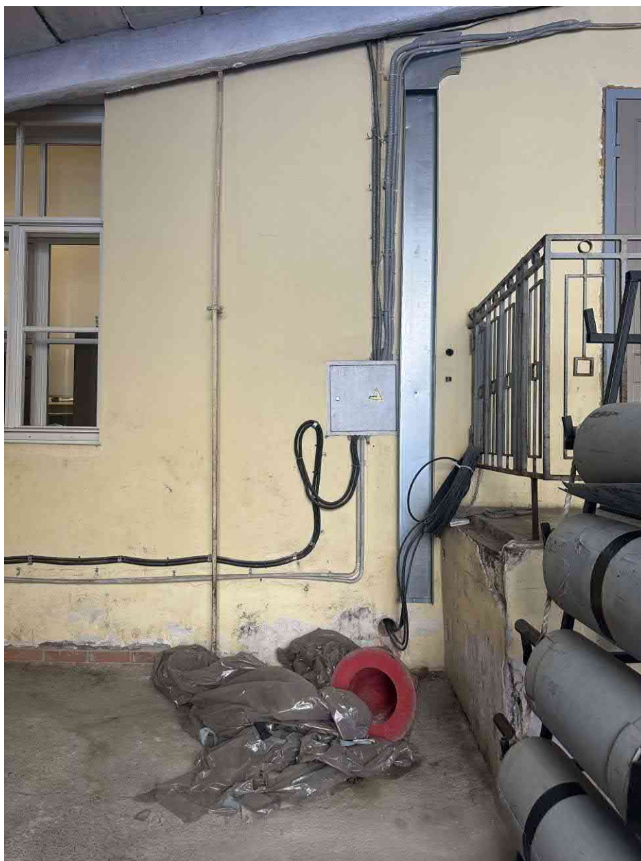
Фото 2. Предлагаемое место установки наружного блока кондиционера на дворовом фасаде здания театра
