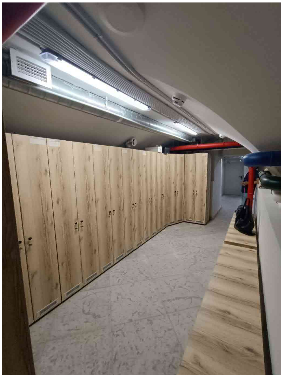
Фото 8. Помещение Е 47 (помещение оркестра), в котором устанавливается внутренний блок кондиционера
