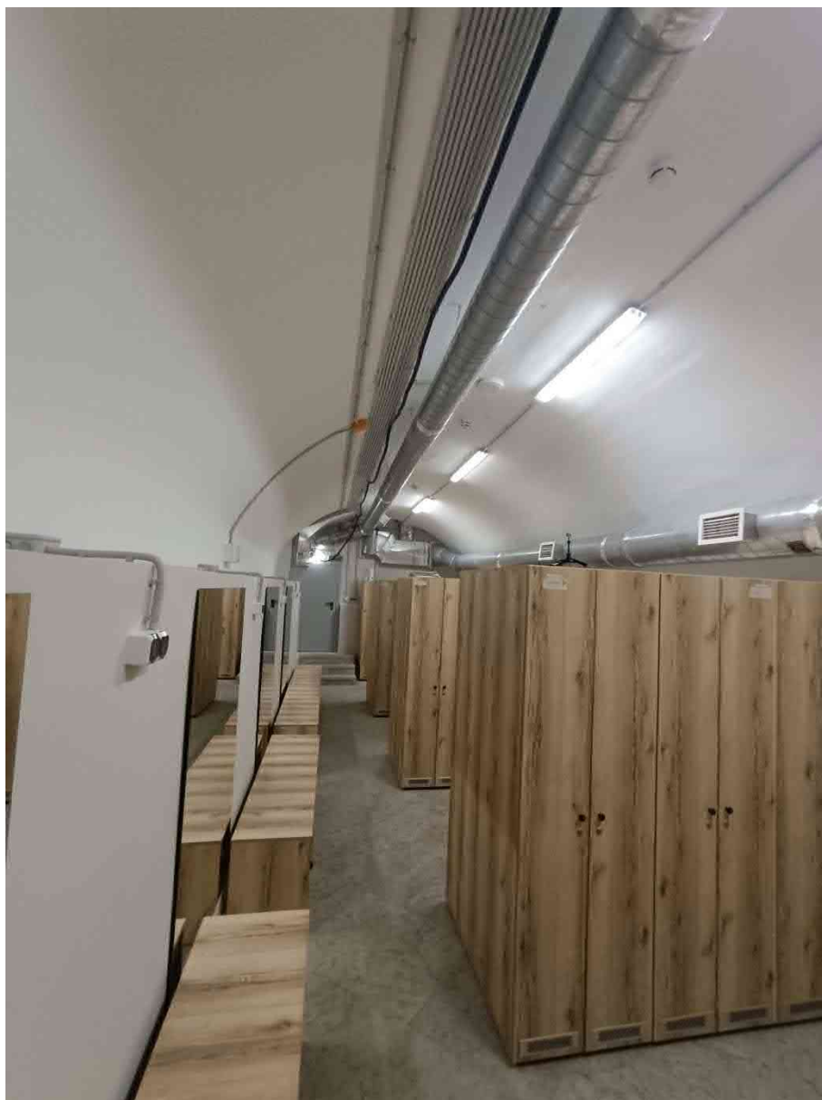
Фото 9. Помещение Е 47.1 (помещение оркестра), в котором устанавливается внутренний блок кондиционера
