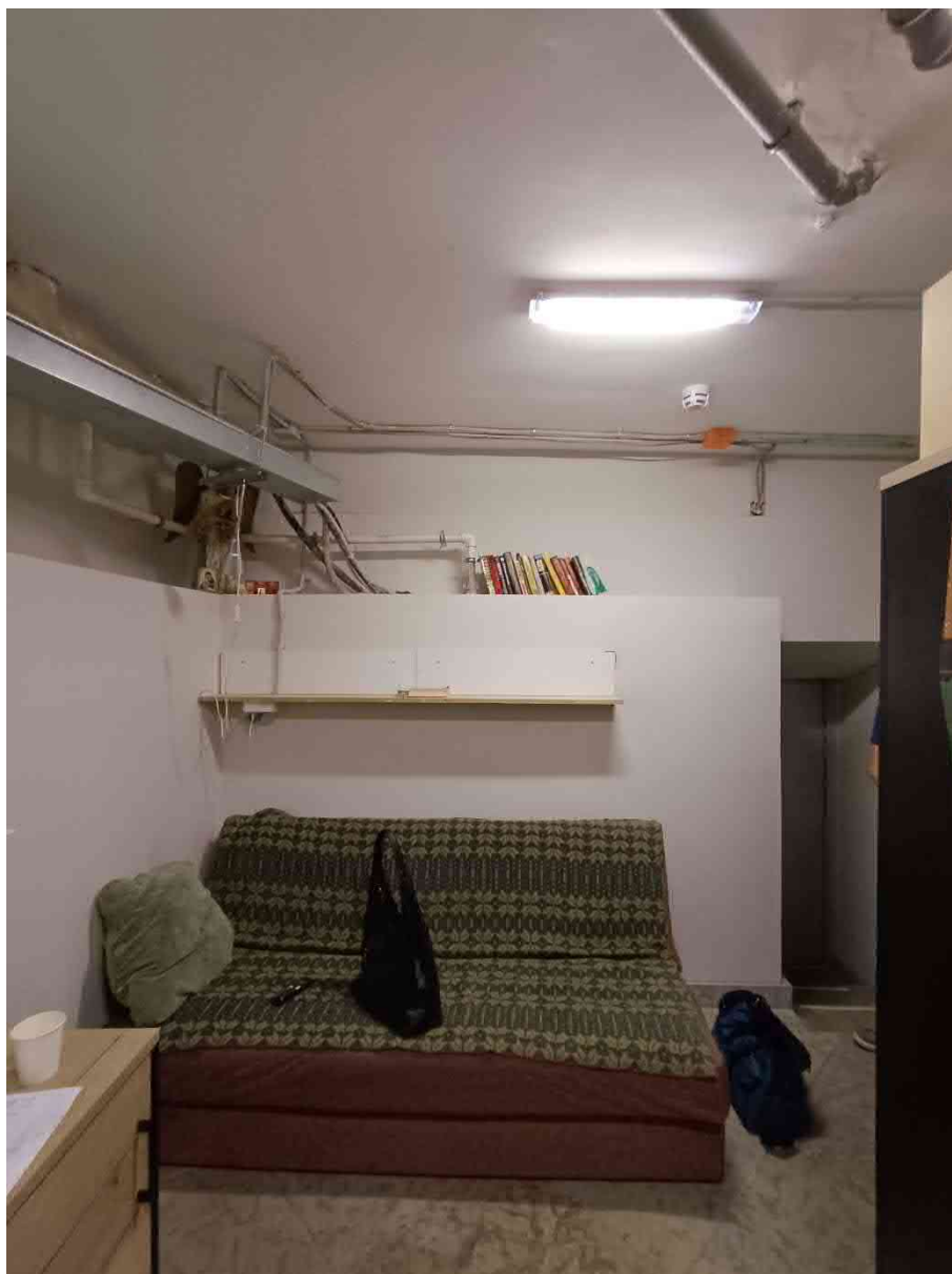
Фото 10. Помещение F 70 (помещение сантехников), в котором устанавливается внутренний блок кондиционера
