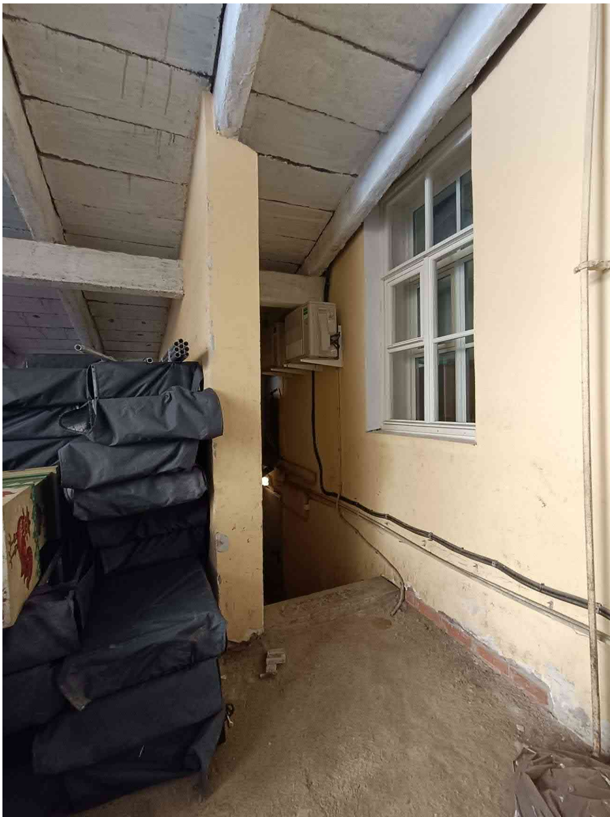
Фото 4. Установленные наружные блоки кондиционеров на дворовом фасаде здания театра
