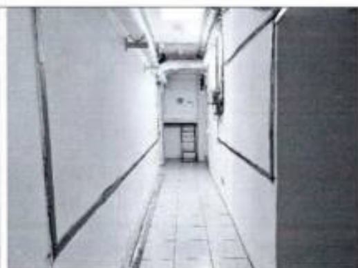
Фото 45. Помещение подвала (2-Н (76)) (фото от 05.09.2022).
