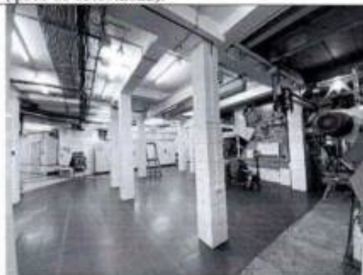
Фото 29. Помещение подвала (2-Н (21) (фото от 12.05.2022).
