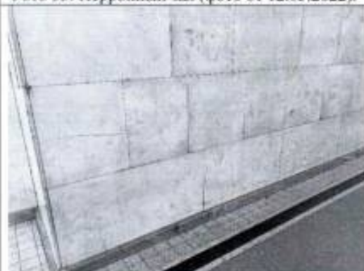
Фото 35. Перронный зал (фото от 12.05.2022).
