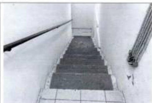
Фото 19. Лестница (пом. 2-Н (50)) (фото от 12.05.2022).
