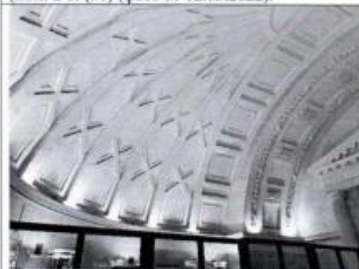
Фото 53. Помещение эскалаторного зала (пом. 2-Н (31) (фото от 12.05.2022).
