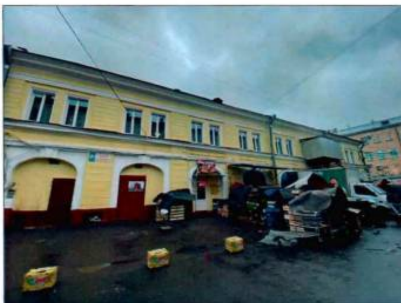
11. Фрагмент восточного фасада части объекта культурного наследия.
