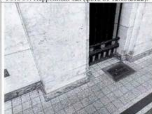
Фото 41. Перронный зал (фото от 12.05.2022).
