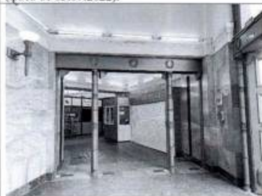
Фото 47. Помещение вестибюля (пом. 2-Н (1)) (фото от 12.05.2022).
