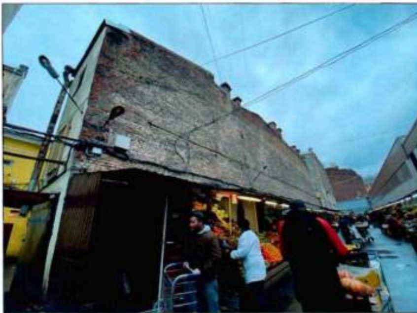
15. Северо-восточный фасад части объекта культурного наследия.
