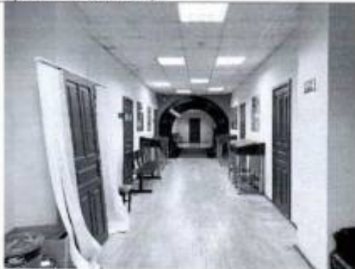
Фото 71. Помещение 3 этажа (пом. 8-Н (1)) (фото от 12.05.2022).
