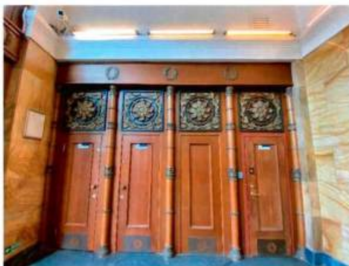
8. Помещение вестибюля объекта культурного наследия. Фото от 12.05.2022.
