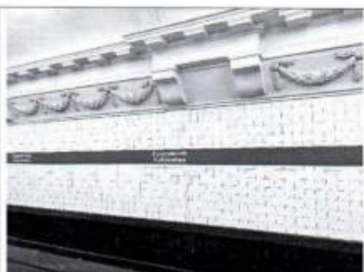
Фото 38. Перронный зал (фото от 12.05.2022).
