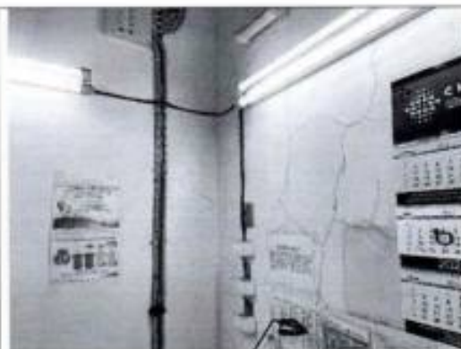
Фото 56. Помещение 1 этажа (пом. 2-Н (5) (фото от 12.05.2022).
