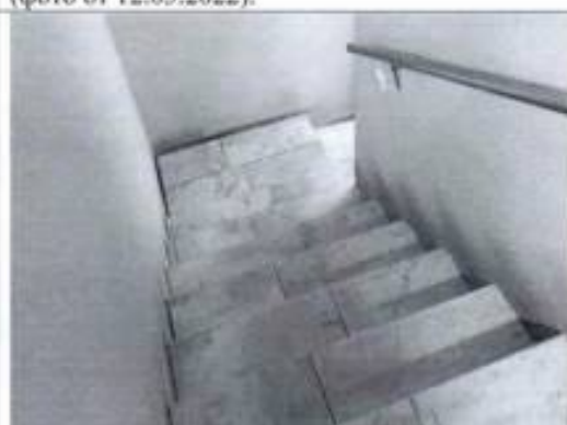
Фото 22. Лестница (пом. 3-Н (1)) (фото от 12.05.2022).
