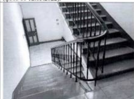
Фото 21. Лестница (1ЛК) (фото от 12.05.2022).
