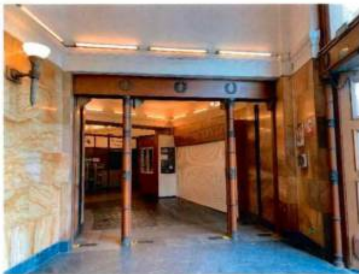
7. Помещение вестибюля объекта культурного наследия. Фото от 12.05.2022.
