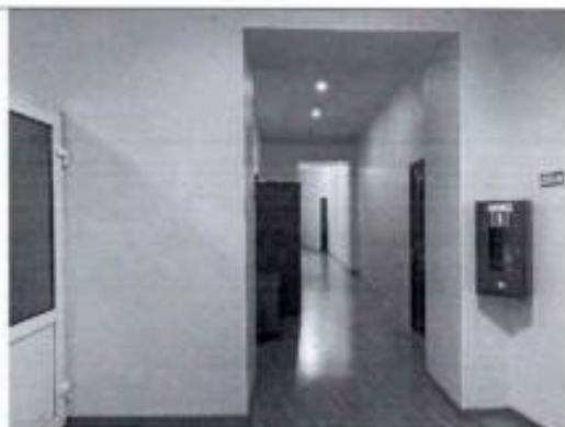
Фото 61. Помещение 2 этажа (пом. 7-Н (18)) (фото от 12.05.2022).
