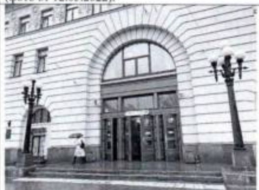
Фото 6. Крыльцо со стороны северо-западного фасада (фото от 12.05.2022).
