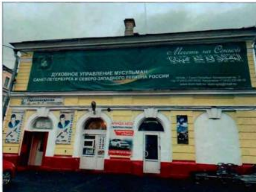
10. Южный фасад части объекта культурного наследия.
