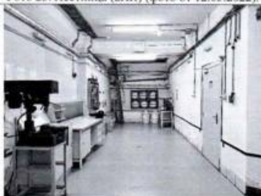
Фото 27. Помещение подвала (2-Н (61) (фото от 05.09.2022).
