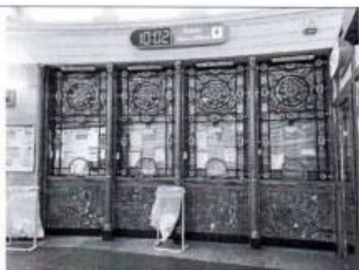
Фото 50. Помещение вестибюля (пом. 2-Н (8) (фото от 12.05.2022).
