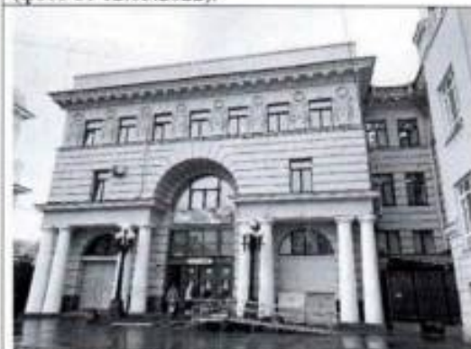
Фото 5. Юго-восточный фасад (фото от 12.05.2022).
