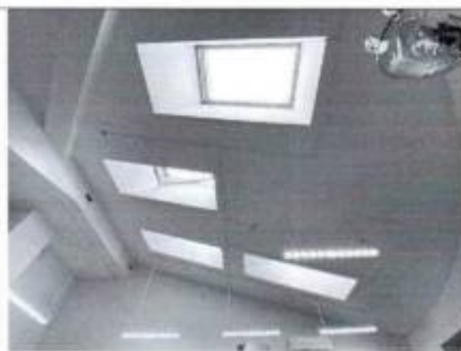
Фото 79. Помещение мансардного этажа (фото от 12.05.2022).
