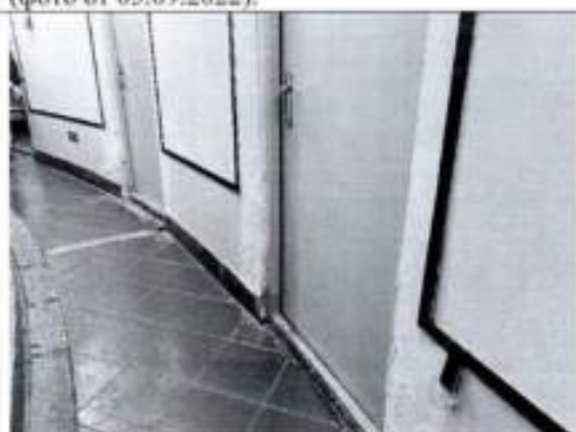
Фото 46. Помещение подвала (2-Н (64)) (фото от 05.09.2022).
