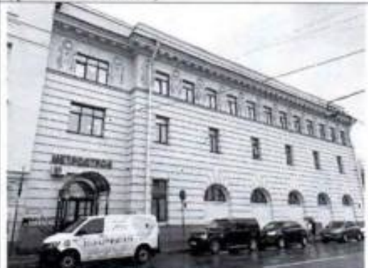
Фото 4. Северо-восточный фасад (фото от 12.05.2022).
