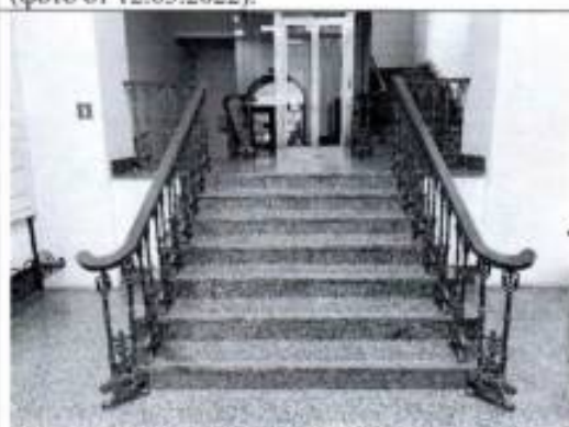
Фото 24. Лестница (пом. 2ЛК (2)) (фото от 12.05.2022).
