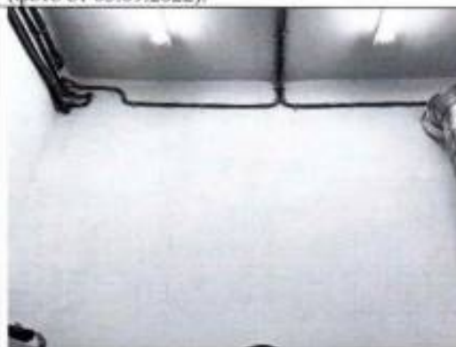
Фото 30. Помещение подвала (2-Н (65) (фото от 12.05.2022).
