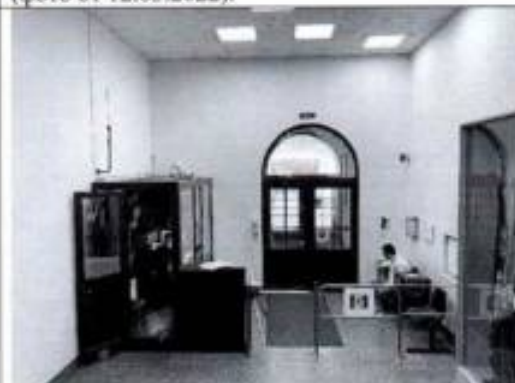
Фото 58. Помещение 1 этажа (пом. 2/ПК (2) (фото от 12.05.2022).
