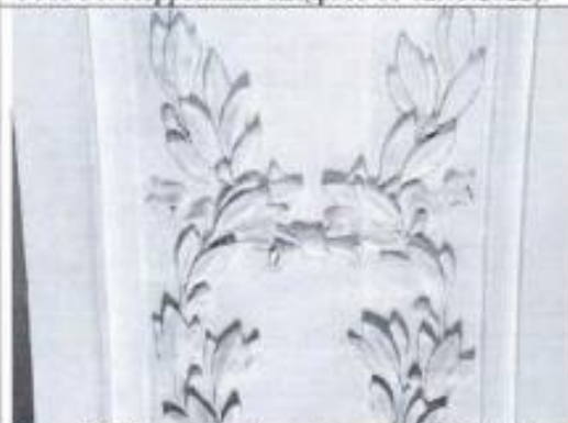
Фото 33. Перронный зал (фото от 12.05.2022).
