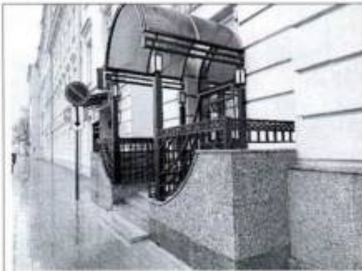
Фото 7. Крыльцо со стороны северо-восточного фасада (фото от 12.05.2022).
