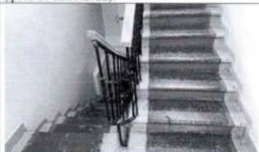
Фото 18. Лестница (пом. 2-Н (25) (фото от 12.05.2022).
