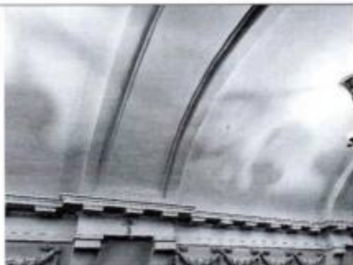
Фото 32. Перронный зал (фото от 12.05.2022).
