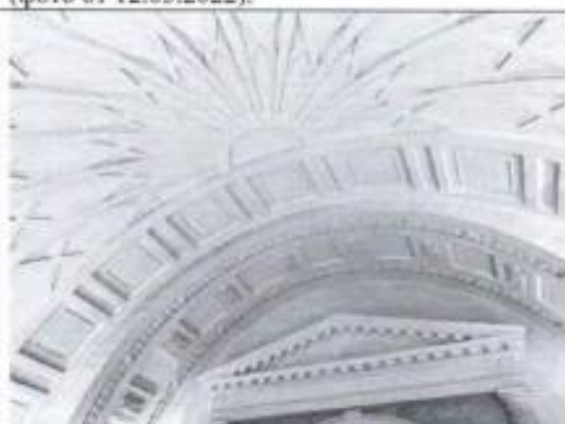
Фото 52. Помещение эскалаторного зала (пом. 2-Н (31) (фото от 12.05.2022).
