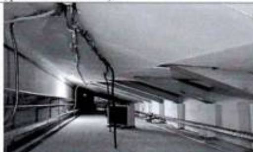
Фото 17. Фрагмент конструкции крыши (фото от 12.05.2022).
