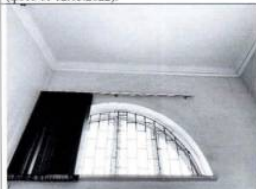
Фото 57. Помещение 1 этажа (пом. 2-Н (45) (фото от 12.05.2022).
