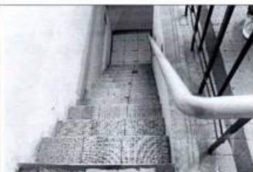
Фото 20. Лестница (пом. 2-Н (30)) (фото от 12.05.2022).
