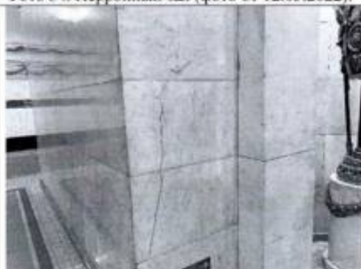
Фото 36. Перронный зал (фото от 12.05.2022).
