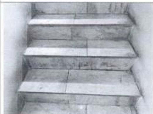
Фото 23. Лестница (пом. 3-Н (1)) (фото от 12.05.2022).
