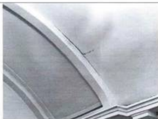
Фото 43. Перронный зал (фото от 05.09.2022).
