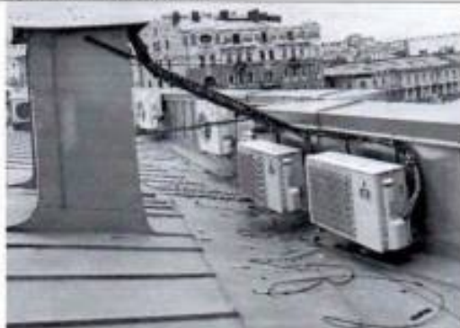
Фото 15. Фрагмент кровли (фото от 12.05.2022).
