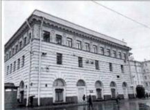
Фото 3. Юго-западный фасад (фото от 12.05.2022).
