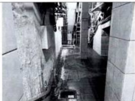
Фото 44. Помещение подвала (2-Н (21)) (фото от 05.09.2022).
