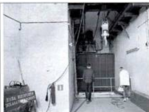
Фото 55. Помещение 1 этажа (пом. 2-Н (10) (фото от 12.05.2022).
