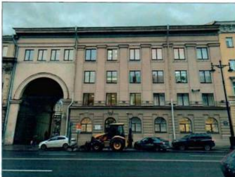
6. Западный лицевой фасад части объекта культурного наследия.
