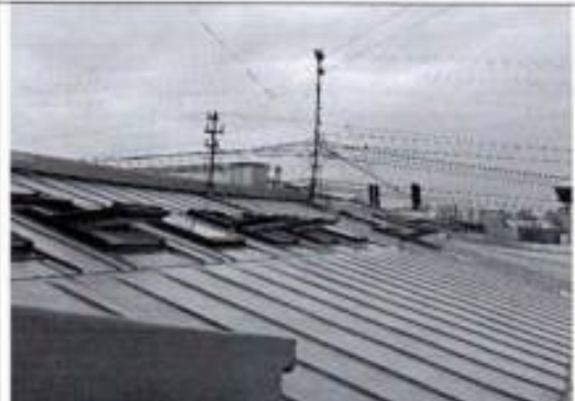
Фото 16. Фрагмент кровли (фото от 12.05.2022).
