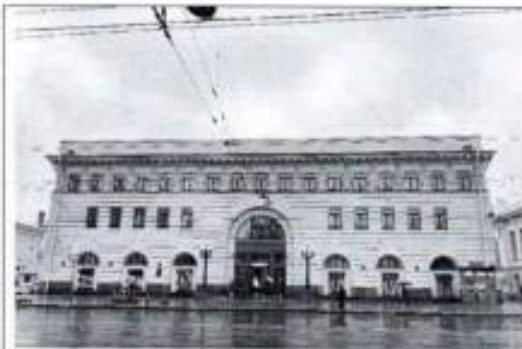
Фото 1. Северо-западный фасад (фото от 12.05.2022).
