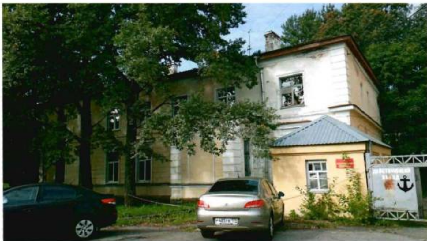
1. Восточный фасад здания
