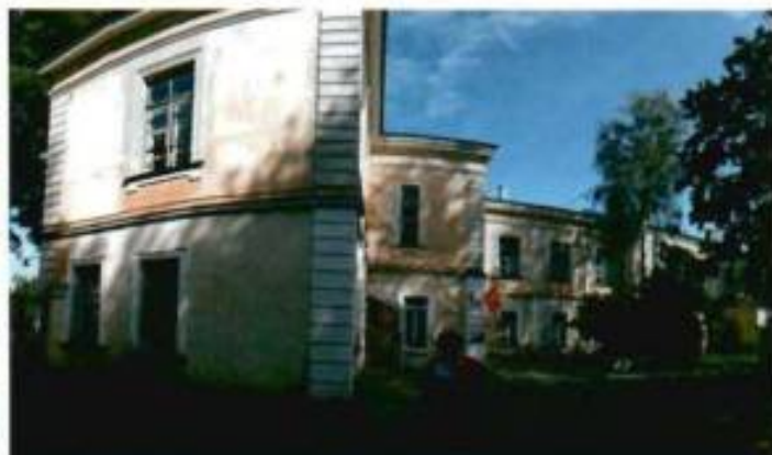
13. Южный фасад западной части здания
