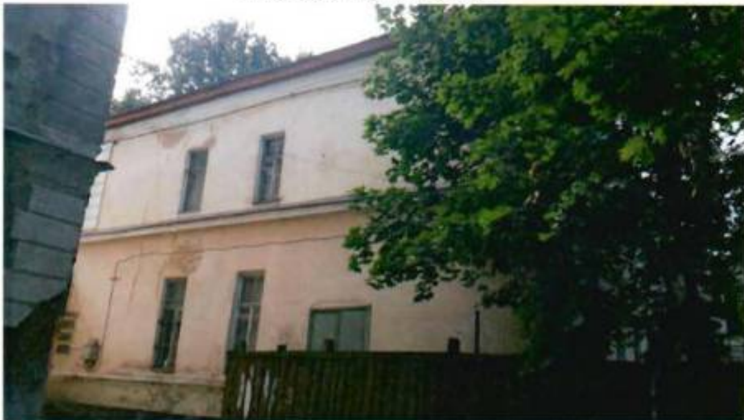
5. Северный фасад здания
