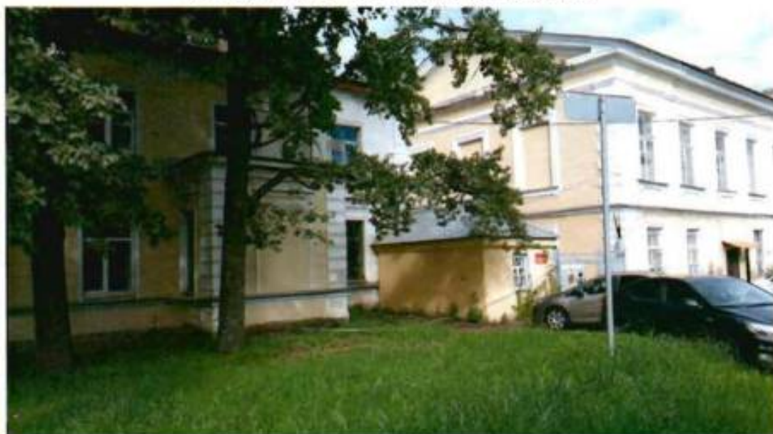
9. Вид на северо-восточную часть здания
