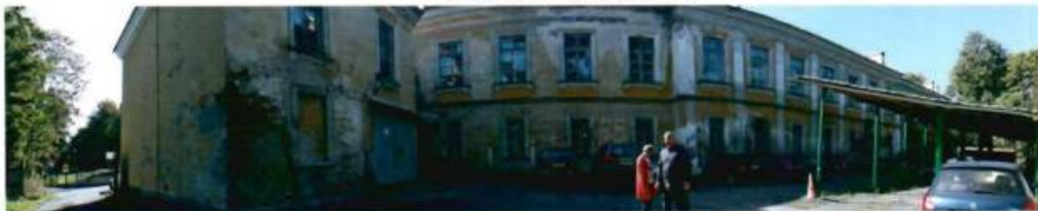
16. Северный фасад здания
