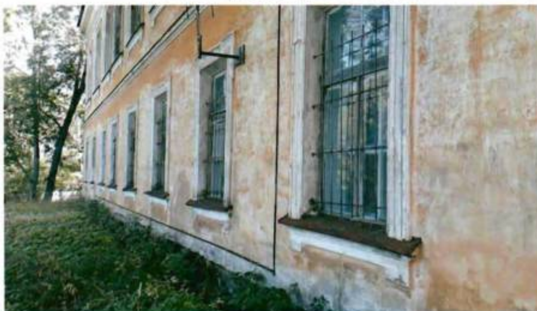
14. Западный фасад западной части здания
