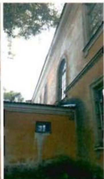
15. Северная часть фасада
