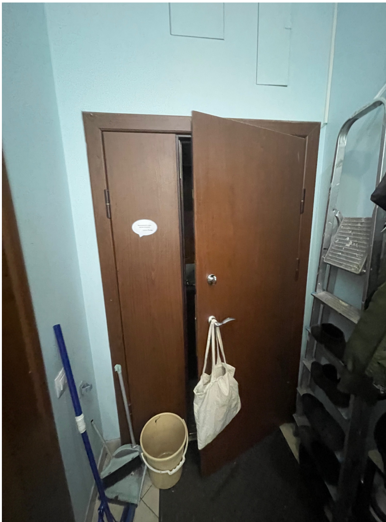
4. Входная дверь в квартиру №9 изнутри.
