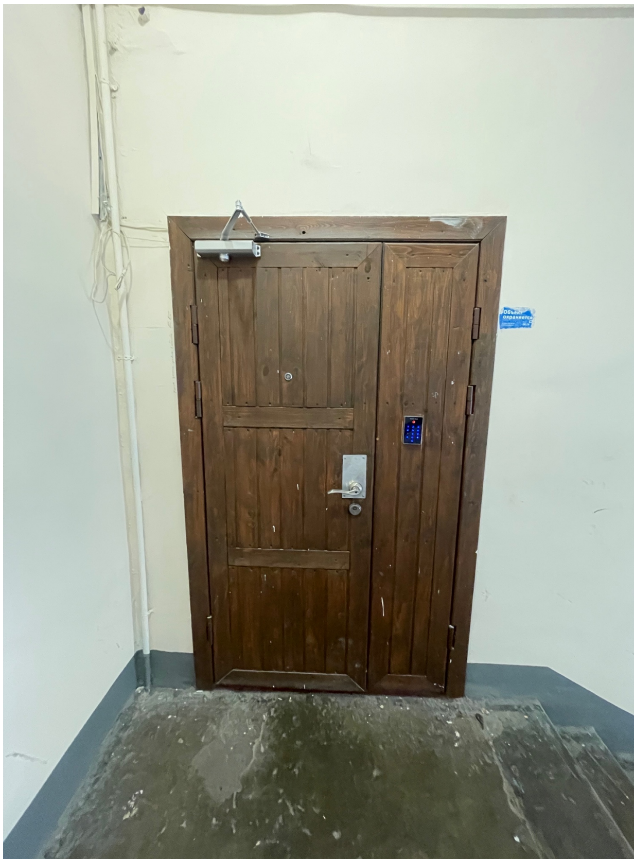
3. Входная дверь в квартиру №9.
