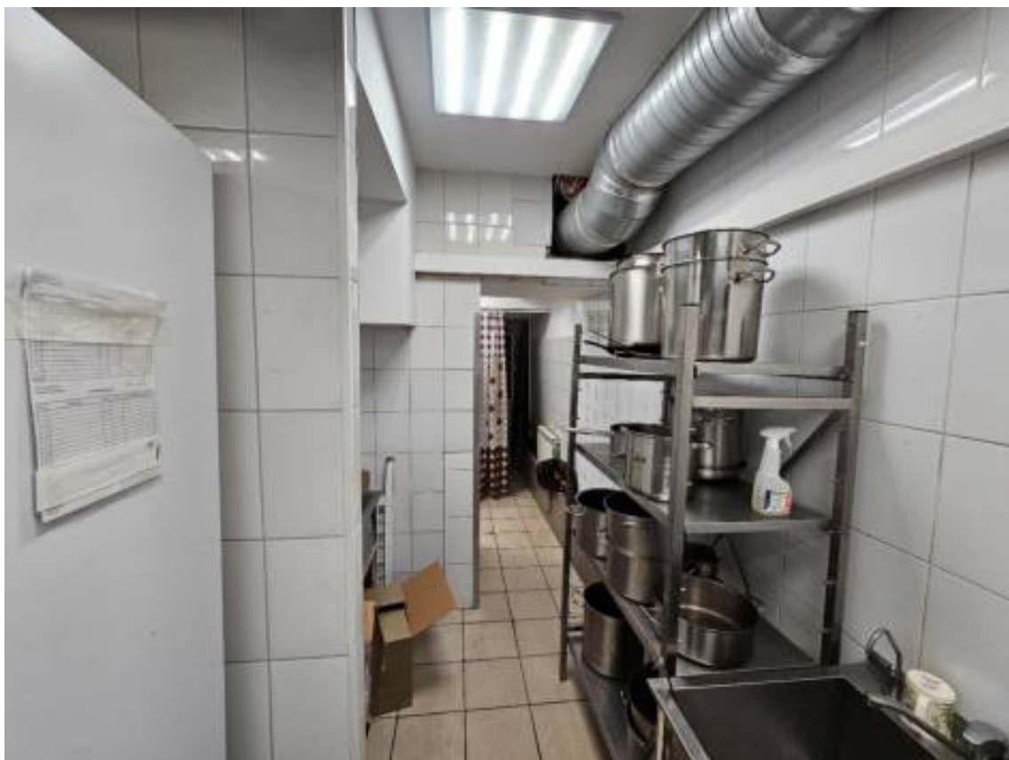
24.Выявленный объект культурного наследия «Дом Артемьевых», по адресу: г. Санкт-Петербург, Казанская ул., 34; Гривцова пер., 7. Фрагмент пом. 2-Н (6) в уровне 1-го этажа.
