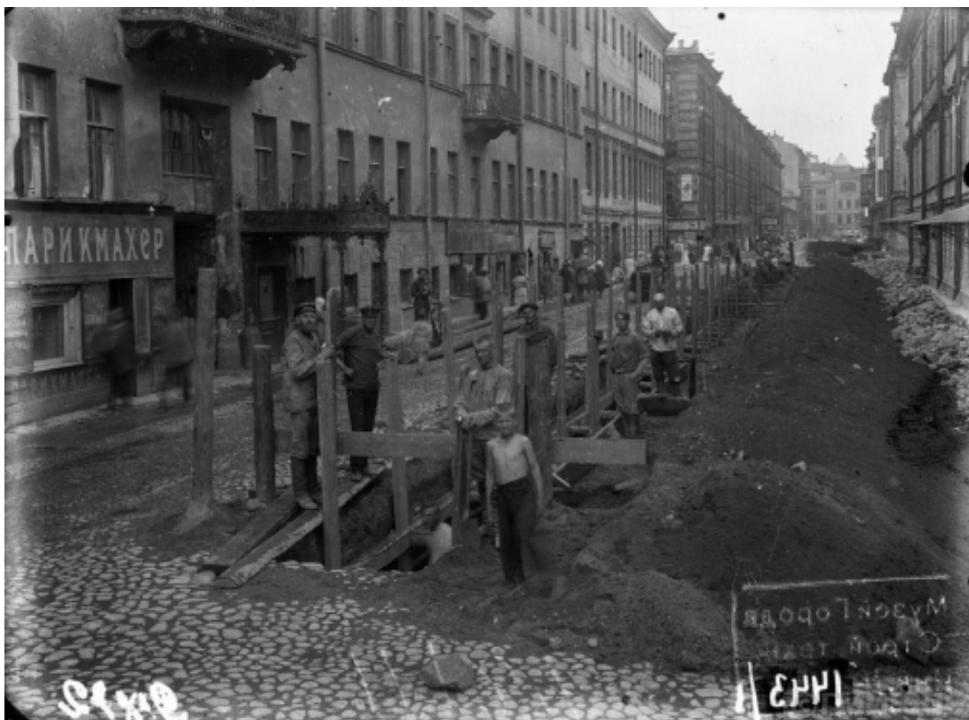
62. 1920-1930 гг. Канализационные работы в Демидовом переулке. https://goskatalog.ru/portal/#/collections?id=17737546
