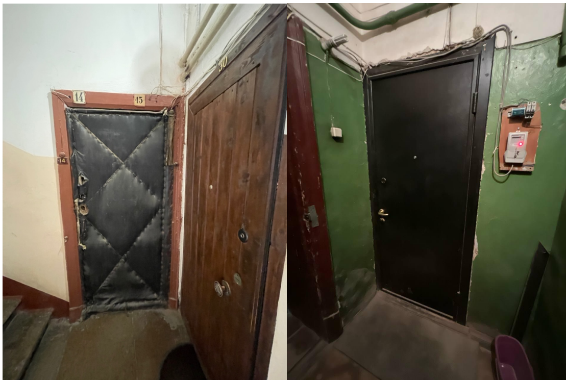
2. Вид на входную дверь в квартиру.
