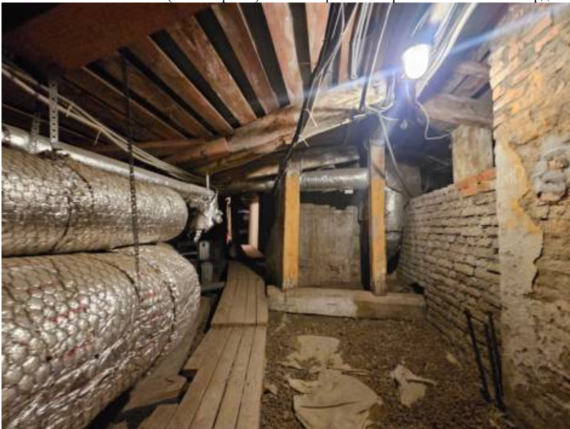
237. Объект культурного наследия федерального значения «Замок», по адресу: г. Санкт-Петербург, Садовая ул., д. 2, лит. А, в составе объекта культурного наследия федерального значения «Михайловский (Инженерный) замок». Фрагмент чердака.
