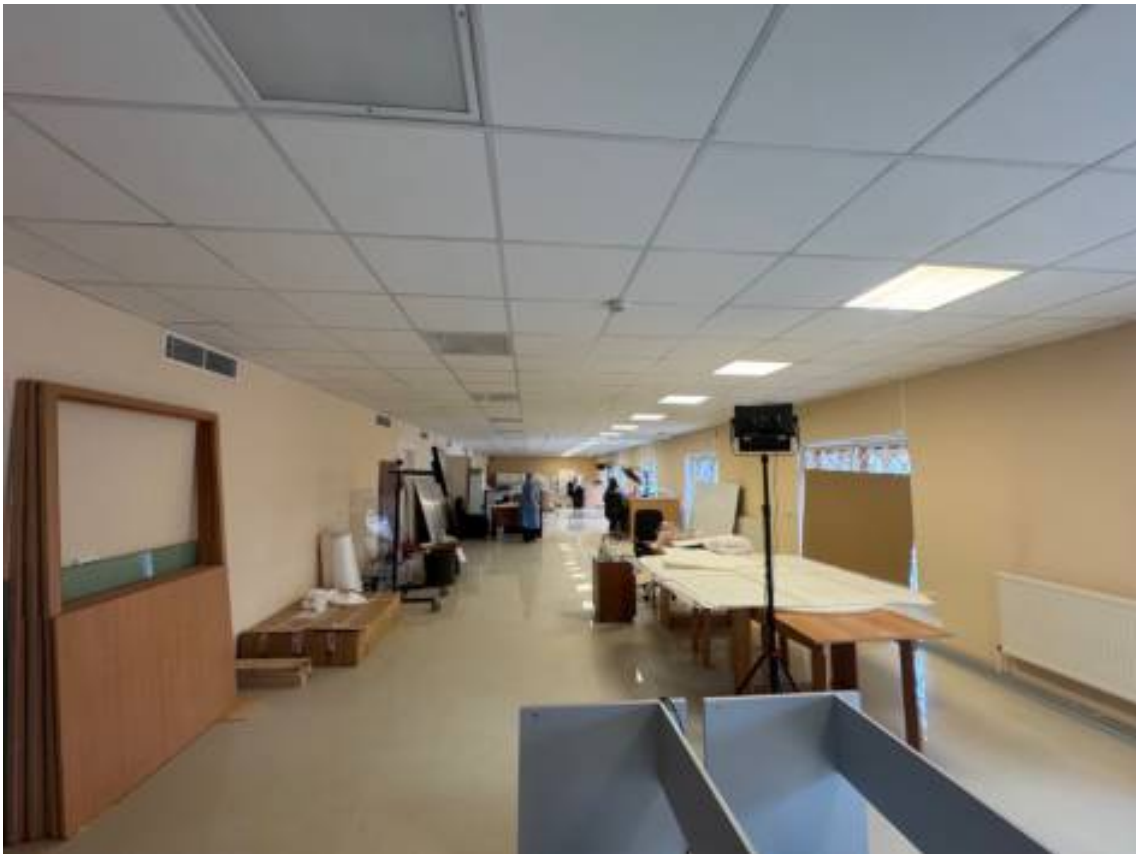
207. Объект культурного наследия федерального значения «Замок», по адресу: г. Санкт-Петербург, Садовая ул., д. 2, лит. А, в составе объекта культурного наследия федерального значения «Михайловский (Инженерный) замок». Общий вид пом. 1-Н (368) в уровне 3 этажа.
