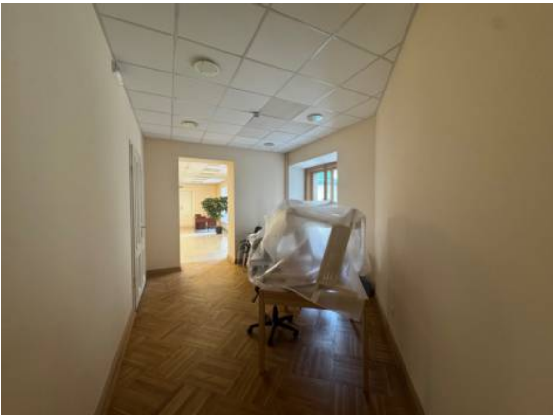
208. Объект культурного наследия федерального значения «Замок», по адресу: г. Санкт-Петербург, Садовая ул., д. 2, лит. А, в составе объекта культурного наследия федерального значения «Михайловский (Инженерный) замок». Общий вид пом. 1-Н (340) в уровне 3 этажа.
