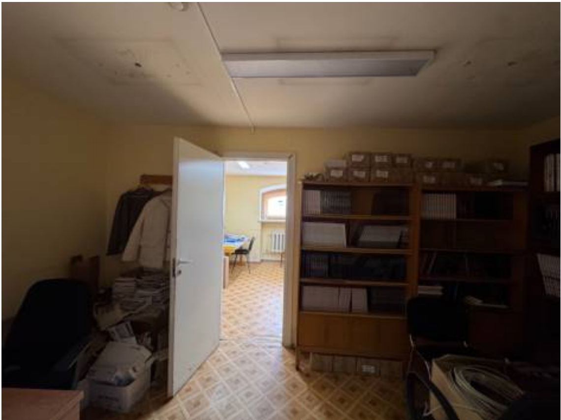
228. Объект культурного наследия федерального значения «Замок», по адресу: г. Санкт-Петербург, Садовая ул., д. 2, лит. А, в составе объекта культурного наследия федерального значения «Михайловский (Инженерный) замок». Общий вид пом. 1-Н (492) в уровне 4 этажа.
