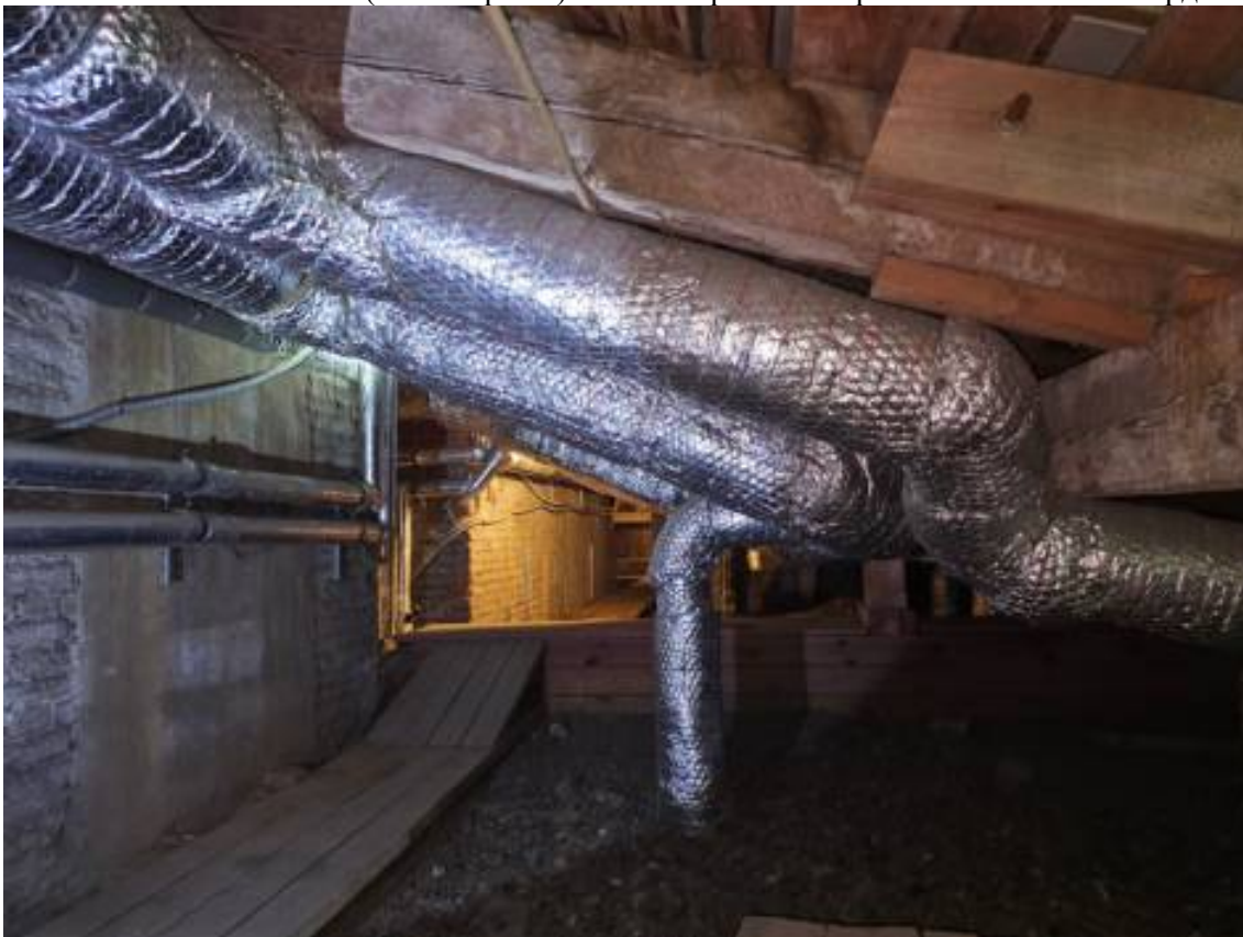
239. Объект культурного наследия федерального значения «Замок», по адресу: г. Санкт-Петербург, Садовая ул., д. 2, лит. А, в составе объекта культурного наследия федерального значения «Михайловский (Инженерный) замок». Фрагмент чердака.
