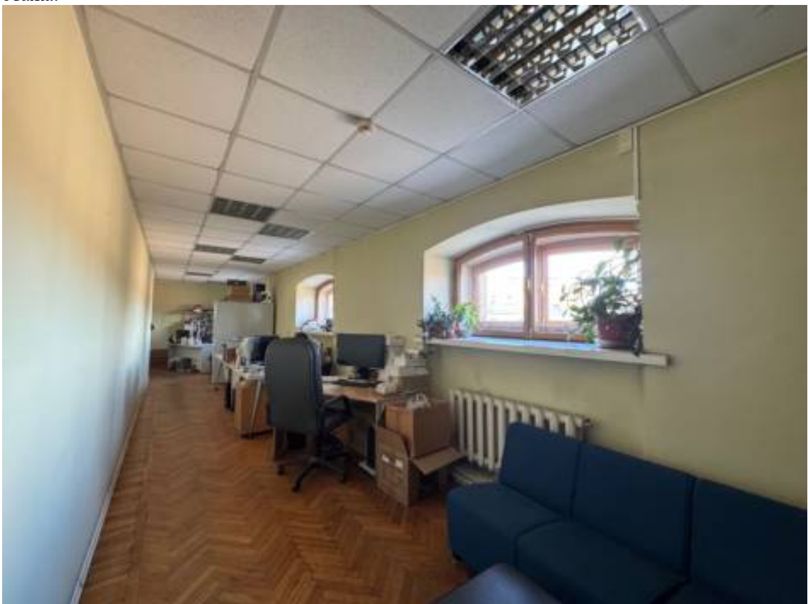
231. Объект культурного наследия федерального значения «Замок», по адресу: г. Санкт-Петербург, Садовая ул., д. 2, лит. А, в составе объекта культурного наследия федерального значения «Михайловский (Инженерный) замок». Общий вид пом. 1-Н (514) в уровне 4 этажа.
