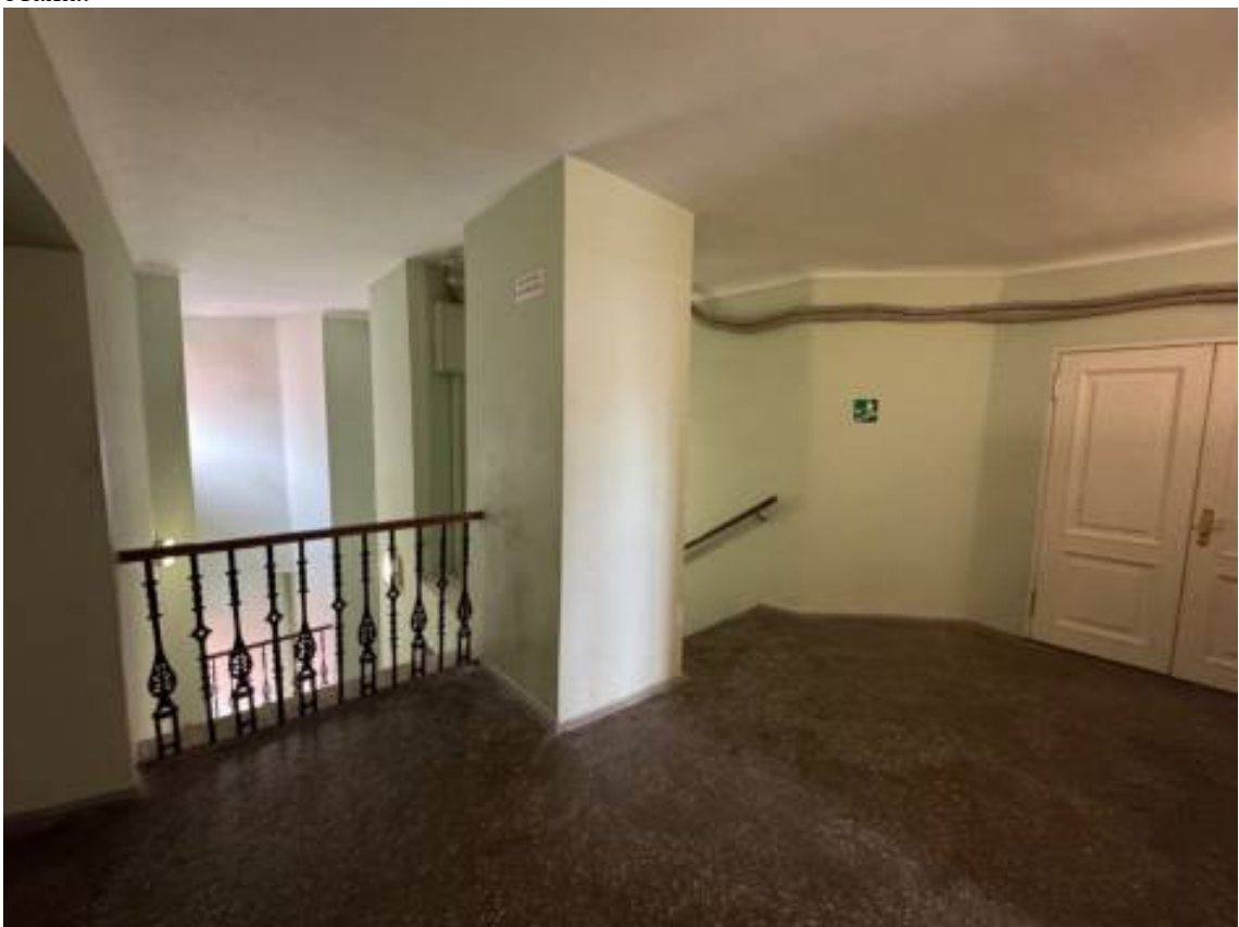
225. Объект культурного наследия федерального значения «Замок», по адресу: г. Санкт-Петербург, Садовая ул., д. 2, лит. А, в составе объекта культурного наследия федерального значения «Михайловский (Инженерный) замок». Общий вид пом. 1-Н (450) в уровне 4 этажа.
