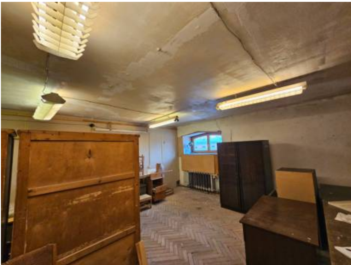
234. Объект культурного наследия федерального значения «Замок», по адресу: г. Санкт-Петербург, Садовая ул., д. 2, лит. А, в составе объекта культурного наследия федерального значения «Михайловский (Инженерный) замок». Фрагмент пом. 1-Н (440) в уровне 4 этажа.
