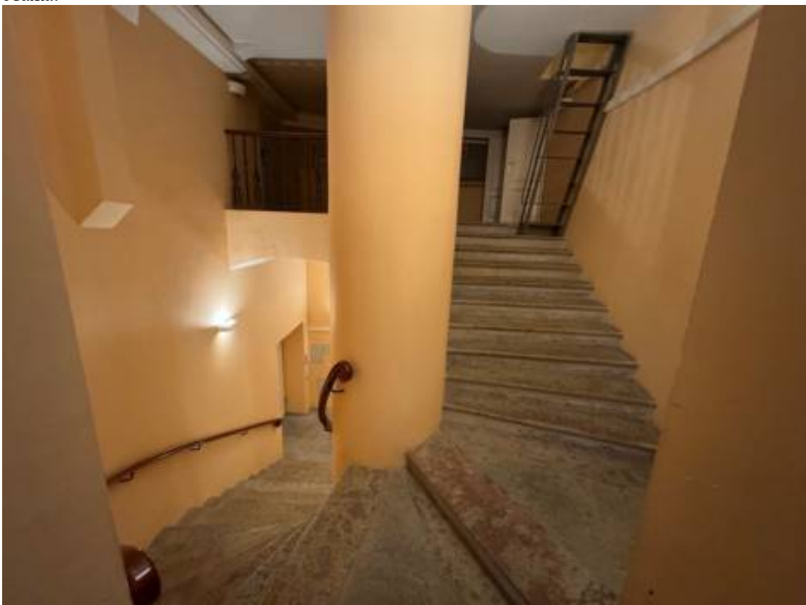
219. Объект культурного наследия федерального значения «Замок», по адресу: г. Санкт-Петербург, Садовая ул., д. 2, лит. А, в составе объекта культурного наследия федерального значения «Михайловский (Инженерный) замок». Общий вид пом. 1-Н (487) в уровне 4 этажа.
