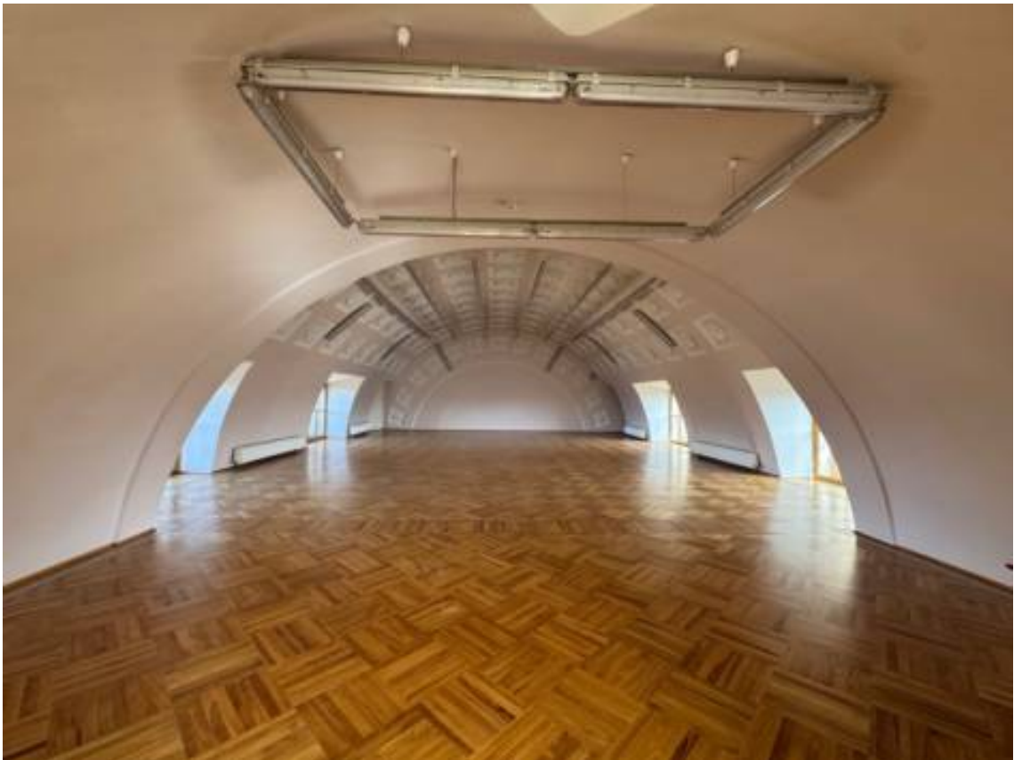
211. Объект культурного наследия федерального значения «Замок», по адресу: г. Санкт-Петербург, Садовая ул., д. 2, лит. А, в составе объекта культурного наследия федерального значения «Михайловский (Инженерный) замок». Общий вид пом. 1-Н (332) в уровне 3 этажа.
