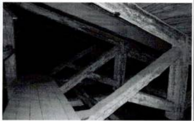
8. Фрагмент чердачного пространства
