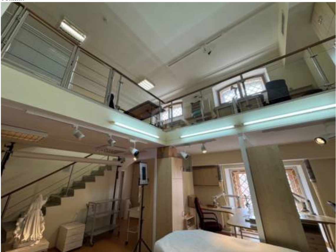
210. Объект культурного наследия федерального значения «Замок», по адресу: г. Санкт-Петербург, Садовая ул., д. 2, лит. А, в составе объекта культурного наследия федерального значения «Михайловский (Инженерный) замок». Общий вид пом. 1-Н (425) в уровне 3 этажа.
