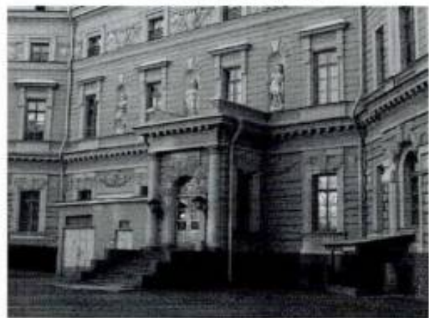
4. Фрагмент дворового фасада
