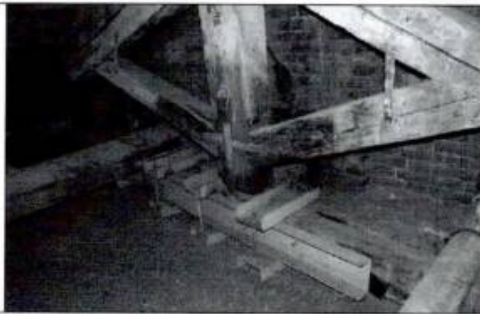
7. Фрагмент чердачного пространства
