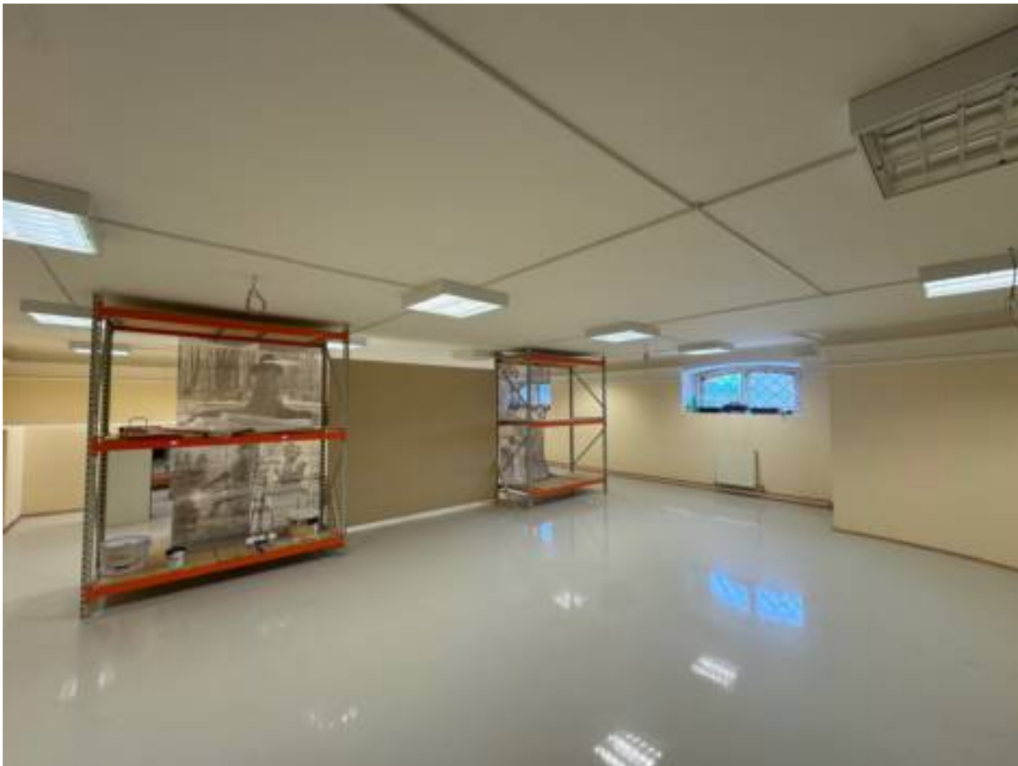
214. Объект культурного наследия федерального значения «Замок», по адресу: г. Санкт-Петербург, Садовая ул., д. 2, лит. А, в составе объекта культурного наследия федерального значения «Михайловский (Инженерный) замок». Общий вид пом. 1-Н (486) в уровне 4 этажа.
