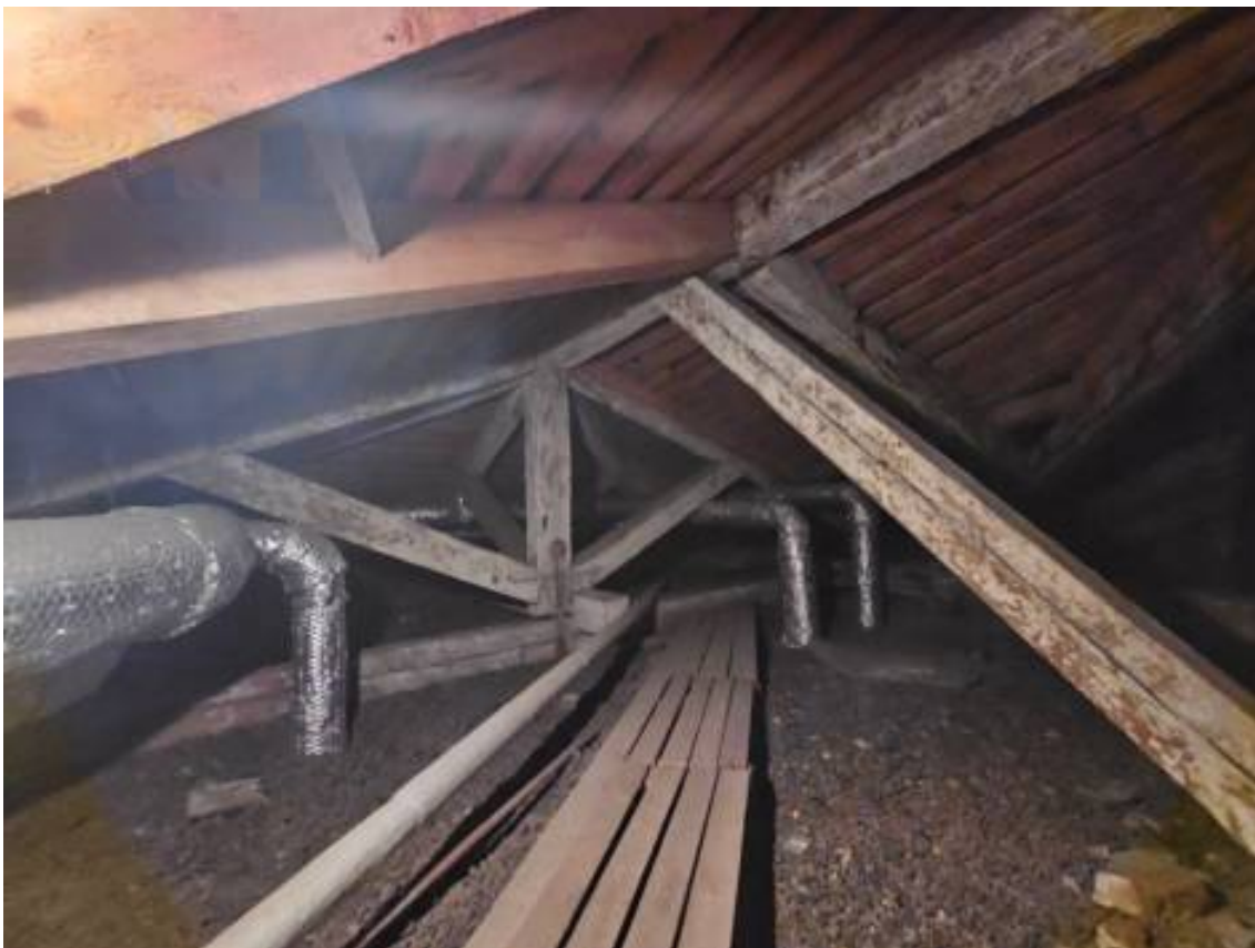
238. Объект культурного наследия федерального значения «Замок», по адресу: г. Санкт-Петербург, Садовая ул., д. 2, лит. А, в составе объекта культурного наследия федерального значения «Михайловский (Инженерный) замок». Фрагмент стропильной системы чердака.
