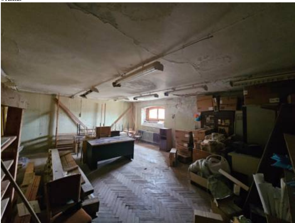
235. Объект культурного наследия федерального значения «Замок», по адресу: г. Санкт-Петербург, Садовая ул., д. 2, лит. А, в составе объекта культурного наследия федерального значения «Михайловский (Инженерный) замок». Фрагмент пом. 1-Н (440) в уровне 4 этажа.
