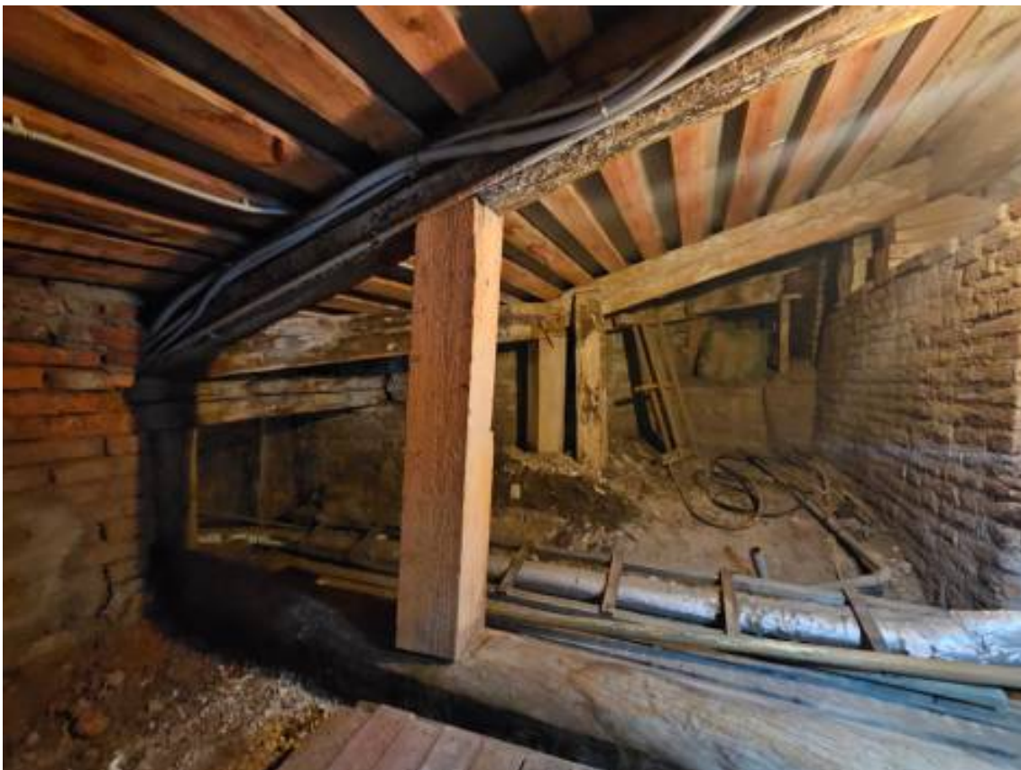
236. Объект культурного наследия федерального значения «Замок», по адресу: г. Санкт-Петербург, Садовая ул., д. 2, лит. А, в составе объекта культурного наследия федерального значения «Михайловский (Инженерный) замок». Фрагмент стропильной системы чердака.
