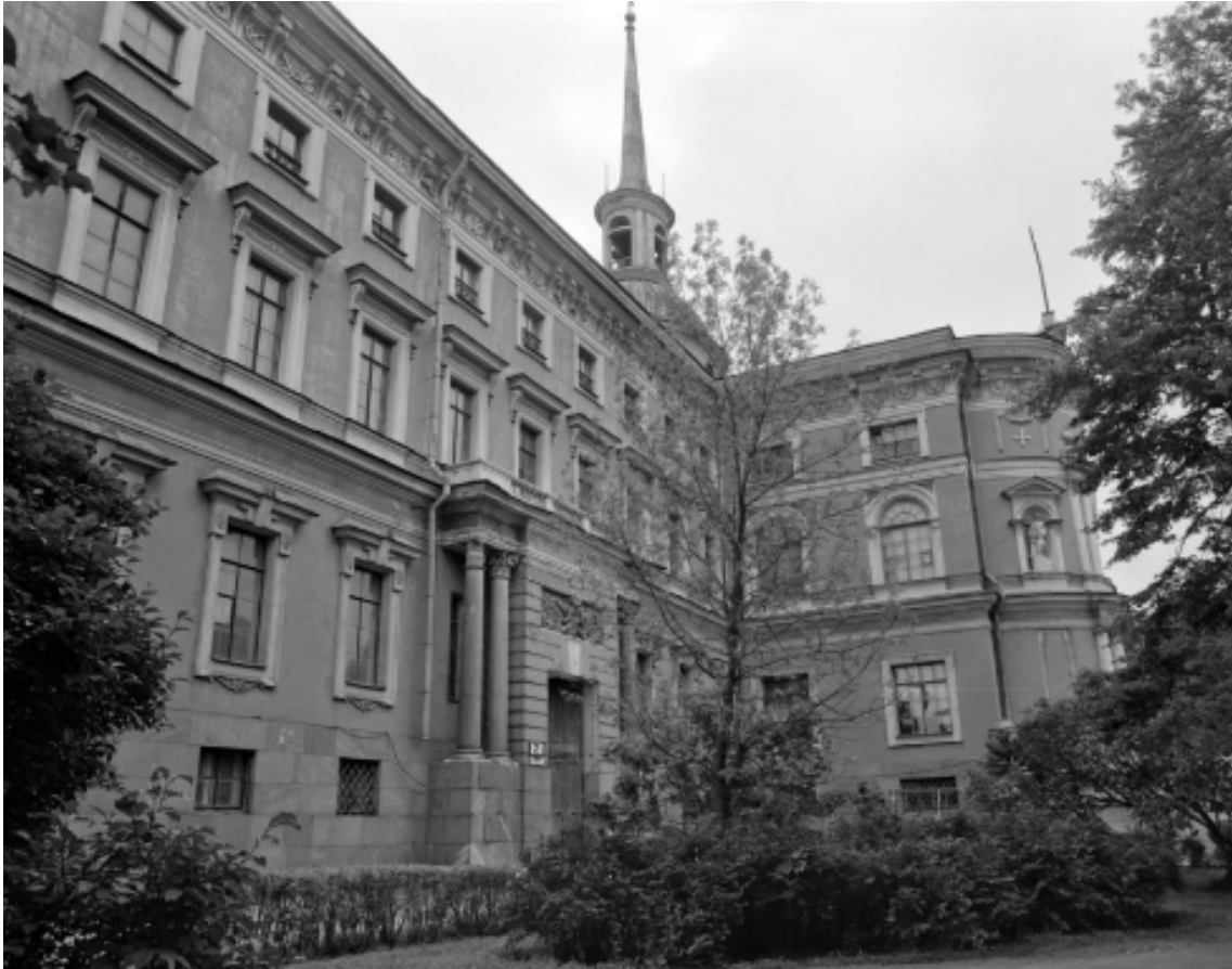
25. Михайловский, или Инженерный замок. Западный фасад и церковь св. Михаила Архангела, 1996 г. Источник: https://pastvu.com/
