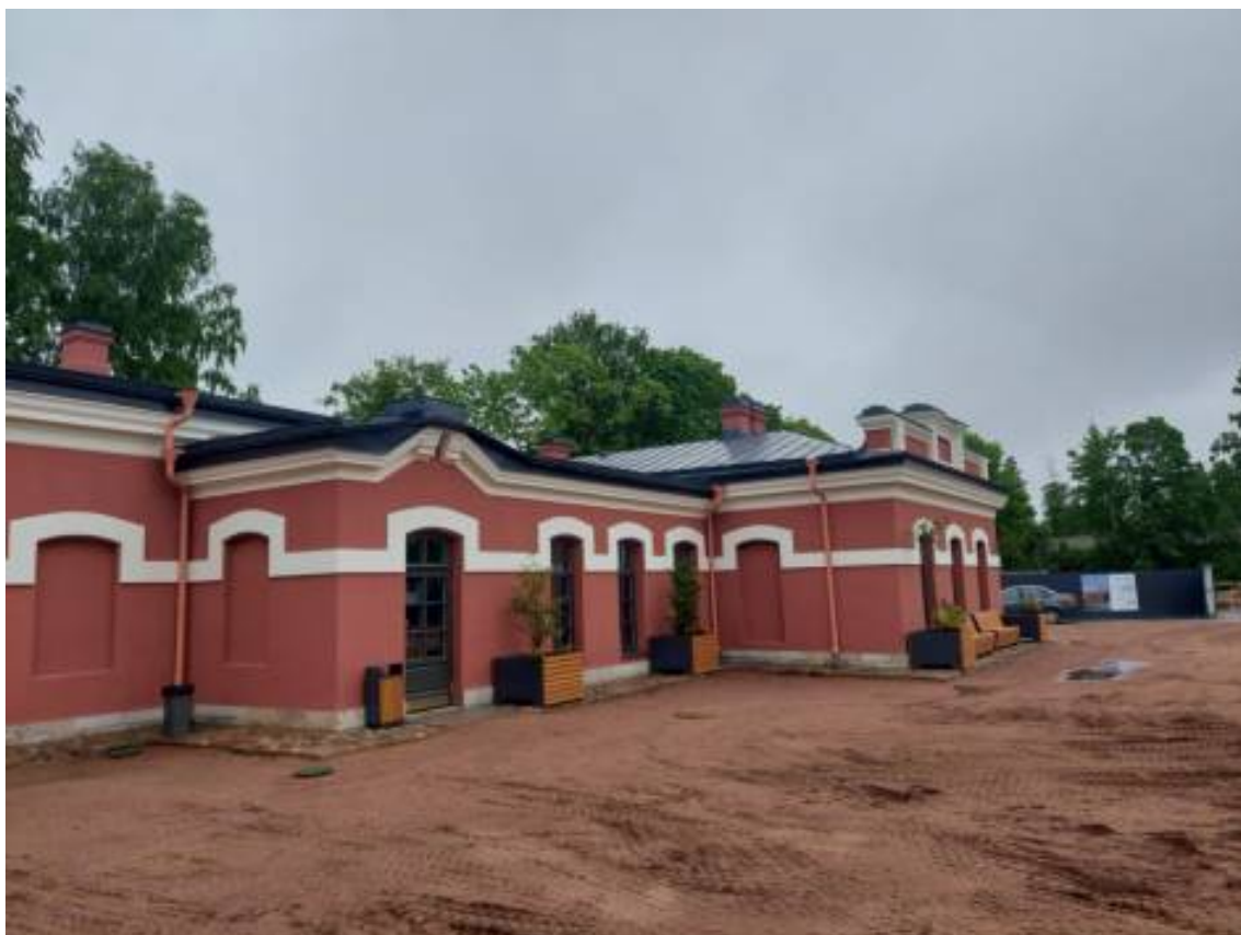
5. Вид на восточную часть с юго-западной стороны
