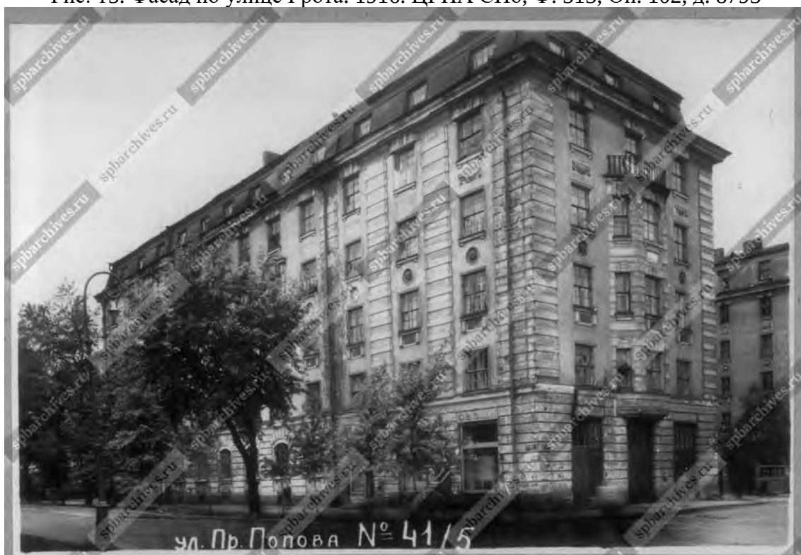
Рис. 16. ЦГАКФФД СПб. Фотодокументы. Описание 1ГР-48. Ед.хр.73758 1961г. Угловой фасад дома № 41/5. Автор съемки: Не установлен Место съемки: Ленинград
