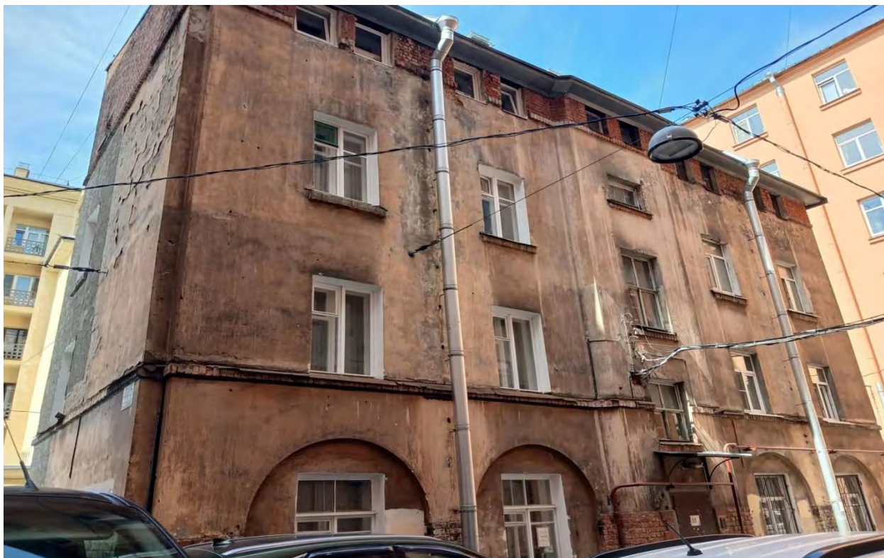
Фото 13. Фасад дворового корпуса.
