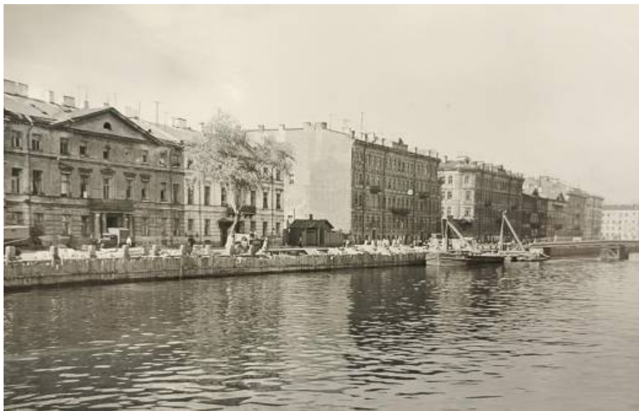
29. Капитальный ремонт набережной у д.93-101. 1957. Архив Мостотреста. Папка 98/4.
