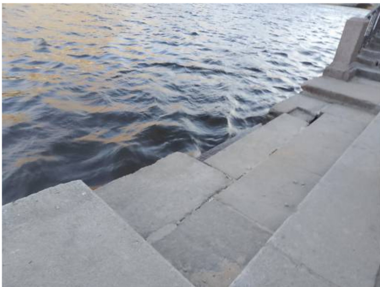
12. Ступени спуска: утраты шовного раствора, смещение.
