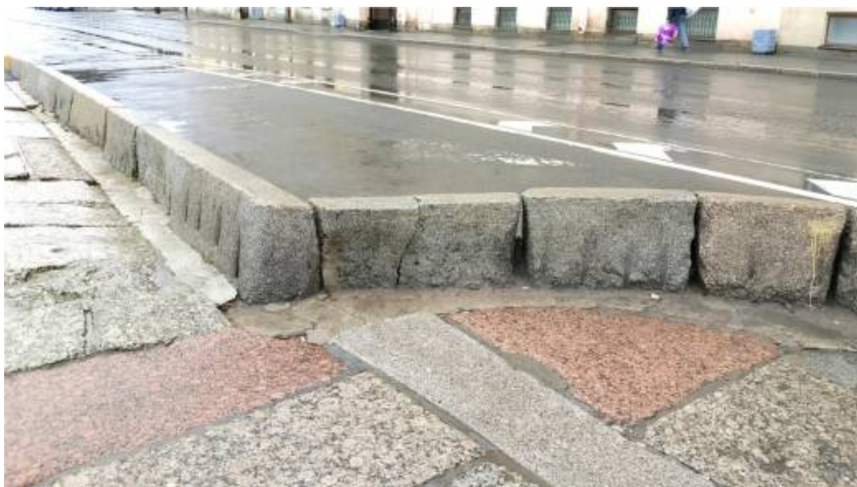
16. Площадка перед спуском. Бордюрный камень имеет трещины, отклонения от проектного положения, химические загрязнения. Шовный раствор утрачен.
