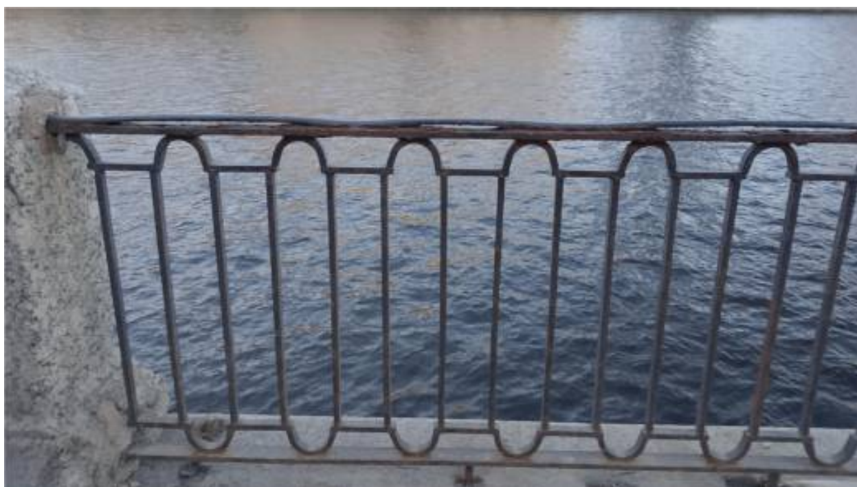
7. Металлическая секция ограждения: коррозия, утрата окрасочных слоёв, расслоение и деформация поручня; вместо декоративных опор выполнены прямые стойки.
