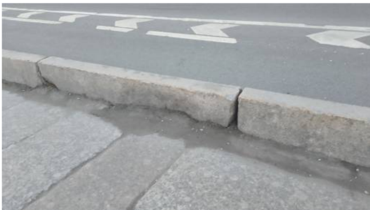
9. Гранитный бордюр: сколы камня, утраты шовного заполнения, загрязнение водосборного лотка.
