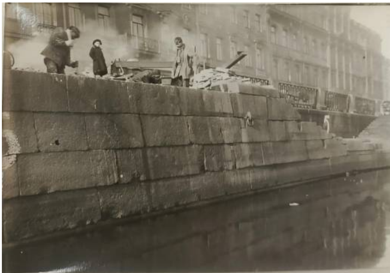
13. Разборка стенки набережной у домов 105-109. Автор фото Л.Г. Андреевский. 1928. Архив Мостотреста. Папка 98/5. №19.
