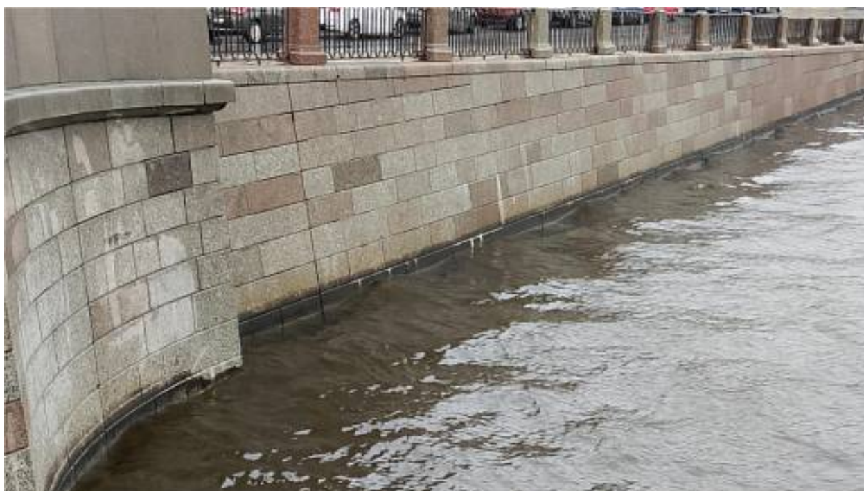
28. Общий вид набережной от Обуховского моста. Утраты шовного заполнения, высолы на поверхности облицовки, загрязнение и биопоражение по границе с уровнем воды.
