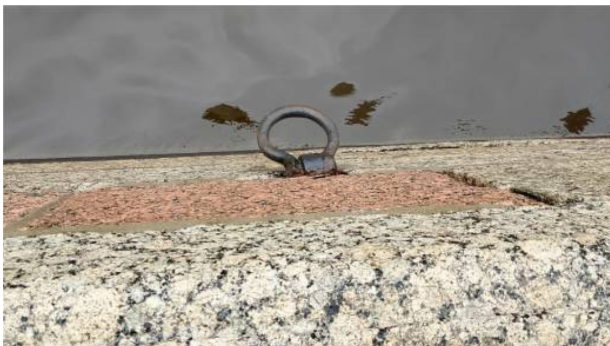
26. Рым: следы коррозии.
