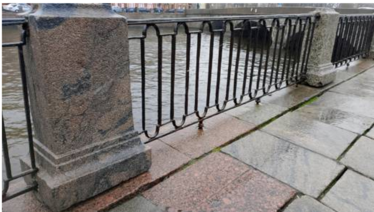
21. Тумбы выполнены из различных видов гранита. Шовное заполнение мощения вымыто, присутствует биопоражение.
