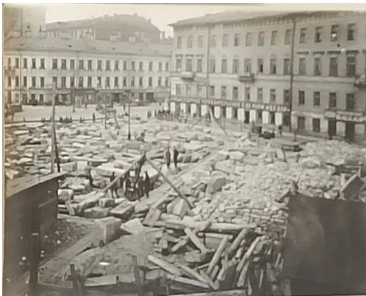
21. Строительная площадка на Обуховской площади при ремонте наб р. Фонтанки д. 105-109. Автор фото Л.Г. Андреевский. 1928. Архив Мостотреста. Папка 98/5. №30
