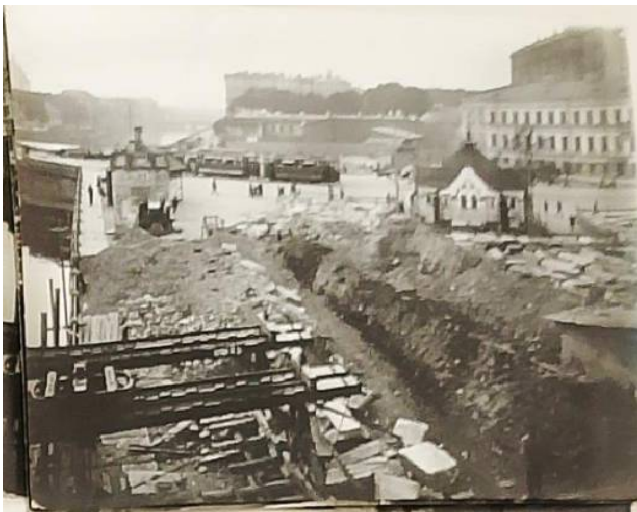
22. Общий вид строительной площадки на Обуховской площади при ремонте наб р. Фонтанки д. 105-109. Автор фото Л.Г. Андреевский. 1928. Архив Мостотреста. Папка 98/5. № 31
