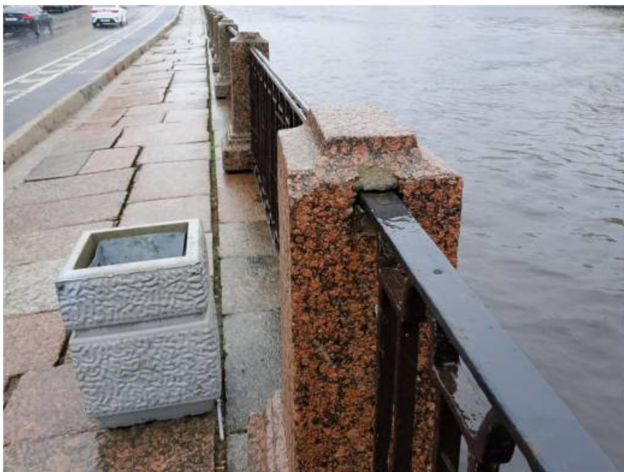
25. Заделка цементным раствором в месте сопряжения поручня и тумбы.
