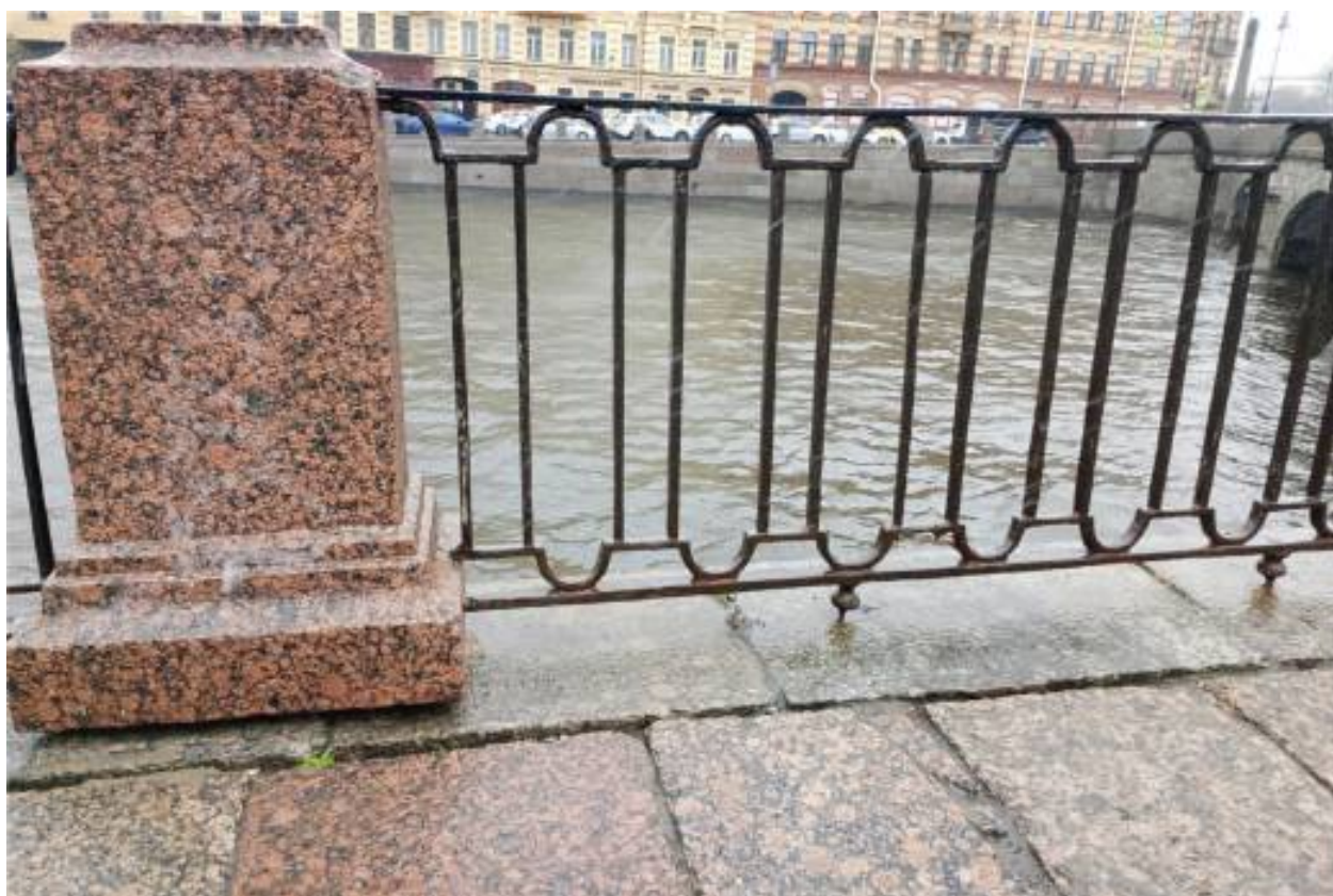
24. Зависание тумбы, сколы гранитных плит, биопоражение швов.
