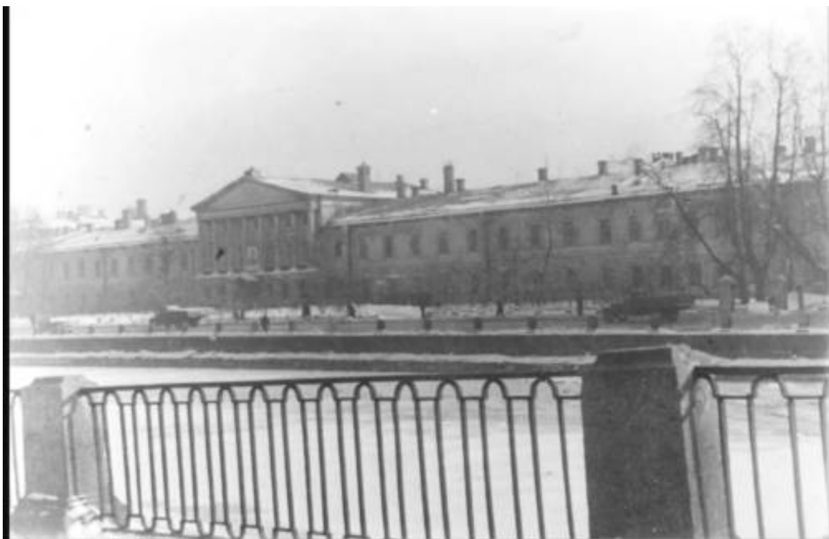
28. Обуховская больница (на первом плане – ограждение исследуемого участка правого берега Фонтанки). 1946–1950. Интернет-фотоархив Pastvu.com. URL: https://pastvu.com/p/1417274
