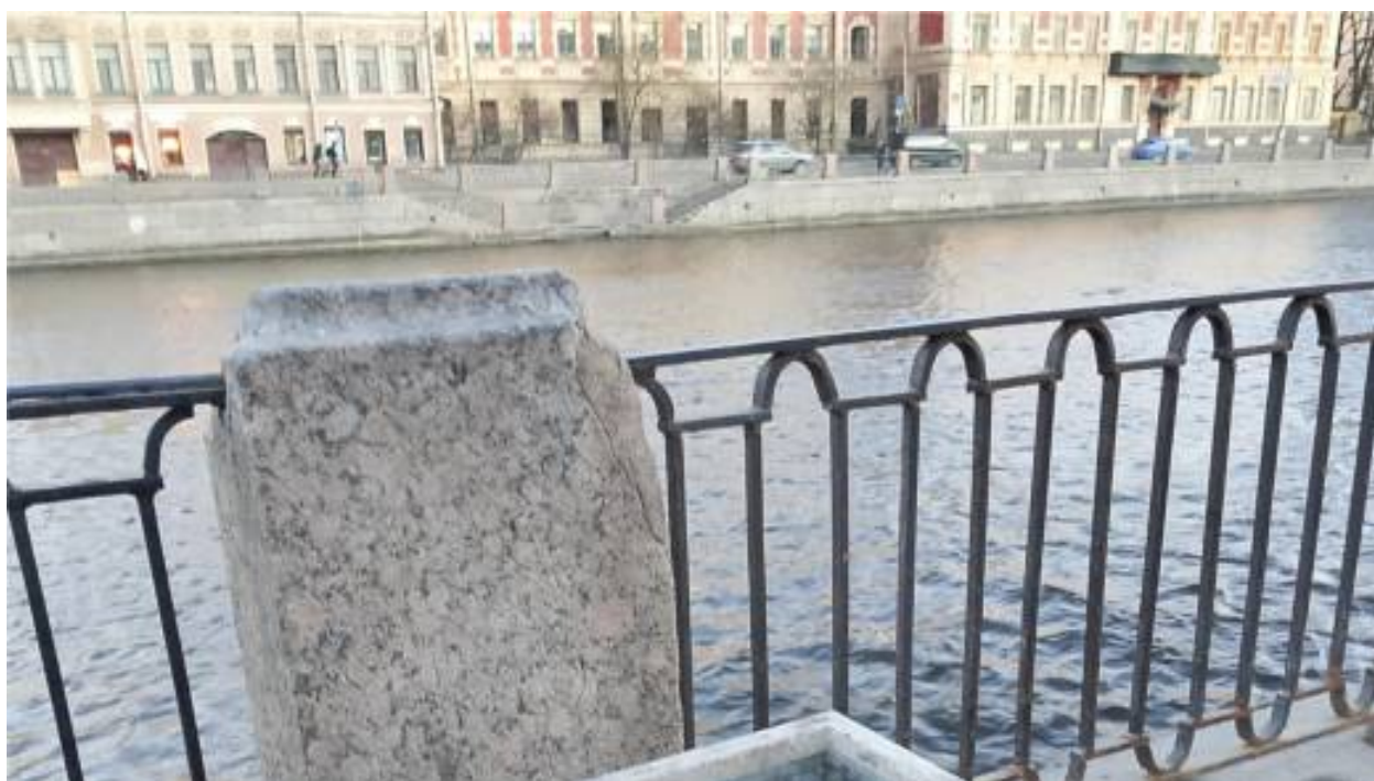
4. Гранитная тумба: скол с домастикровкой цементным раствором.
