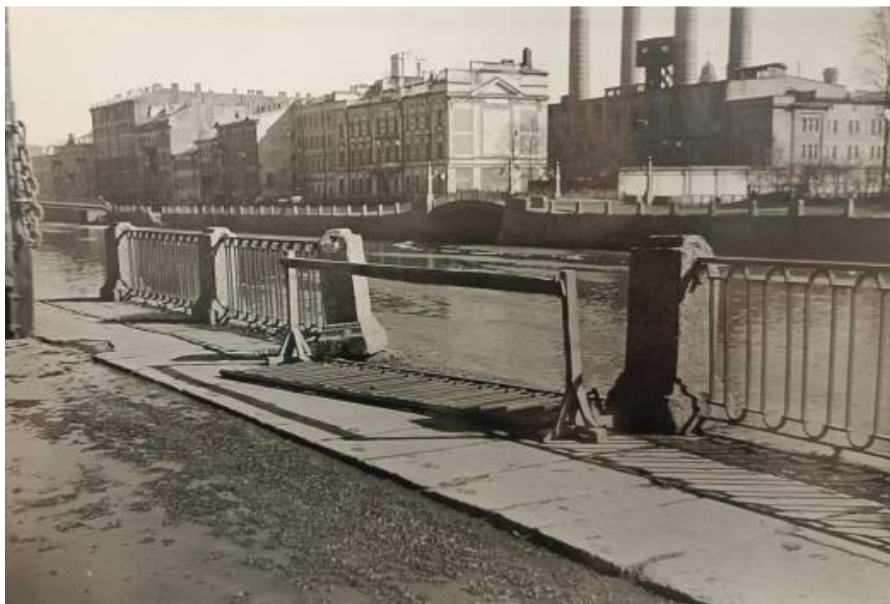
30. Капитальный ремонт набережной у д.93-101. 1957. Архив Мостотреста. Папка 98/4.
