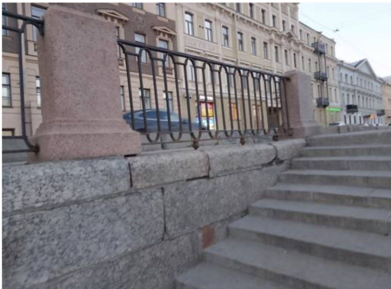
10. Стенка спуска: утраты шовного раствора, сколы карнизного камня, загрязнение . Секция ограждения: следы коррозии, утраты окрасочного слоя.
