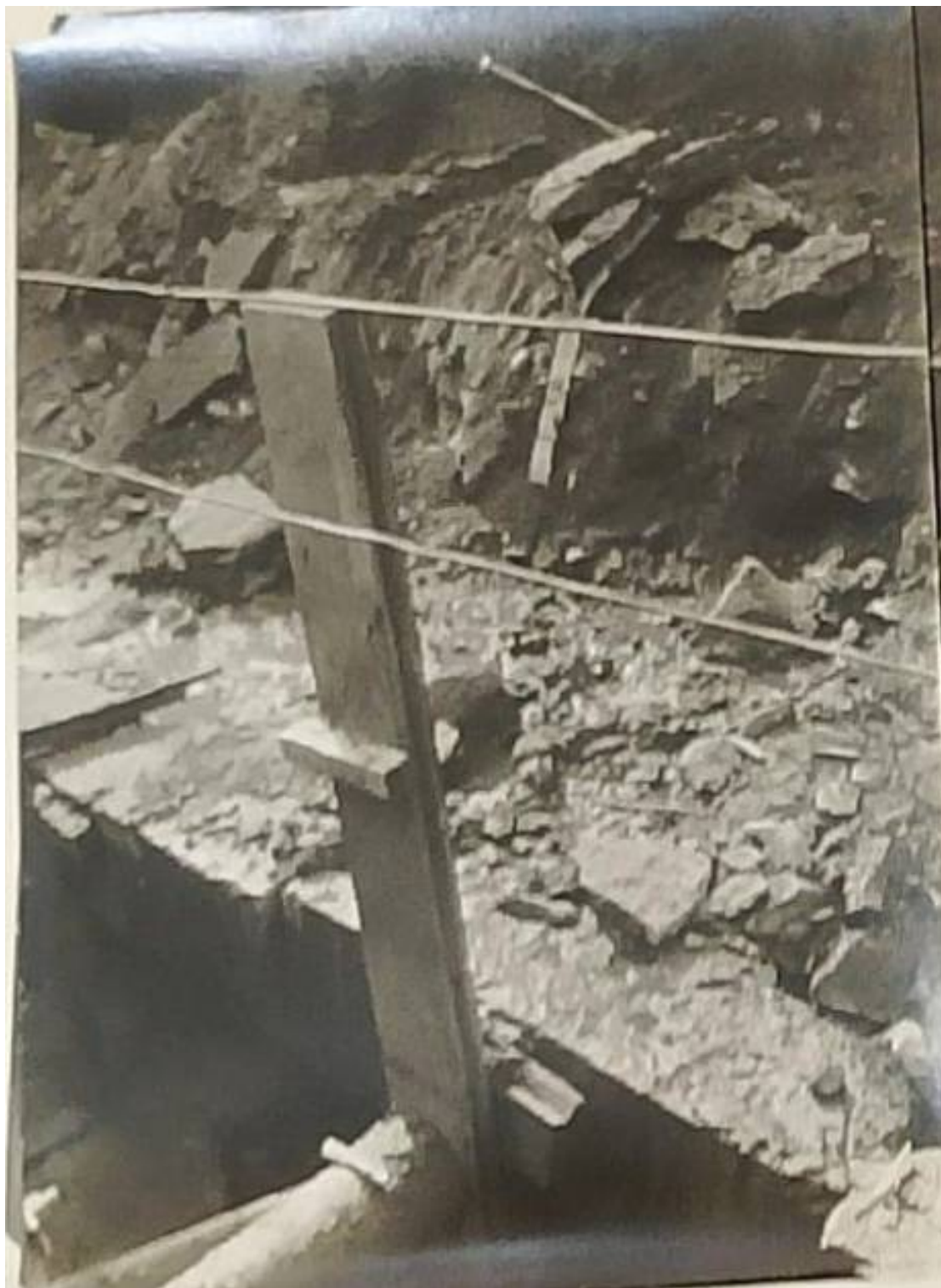
19. Разборка подпорной стенки наб. р Фонтанки у д. 105. Автор фото Л.Г. Андреевский. 1928. Архив Мостотреста. Папка 98/5. №27.
