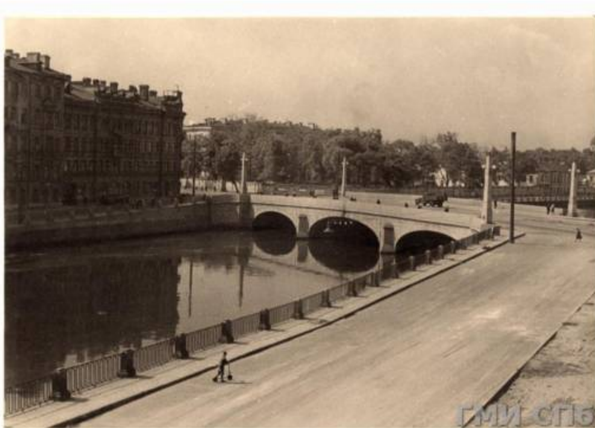
27. Обуховский мост через Фонтанку после реконструкции (на первом плане – исследуемый участок набережной). Автор фото: Тумилович Е. В. 1948. ГМИ. СПб. Инв.№-П-Б-3966 ф. Эл. доступ: https://goskatalog.ru/portal/#/collections?id=61552016
