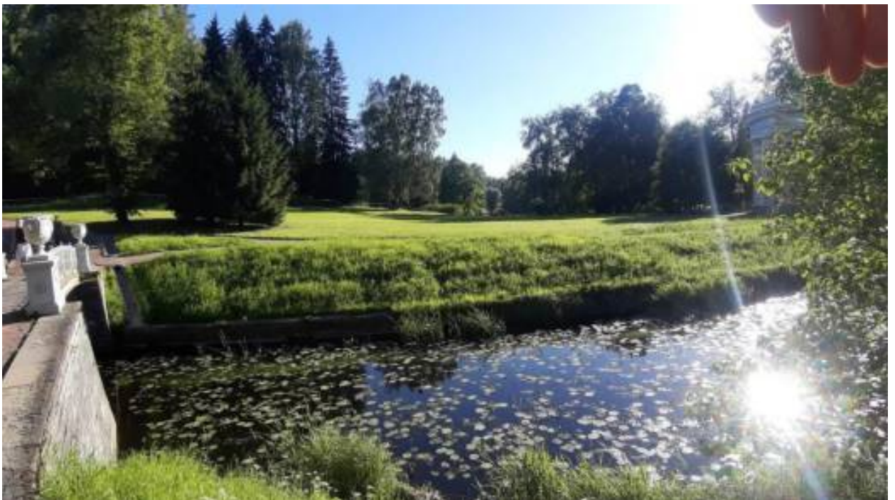
12. «Мост Чугунный у Храма дружбы» (Санкт-Петербург, г. Павловск, Садовая ул., д. 20, лит. АИ). Вид на берегоукрепление со стороны Храма дружбы. Штиглиц М.С. 22.07.2026 г.
