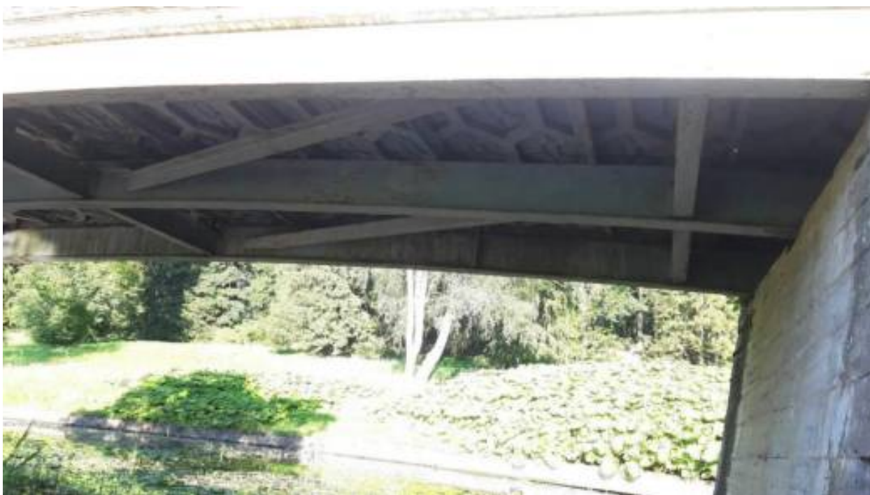
23. «Мост Чугунный у Храма дружбы» (Санкт-Петербург, г. Павловск, Садовая ул., д. 20, лит. АИ). Вид на пролетное строение Чугунного моста. Штиглиц М.С. 22.07.2026 г.
