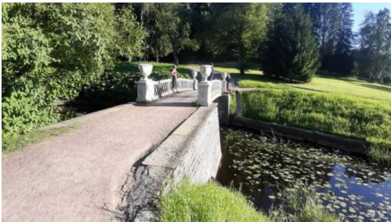
16. «Мост Чугунный у Храма дружбы» (Санкт-Петербург, г. Павловск, Садовая ул., д. 20, лит. АИ). Вид на устои Чугунного моста с северо-запада. Штиглиц М.С. 22.07.2026 г.
