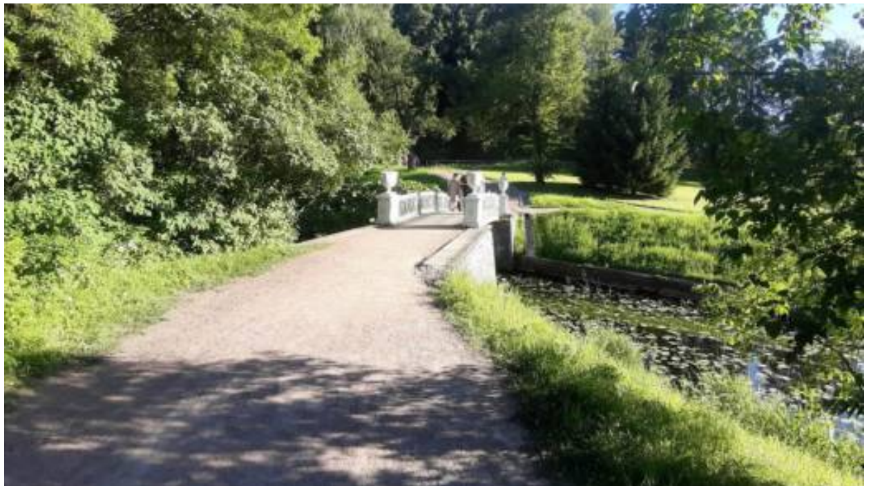
20. «Мост Чугунный у Храма дружбы» (Санкт-Петербург, г. Павловск, Садовая ул., д. 20, лит. АИ). Вид на Чугунный мост с севера. Штиглиц М.С. 22.07.2026 г.
