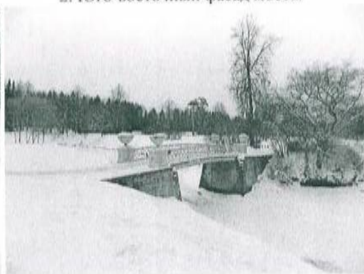
2. Юго-восточный фасад моста.
