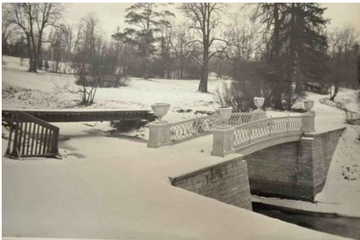
Ил. 32. Павловский парк. 1965 г., Мост Росси и рабочий мост после реставрации. КГИОП. 80940/1, 22.03.1965 г., нег. № 37483.
