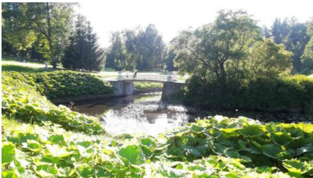
8. «Мост Чугунный у Храма дружбы» (Санкт-Петербург, г. Павловск, Садовая ул., д. 20, лит. АИ). Общий вид на Чугунный мост с севера-востока. Штиглиц М.С. 22.07.2026 г.
