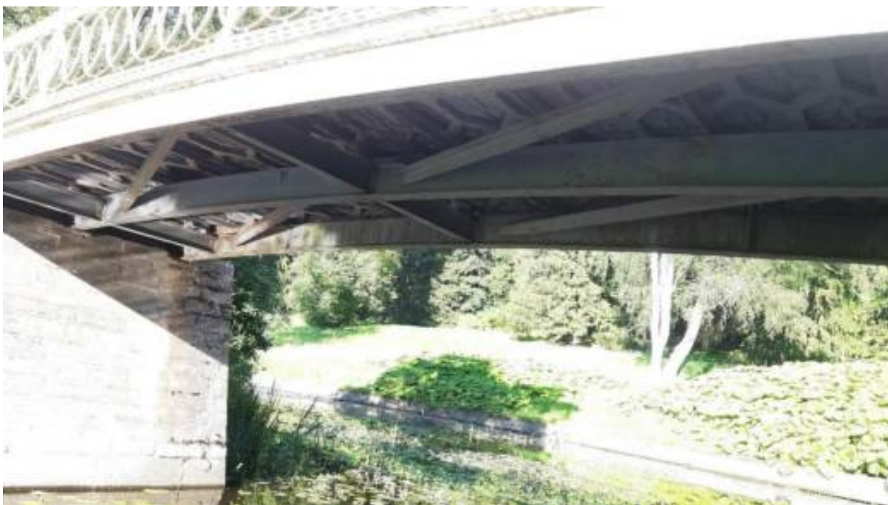
24. «Мост Чугунный у Храма дружбы» (Санкт-Петербург, г. Павловск, Садовая ул., д. 20, лит. АИ). Вид на пролетное строение Чугунного моста. Штиглиц М.С. 22.07.2026 г.
