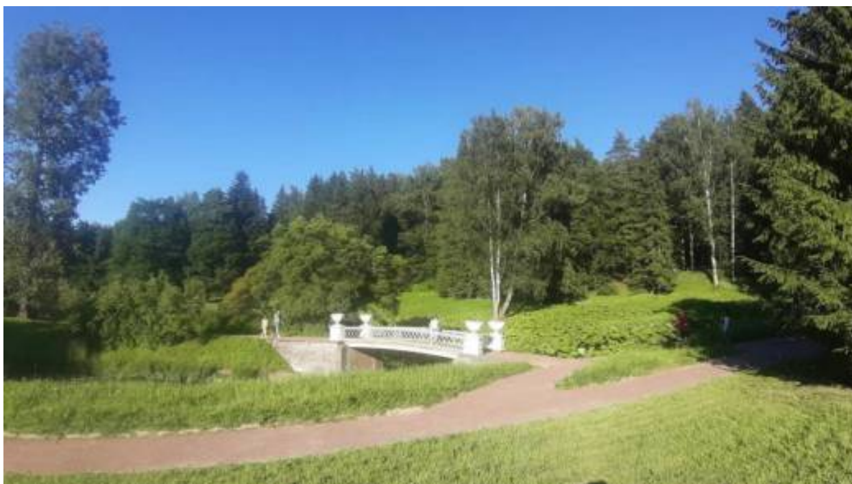
1. «Мост Чугунный у Храма дружбы» (Санкт-Петербург, г. Павловск, Садовая ул., д. 20, лит. АИ). Общий вид на Чугунный мост с юга-запада. Штиглиц М.С. 22.07.2026 г.
