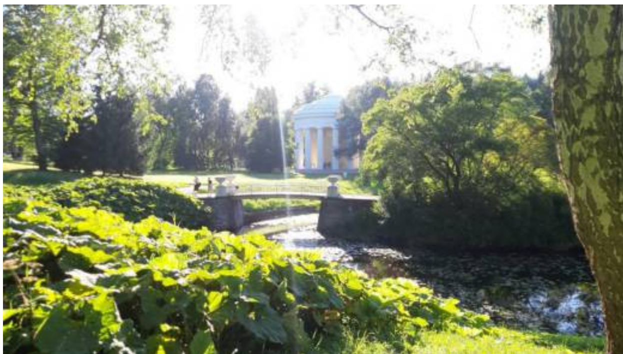
7. «Мост Чугунный у Храма дружбы» (Санкт-Петербург, г. Павловск, Садовая ул., д. 20, лит. АИ). Общий вид на Чугунный мост и Храм дружбы. Штиглиц М.С. 22.07.2026 г.
