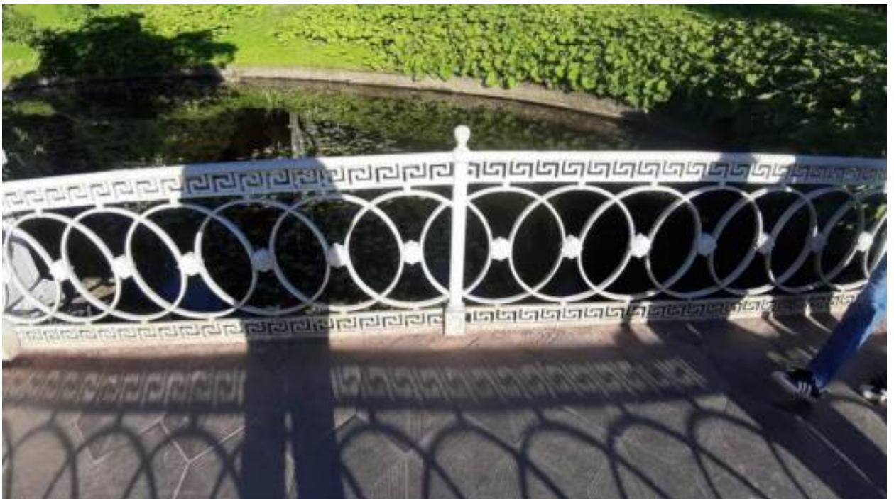
22. «Мост Чугунный у Храма дружбы» (Санкт-Петербург, г. Павловск, Садовая ул., д. 20, лит. АИ). Вид на решетку ограждения Чугунного моста. Штиглиц М.С. 22.07.2026 г.
