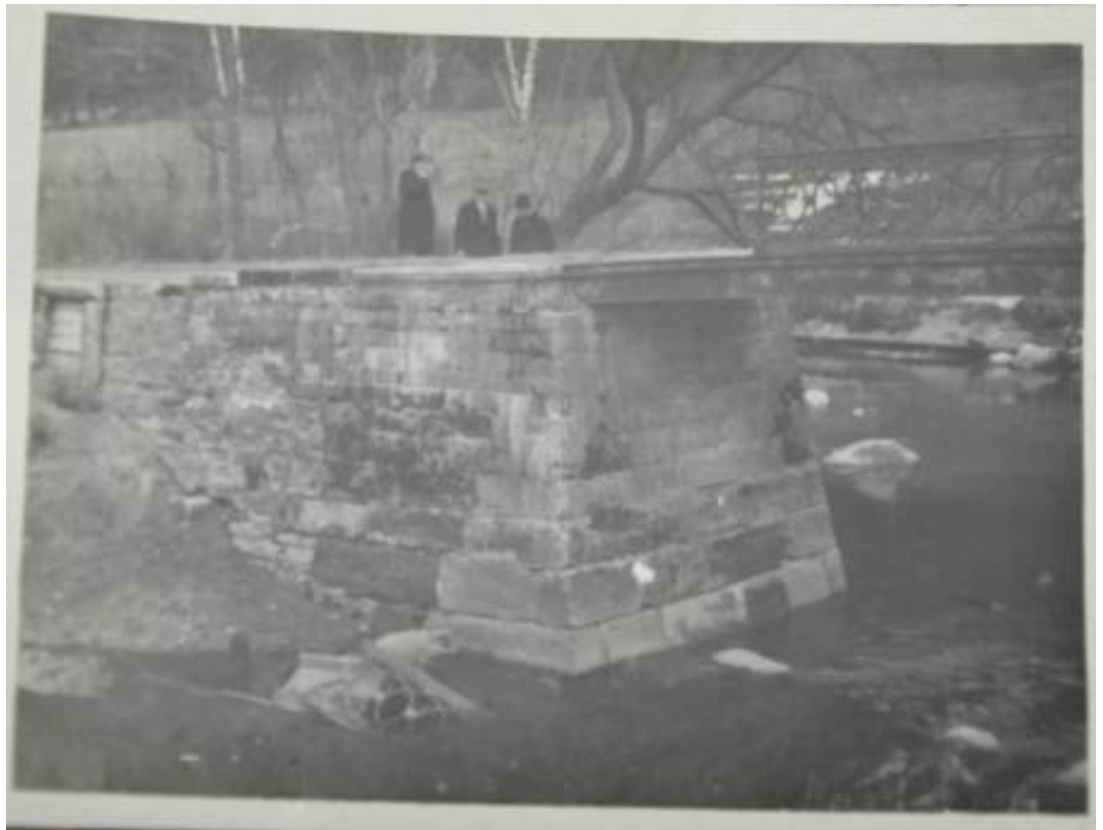
Ил. 29. Разрушения Чугунного мостика в Павловске. Фототека КГИОП № 2500/2 03.07.1937. ГМЗ Павловск.
