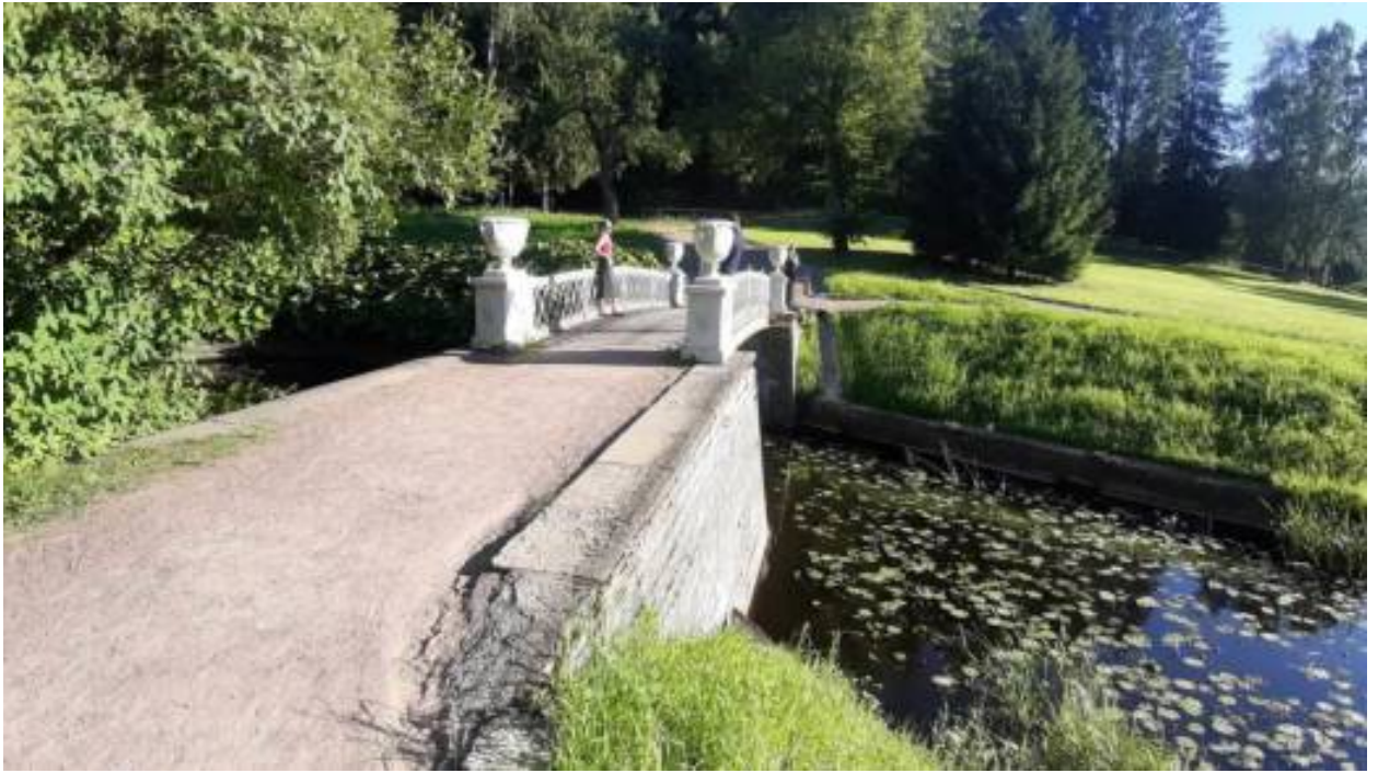
11. «Мост Чугунный у Храма дружбы» (Санкт-Петербург, г. Павловск, Садовая ул., д. 20, лит. АИ). Общий вид на Чугунный мост с пересечения аллеи Зодчего Росси и Михайловской. Штиглиц М.С. 22.07.2026 г.
