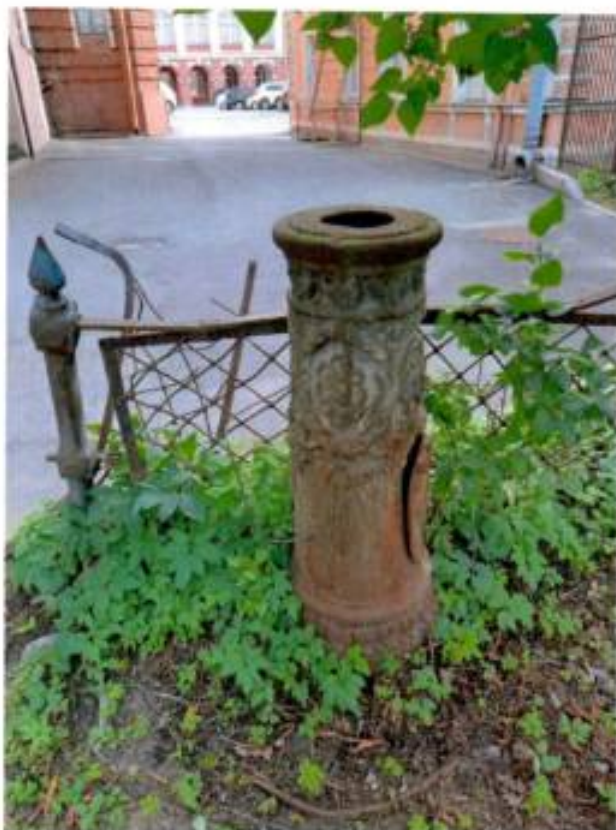
Фото 16: фрагмент объекта: фрагмент исторической чугуной фонарной опоры.
