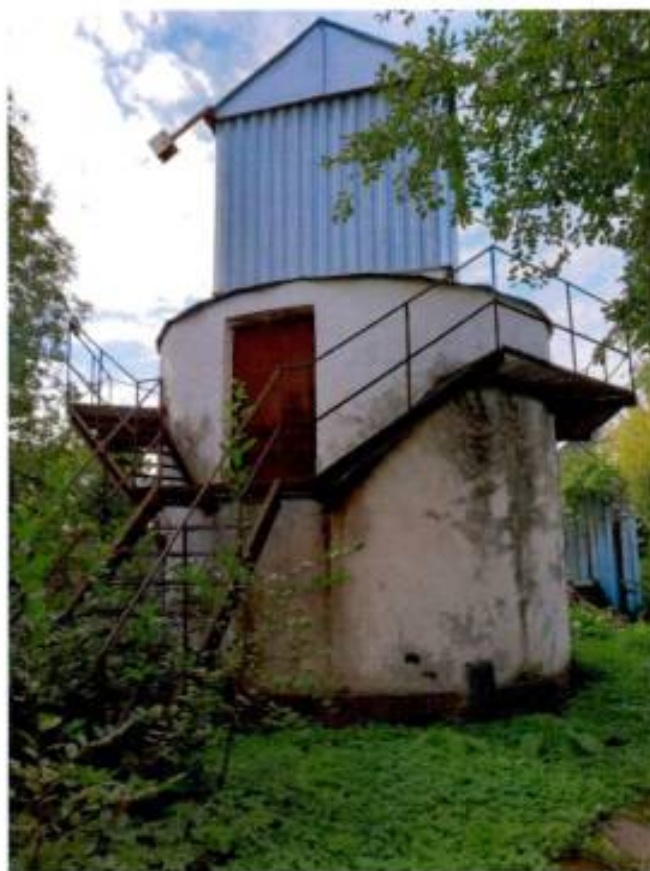
Фото 21: фрагмент объекта: Башня Глазенапа.
