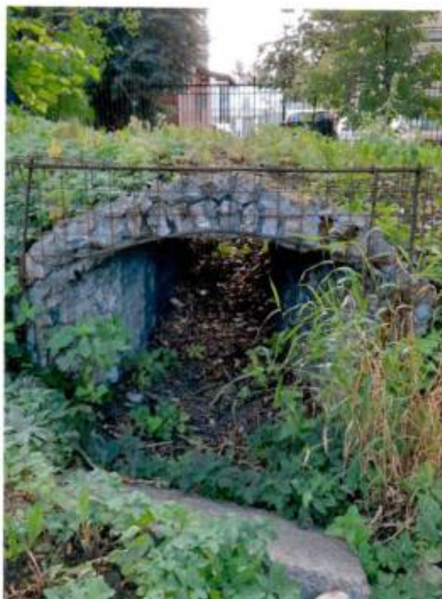
Фото 12: фрагмент объекта: грот (юго-восточная часть объекта).
