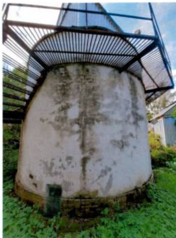
Фото 22: фрагмент объекта: Башня Глазенапа.
