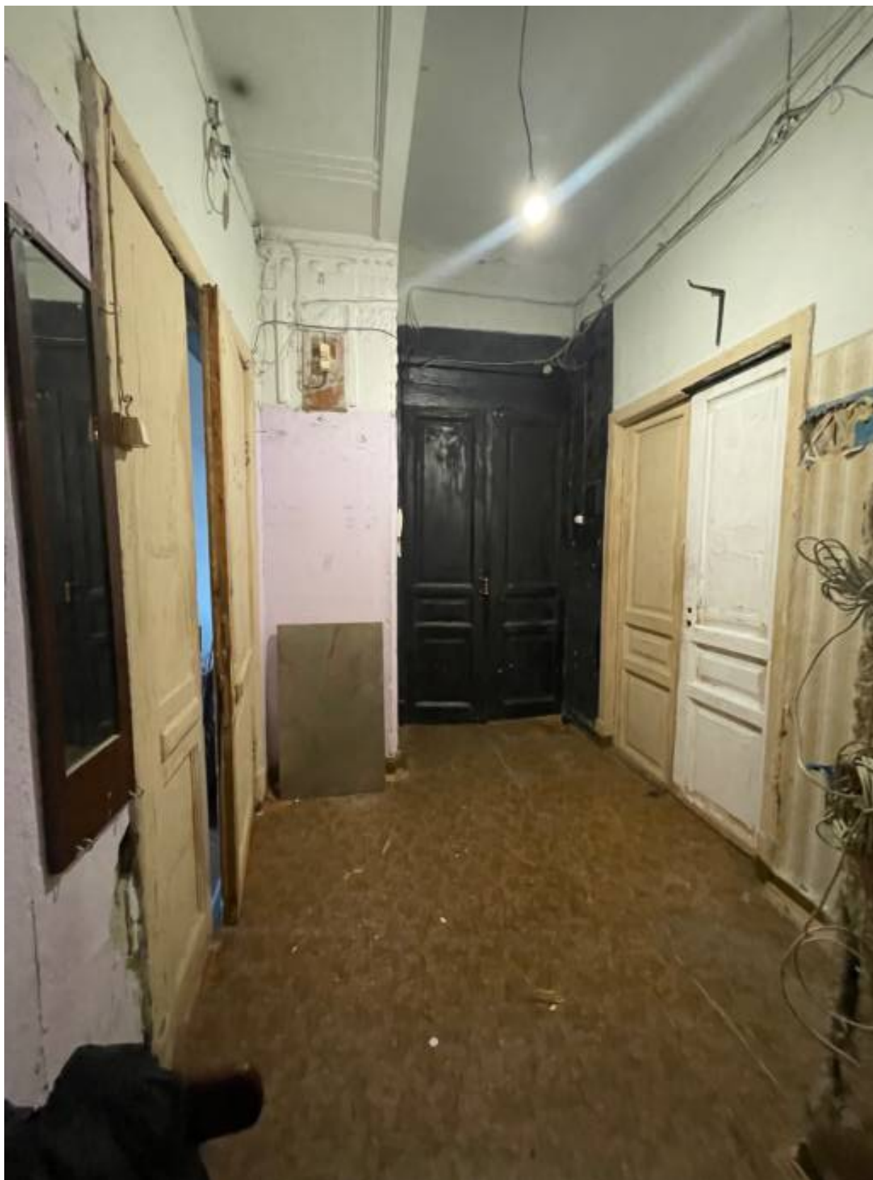
3. Входная дверь квартиры со стороны лестницы ЛК-2.
