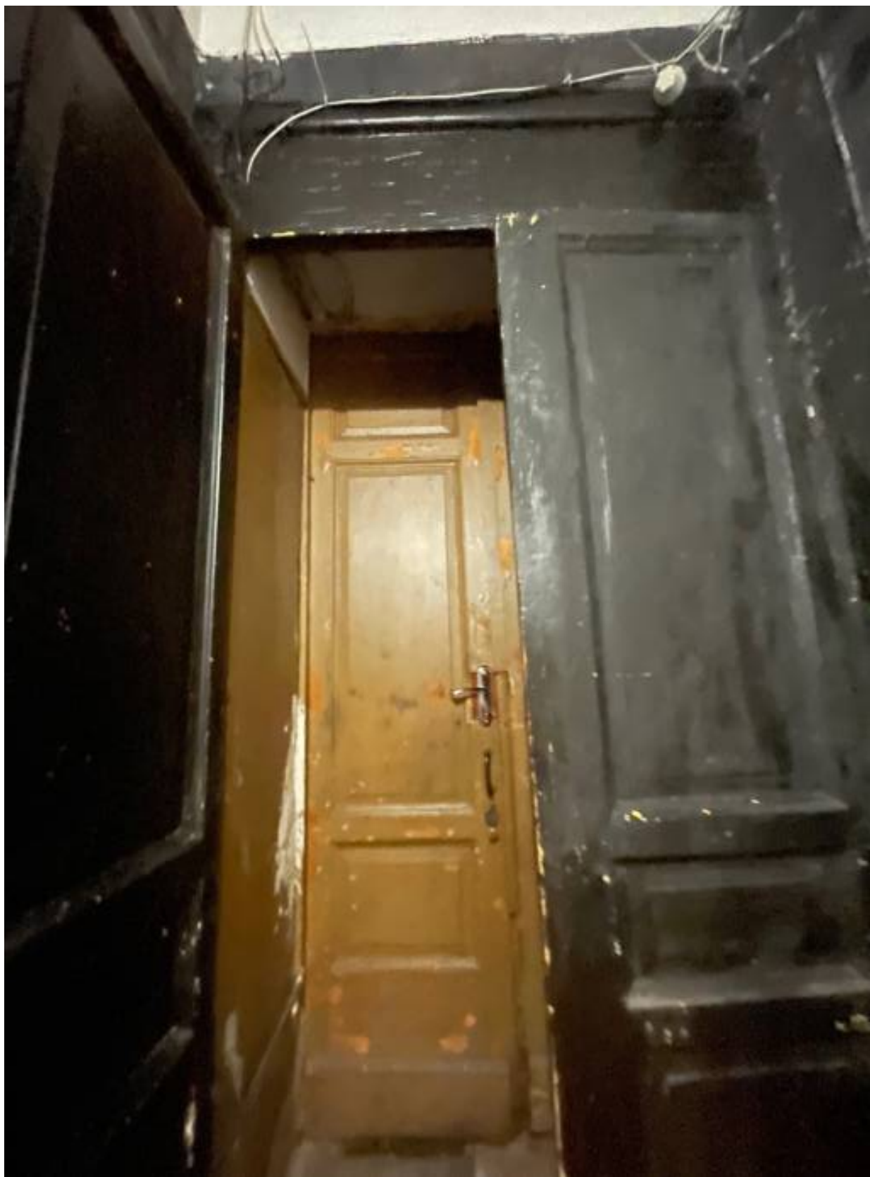
8. Тамбур входной двери со стороны лестницы ЛК-2.
