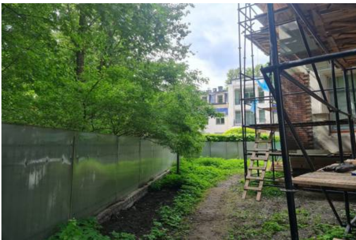
Фото 4. Южная часть земельного участка.
