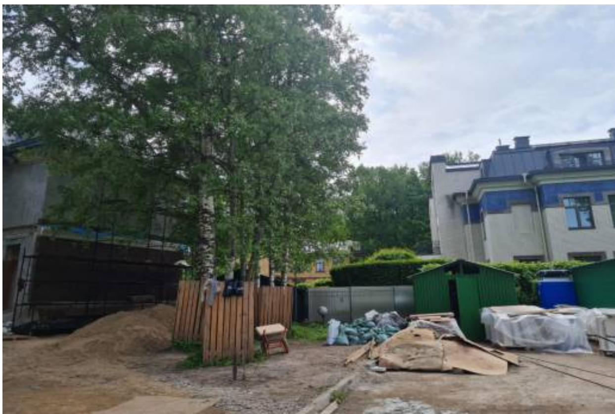
Фото 10. Вид на юго-западную часть участка (металлические сараи, подлежащие демонтажу).
