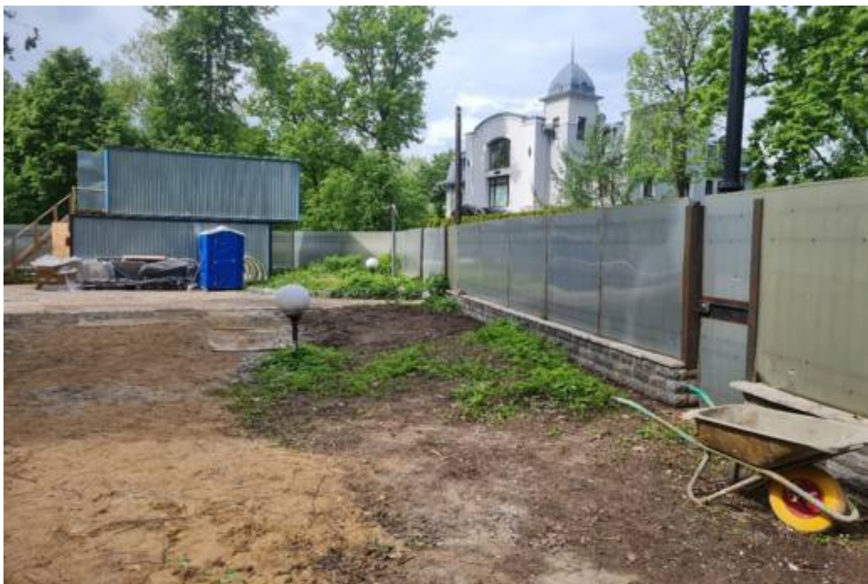
Фото 9. Северо-западная часть земельного участка (ворота и калитка).
