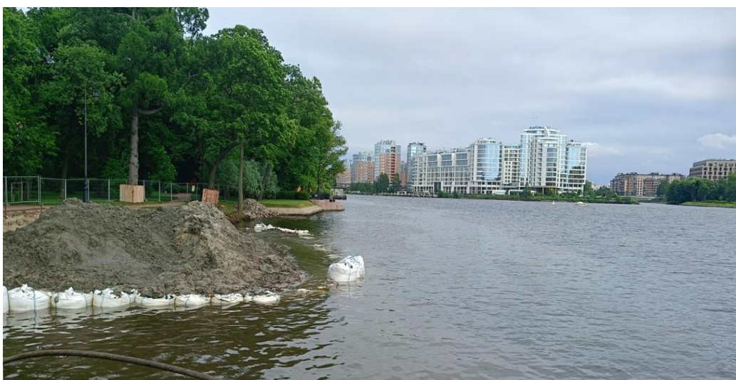
Фото 2. Вид на акваторию р. М. Невки и разрушенный участок береговой линии в границах объекта. Объект культурного наследия регионального значения «Парк с гидротехническими сооружениями, двумя прудами и фрагментами ограды» (в границах объекта культурного наследия ведутся работы по Разрешению КГИОП от 14.04.2026 №01-38-500/16-0-1 (противоаварийные мероприятия)).
