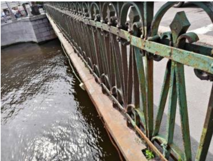
23. «Мост Аларчин» входящий в состав комплекса «Набережные и мосты Екатерининского канала (ныне канала Грибоедова)», через канал Грибоедова по Английскому проспекту. Фрагмент. Фото 09.07.2025г.
