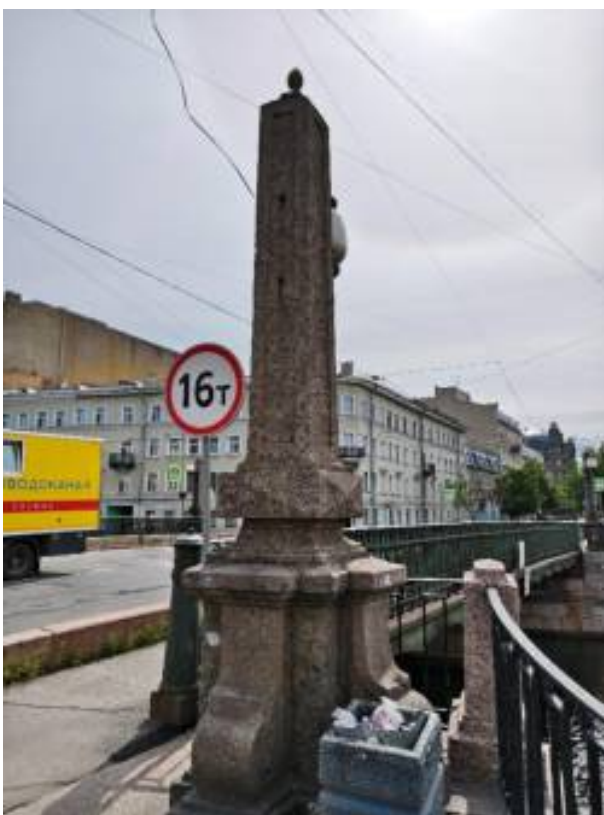
34. «Мост Аларчин» входящий в состав комплекса «Набережные и мосты Екатерининского канала (ныне канала Грибоедова)», через канал Грибоедова по Английскому проспекту. Фрагмент. Фото 09.07.2025г.
