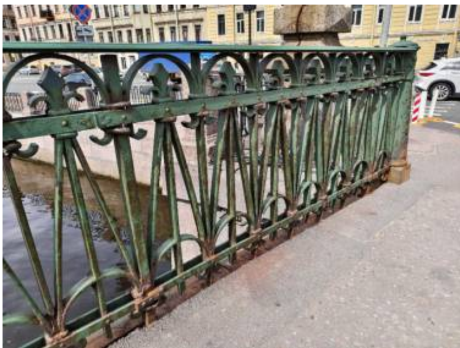
32. «Мост Аларчин» входящий в состав комплекса «Набережные и мосты Екатерининского канала (ныне канала Грибоедова)», через канал Грибоедова по Английскому проспекту. Фрагмент. Фото 09.07.2025г.
