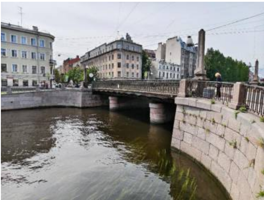
7. «Мост Аларчин» входящий в состав комплекса «Набережные и мосты Екатерининского канала (ныне канала Грибоедова)», через канал Грибоедова по Английскому проспекту. Восточный фасад. Общий вид. Фото 09.07.2025г.
