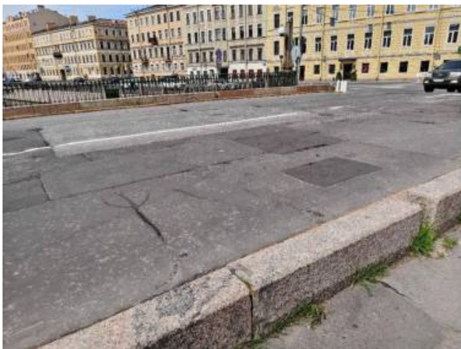
16. «Мост Аларчин» входящий в состав комплекса «Набережные и мосты Екатерининского канала (ныне канала Грибоедова)», через канал Грибоедова по Английскому проспекту. Фрагмент. Фото 09.07.2025г.
