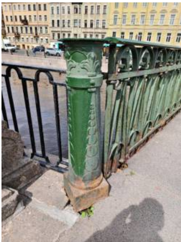
25. «Мост Аларчин» входящий в состав комплекса «Набережные и мосты Екатерининского канала (ныне канала Грибоедова)», через канал Грибоедова по Английскому проспекту. Фрагмент. Фото 09.07.2025г.
