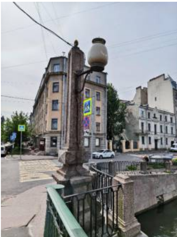
27. «Мост Аларчин» входящий в состав комплекса «Набережные и мосты Екатерининского канала (ныне канала Грибоедова)», через канал Грибоедова по Английскому проспекту. Фрагмент. Фото 09.07.2025г.
