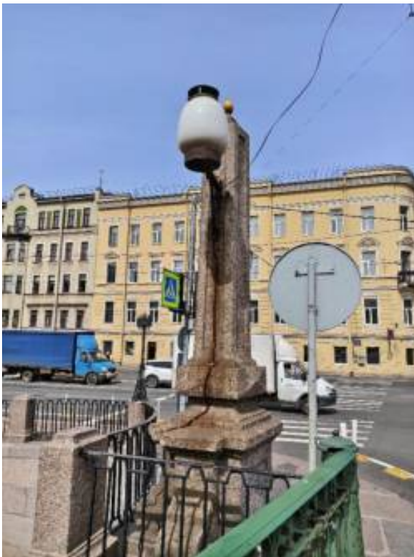
30. «Мост Аларчин» входящий в состав комплекса «Набережные и мосты Екатерининского канала (ныне канала Грибоедова)», через канал Грибоедова по Английскому проспекту. Фрагмент. Фото 09.07.2025г.
