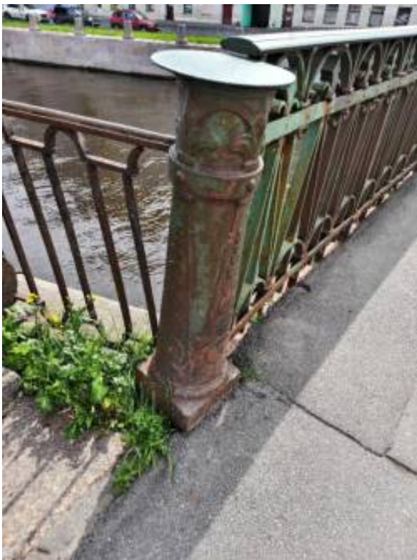
21. «Мост Аларчин» входящий в состав комплекса «Набережные и мосты Екатерининского канала (ныне канала Грибоедова)», через канал Грибоедова по Английскому проспекту. Фрагмент. Фото 09.07.2025г.
