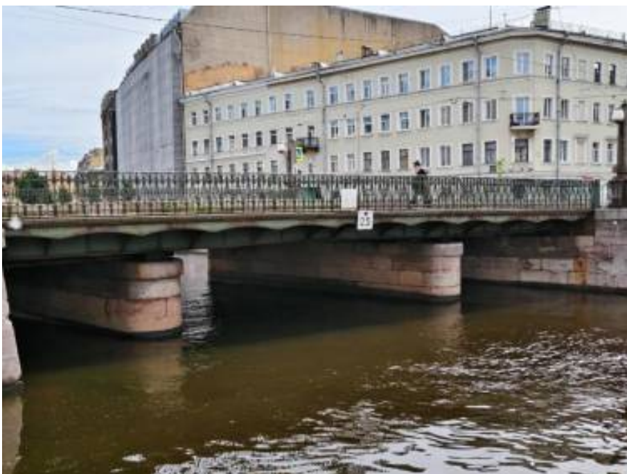
6. «Мост Аларчин» входящий в состав комплекса «Набережные и мосты Екатерининского канала (ныне канала Грибоедова)», через канал Грибоедова по Английскому проспекту. Западный фасад. Фрагмент. Фото 09.07.2025г.
