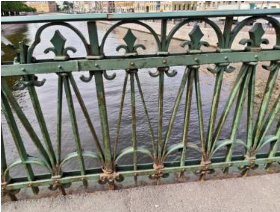
29. «Мост Аларчин» входящий в состав комплекса «Набережные и мосты Екатерининского канала (ныне канала Грибоедова)», через канал Грибоедова по Английскому проспекту. Фрагмент. Фото 09.07.2025г.
