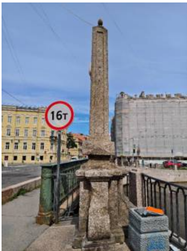
13. «Мост Аларчин» входящий в состав комплекса «Набережные и мосты Екатерининского канала (ныне канала Грибоедова)», через канал Грибоедова по Английскому проспекту. Фрагмент. Фото 09.07.2025г.
