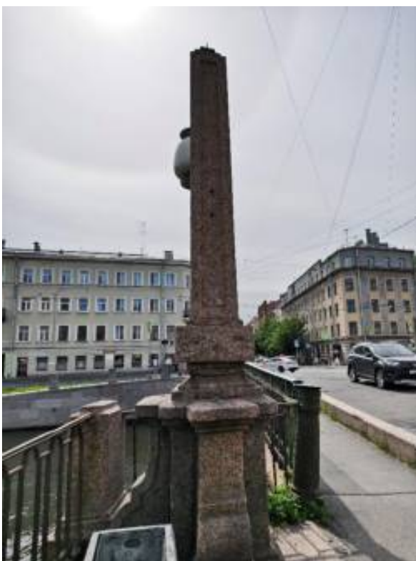
22. «Мост Аларчин» входящий в состав комплекса «Набережные и мосты Екатерининского канала (ныне канала Грибоедова)», через канал Грибоедова по Английскому проспекту. Фрагмент. Фото 09.07.2025г.
