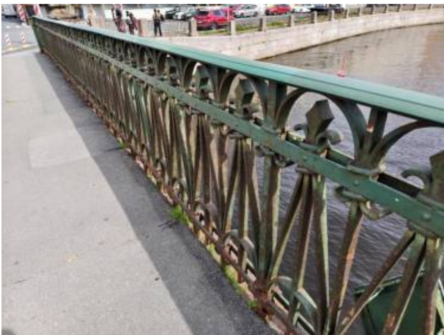
18. «Мост Аларчин» входящий в состав комплекса «Набережные и мосты Екатерининского канала (ныне канала Грибоедова)», через канал Грибоедова по Английскому проспекту. Фрагмент. Фото 09.07.2025г.
