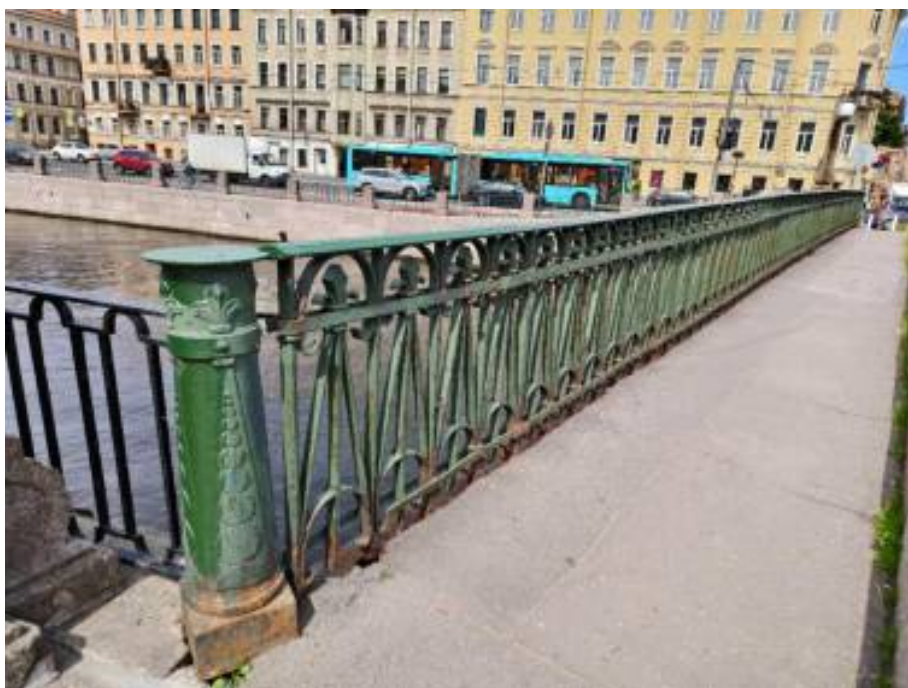
26. «Мост Аларчин» входящий в состав комплекса «Набережные и мосты Екатерининского канала (ныне канала Грибоедова)», через канал Грибоедова по Английскому проспекту. Фрагмент. Фото 09.07.2025г.
