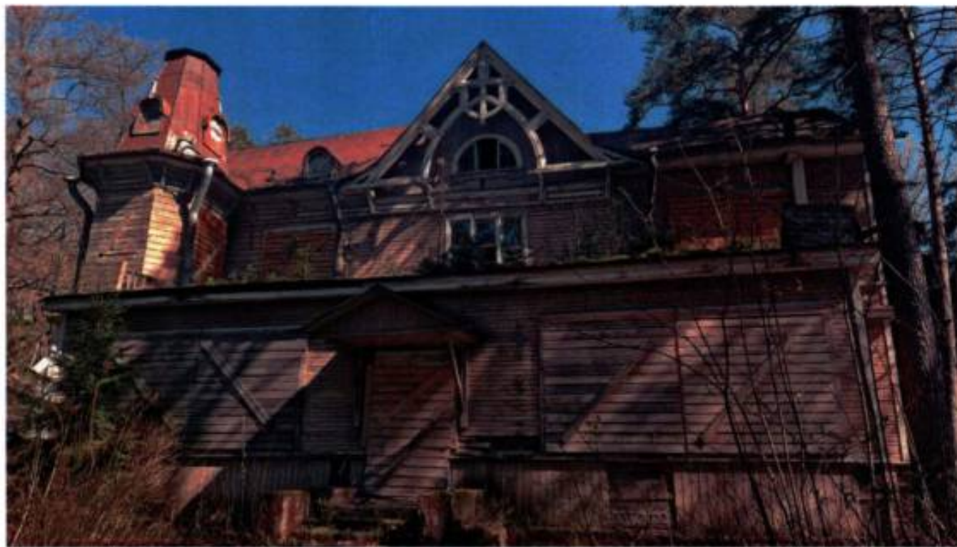
2. Южный фасад объекта культурного наследия (Фотография от 12.05.2025).
