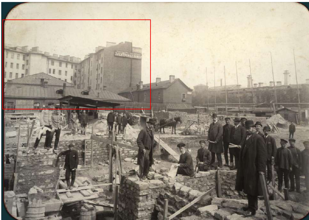
Илл. 19. Строительство дома Российского общества страхования капиталов и доходов «Жизнь». На дальнем плане дом по совр. адресу: Санкт-Петербург, ул. Академика Лебедева, д. 14/2. 1912 г. (источник: https://pastvu.com/p/2363053 ).
