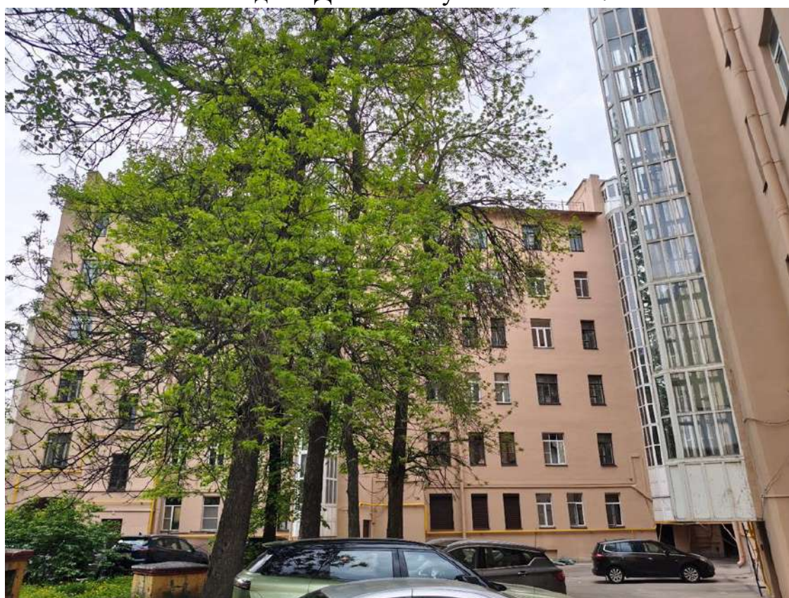
Фото 12. Вид на дворовые фасады выявленного объекта культурного наследия «Дом М.Е. Румшишского».
