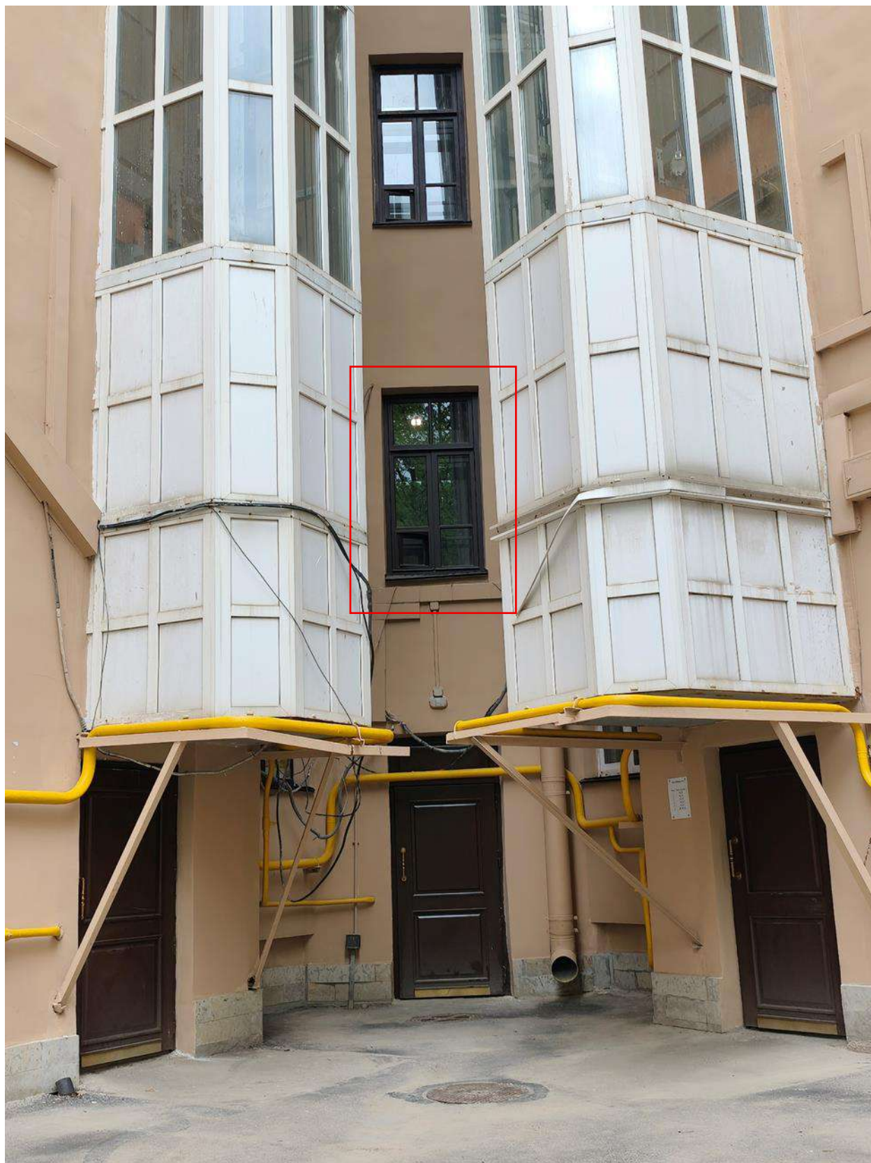
Фото 13. Вид на дворовые фасады выявленного объекта культурного наследия «Дом М.Е. Румшишского». Красным отмечены оконные проемы квартиры № 40.
