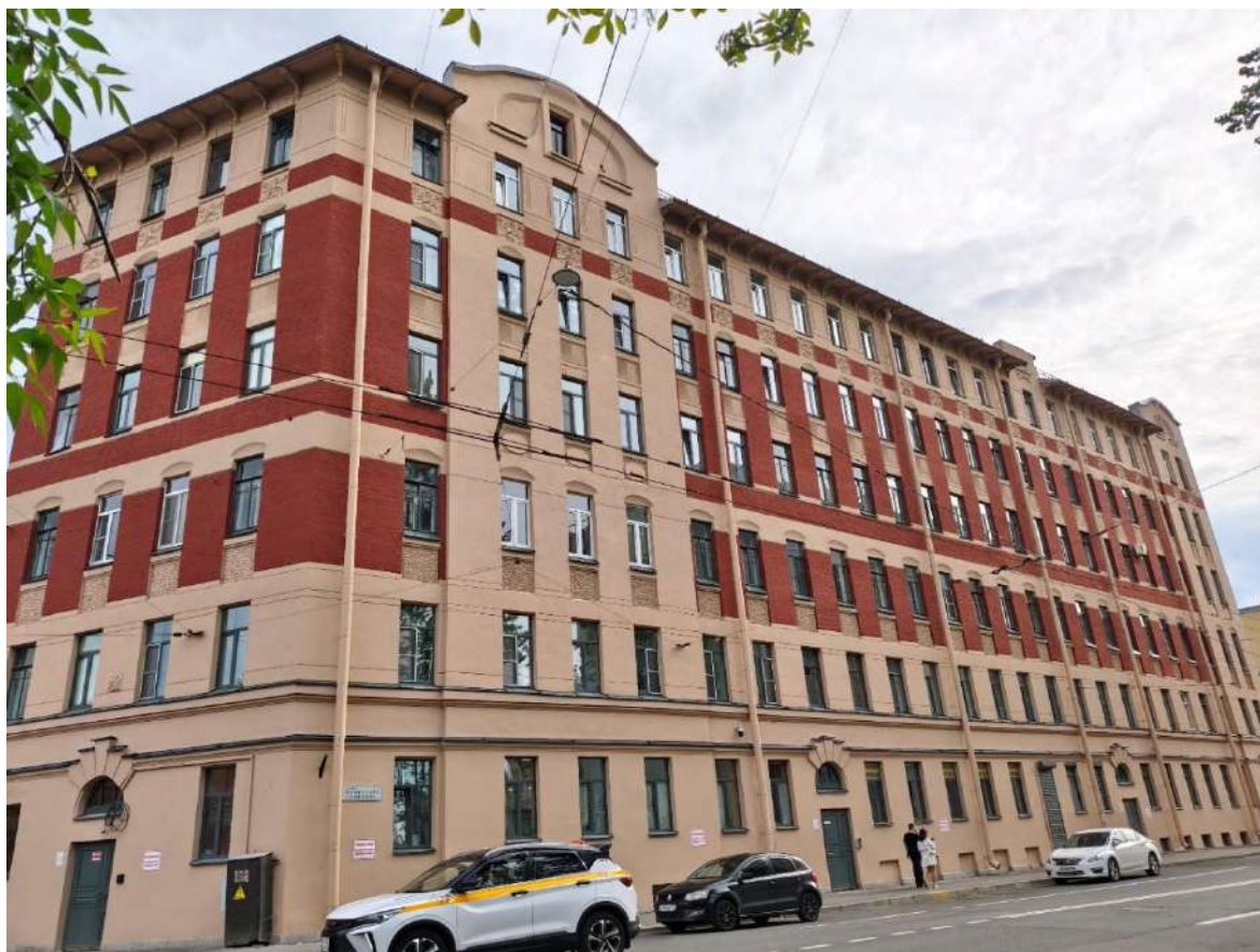
Фото 5. Вид на угловой фасад выявленного объекта культурного наследия «Дом М.Е. Румшишского» и фасад по улице Комиссара Смирнова.
