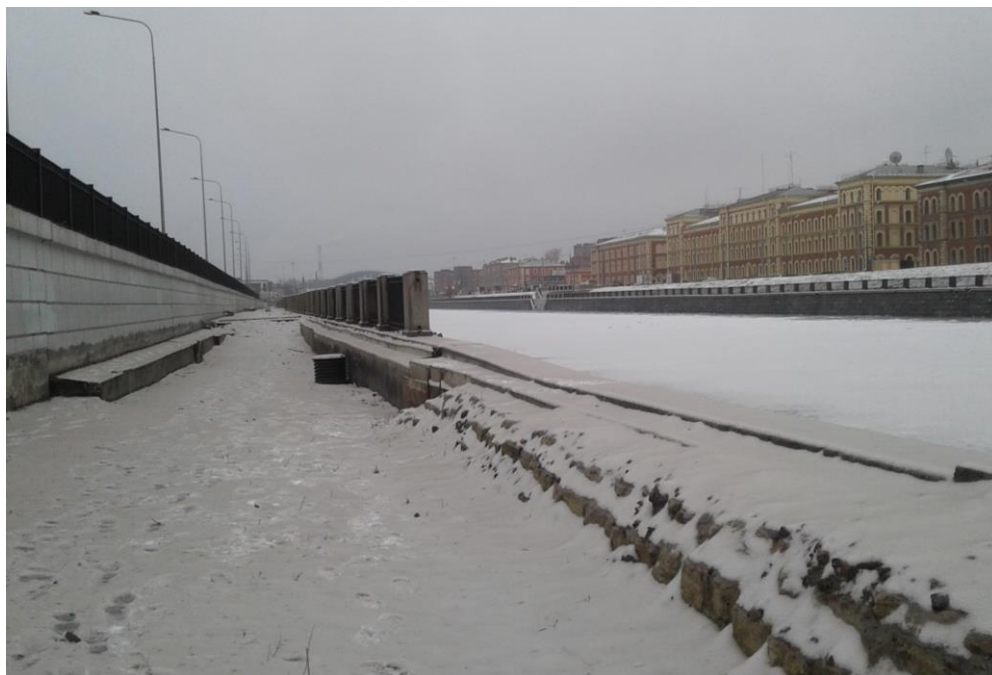
26. Объект культурного наследия регионального значения «Набережная Обводного канала» по адресу: от Шлиссельбургского моста до Московской ж. д. Участок от протоки Французского ковша до Атаманского моста, левый берег. Нижний уровень. Фрагмент. Общий вид в западном направлении (в сторону Атаманского моста).
