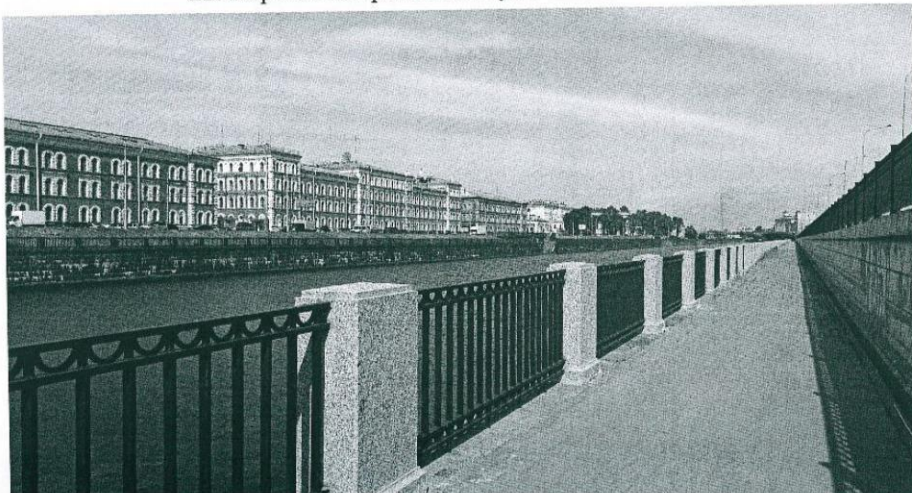
22. Парапет из гранитных тумб и металлической решетки
