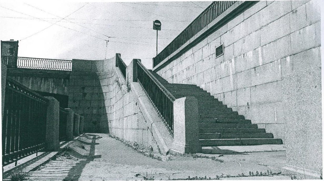
9. Лестничный спуск на нижний ярус. Стенки набережной имеют линейный руст
