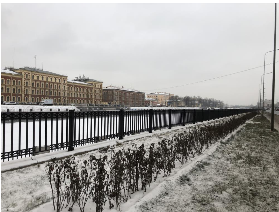
10. Объект культурного наследия регионального значения «Набережная Обводного канала» по адресу: от Шлиссельбургского моста до Московской ж. д. (Участок от протоки Французского ковш до Атаманского моста, левый берег). Верхний уровень. Вид в восточном направлении (в сторону Французского моста). Фрагмент.
