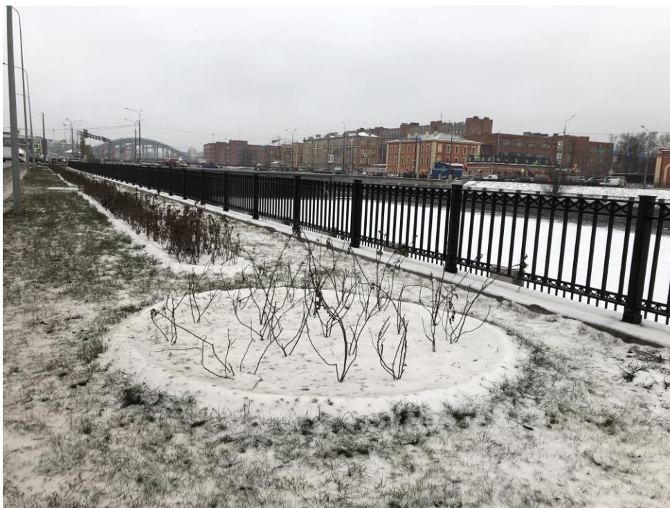
9. Объект культурного наследия регионального значения «Набережная Обводного канала» по адресу: от Шлиссельбургского моста до Московской ж. д. (Участок от протоки Французского ковш до Атаманского моста, левый берег). Верхний уровень (вид в западном направлении, в сторону Атаманского моста). Фрагмент.
