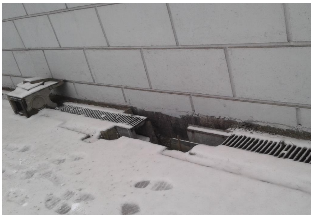
20. Объект культурного наследия регионального значения «Набережная Обводного канала» по адресу: от Шлиссельбургского моста до Московской ж. д. (Участок от протоки Французского ковша до Атаманского моста, левый берег). Нижний уровень. Металлическая решетка дренажного лотка.
