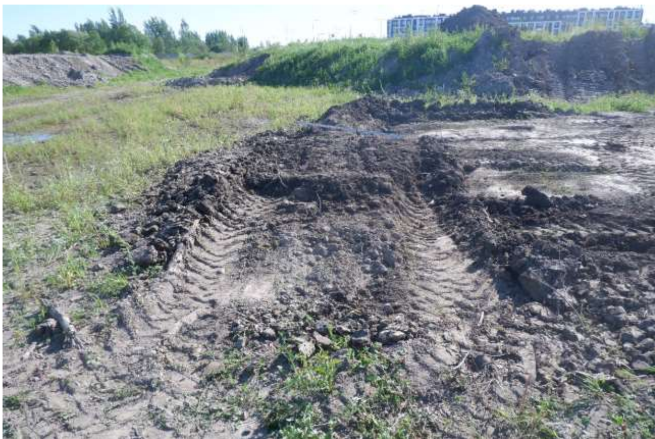
Рис. 60. СПб-2026. Московский район, Пулковское шоссе, дом 103, литера М. Шурф 3-5. Вид с СВ
