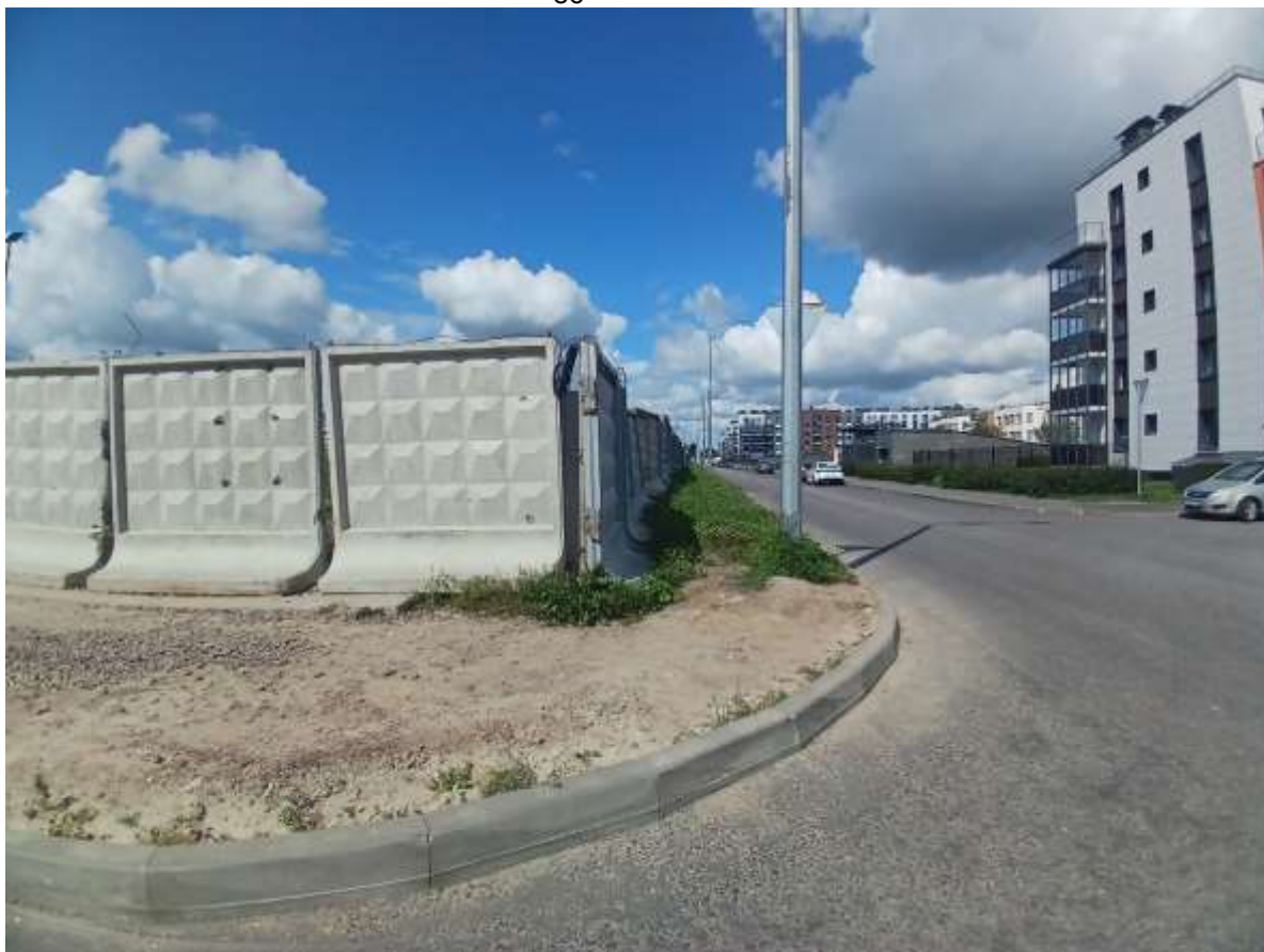
Рис. 15. СПб-2026. Московский район, Пулковское шоссе, дом 103, литера М. Общий вид участка обследования
