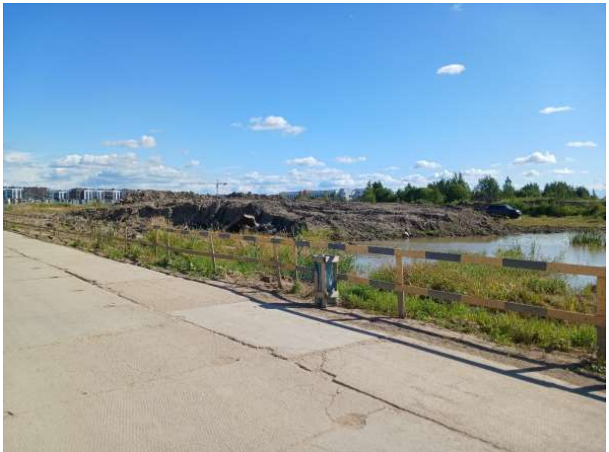
Рис. 26. СПб-2026. Московский район, Пулковское шоссе, дом 103, литера М. Общий вид участка обследования
