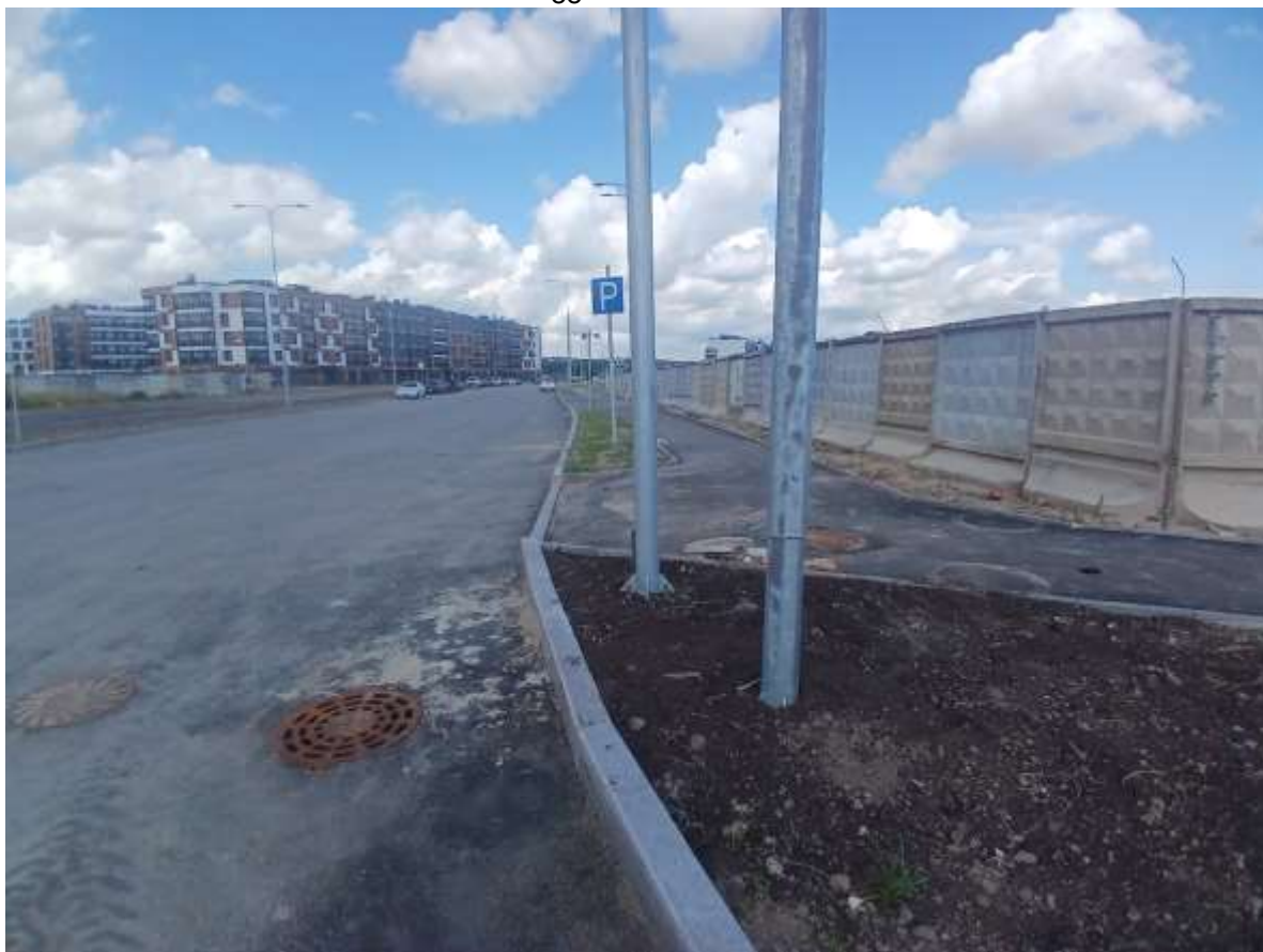
Рис. 19. СПб-2026. Московский район, Пулковское шоссе, дом 103, литера М. Общий вид участка обследования
