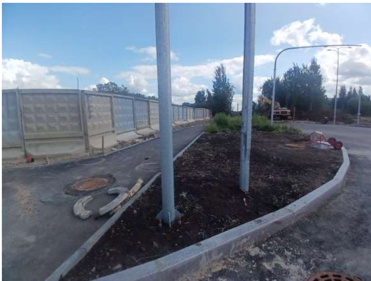
Рис. 20. СПб-2026. Московский район, Пулковское шоссе, дом 103, литера М. Общий вид участка обследования
