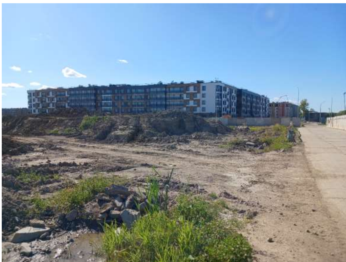
Рис. 28. СПб-2026. Московский район, Пулковское шоссе, дом 103, литера М. Общий вид участка обследования
