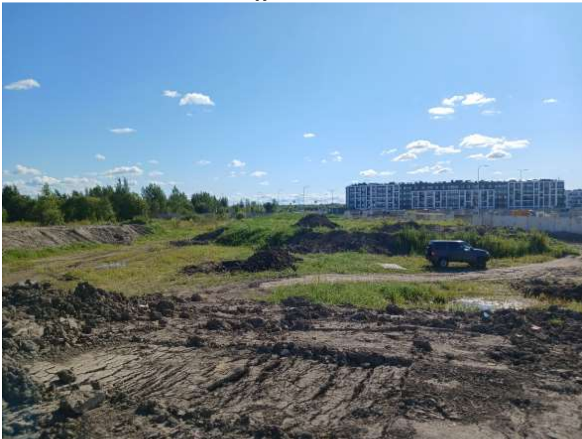
Рис. 29. СПб-2026. Московский район, Пулковское шоссе, дом 103, литера М. Общий вид участка обследования
