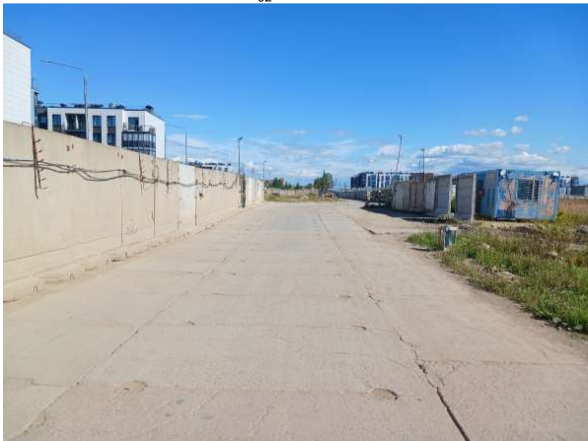
Рис. 27. СПб-2026. Московский район, Пулковское шоссе, дом 103, литера М. Общий вид участка обследования
