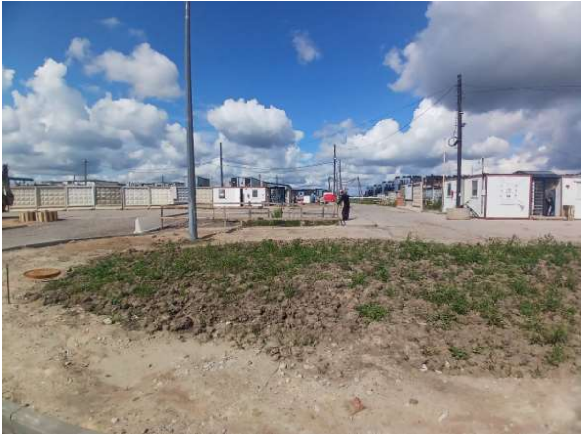
Рис. 17. СПб-2026. Московский район, Пулковское шоссе, дом 103, литера М. Общий вид участка обследования
