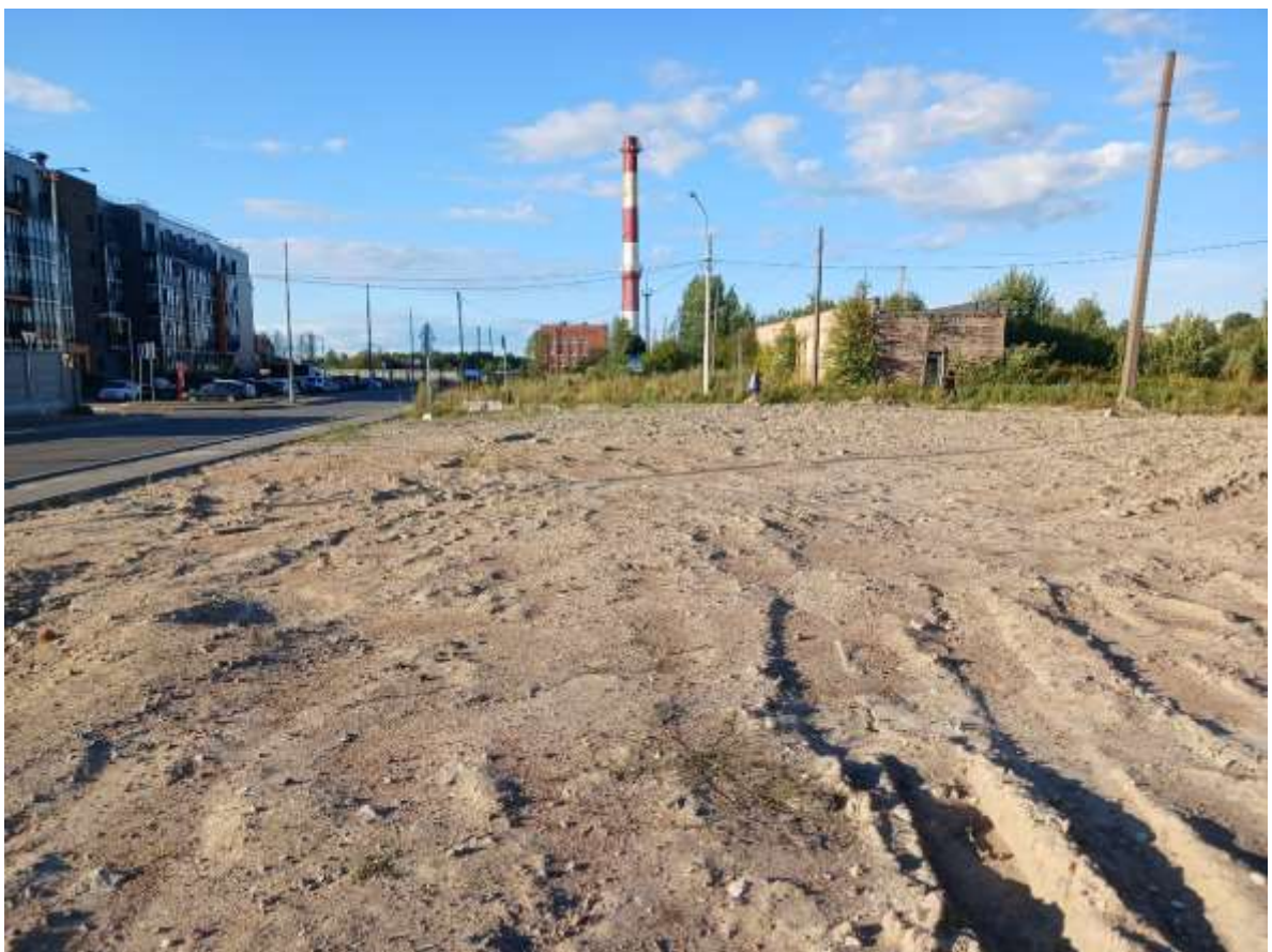
Рис. 40. СПб-2026. Московский район, Пулковское шоссе, дом 103, литера М. Общий вид участка обследования
