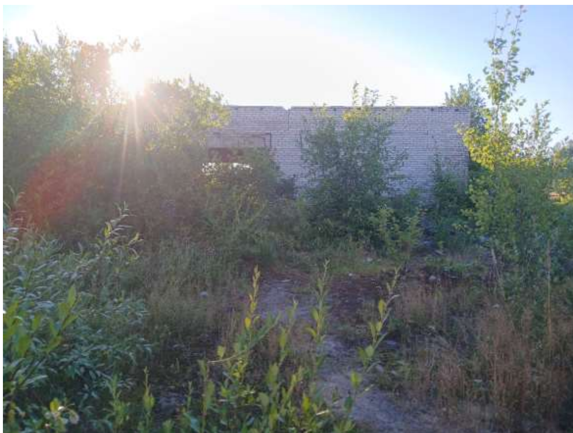
Рис. 46. СПб-2026. Московский район, Пулковское шоссе, дом 103, литера М. Общий вид участка обследования
