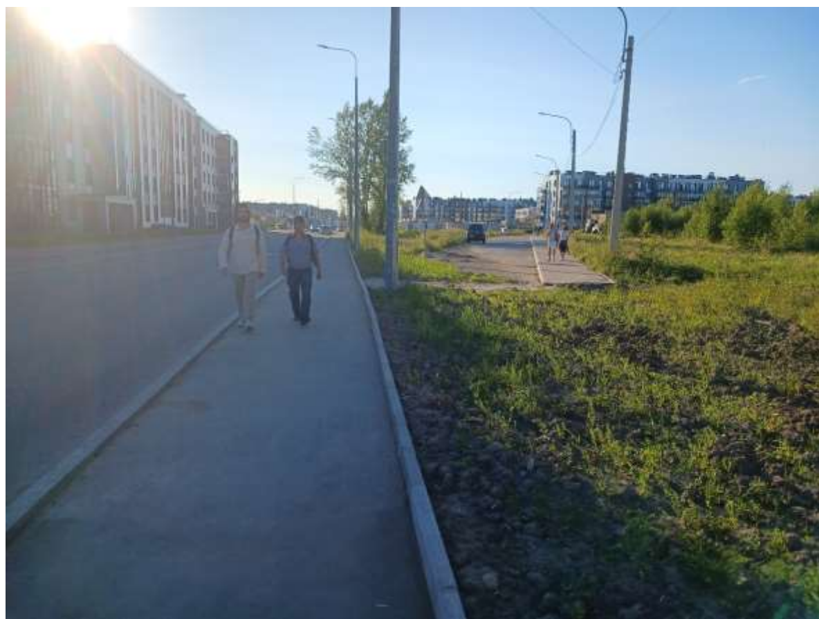
Рис. 38. СПб-2026. Московский район, Пулковское шоссе, дом 103, литера М. Общий вид участка обследования
