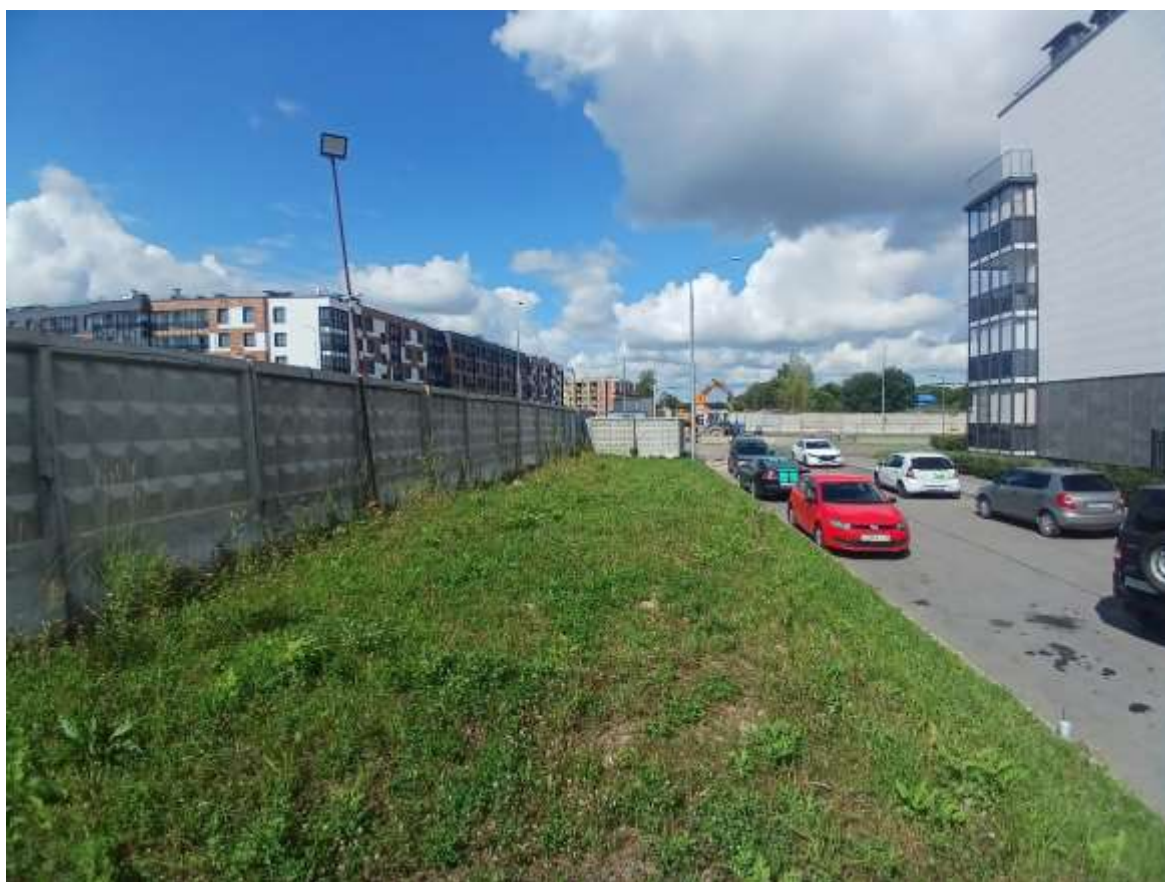
Рис. 14. СПб-2026. Московский район, Пулковское шоссе, дом 103, литера М. Общий вид участка обследования
