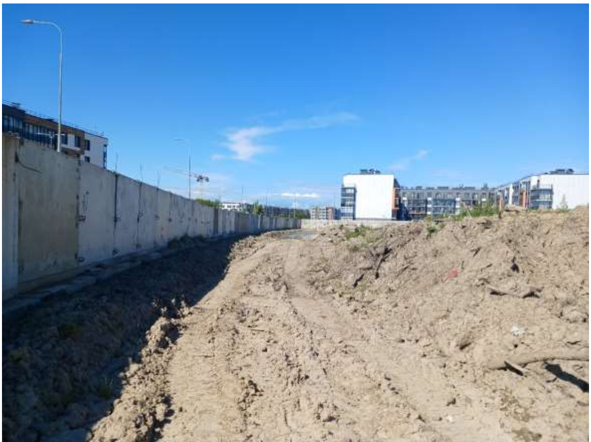
Рис. 22. СПб-2026. Московский район, Пулковское шоссе, дом 103, литера М. Общий вид участка обследования
