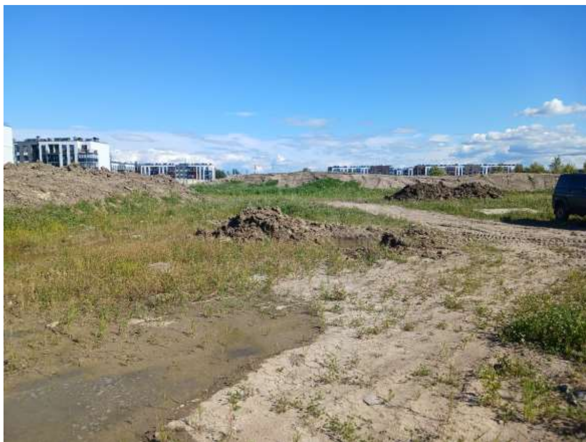
Рис. 24. СПб-2026. Московский район, Пулковское шоссе, дом 103, литера М. Общий вид участка обследования
