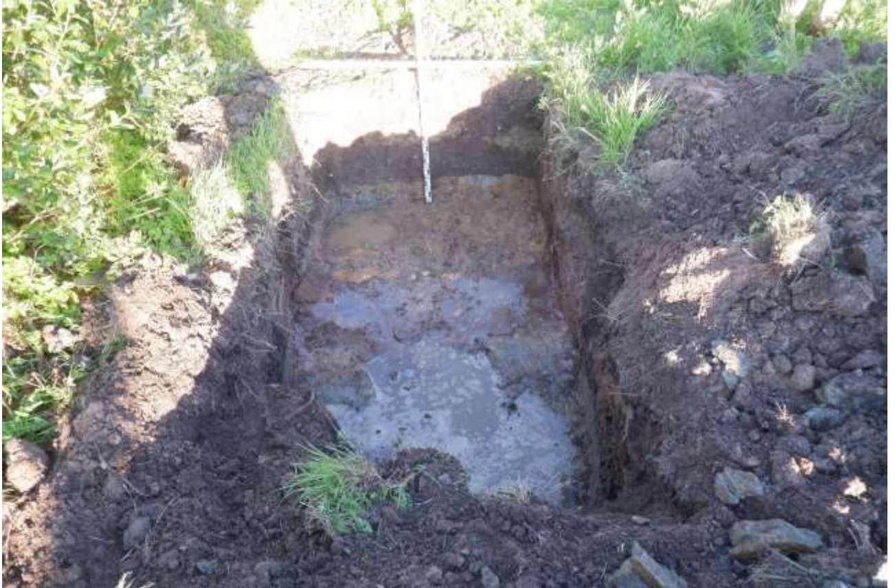
Рис. 73. СПб-2026. Московский район, Пулковское шоссе, дом 103, литера М. Шурф 10-11. Вид с Ю
