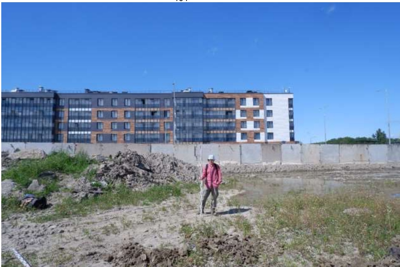
Рис. 51. СПб-2026. Московский район, Пулковское шоссе, дом 103, литера М. Шурф 1-2. Общий вид участка обследования до начала работ. Вид с В
