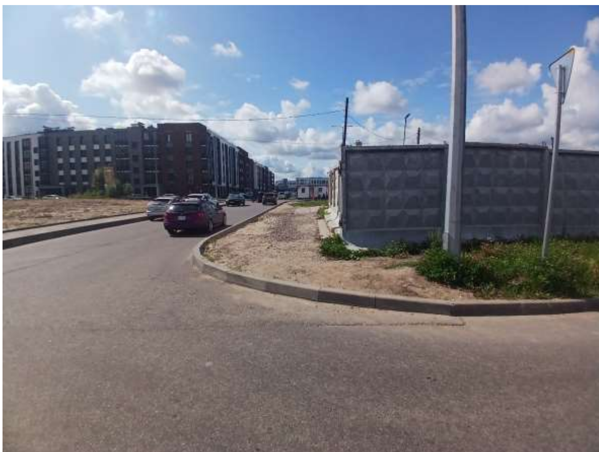
Рис. 16. СПб-2026. Московский район, Пулковское шоссе, дом 103, литера М. Общий вид участка обследования
