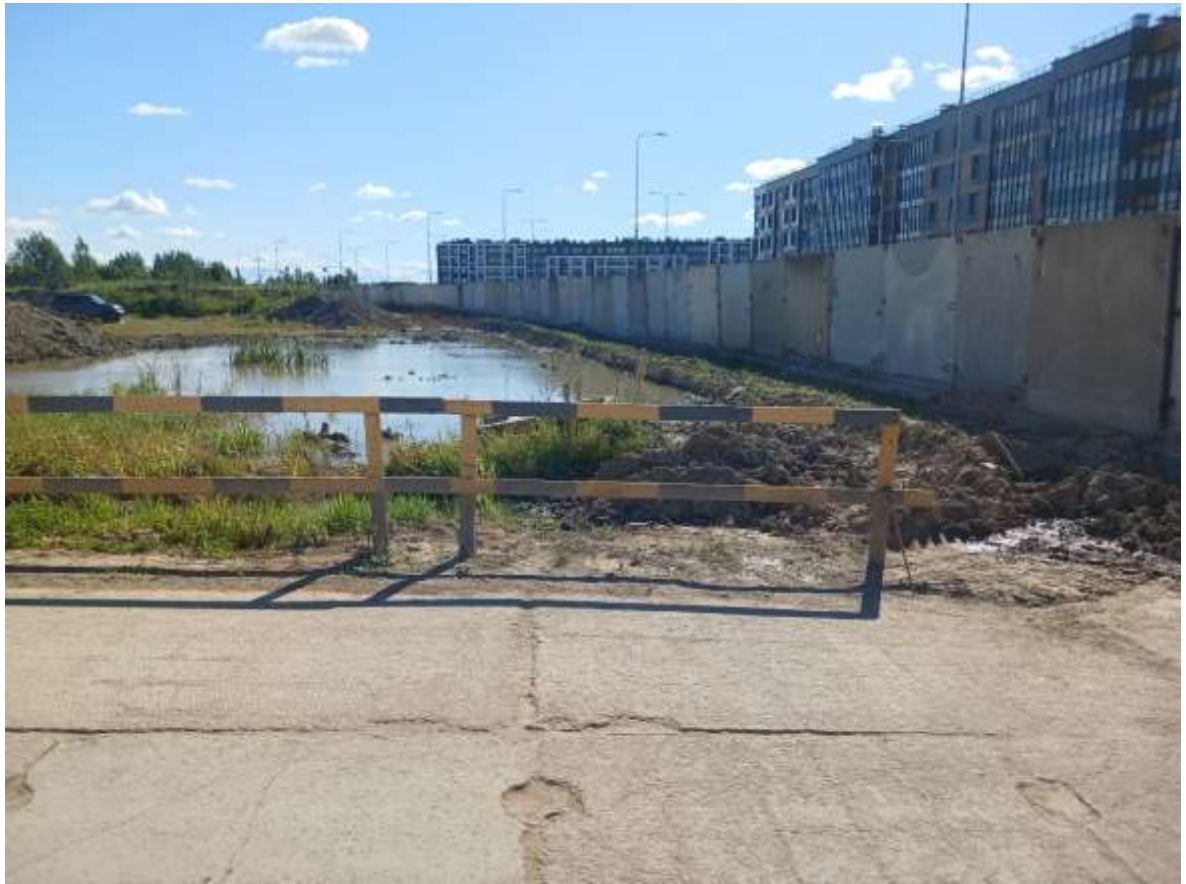
Рис. 25. СПб-2026. Московский район, Пулковское шоссе, дом 103, литера М. Общий вид участка обследования
