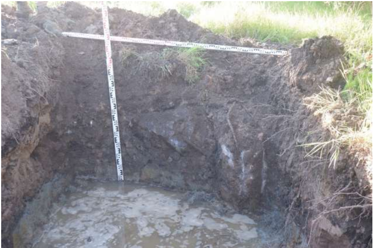
Рис. 74. СПб-2026. Московский район, Пулковское шоссе, дом 103, литера М. Шурф 10-11. Вид с Ю
