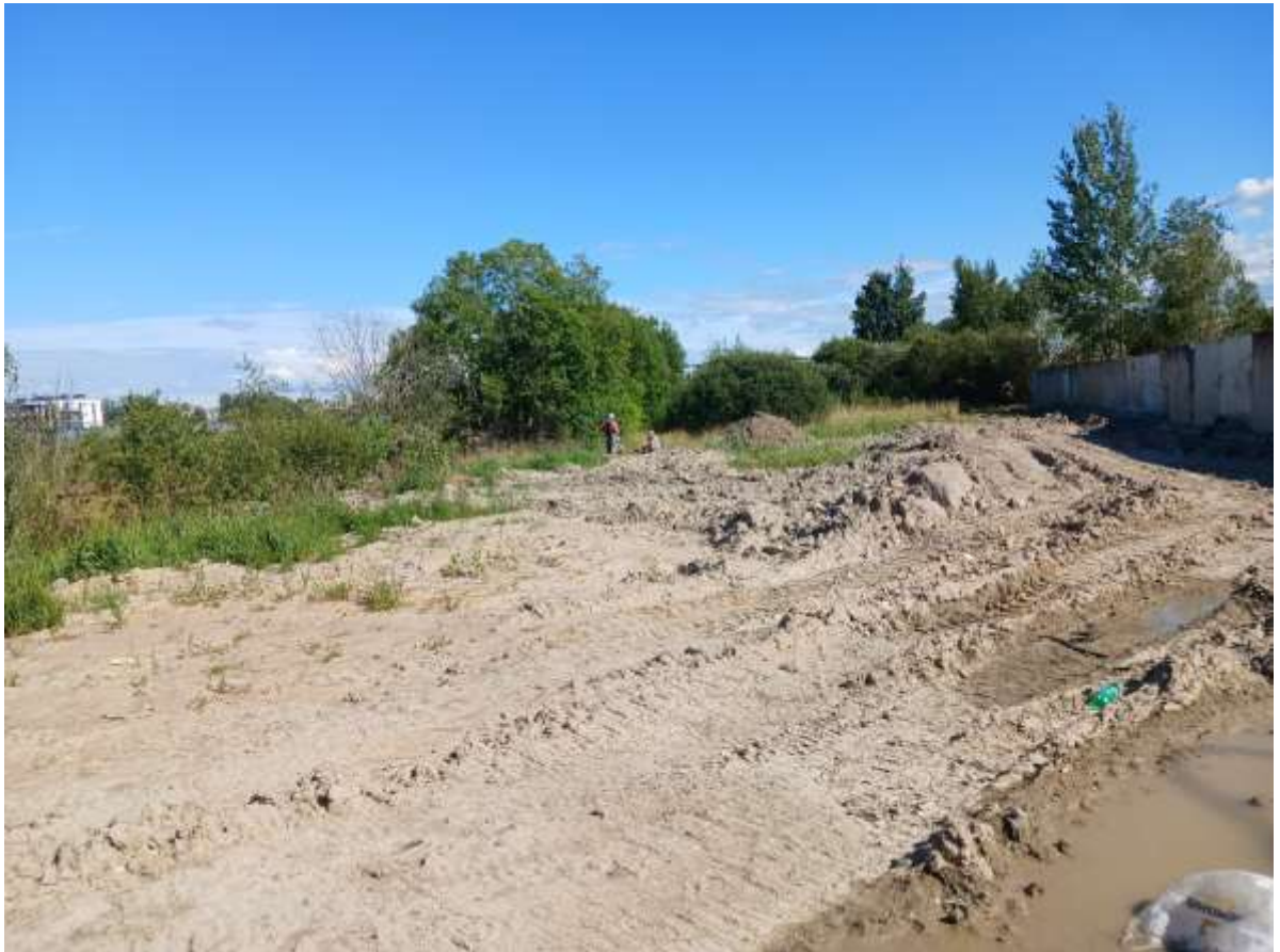
Рис. 21. СПб-2026. Московский район, Пулковское шоссе, дом 103, литера М. Общий вид участка обследования
