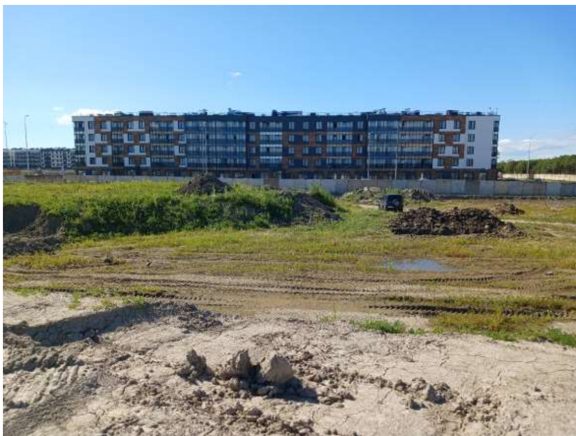
Рис. 32. СПб-2026. Московский район, Пулковское шоссе, дом 103, литера М. Общий вид участка обследования
