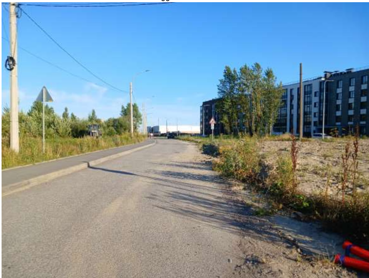
Рис. 41. СПб-2026. Московский район, Пулковское шоссе, дом 103, литера М. Общий вид участка обследования
