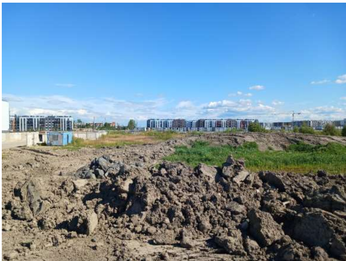
Рис. 30. СПб-2026. Московский район, Пулковское шоссе, дом 103, литера М. Общий вид участка обследования
