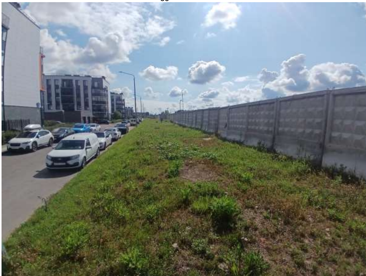
Рис. 13. СПб-2026. Московский район, Пулковское шоссе, дом 103, литера М. Общий вид участка обследования
