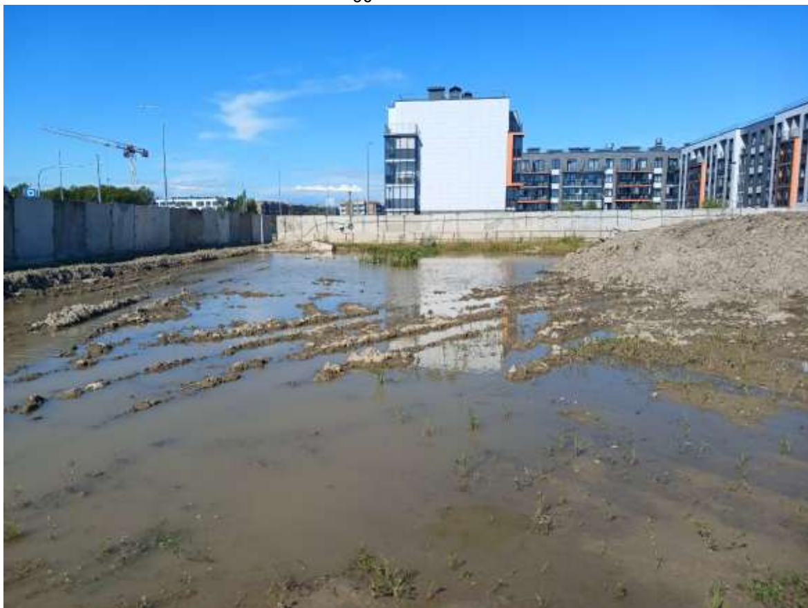
Рис. 23. СПб-2026. Московский район, Пулковское шоссе, дом 103, литера М. Общий вид участка обследования
