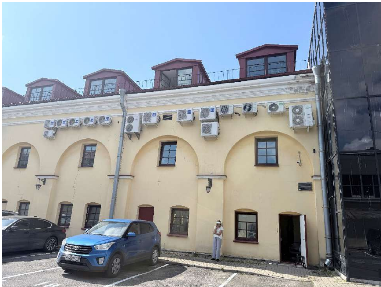
Фото 17. Общий вид на часть дворового фасада объекта.
