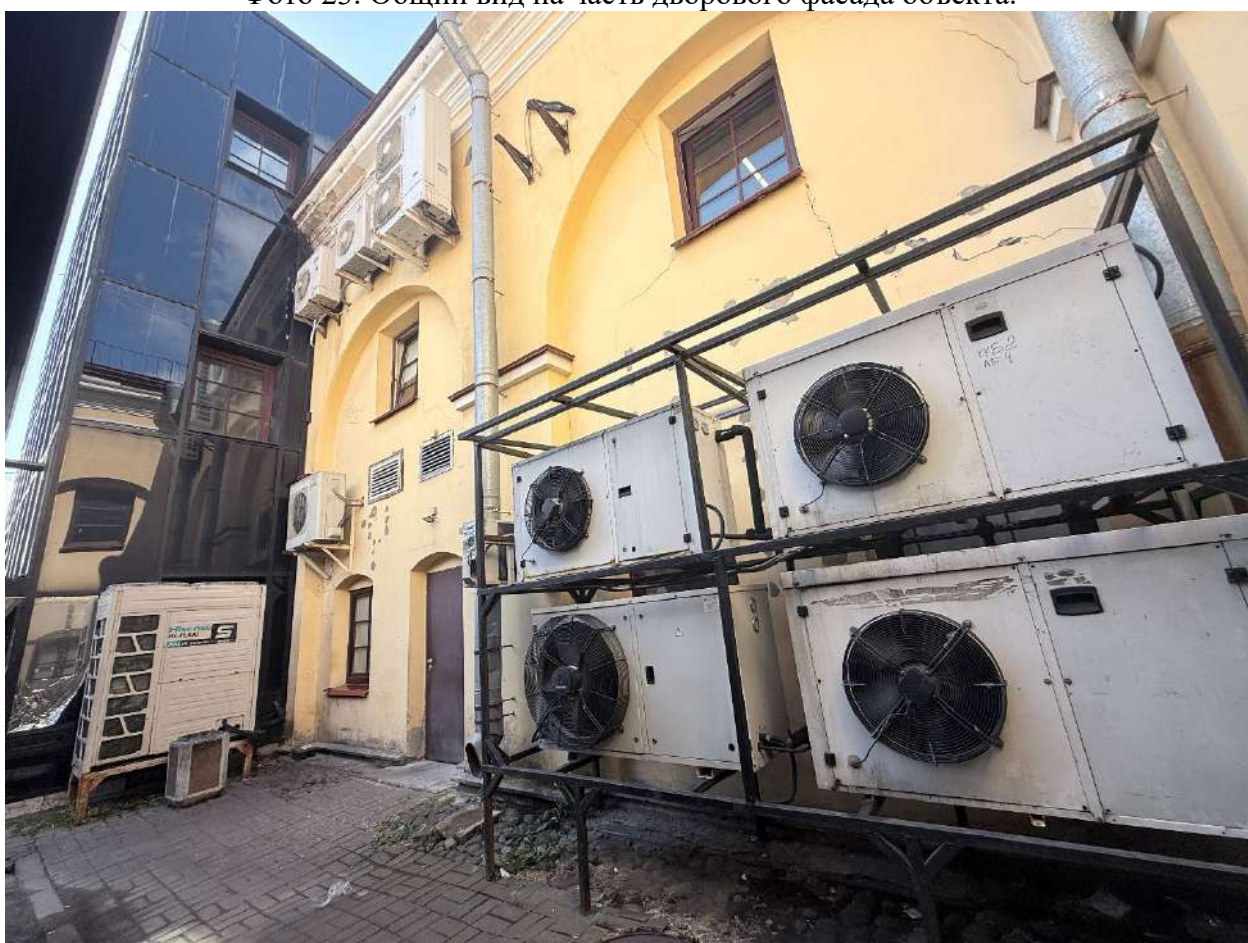
Фото 24. Общий вид на часть дворового фасада объекта.
