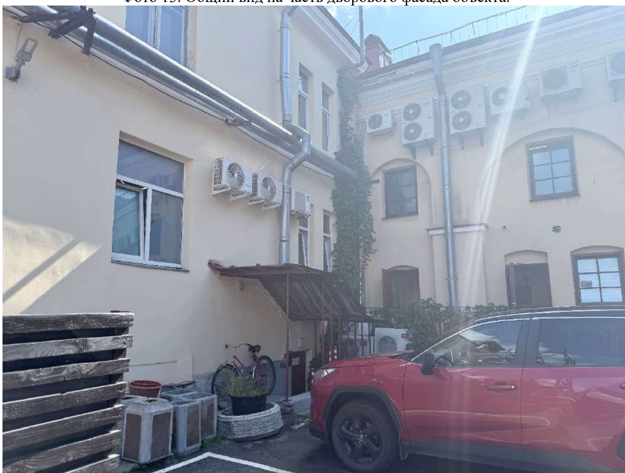
Фото 14. Общий вид на часть дворового фасада объекта.
