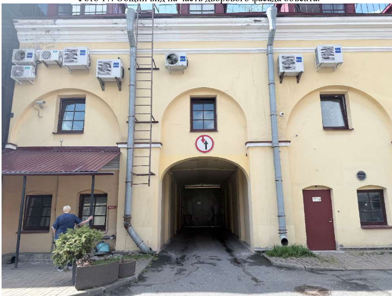
Фото 18. Общий вид на часть дворового фасада объекта.
