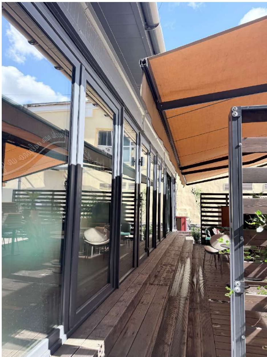
Фото 25. Общий вид на часть дворового фасада объекта.
