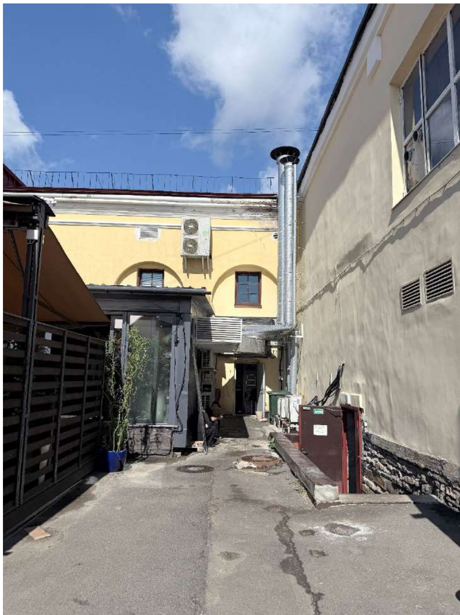
Фото 26. Общий вид на часть дворового фасада объекта.
