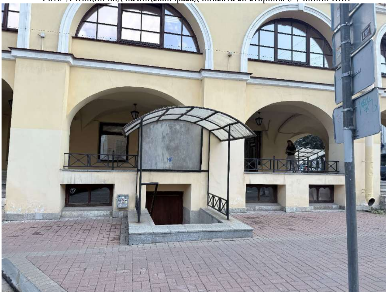
Фото 8. Общий вид на приямок на лицевом фасаде объекта со стороны 6-7 линий В.О.
