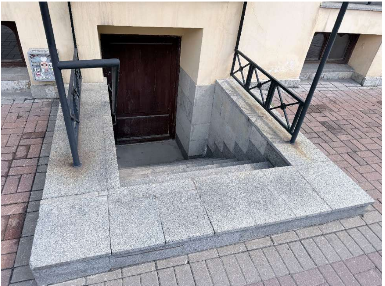
Фото 9. Общий вид на приямок на лицевом фасаде объекта со стороны 6-7 линий В.О.
