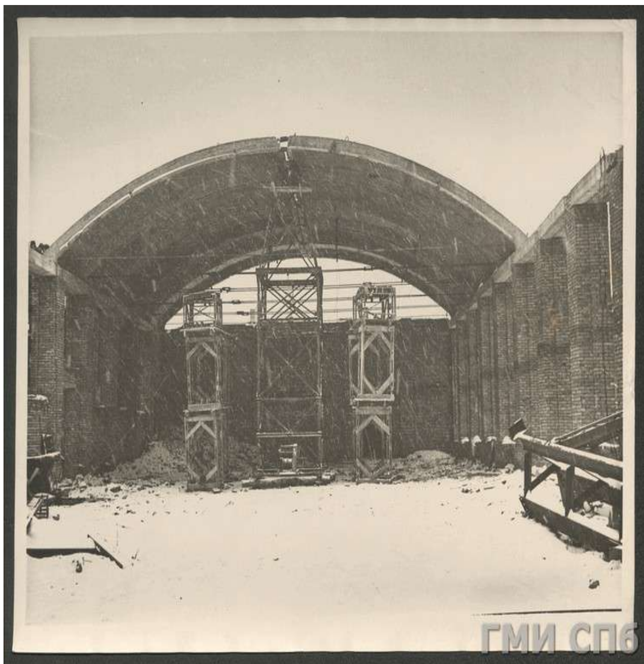
Рис.№ 49. Андреевский рынок. Начало реконструкции.1950-е гг. ГМИ СПб
