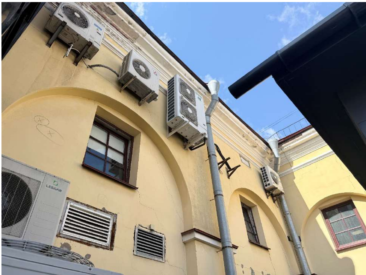
Фото 23. Общий вид на часть дворового фасада объекта.
