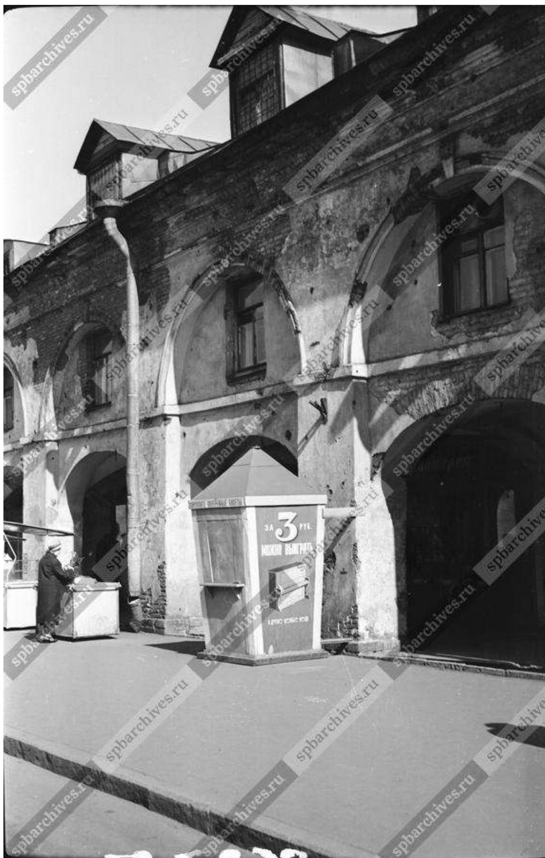
Рис.№ 48. Реконструкция здания Андреевского рынка. Конец 1950-х гг.
