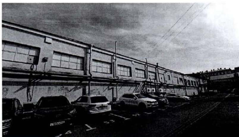
43. Территория объекта культурного наследия. Дополнительное инженерное оборудование (наружные блоки систем кондиционирования) примыкающие к фасаду здания не являющиеся объектом культурного наследия.
