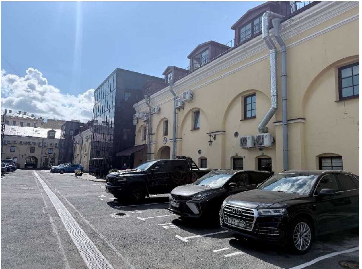
Фото 19. Общий вид на часть дворового фасада объекта.
