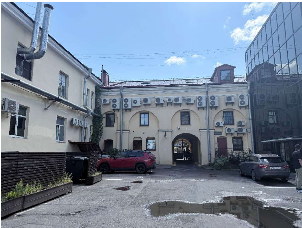
Фото 13. Общий вид на часть дворового фасада объекта.
