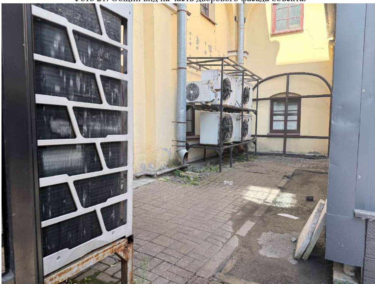
Фото 22. Общий вид на часть дворового фасада объекта.
