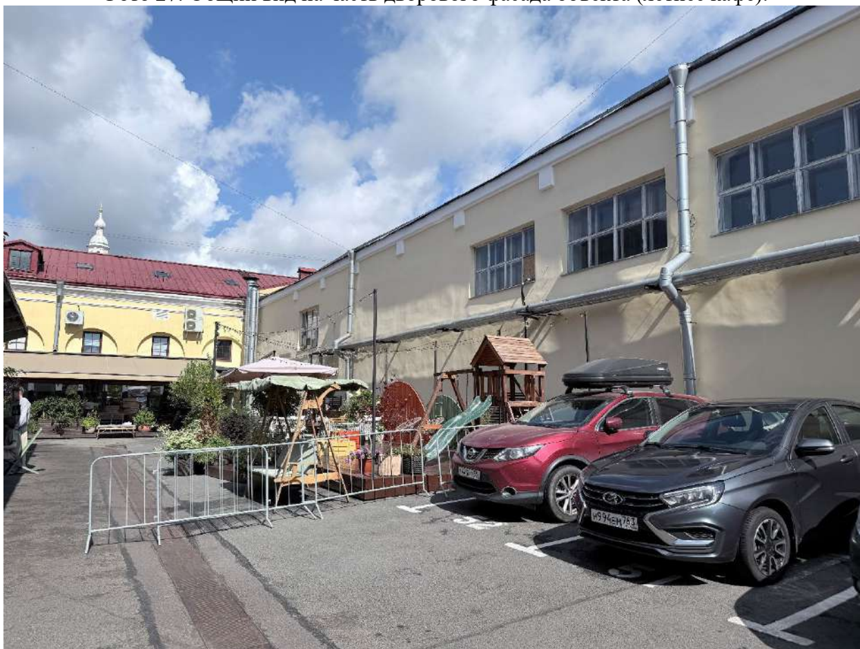
Фото 28. Общий вид на часть дворового фасада объекта (подиум).
