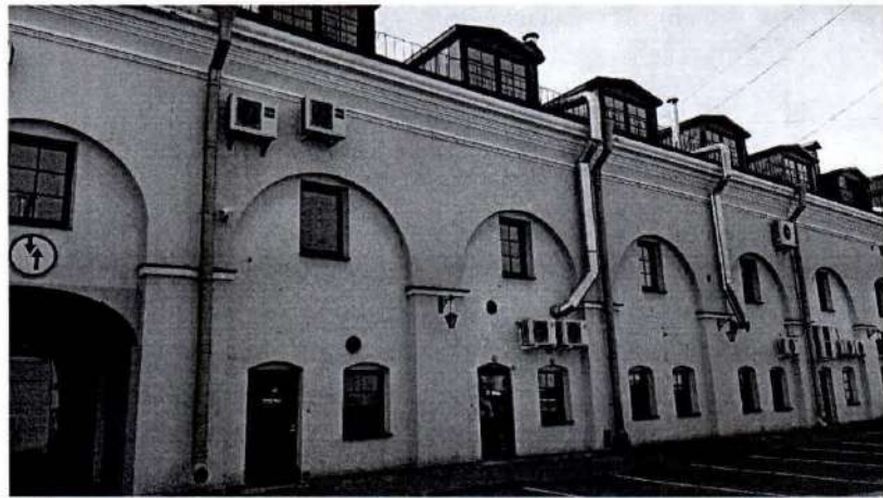
20. Фрагмент восточного дворового фасада с дополнительным оборудованием
