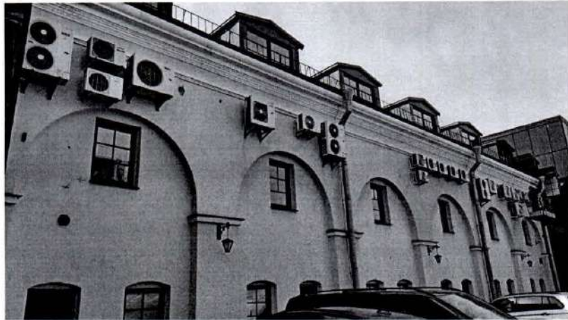
19. Фрагмент восточного дворового фасада с дополнительным оборудованием
