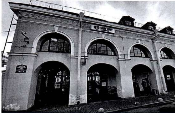
1. Фрагмент северного лицевого фасада
