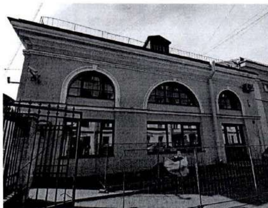
16. Южная часть восточного фасада
