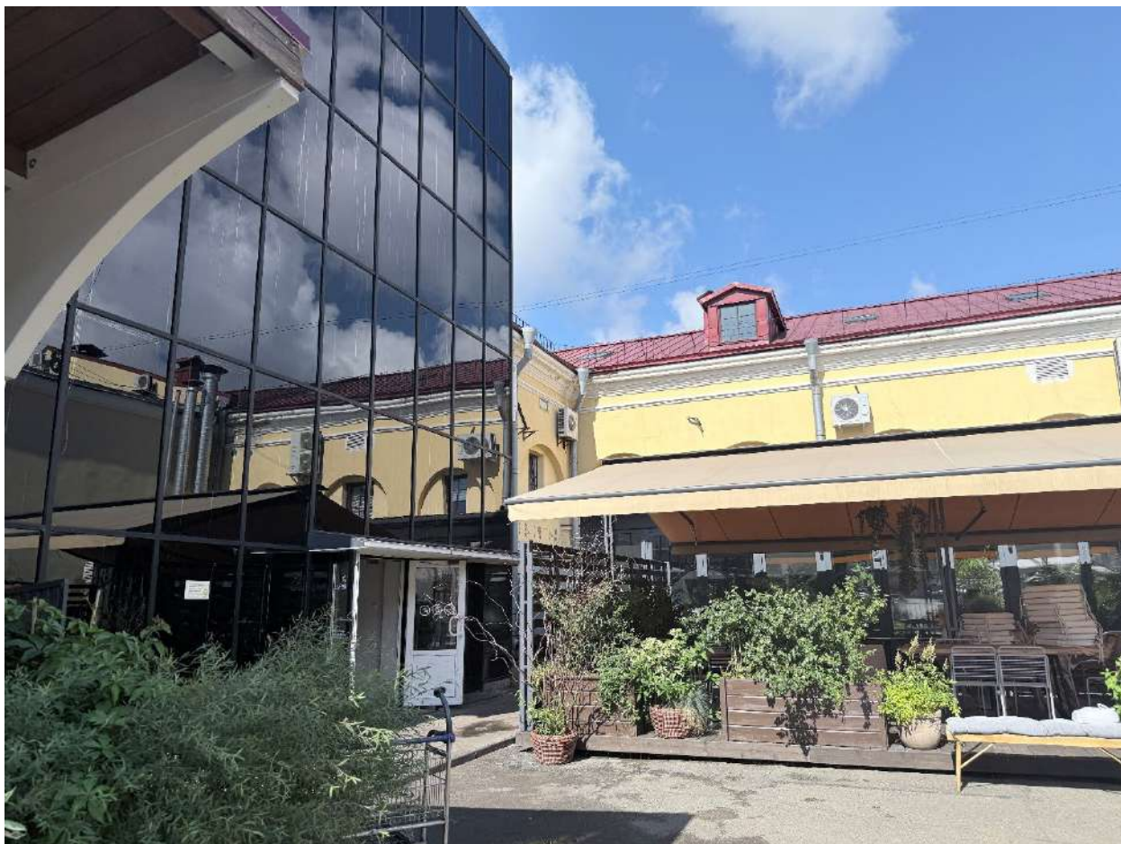
Фото 21. Общий вид на часть дворового фасада объекта.
