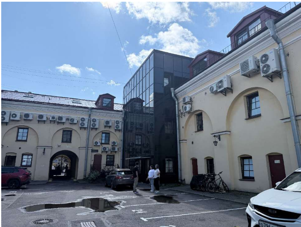
Фото 15. Общий вид на часть дворового фасада объекта.
