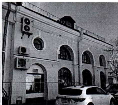
17. Северная часть восточного фасада
