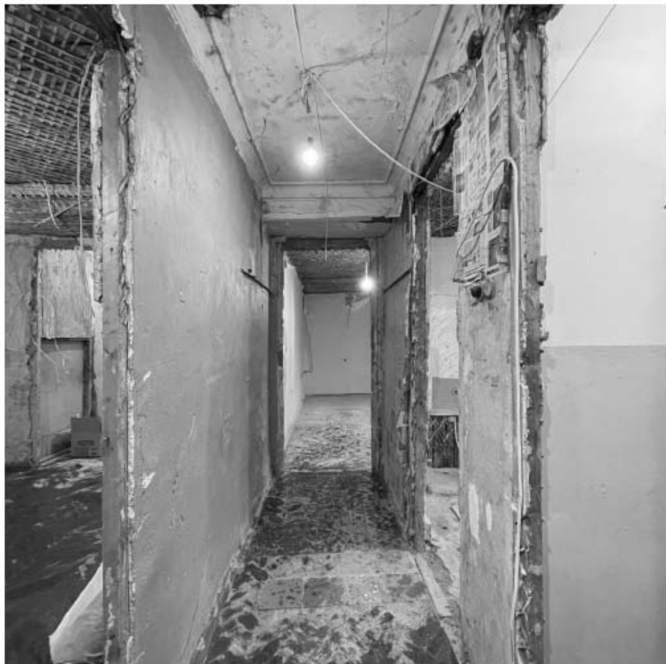
23. «Дом О.П. Кушелевой». Санкт-Петербург, Невский пр., д. 88, литера А. Фрагмент интерьера кв. №109 (Н-11). Коридор. Фото: 05.06.2026.
