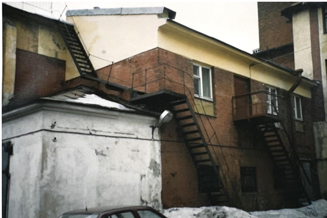
Илл. 59. Дворовый фасад северной части здания «Подстанции» (бывш. Тяговая подстанция (Староконная подстанция). Фото (копия) 2003 г. (ист. Проект приспособления бывшей тяговой подстанции под архив ГУП «Горэлектротранс». 2003 г. ООО «Творческая архитектурная мастерская Вальдбрит». Том I)
