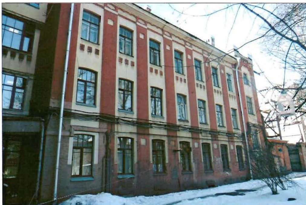
3. Общий вид с северо-востока.
