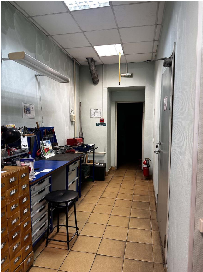
Фото 10. Помещение архива СПб ГУП «Горэлектротранс», расположенное в объекте культурного наследия регионального значения «Подстанция» (ул. Атаманская, д. 3/6 литера С). 1-ый этаж, коридор в южной части здания. Фото с севера. Дата съемки: 01.06.2026 г. Автор съемки: Куваева Ю.П.
