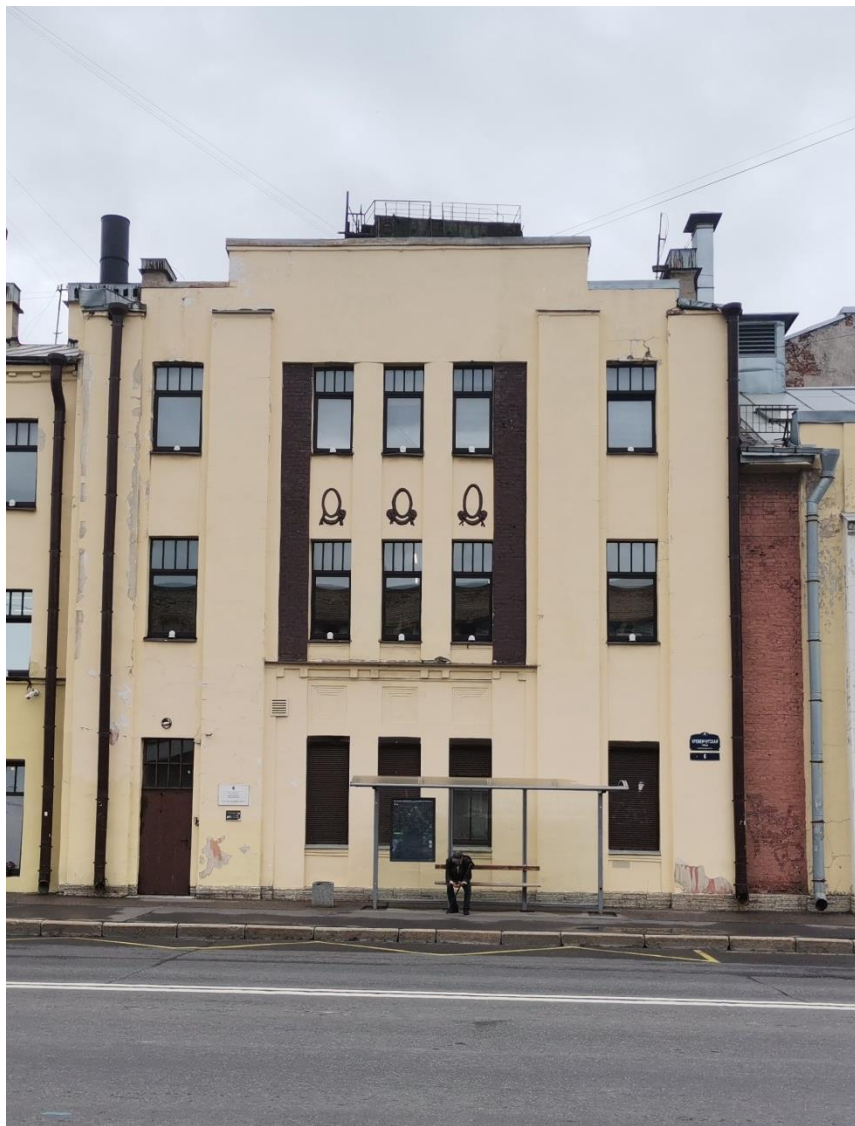
Фото 4. Уличный фасад служебного корпуса объекта культурного наследия регионального значения «Подстанция» по адресу: г. Санкт-Петербург, ул. Атаманская, д. 3/6 литера С. Фото с запада, со стороны ул. Кременчугской. Дата съемки: 01.06.2026 г. Автор съемки: Куваева Ю.П.
