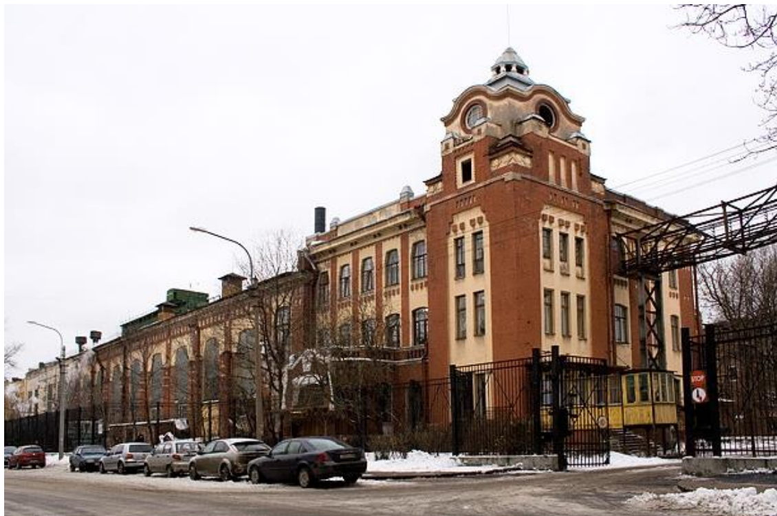
Илл. 61. Центральная электрическая станция. Фото (копия) 2020 г. (ист. https://ru.wikipedia.org/wiki/Центральная электростанция городского трамвая с водокачальной . Кириков, Лелина, Штиглиц. 2020)
