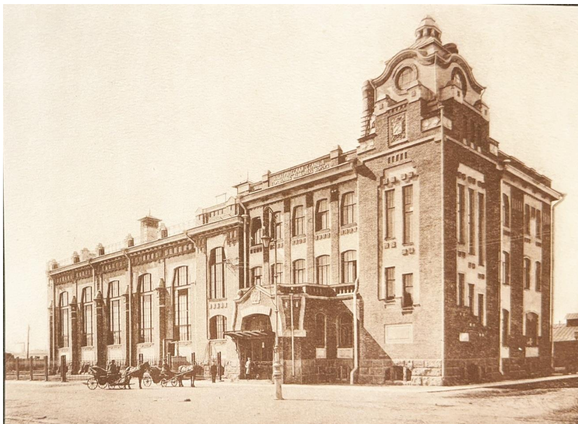
Илл. 51. Центральная электрическая станция городского трамвая НПО ЦКТИ им. И.И. Ползунова. Фото (копия) 1907 г. (ист. Описание сооружений С.-Петербургского электрического трамвая. Том II. Отчет по сооружению С-Петербургского городского электрического трамвая. 909. СПб)
