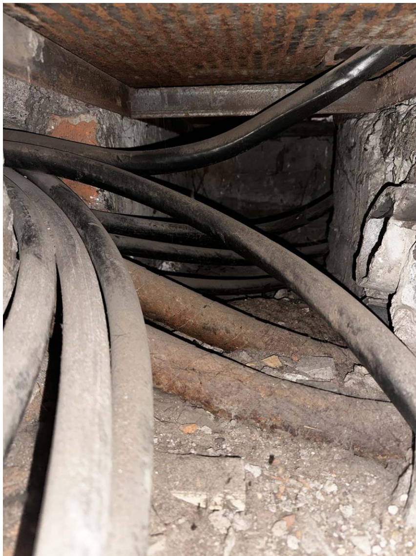
Фото 13. Помещение архива СПб ГУП «Горэлектротранс», расположенное в объекте культурного наследия регионального значения «Подстанция» (ул. Атаманская, д. 3/6 литера С). 1-ый этаж, техническое помещение в южной части дворовой одноэтажной пристройки здания. Существующая прокладка электрокабелей под полом вдоль северной стены помещения. Дата съемки: 01.06.2026 г. Автор съемки: Куваева Ю.П.
