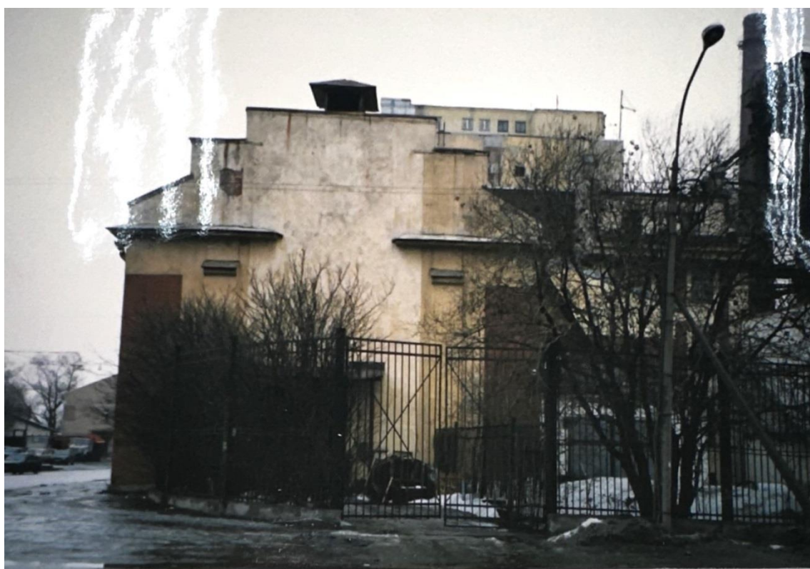
Илл. 58. Южный боковой фасад здания «Подстанции» (бывш. Тяговая подстанция (Староконная подстанция). Фото (копия) 2003 г. (ист. Проект приспособления бывшей тяговой подстанции под архив ГУП «Горэлектротранс». 2003 г. ООО «Творческая архитектурная мастерская Вальдбрит». Том I)
