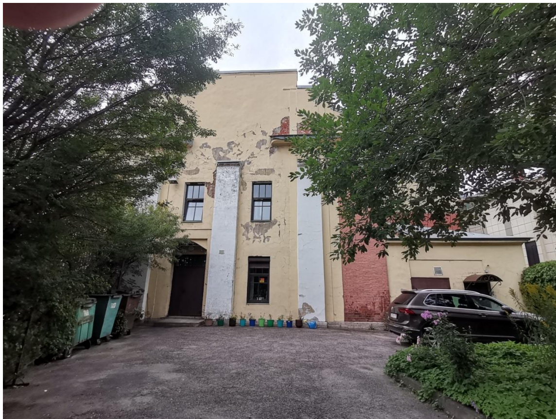
Фото 5. Общий вид южного фасада объекта культурного наследия регионального значения «Подстанция» по адресу: г. Санкт-Петербург, ул. Атаманская, д. 3/6 литера С. Фото с юга. Дата съемки: 01.06.2026 г. Автор съемки: Куваева Ю.П.
