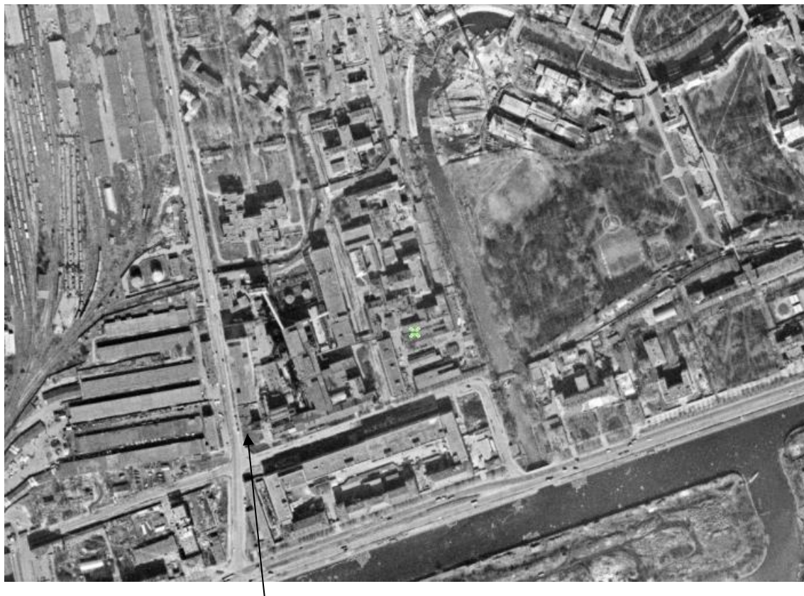
Подстанция № 7 Центральной электростанции городского трамвая
