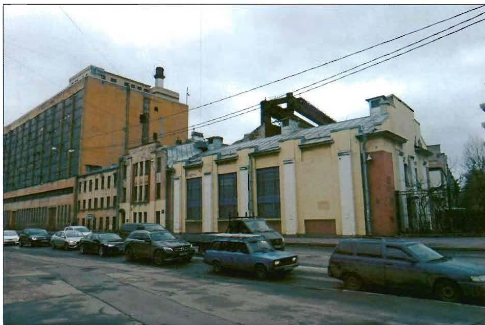
9. Общий вид с юго-запада.
