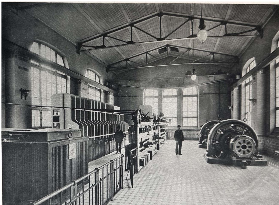
Илл. 54. Машинный зал одной из подстанций. 1910 г. (ист. С.-Петербургский городской электрический трамвай. Центральная электрическая станция и трансформаторные подстанции». Спб. 1910. Фиг. 86)
