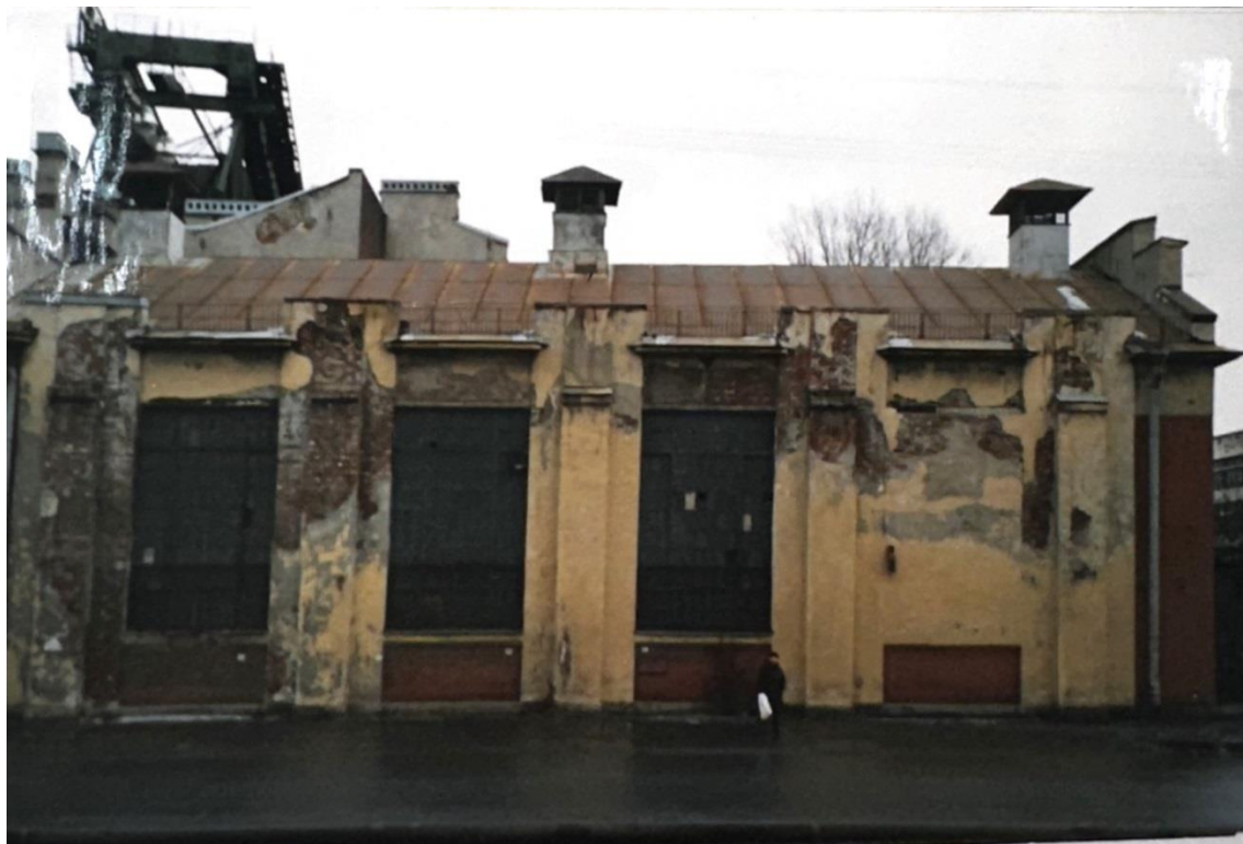
Илл. 57. Правая часть лицевого фасада здания «Подстанции» (бывш. Тяговая подстанция (Староконная подстанция). Фото (копия) 2003 г. (ист. Проект приспособления бывшей тяговой подстанции под архив ГУП «Горэлектротранс». 2003 г. ООО «Творческая архитектурная мастерская Вальдбрит». Том I)
