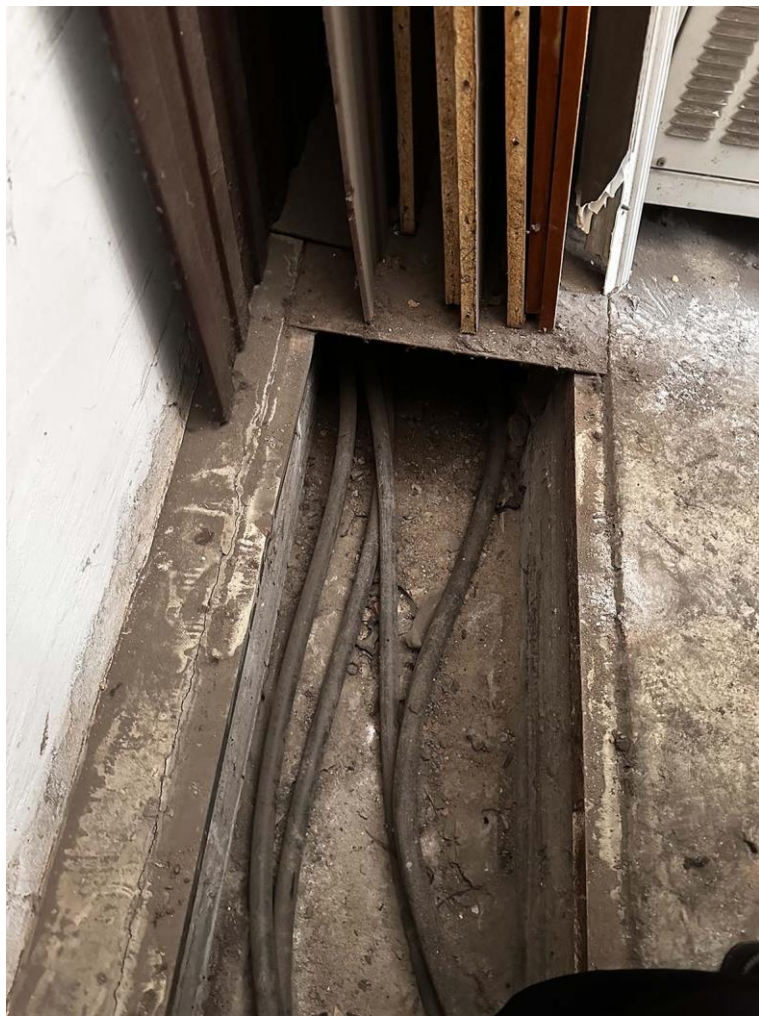
Фото 12. Помещение архива СПб ГУП «Горэлектротранс», расположенное в объекте культурного наследия регионального значения «Подстанция» (ул. Атаманская, д. 3/6 литера С). 1-ый этаж, техническое помещение в южной части дворовой одноэтажной пристройки здания. Существующая прокладка электрокабелей под полом вдоль северной стены помещения. Дата съемки: 01.06.2026 г. Автор съемки: Куваева Ю.П.
