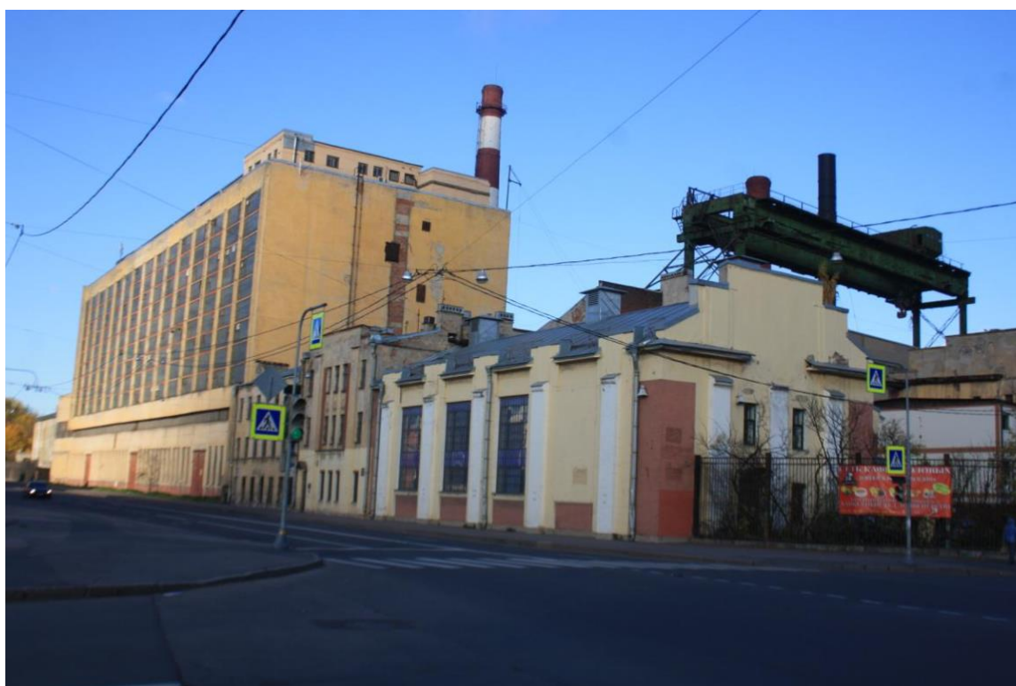
Илл. 60. Староконная трансформаторная подстанция городского трамвая. Фото (копия) 2022 г. (ист. Проект приспособления бывшей тяговой подстанции под архив ГУП «Горэлектротранс». 2003 г. ООО «Творческая архитектурная мастерская Вальдбрит». Том I)
