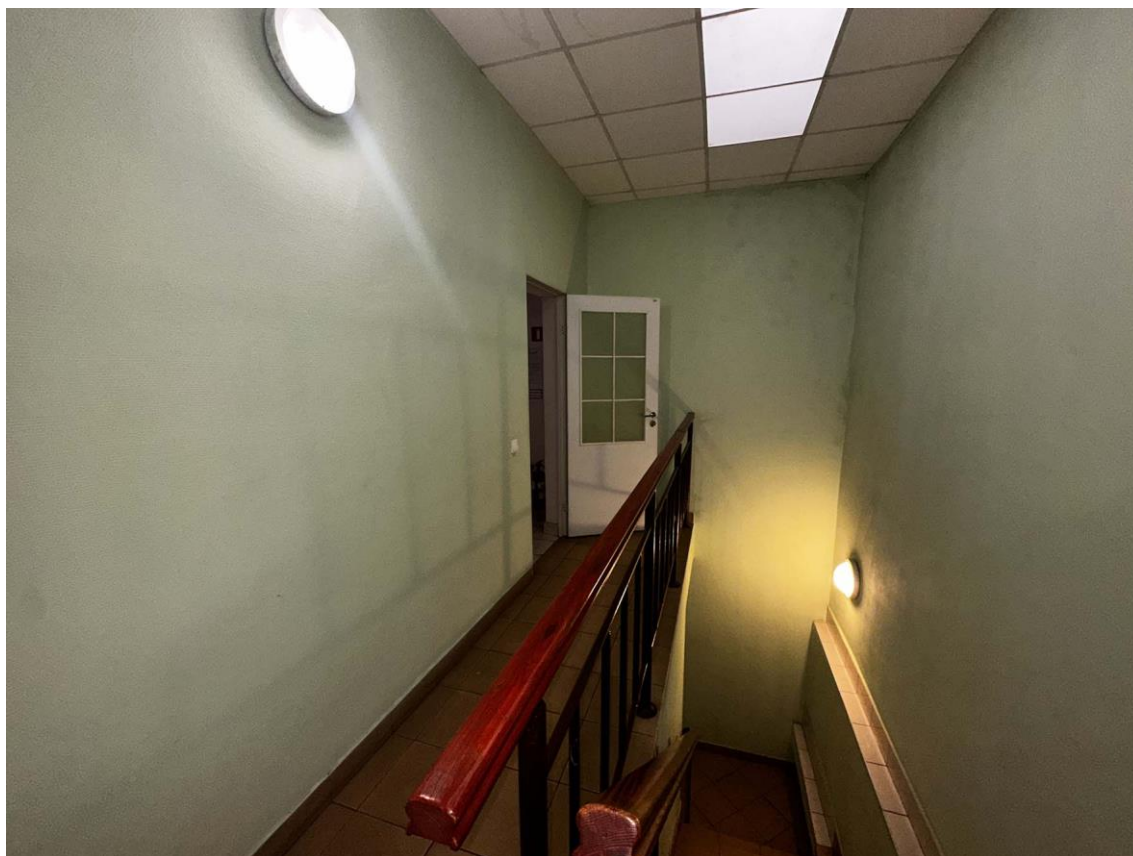
Фото 18. Помещение архива СПб ГУП «Горэлектротранс», расположенное в объекте культурного наследия регионального значения «Подстанция» (ул. Атаманская, д. 3/6 литера С). Помещение лестничной клетки. 2-ой этаж. Дата съемки: 01.06.2026 г. Автор съемки: Куваева Ю.П.
