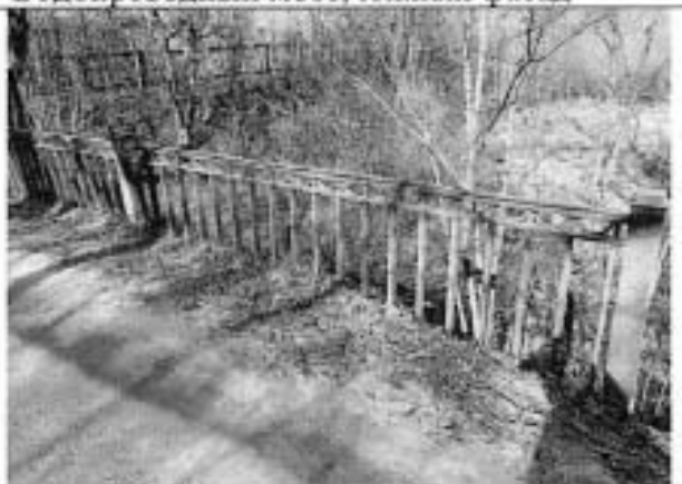
Фото 100. Павловск, ул. Правды. Водопроводный мост, ограждение
