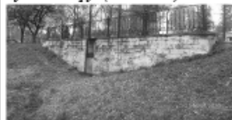
Водостивная плотина на пруду
