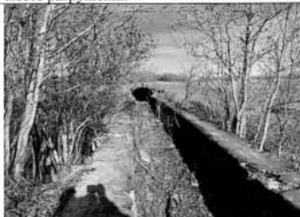
Фото 21. Акведук через р. Кузьминку
