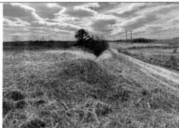
Фото 5. Трасса водовода в полях западнее Киевского шоссе. Рядом проходит историческая дорога
