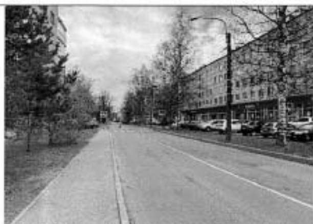
Фото 89. Трасса водовода. Павловск, ул. Березовая
