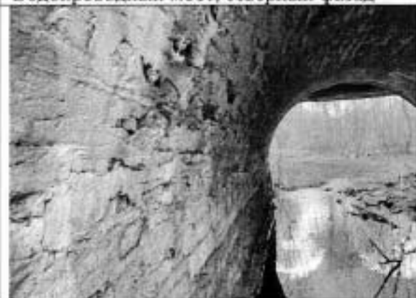
Фото 99. Павловск, ул. Правды. Водопроводный мост, свод
