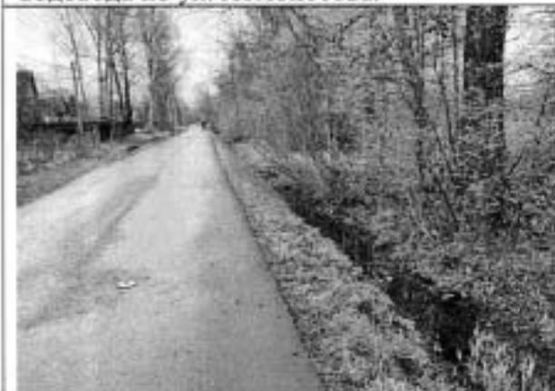
Фото 87. Пушкин, открытый канал по Садовой ул.
