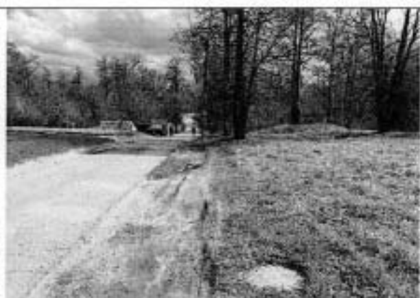
Фото 96. Павловск, ул. Правды. Трасса водовода
