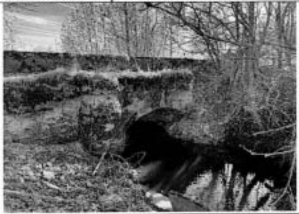
Фото 22. Акведук через р. Кузьминку, западный фасад
