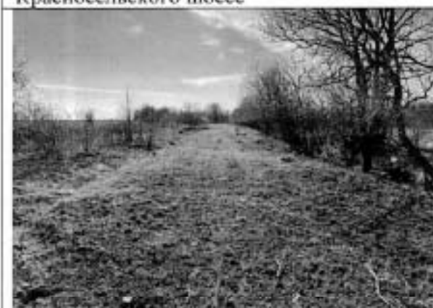
Фото 37. Вид на трассу полуподземного водовода в поле со стороны Красносельского шоссе
