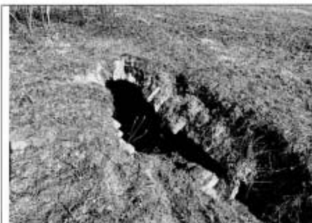
Фото 35. Провалы полуподземной кирпичной галереи в поле южнее Красносельского шоссе
