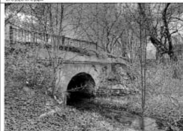
Фото 97. Павловск, ул. Правды. Водопроводный мост, северный фасад
