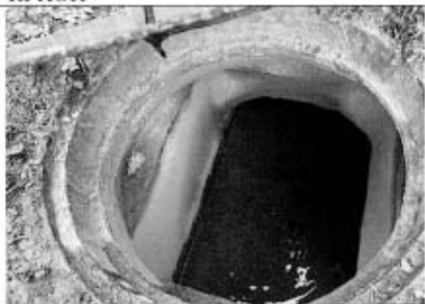
Фото 75. Колодец на ж/б трубопроводе между Отдельным парком и Тярлевским ручьем вблизи ж/д моста
