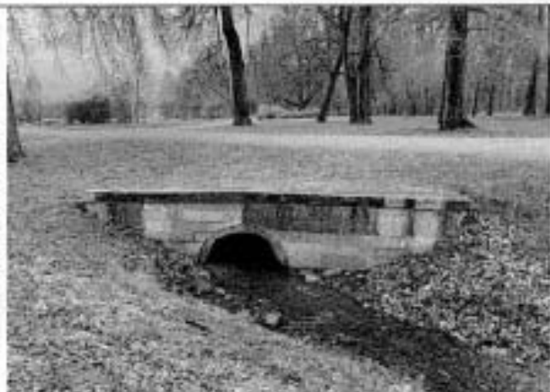
Фото 66. Водовыпуск в канал с облицовкой известняком
