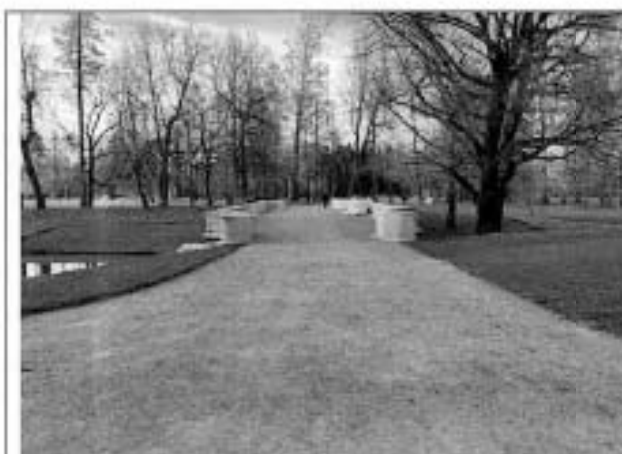
Фото 59. Трасса водовода в Екатерининском парке через Виттоловский мост-делитель
