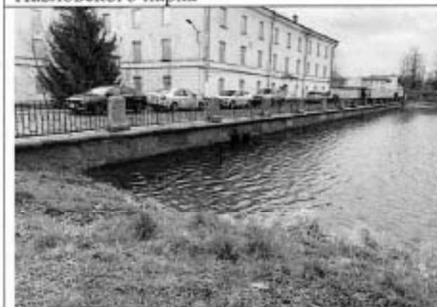
Фото 61. Вид с Нижнего Пятого (Купального) пруда на плотину Фабрику ассигнационных бумаг. Водозабор Павловского водовода
