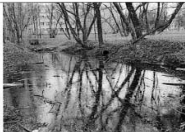
Фото 62. Исторический участок водовода в виде открытого канала на территории сквера за зданием Фабрики. Берега оплыли, русло замусорено
