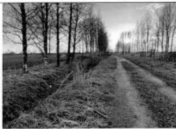
Фото 8. Участок подземного водовода «минная галерея» от Киевского шоссе до базы СПБГУ в Новокондакопшино проходит с южной стороны от дороги
