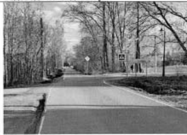
Фото 88. Пушкин, открытый канал по Садовой ул.
