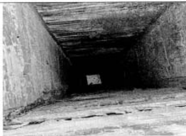
Фото 10. Обетонированный колодец для обслуживания водовода, фрагменты опалубки на стенах у базы СПБГУ в Новокондакопшино
