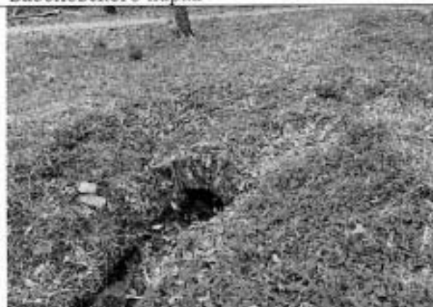
Фото 40. Выпуск из закрытого коллектора в открытую канаву
