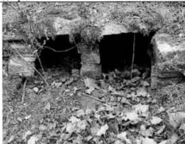
Фото 45. Выходные отверстия галерей, подававшей воду на Баболовский гот
