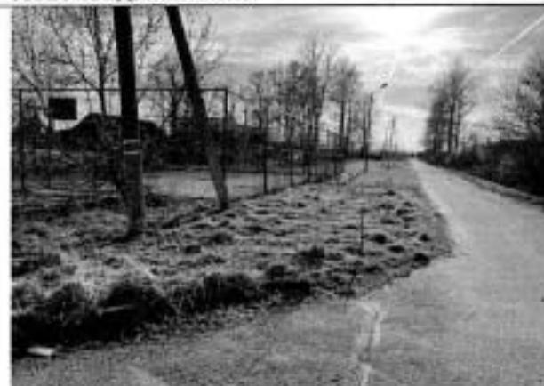
Фото 13. Трасса подземного водовода на территории Новокондакопшино
