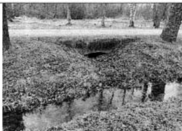
Фото 71. Мостик с гранитным фасадом под аллеей. Западный фасад
