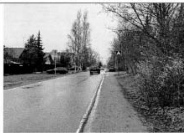
Фото 84. Пушкин, трасса водовода по ул. Ломоносова
