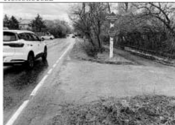
Фото 86. Пушкин, трасса открытого водовода по Садовой ул.
