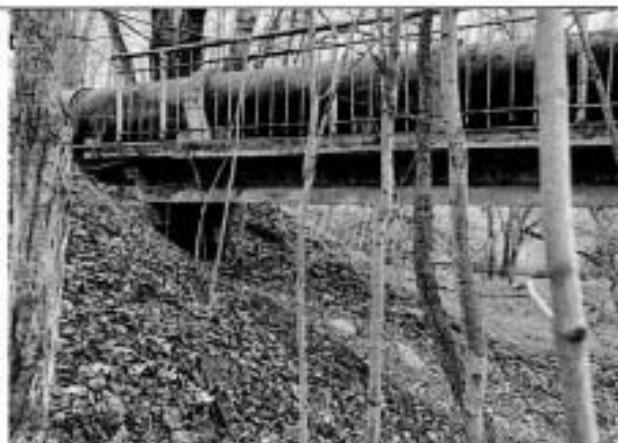
Фото 78. Ж/б конструкции акведука через Тярлевский ручей
