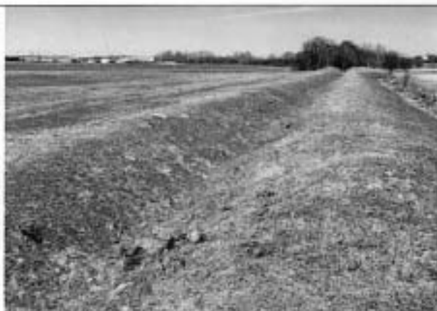
Фото 18. Подземный водовод в полях восточнее ж/д ветки.
