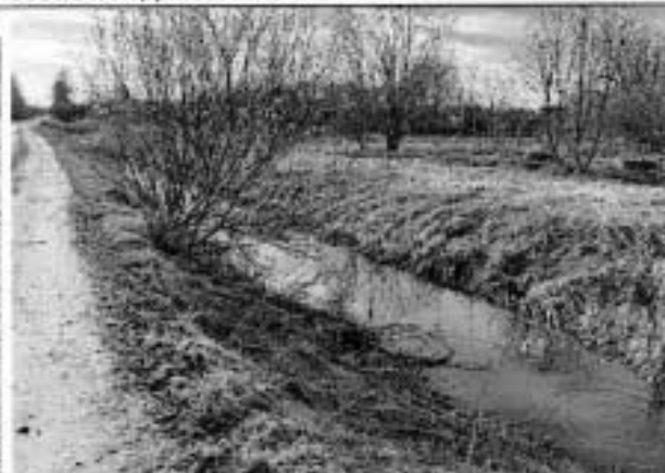
Фото 16. Открытый канал западнее Ж/д ветки в Новокондакопшино
