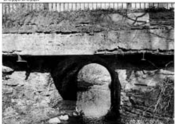
Фото 98. Павловск, ул. Правды. Водопроводный мост, южный фасад
