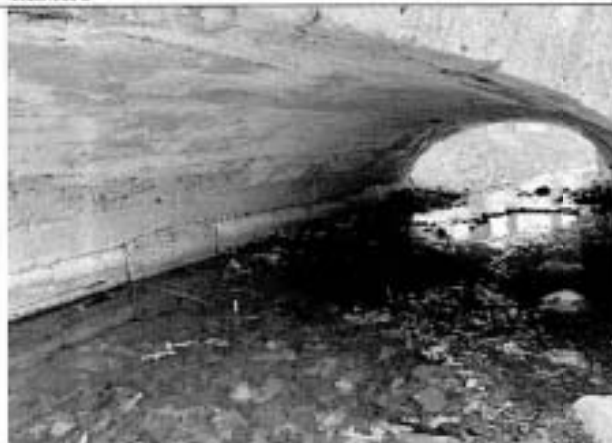
Фото 69. Свод мостика обетонирован
