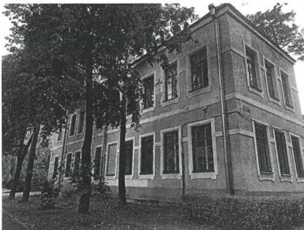
Фото №1. Северный фасад объекта культурного наследия
