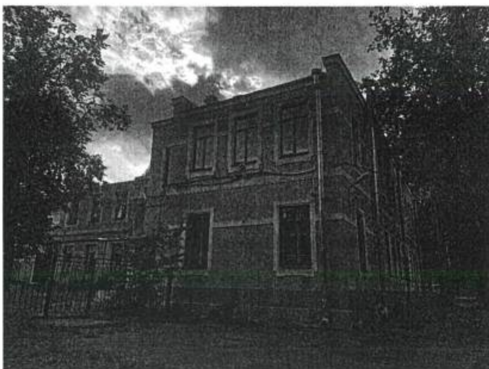
Фото №11. Восточный фасад объекта культурного наследия
