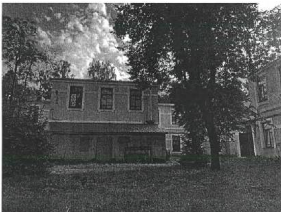
Фото №9. Северный фасад объекта культурного наследия
