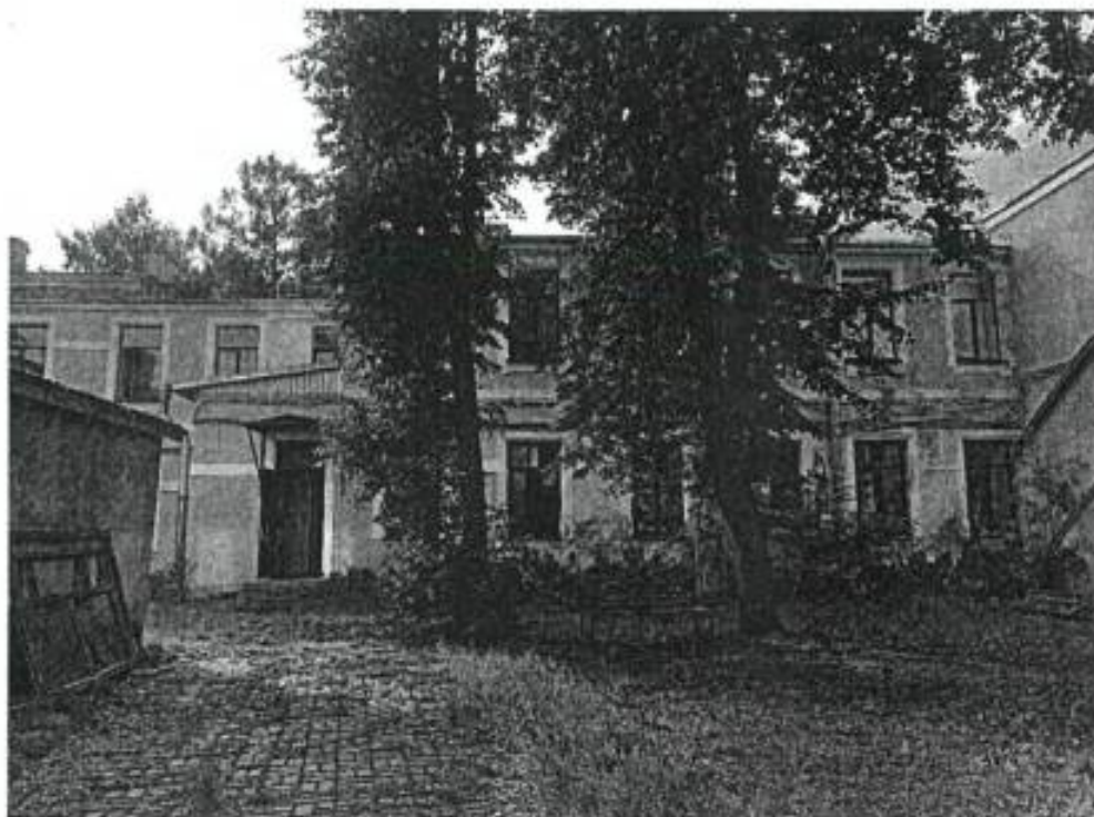
Фото №10. Восточный фасад объекта культурного наследия
