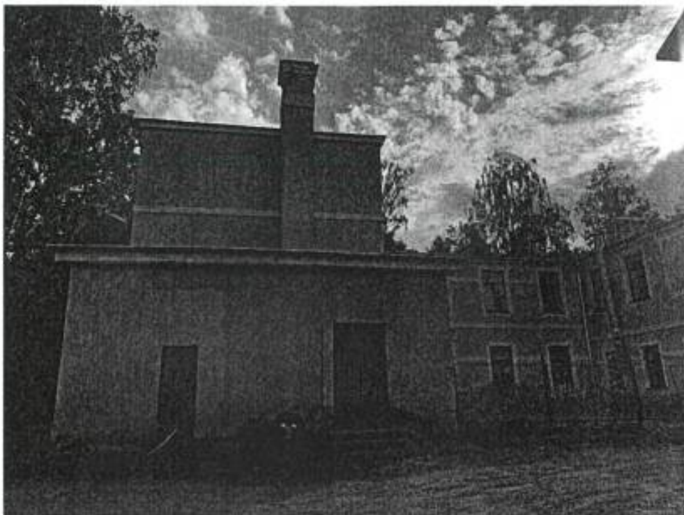
Фото №6. Северный фасад объекта культурного наследия
