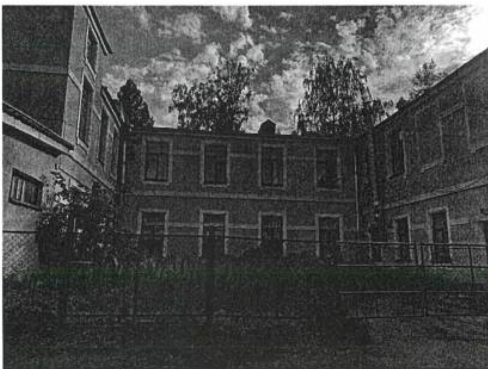
Фото №7. Северный фасад объекта культурного наследия
