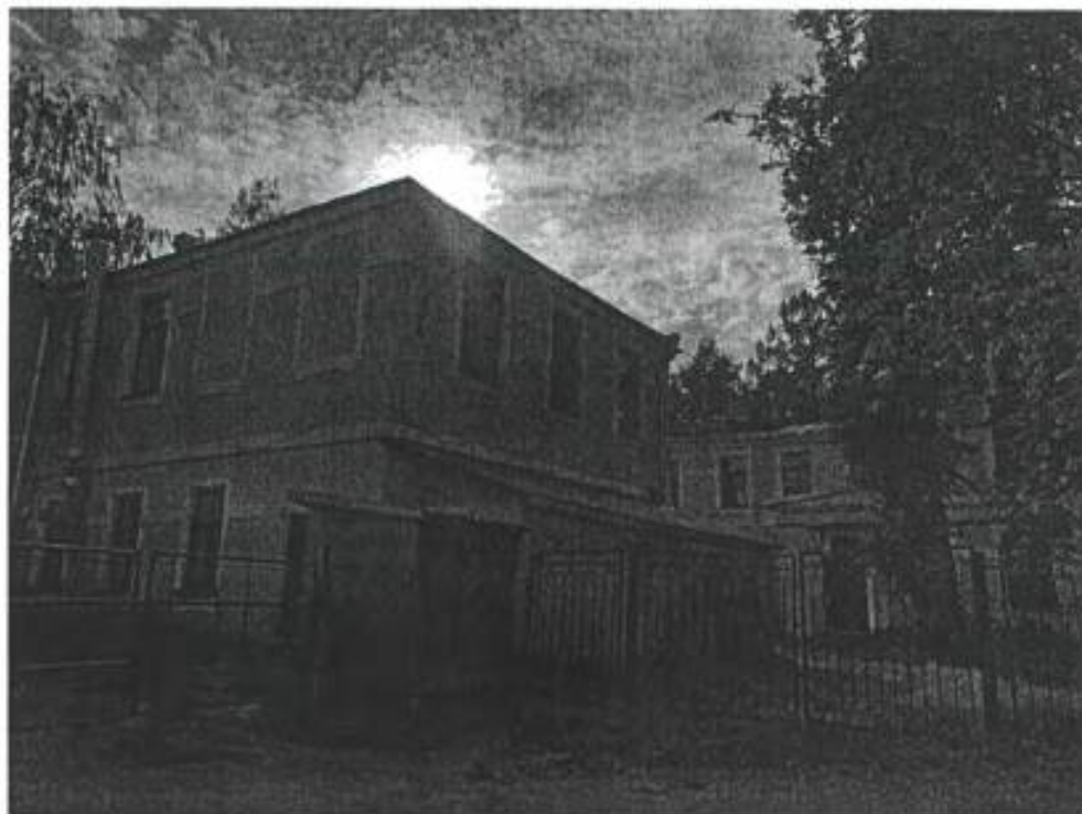
Фото №8. Западный фасад объекта культурного наследия
