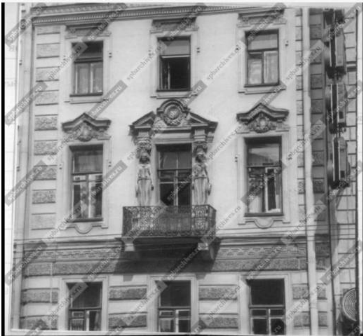
36. Вид части фасада дома №78 на Невском проспекте. Фотография. Автор фото – Фалин С.А. 1983 г. // Источник: ЦГАКФФД СПб. Фотодокументы. Оп.1БР-36. Ед.хр.45726.
