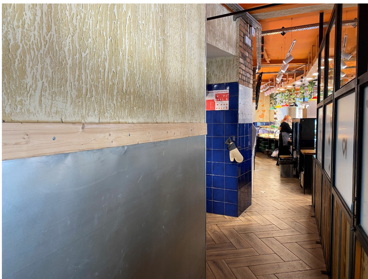
Фото №18. Помещение 31-Н (105).
