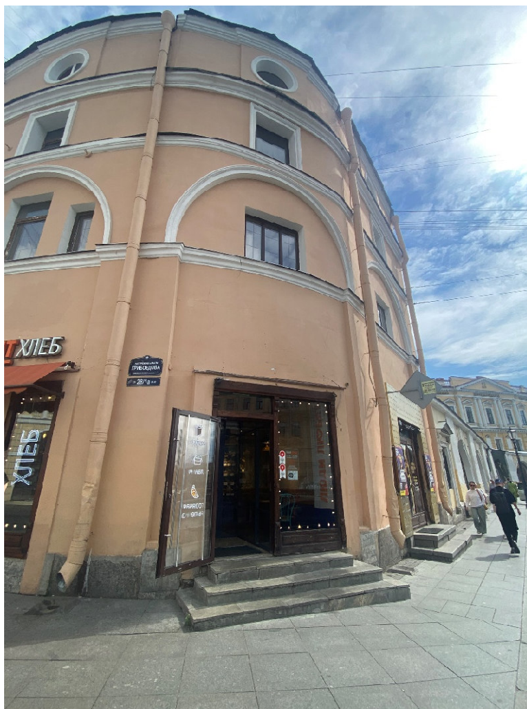
Фото №2. Вход в помещение 31-Н.
