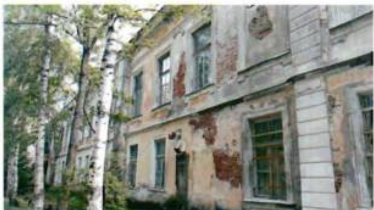
12. Западный фасад восточного корпуса со стороны двора
