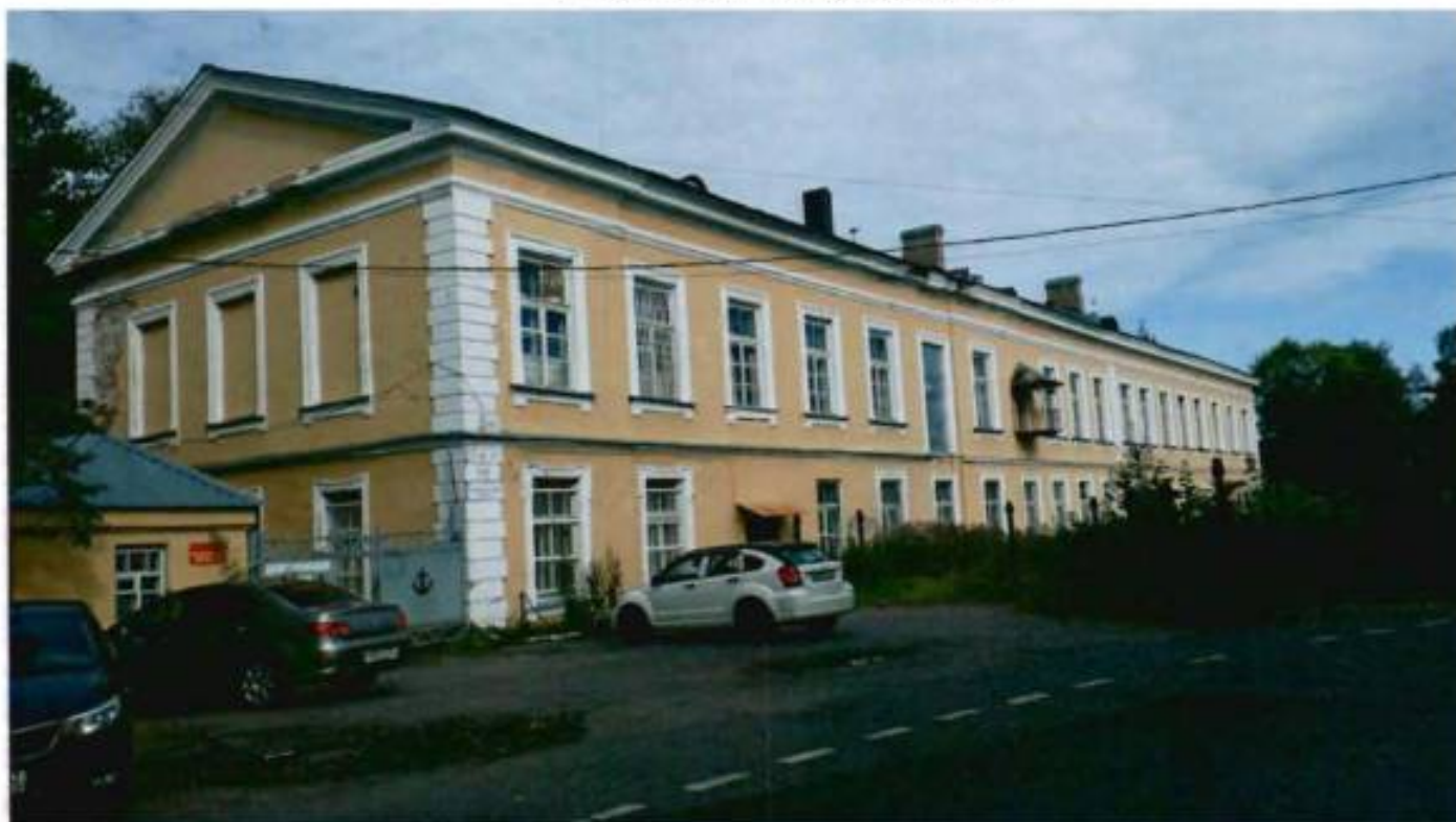
1. Юго-восточный фасад здания
