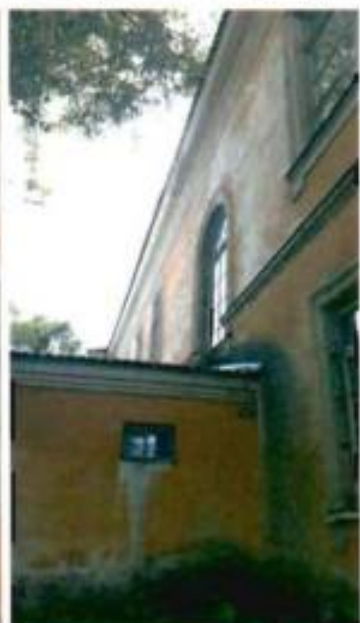
15. Северная часть фасада
