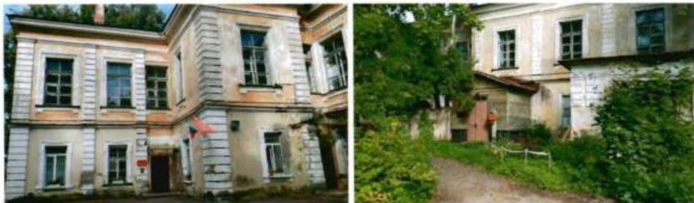
2, 3. Внутренняя часть северо-западного фасада здания
