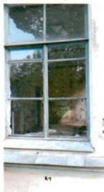
7. Оконный проем южного фасада
