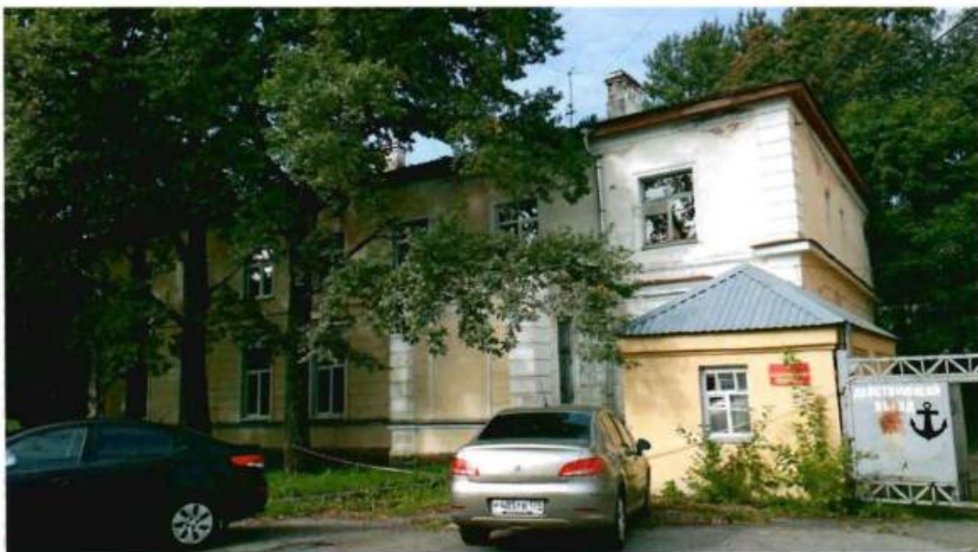
1. Восточный фасад здания
