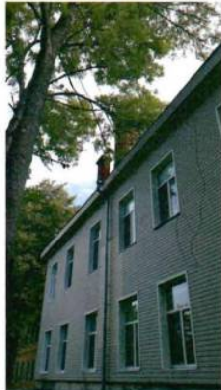
8. Кирпичные дымовые трубы
