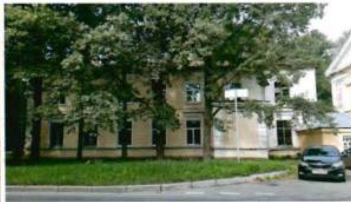
3. Восточный фасад здания
