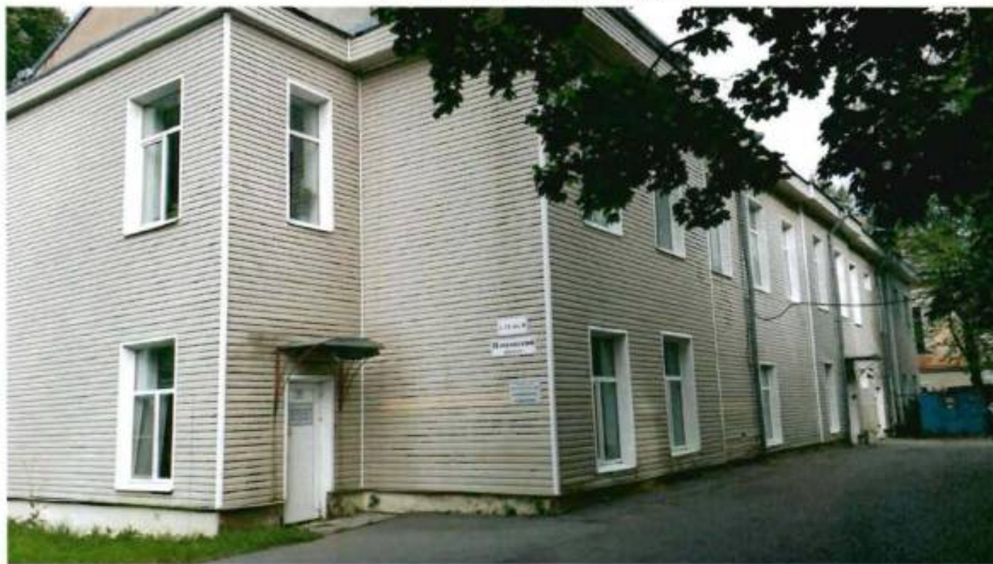
1. Юго-восточный фасад здания
