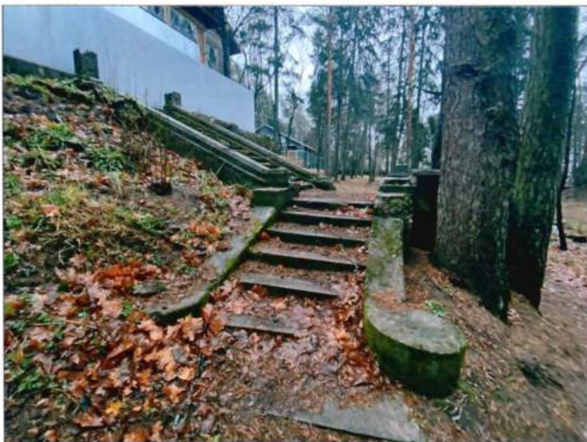
5. Терраса с лестницей. Вид с востока.
