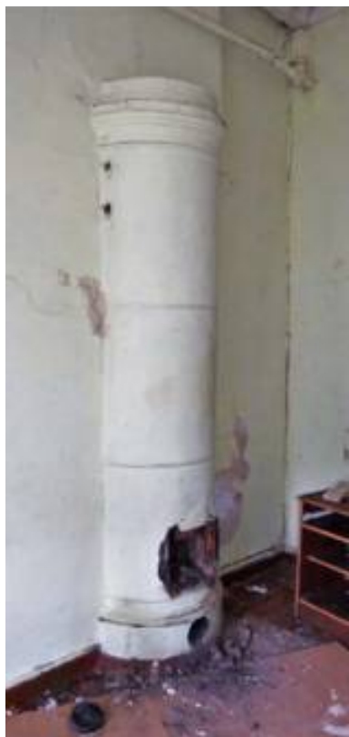
43. Печь в интерьере. 2-й этаж. 2017 г. - http://www.citywalls.ru
