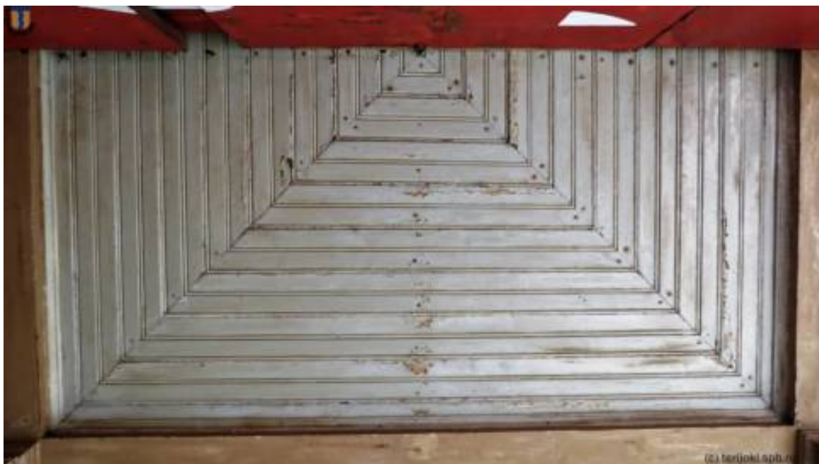
49. Интерьер южной веранды первого этажа. Фрагмент. 2017 г. - http://www.citywalls.ru
