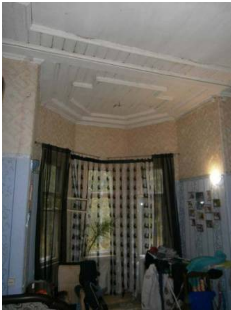
39. Интерьер. 1-й этаж. 2015 г. - http://www.citywalls.ru
