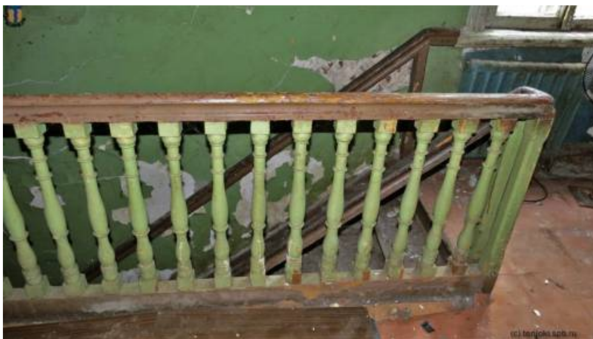
52. Лестница с 1-го на 2-й этаж. 2017 г. - http://www.citywalls.ru
