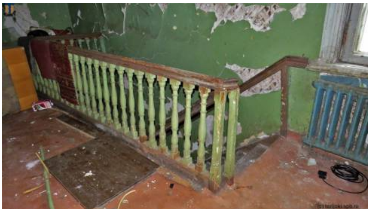
51. Лестница с 1-го на 2-й этаж. 2017 г. - http://www.citywalls.ru
