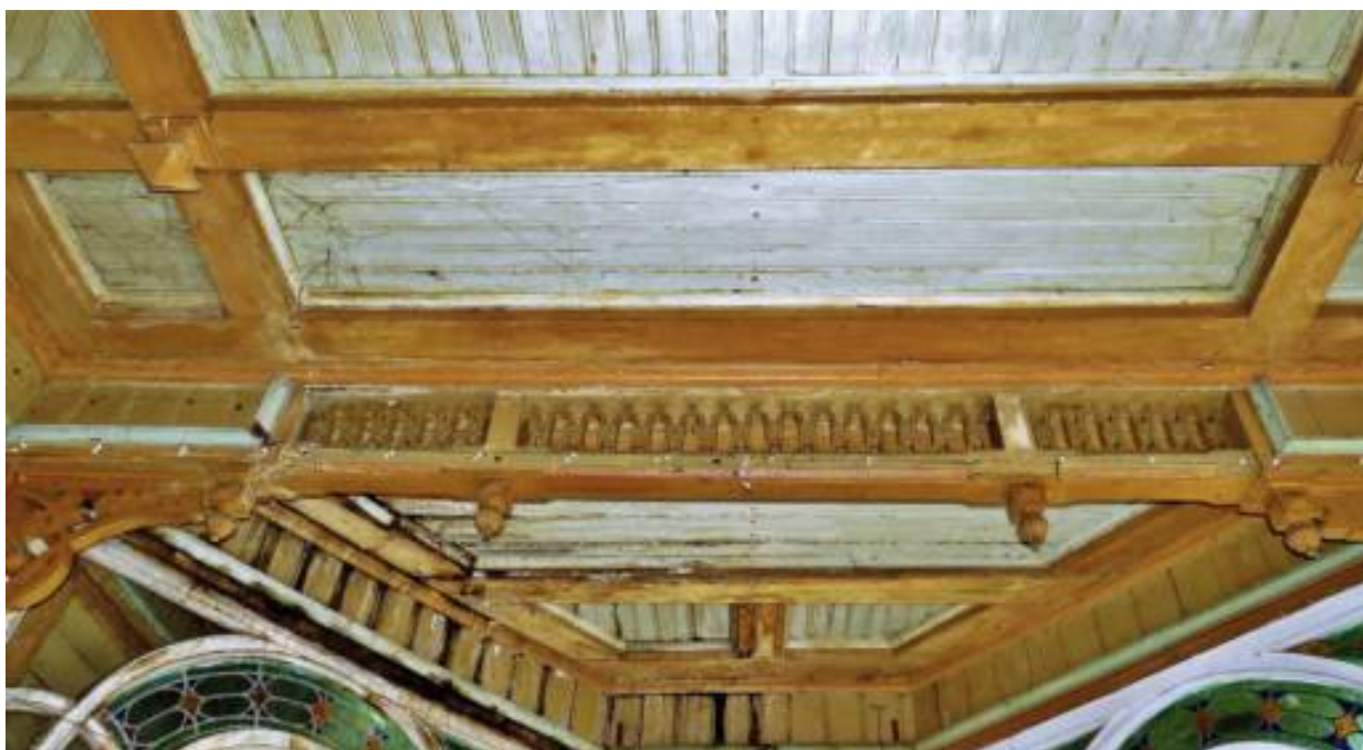
48. Интерьер южной веранды первого этажа. Фрагмент. 2017 г. - http://www.citywalls.ru
