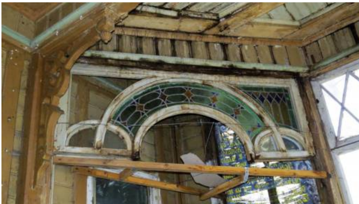
47. Интерьер южной веранды первого этажа. Фрагмент. 2017 г. - http://www.citywalls.ru
