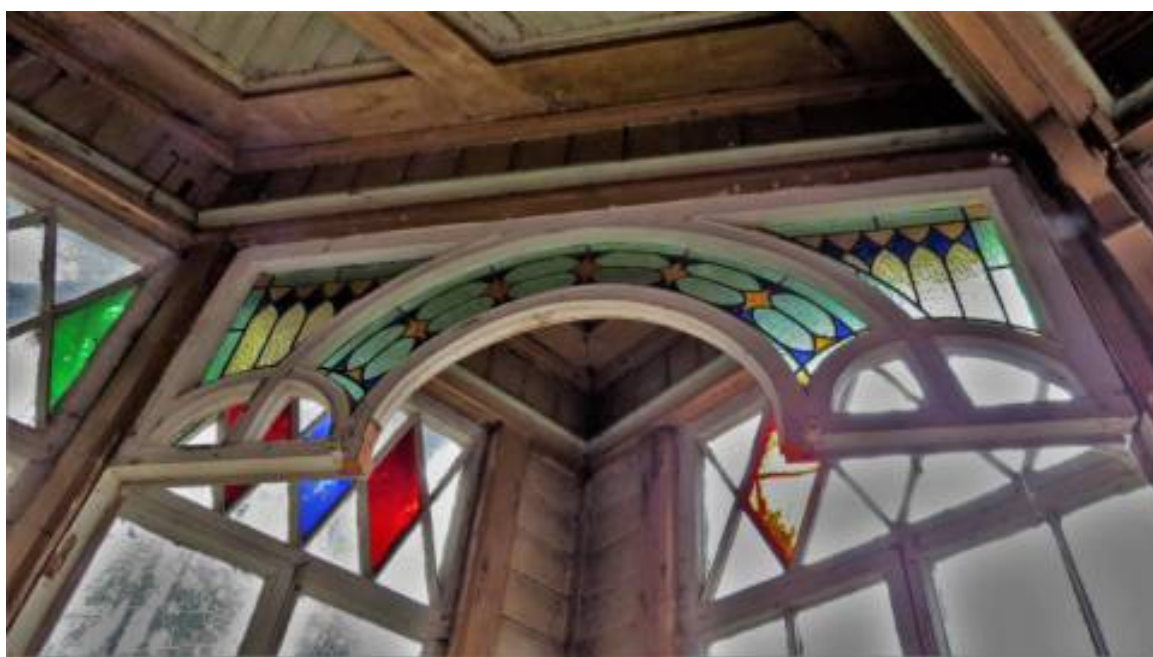
46. Интерьер южной веранды первого этажа. Фрагмент. 2017 г. - http://www.citywalls.ru
