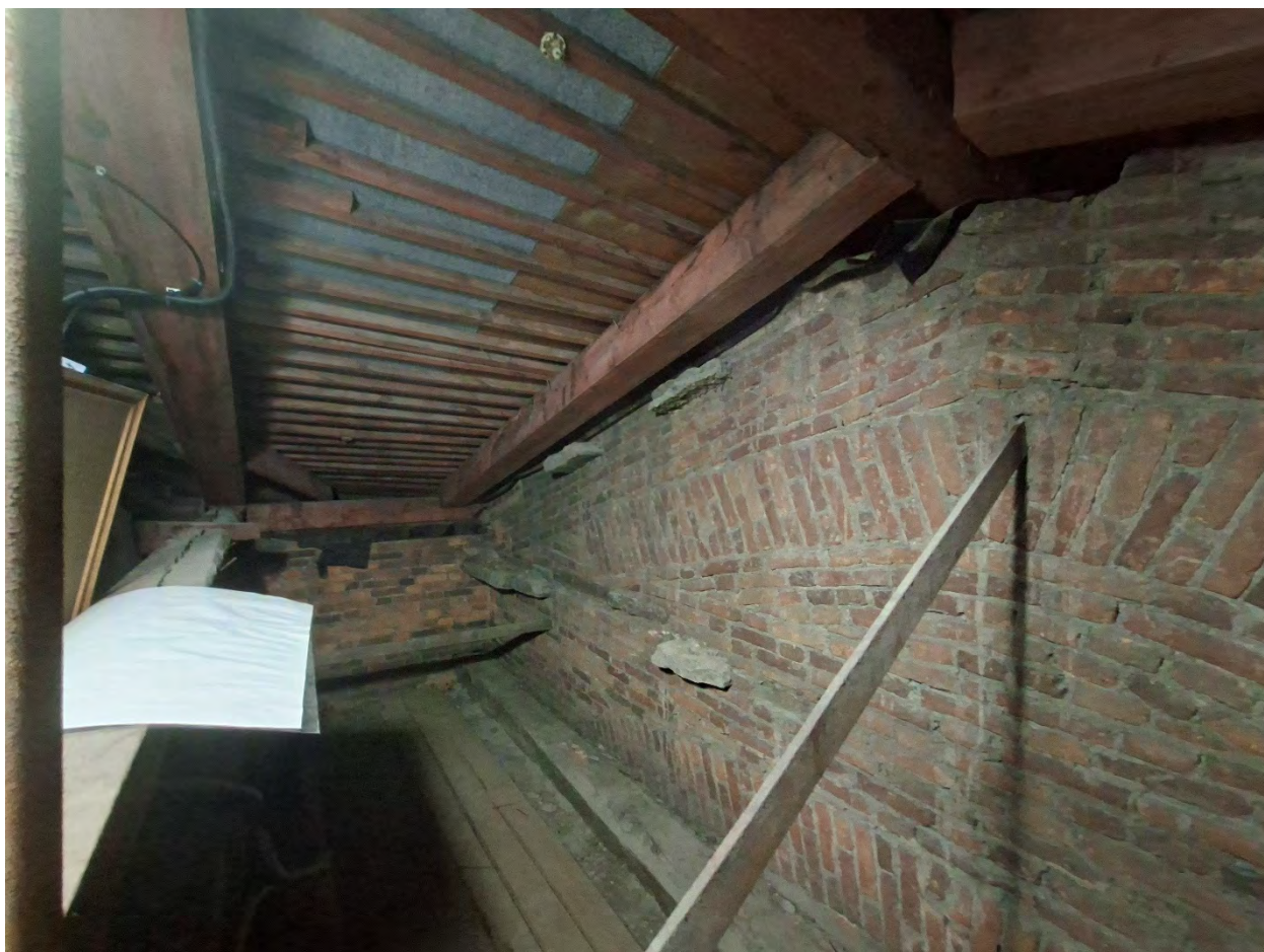
Фото 139. Чердак. Вид на стропильную систему.
