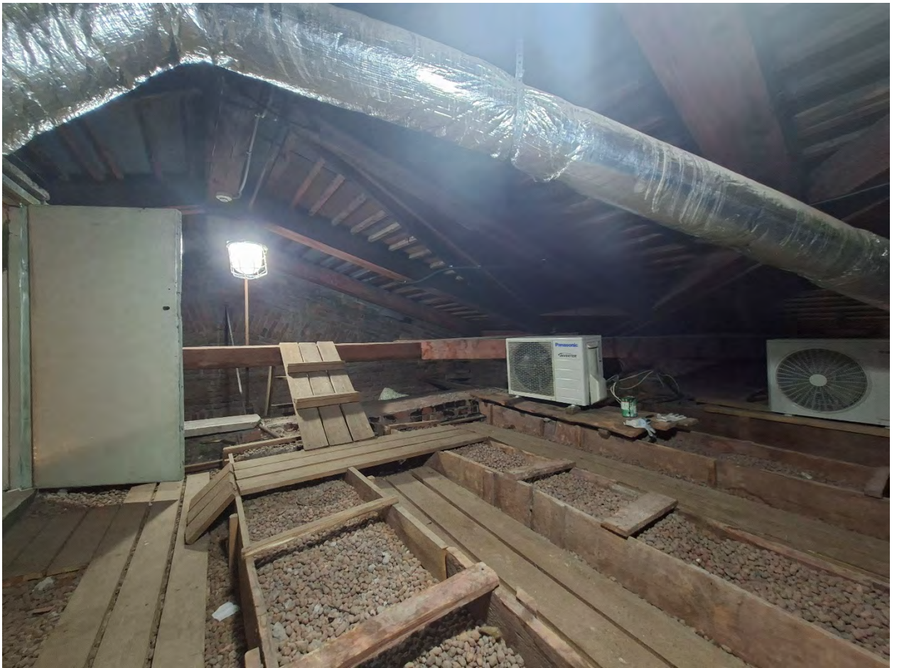
Фото 137. Чердак. Вид на стропильную систему.
