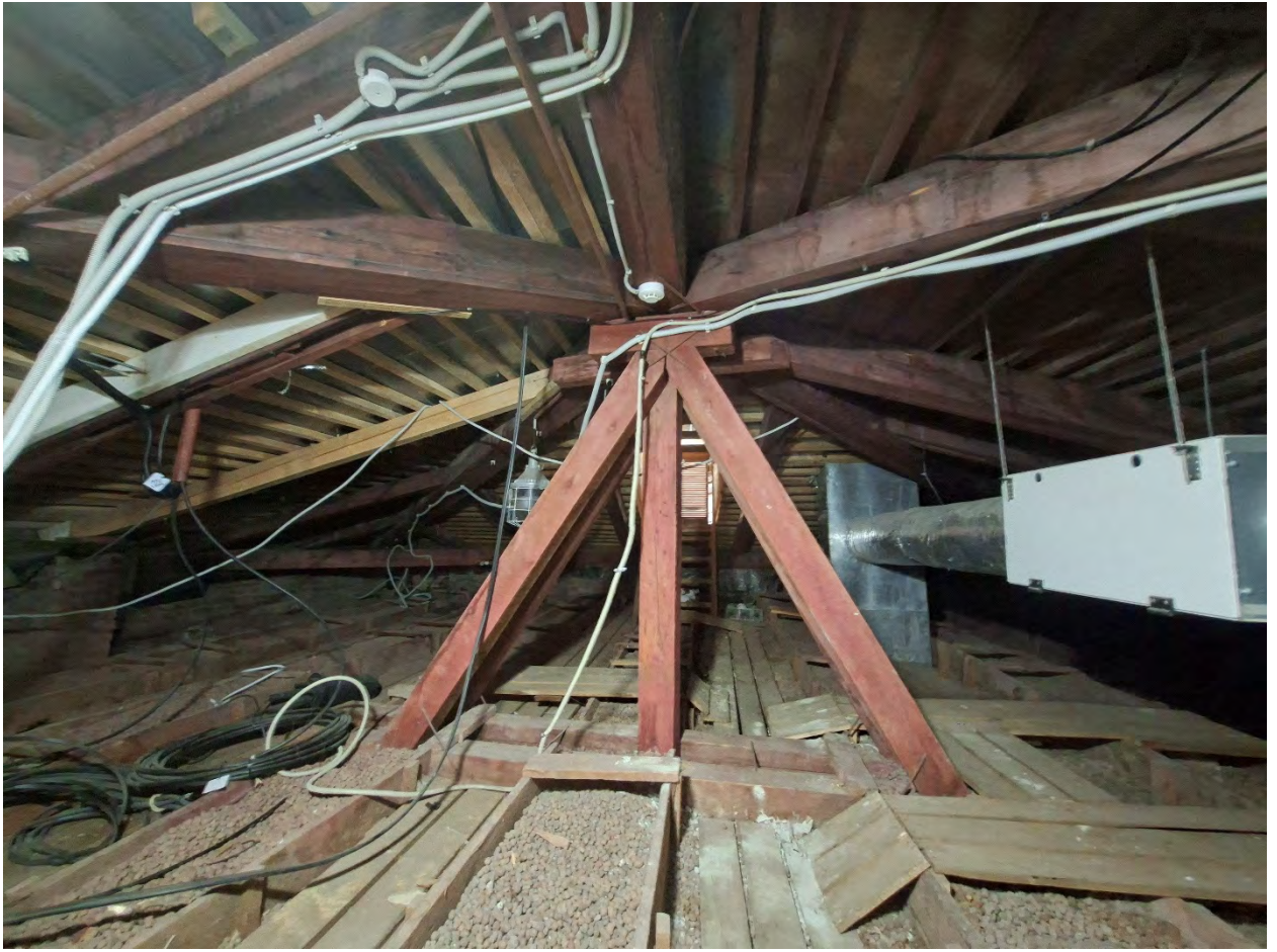
Фото 134. Чердак. Вид на стропильную систему.
