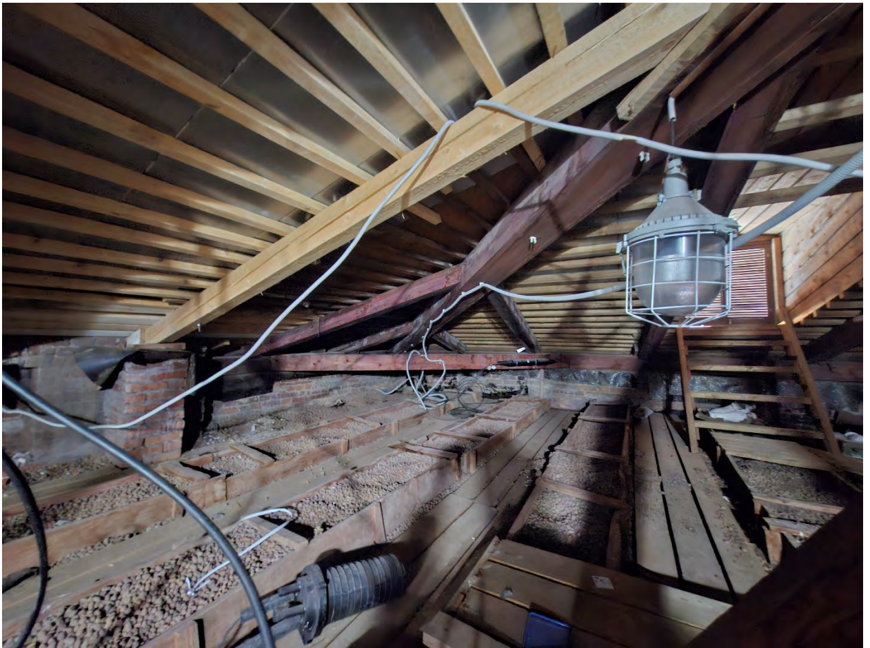
Фото 135. Чердак. Вид на стропильную систему.
