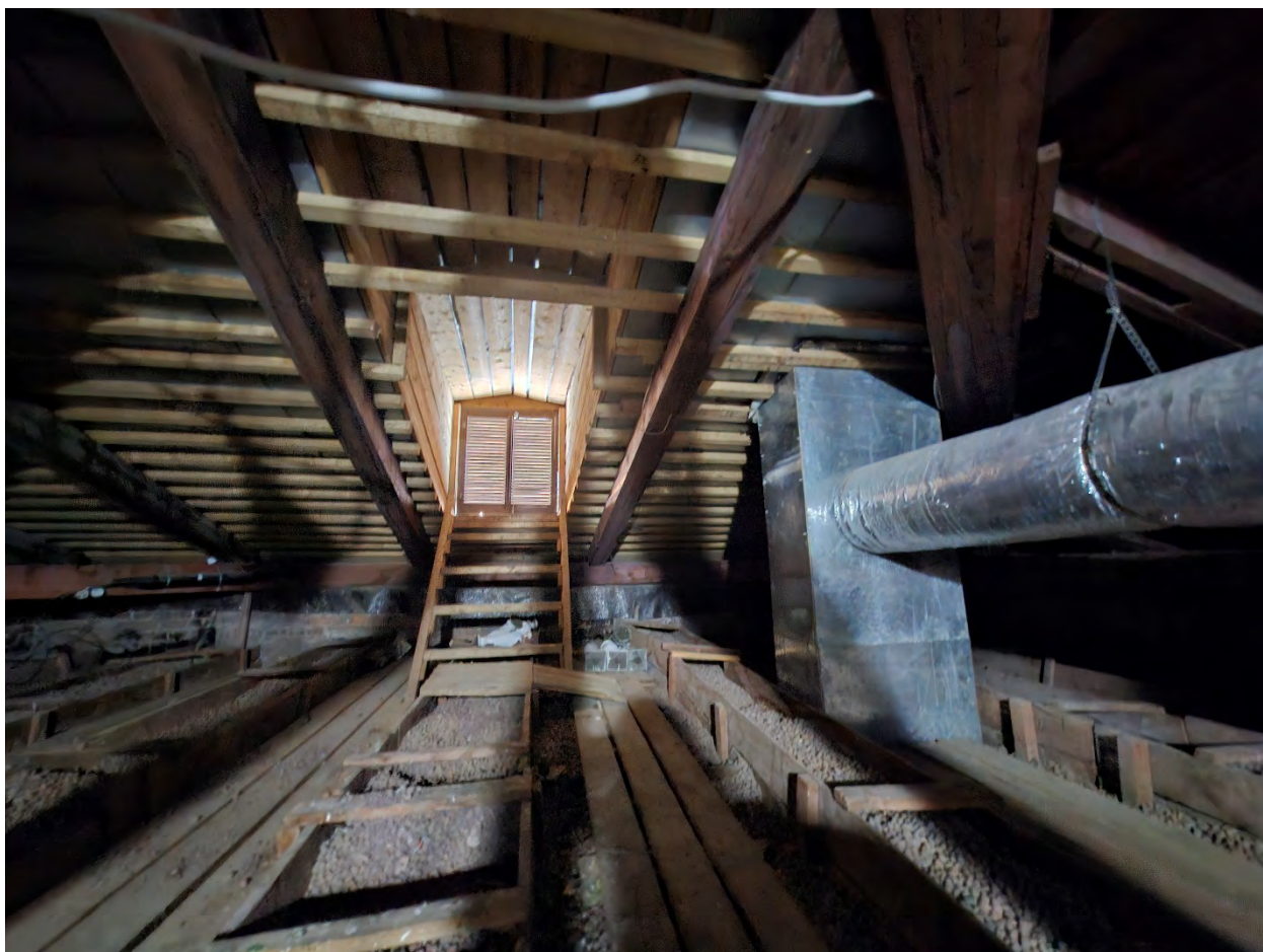
Фото 136. Чердак. Вид на стропильную систему.
