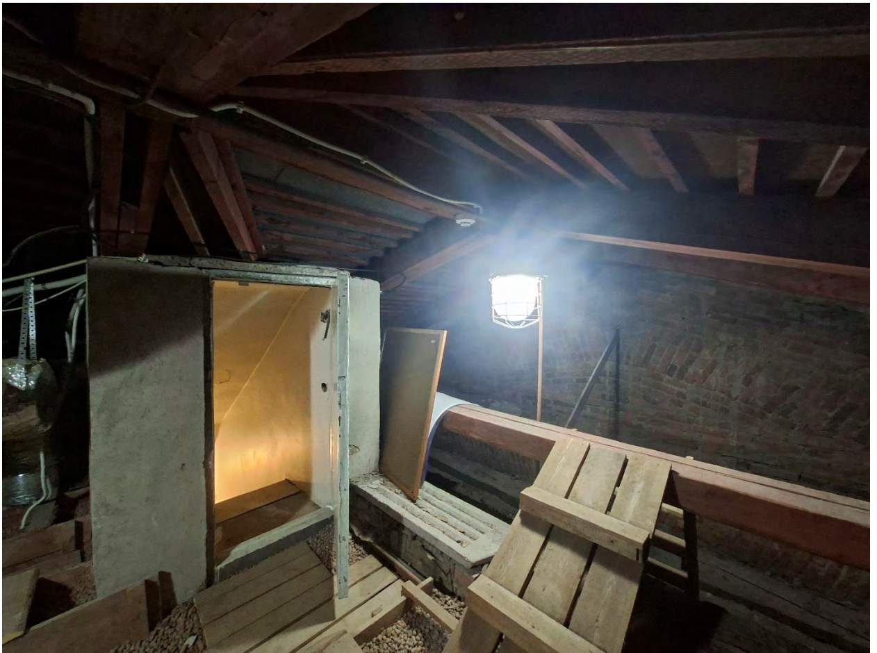
Фото 138. Чердак. Вид на стропильную систему.
