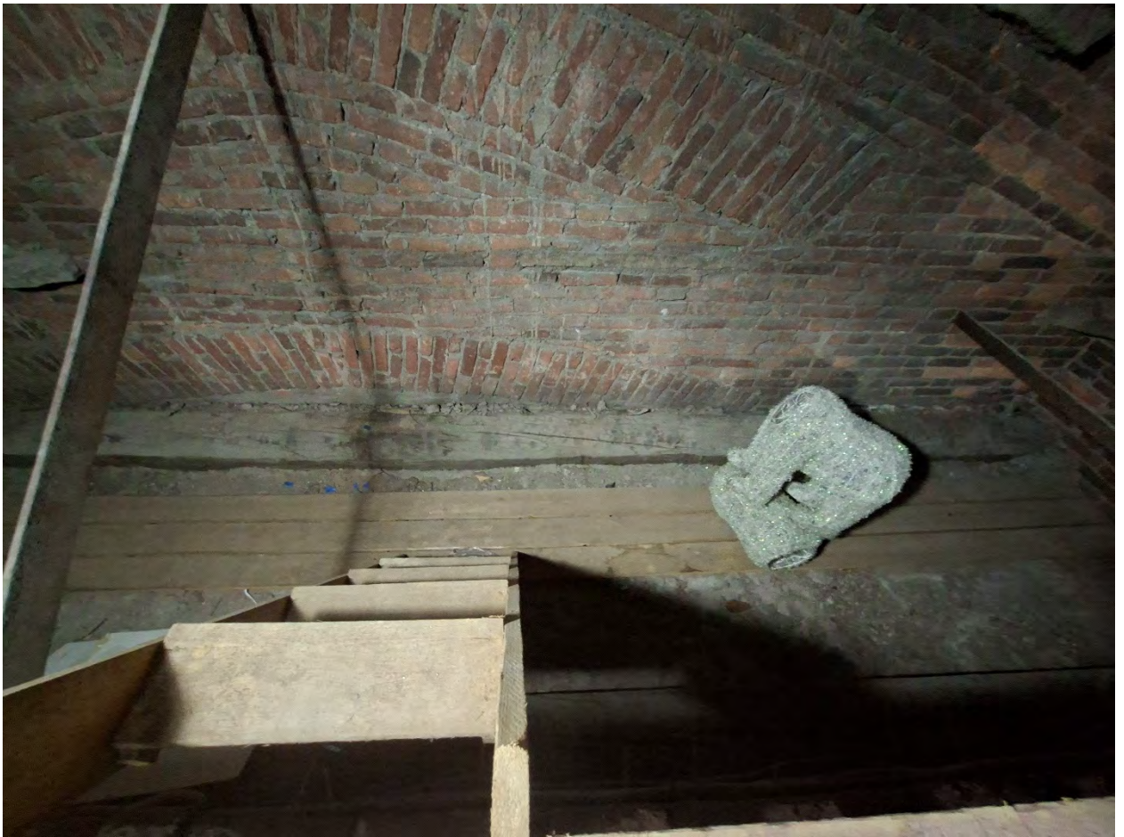
Фото 140. Чердак. Вид на стропильную систему.
