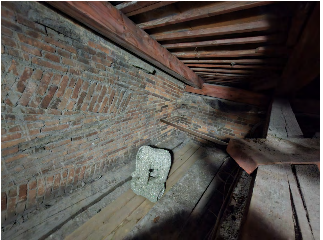
Фото 141. Чердак. Вид на стропильную систему.
