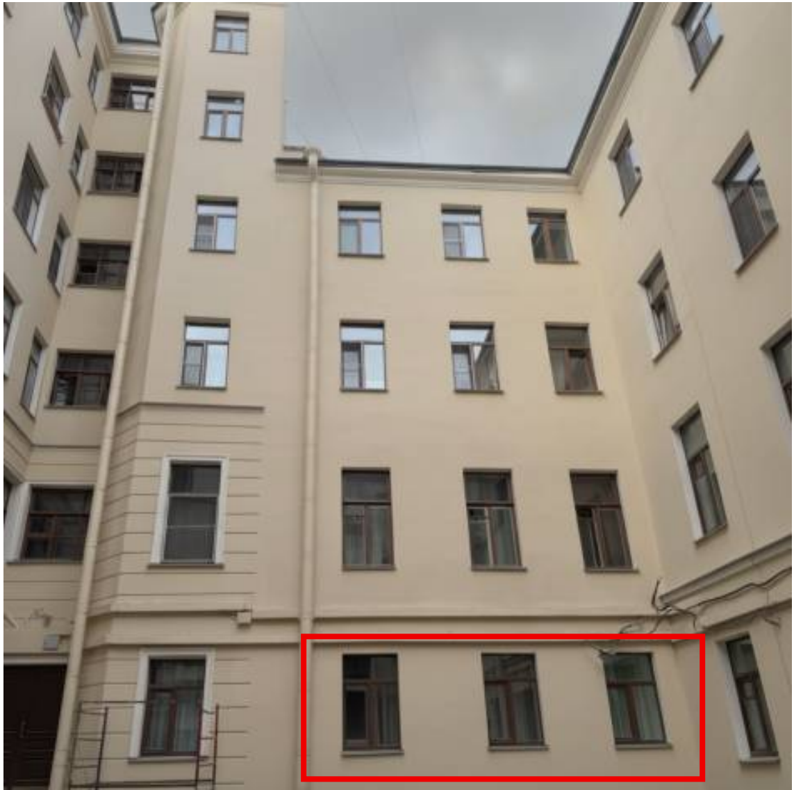
1. Вид на дворовой фасад здания
