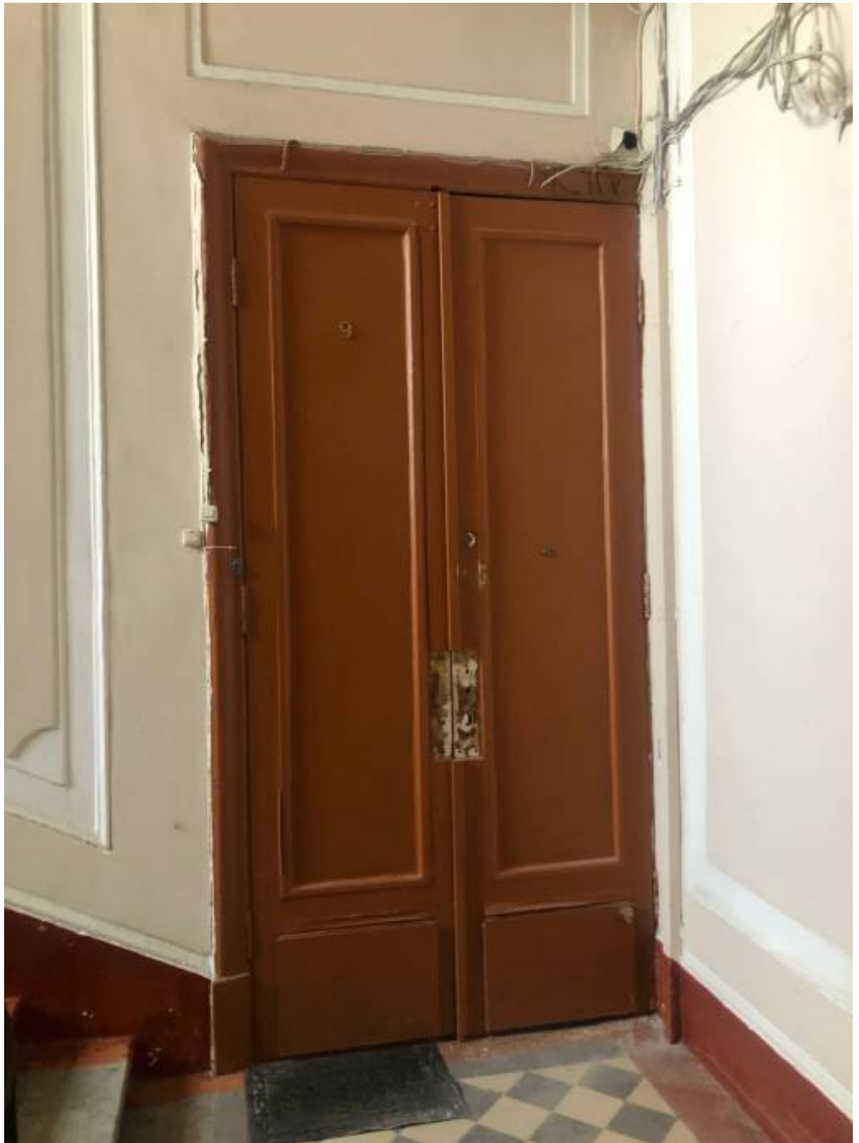
3. Общий вид входной двери.
