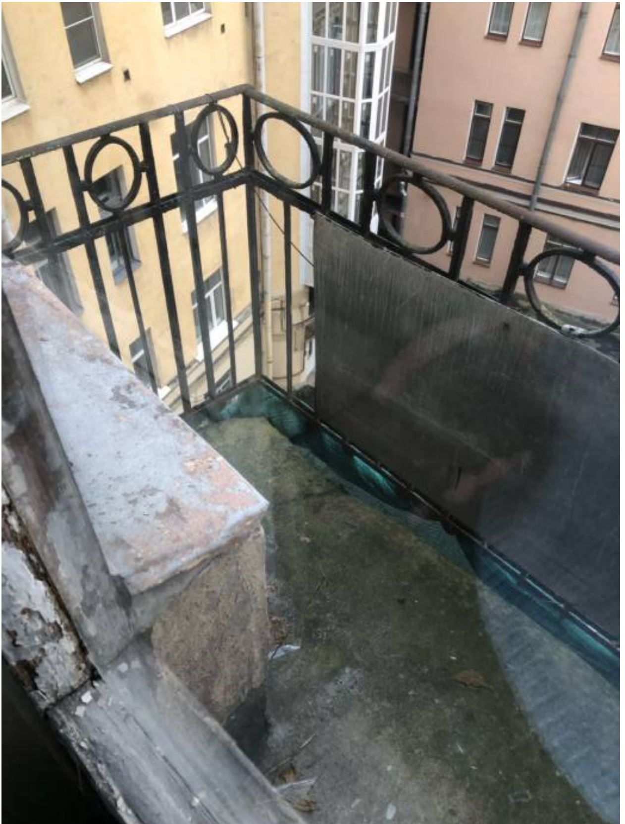
11.Общий вид балкона.
