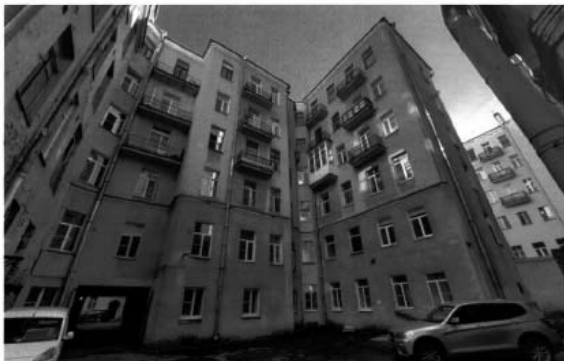
15. Общий вид на дворовые фасады здания (западный двор) (30.09.2024)
