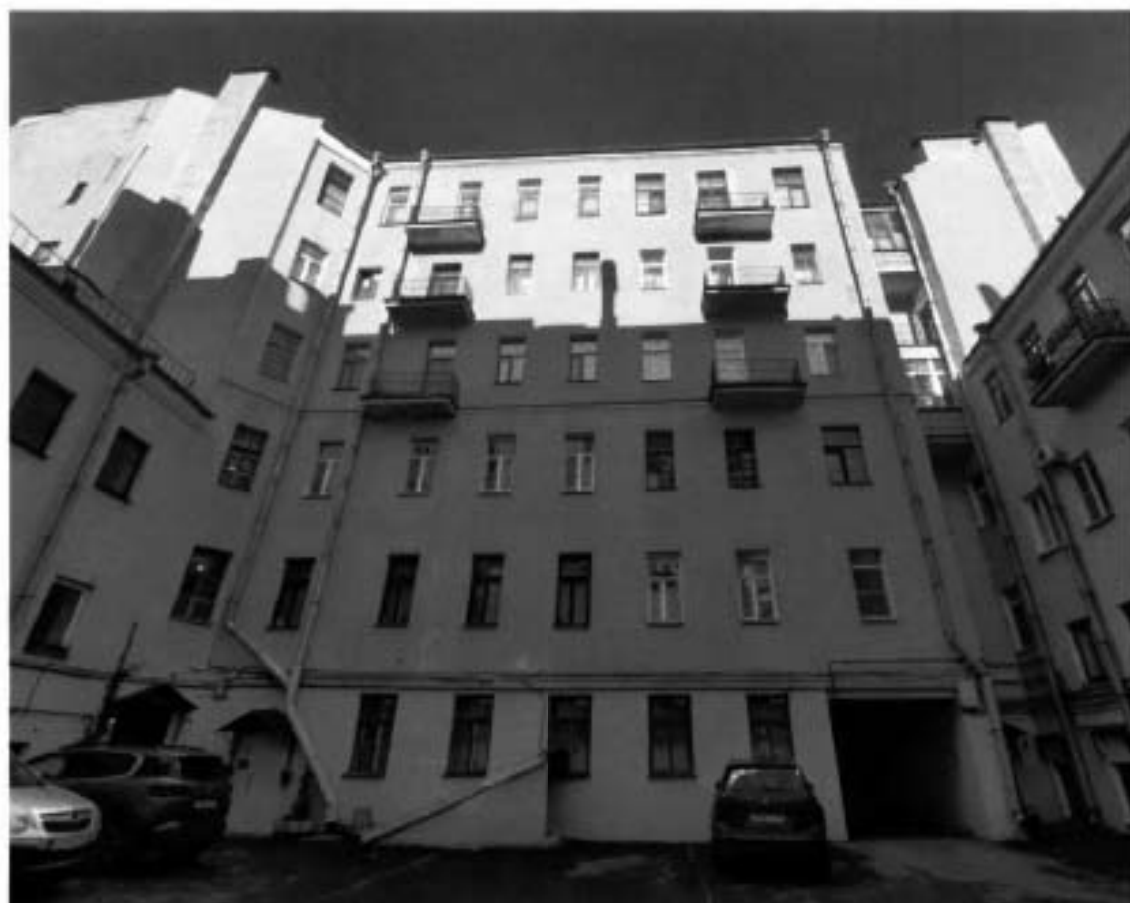
10. Общий вид на дворовый северо-западный фасад здания (южный двор) (30.09.2024)
