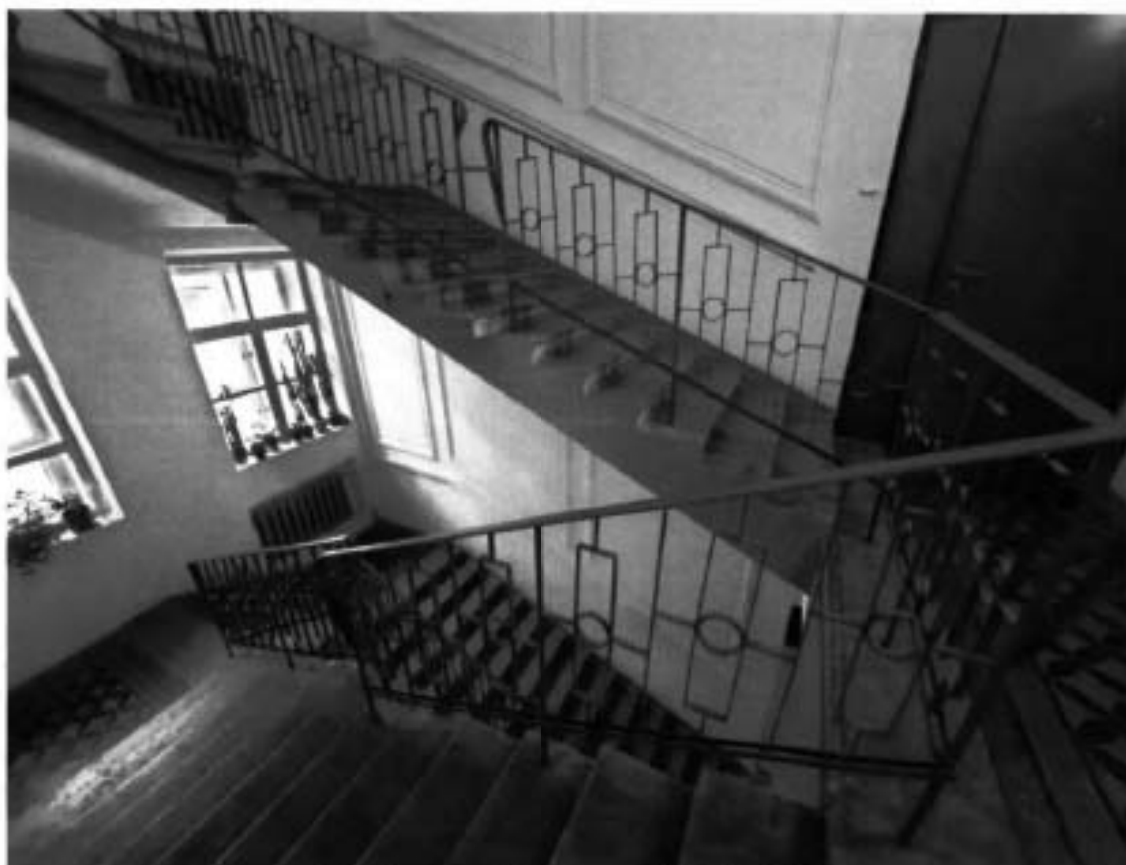
16. Лестница Л-1 здания (03.10.2024)
