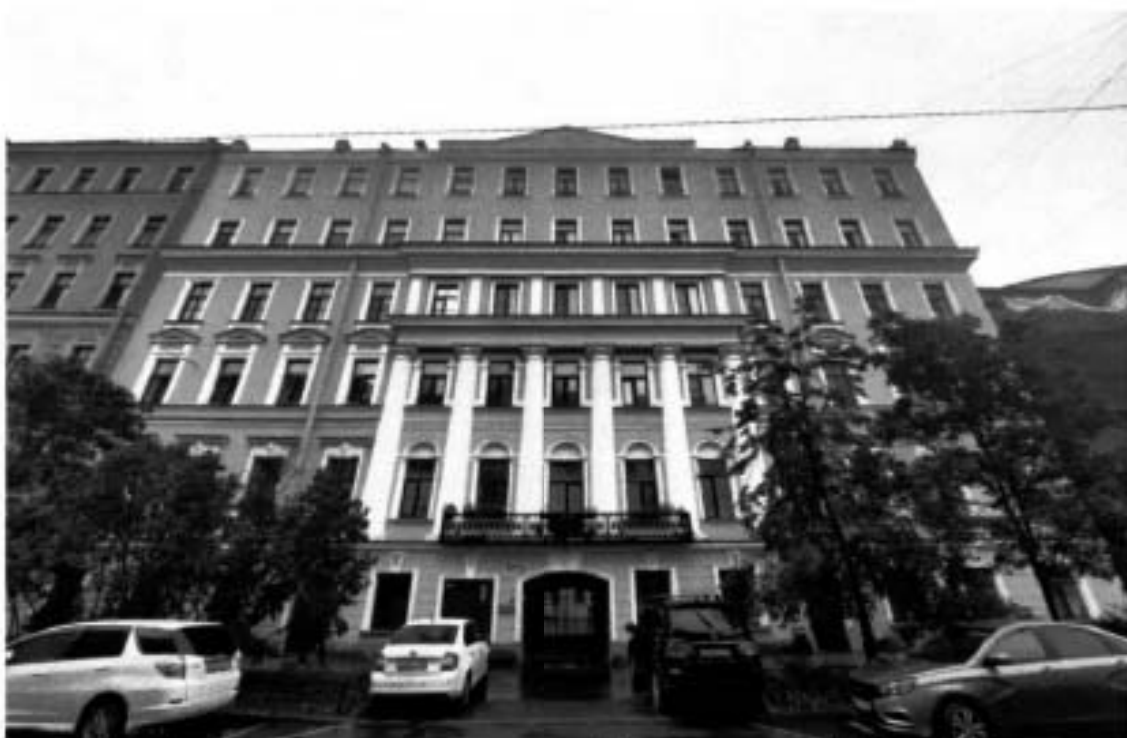
7. Общий вид на юго-восточный фасад здания (04.10.2024)
