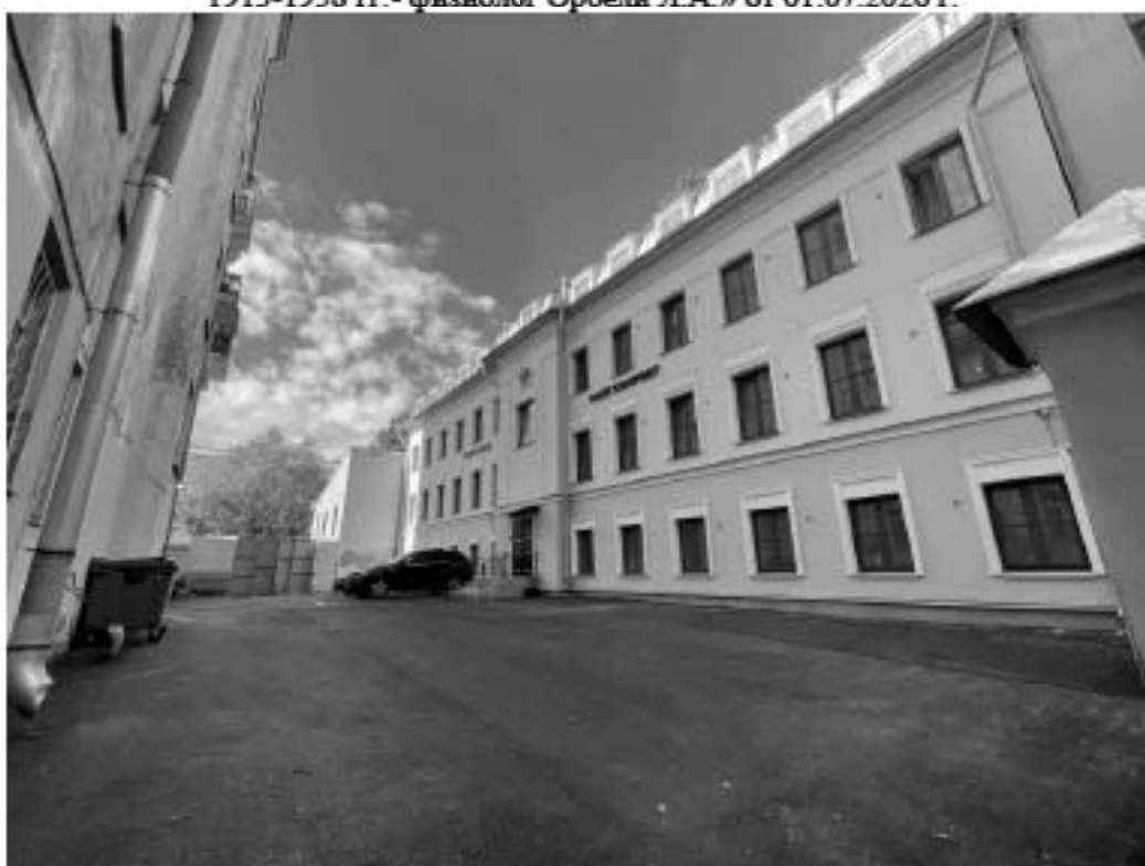
Фото 6. Фрагмент фасада здания по адресу Английский пр., дом 30, лит. Б (участок работ), примыкающее к объекту культурного наследия федерального значения «Здания, где в 1897-1919 гг. находились Высшие курсы физического образования (курсы Лесгафта). Здесь жили и работали: в 1897-1909 гг. - основатель курсов Лесгафт П.Ф., в 1907-1941гг. - революционер Морозов Н.А., в 1913-1958 гг. - физиолог Орбели Л.А.» от 01.07.2026 г.
