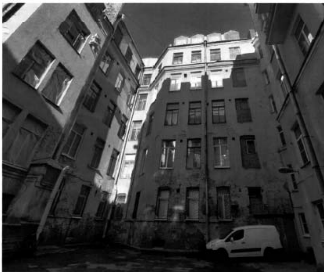
3. Общий вид на дворовый юго-восточный фасад здания (30.09.2024)
