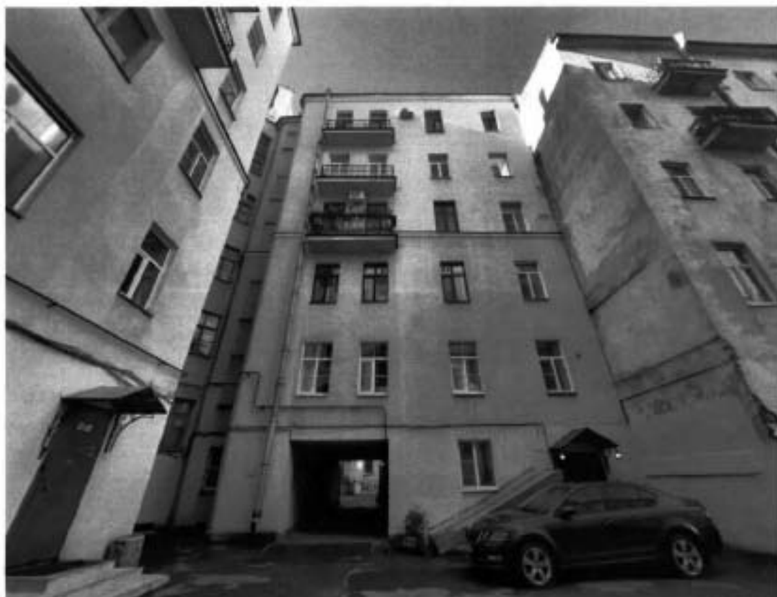
14. Общий вид на дворовый юго-западный фасад здания (северный двор) (30.09.2024)
