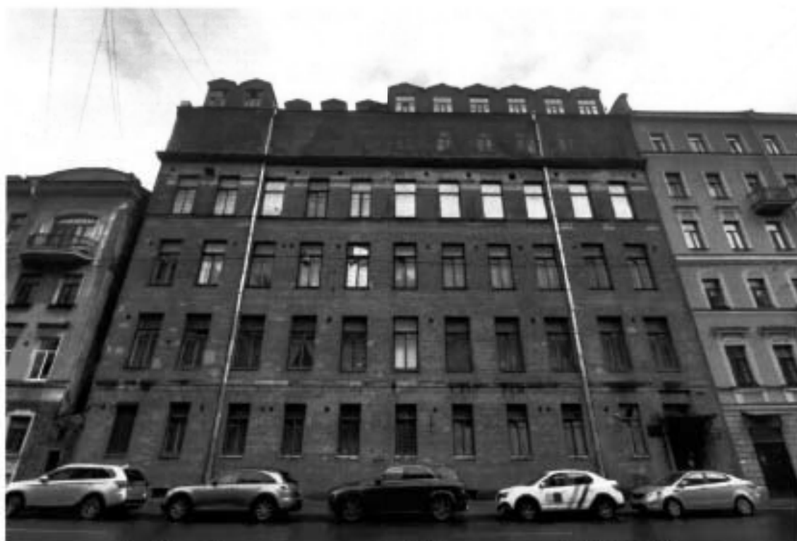
1. Общий вид на юго-западный фасад здания (27.09.2024)
