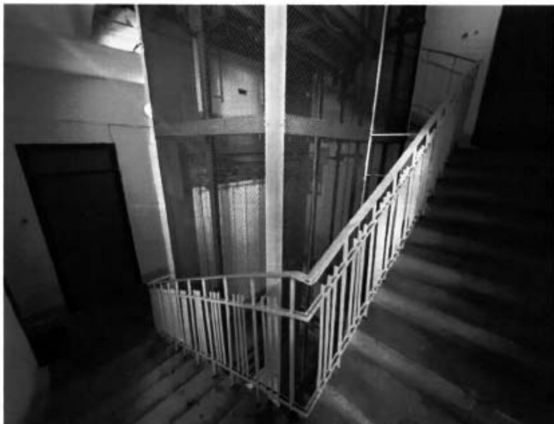
18. Лестница Л-3 здания (30.09.2024)
