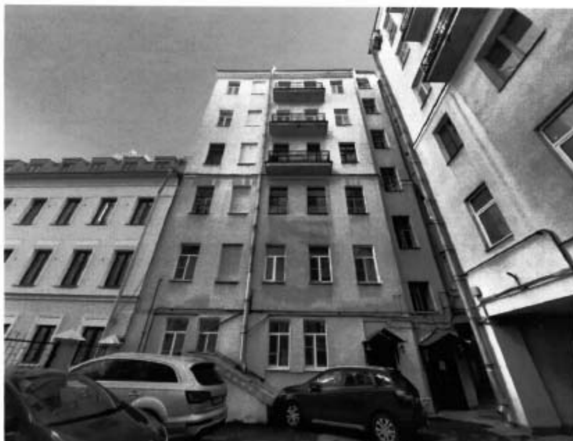
12. Общий вид на дворовый северо-восточный фасад здания (северный двор) (30.09.2024)
