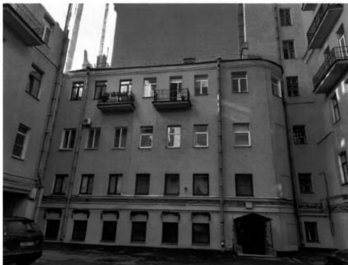
11. Общий вид на дворовый северо-восточный фасад здания (южный двор) (30.09.2024)
