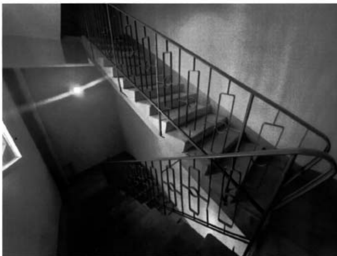
17. Лестница Л-2 здания (30.09.2024)
