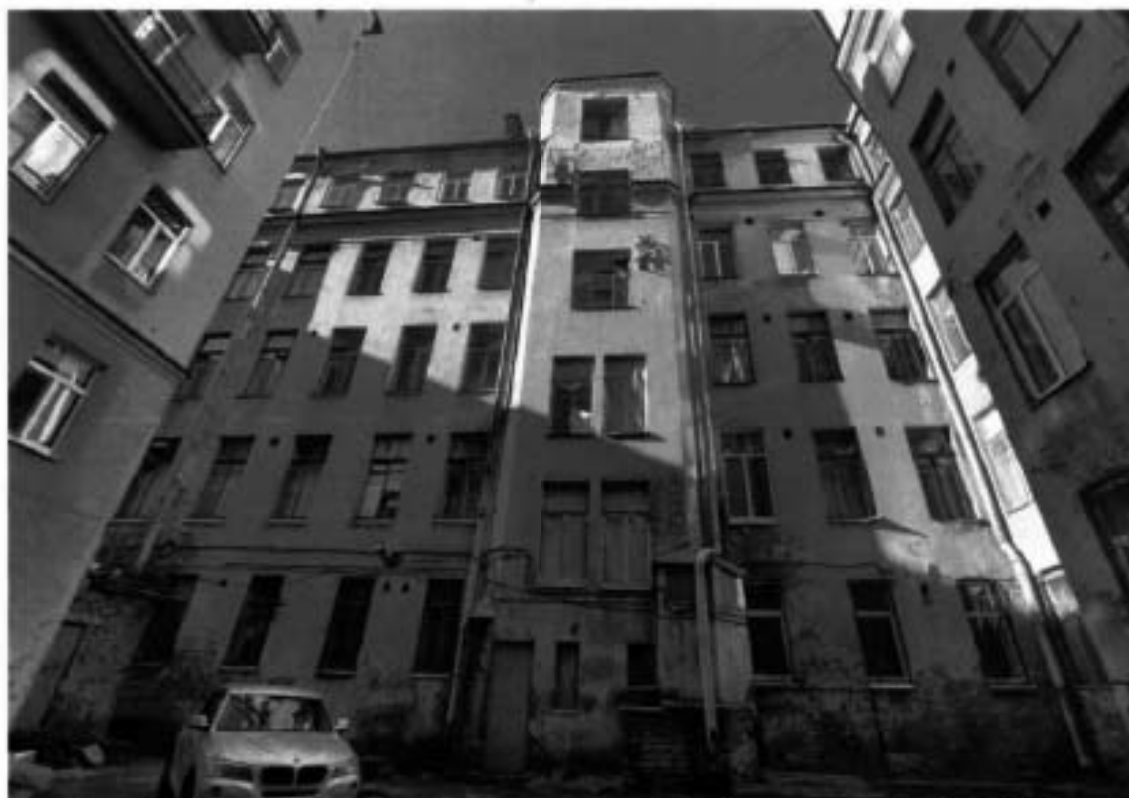
2. Общий вид на дворовый северо-восточный фасад здания (30.09.2024)
