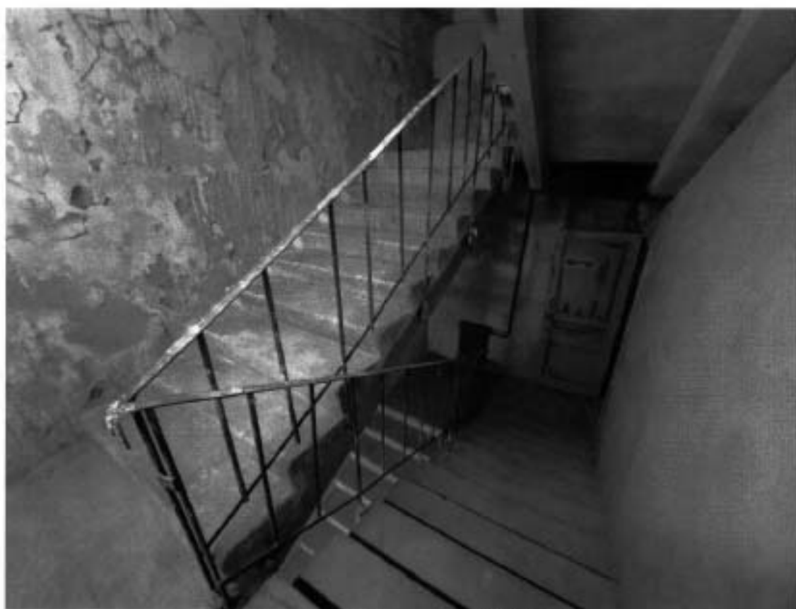
5. Лестница Л-1 здания (27.09.2024)
