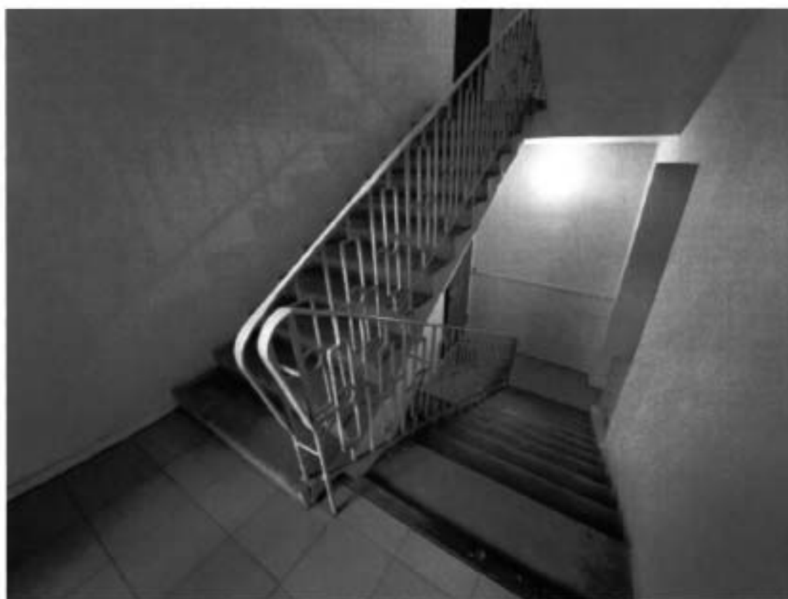
19. Лестница Л-4 здания (03.10.2024)
