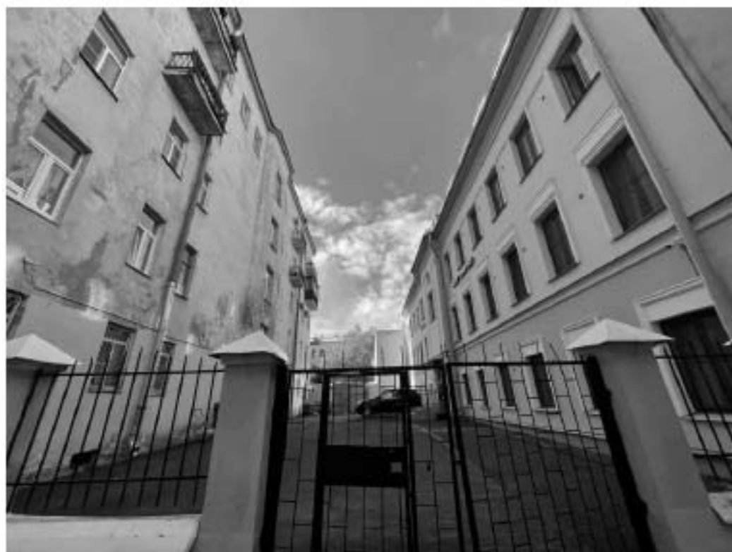
Фото 5. Фрагмент фасада здания по адресу Английский пр., дом 30, лит. Б (участок работ), примыкающее к объекту культурного наследия федерального значения «Здания, где в 1897-1919 гг. находились Высшие курсы физического образования (курсы Лесгафта). Здесь жили и работали: в 1897-1909 гг. - основатель курсов Лесгафт П.Ф., в 1907-1941гг. - революционер Морозов Н.А., в 1913-1958 гг. - физиолог Орбели Л.А.» от 01.07.2026 г.
