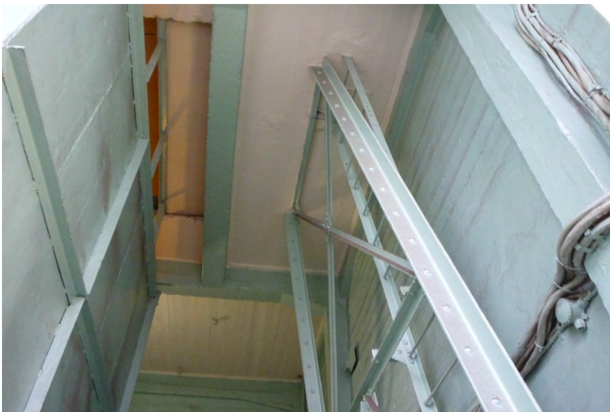
22. Выявленный объект культурного наследия «Разбивочный плаз». Главная лестница. Деталь интерьера. Съёмка 23 марта 2021 г.
