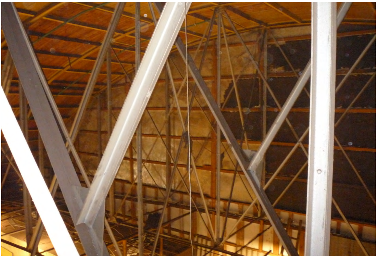
38. Выявленный объект культурного наследия «Разбивочный плаз». Конструкции кровли. Съёмка 23 марта 2021 г.
