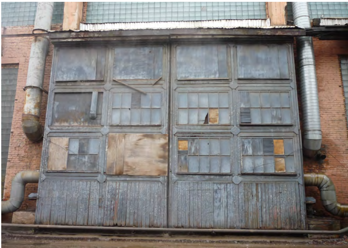
6. Выявленный объект культурного наследия «Разбивочный плаз». Фрагмент северного (продольного) фасада. Съёмка 23 марта 2021 г.
