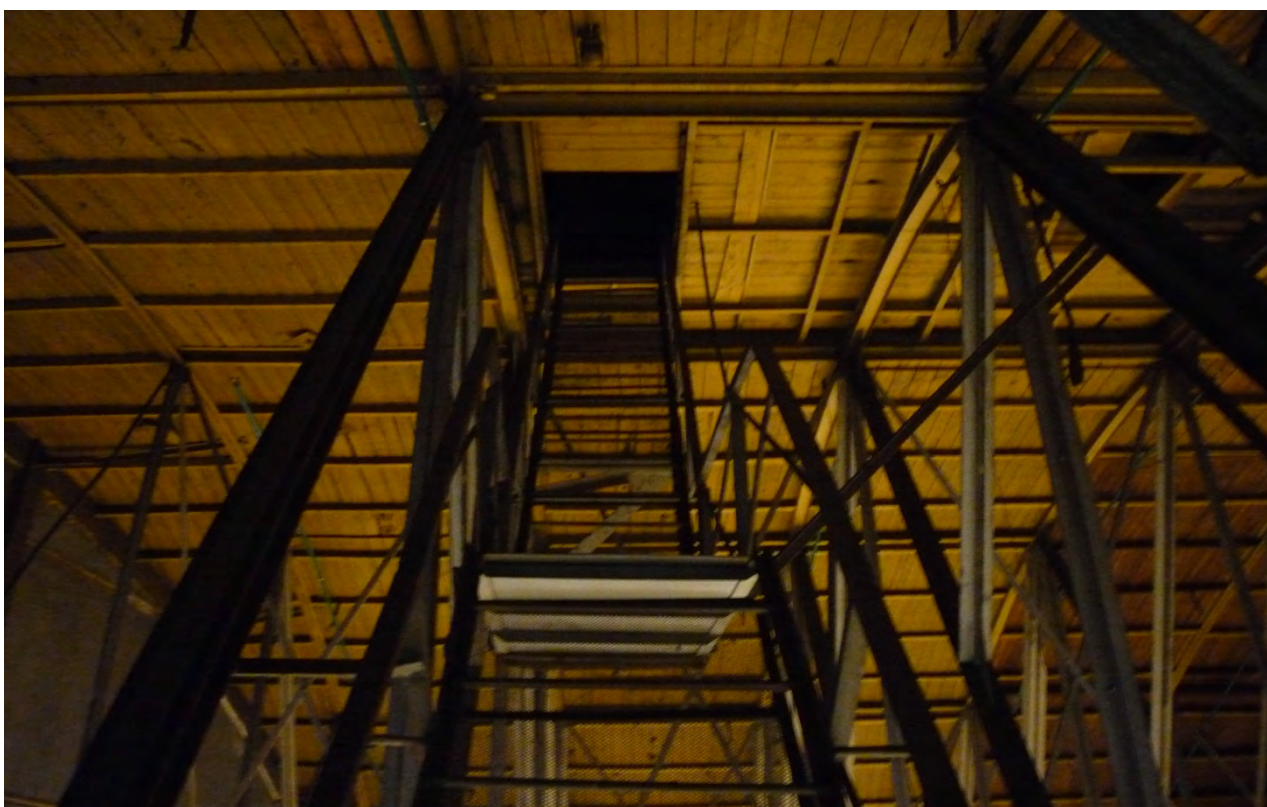
36. Выявленный объект культурного наследия «Разбивочный плаз». Конструкции кровли. Лестница в фотопроеекционную. Съёмка 23 марта 2021 г.
