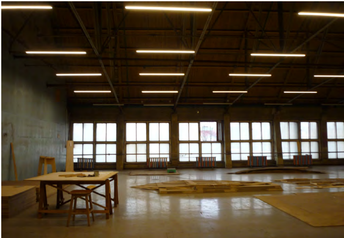
31. Выявленный объект культурного наследия «Разбивочный плаз». Вид цеха на 4 этаже (на юг). Фрагмент. Съёмка 23 марта 2021 г.
