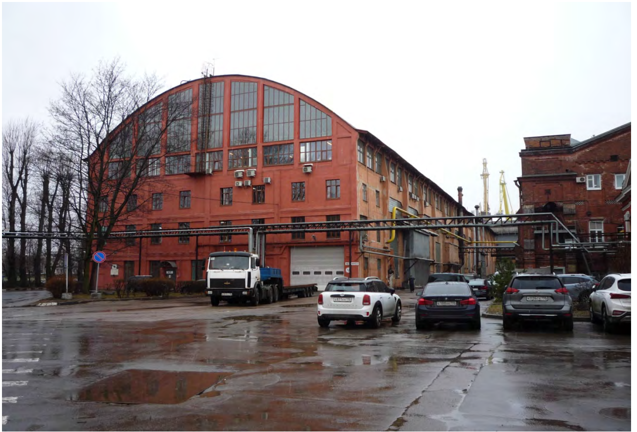
1. Выявленный объект культурного наследия «Разбивочный плаз». Общий вид с северо-востока. 23 марта 2021 г.
