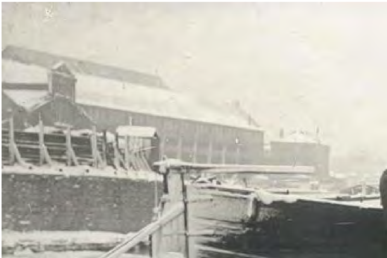
Илл.26. Фонтанка, укрепление берега в районе устья. 1929 г. Фрагмент. Код доступа URL: https://pastvu.com/p/535654 . Дата обращения 15 апреля 2021 г.
