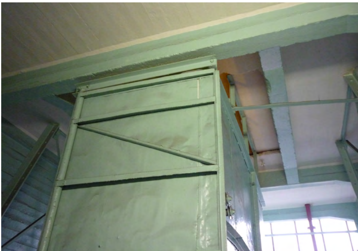
21. Выявленный объект культурного наследия «Разбивочный плаз». Главная лестница. Деталь интерьера. Съёмка 23 марта 2021 г.
