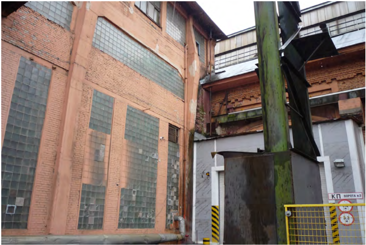
5. Выявленный объект культурного наследия «Разбивочный плаз». Фрагмент северного (продольного) фасада. Съёмка 23 марта 2021 г.
