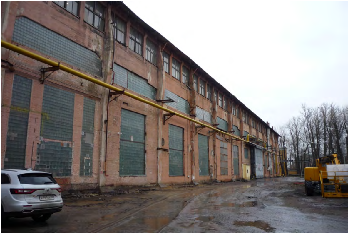
10. Выявленный объект культурного наследия «Разбивочный плаз». Общий вид южного (продольного) фасада. Съёмка 23 марта 2021 г.
