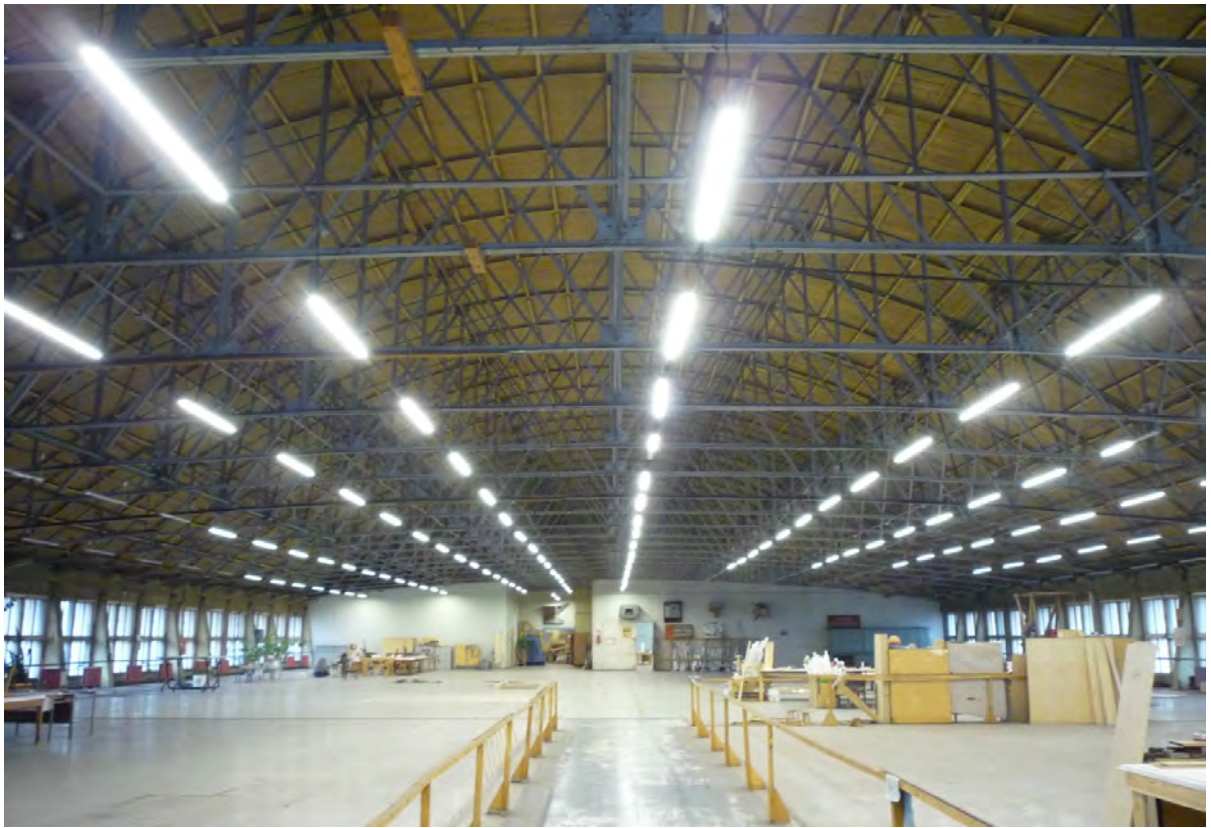
27. Выявленный объект культурного наследия «Разбивочный плаз». Вид цеха на 4 этаже (на запад). Съёмка 23 марта 2021 г.
