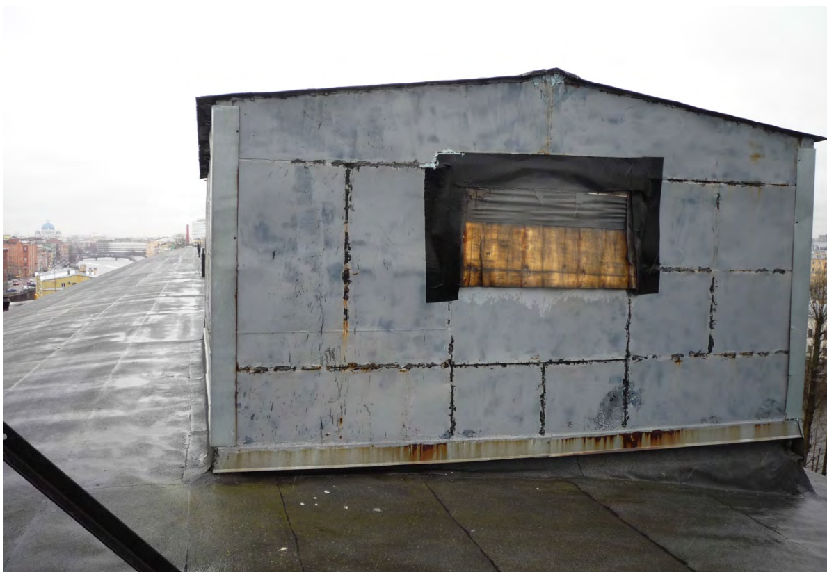
18. Выявленный объект культурного наследия «Разбивочный плаз». Кровля. Вид на восток. Фотопроекторная. Съёмка 23 марта 2021 г.
