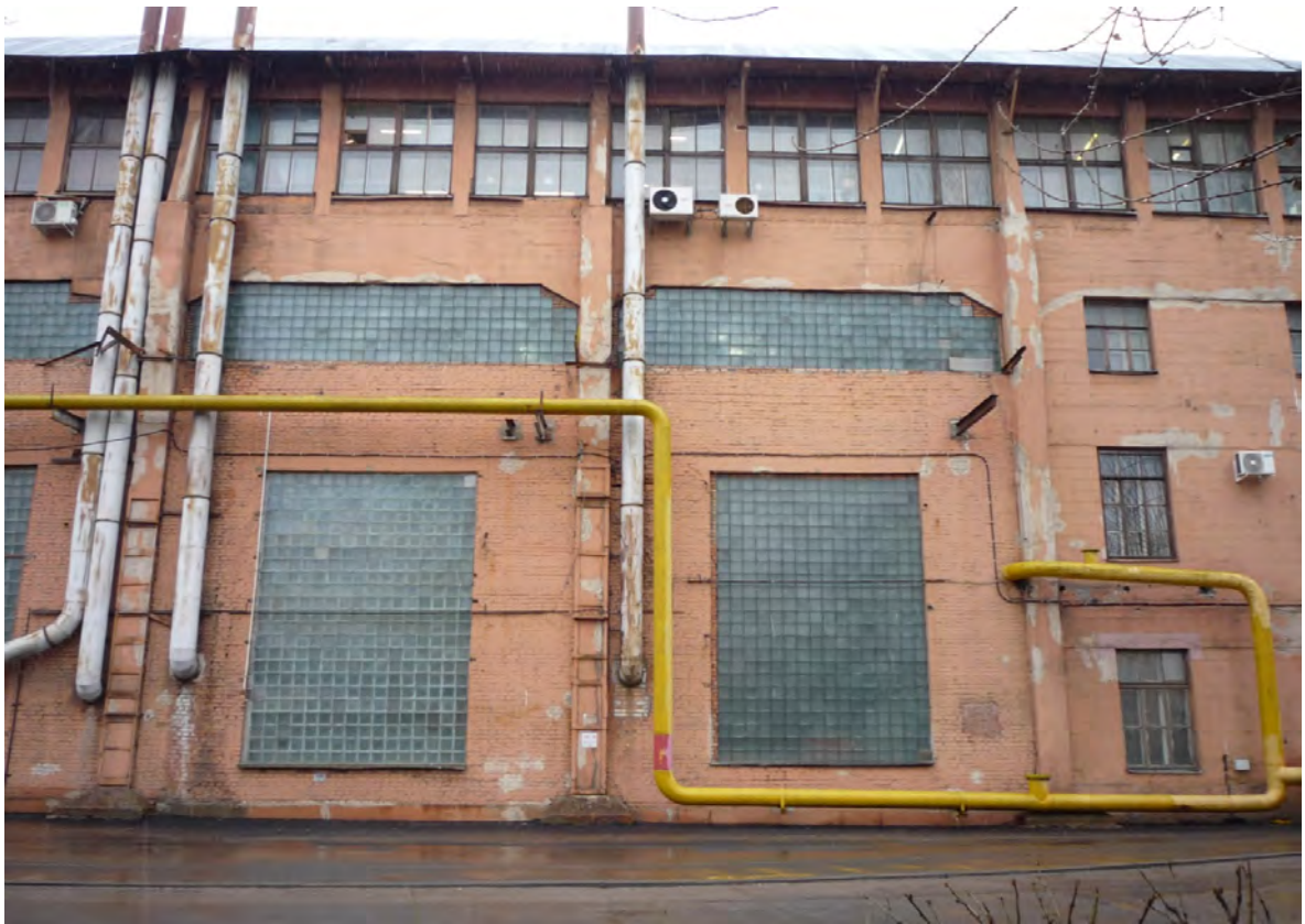
11. Выявленный объект культурного наследия «Разбивочный плаз». Фрагмент южного (продольного) фасада. Съёмка 23 марта 2021 г.
