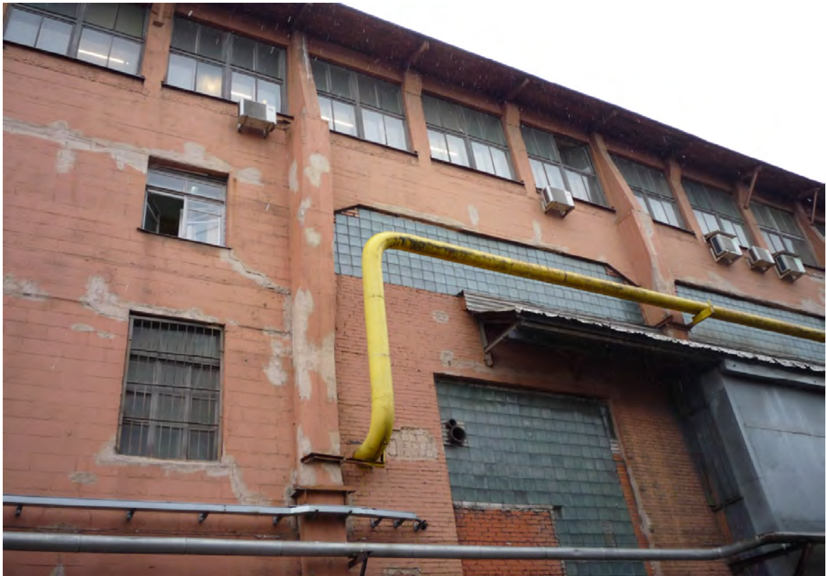
3. Выявленный объект культурного наследия «Разбивочный плаз». Фрагмент северного (продольного) фасада. 23 марта 2021 г.
