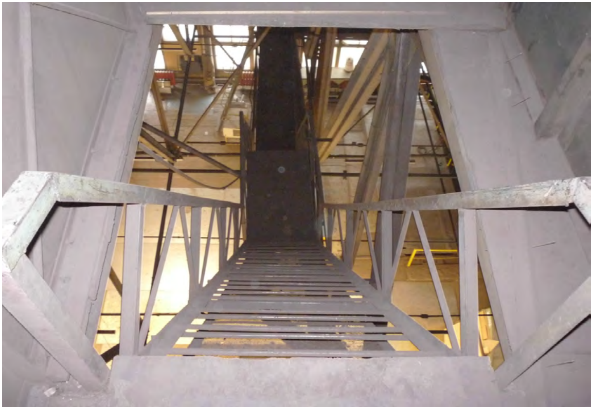
37. Выявленный объект культурного наследия «Разбивочный плаз». Конструкции кровли. Лестница в фотопроеекционную. Вид сверху. Съёмка 23 марта 2021 г.
