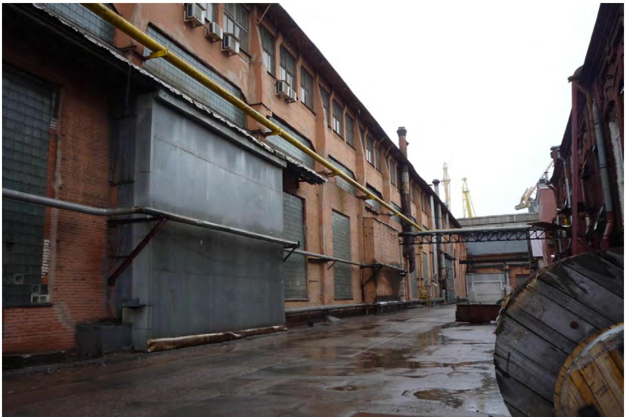
4. Выявленный объект культурного наследия «Разбивочный плаз». Фрагмент северного (продольного) фасада. 23 марта 2021 г.
