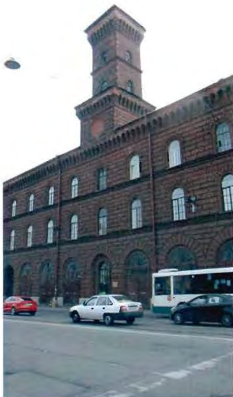
5. Фрагмент западного фасада. Башня-каланча.
