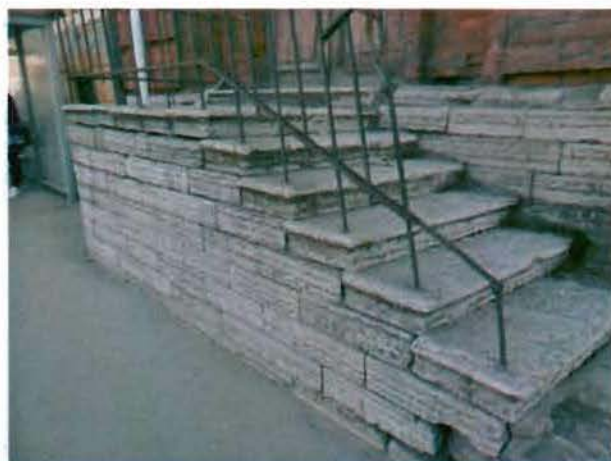
10. Крыльцо со стороны западного фасада.
