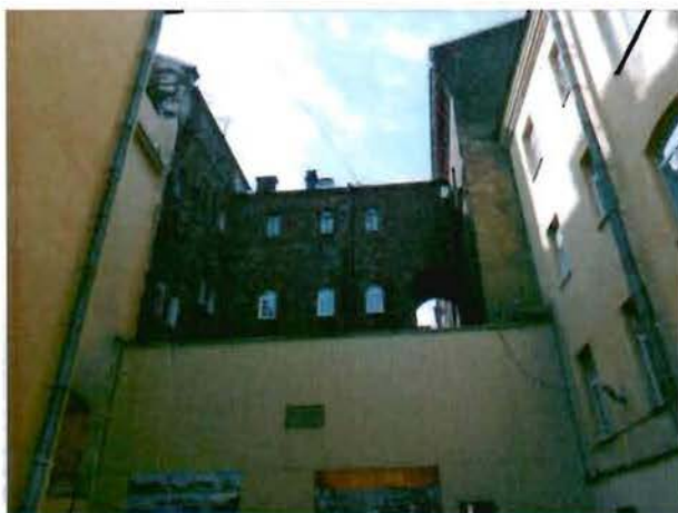
9. Северный фасад здания.
