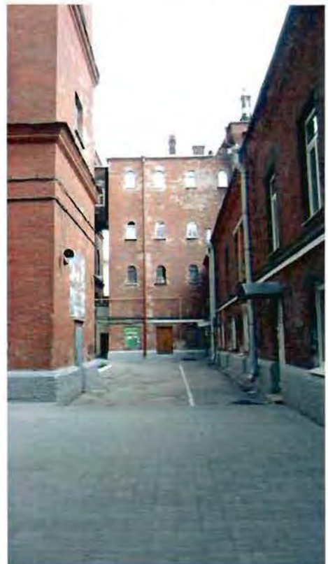
8. Фрагмент северо-восточного дворового фасада.
