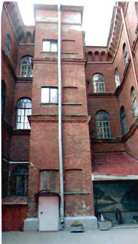
7. Юго-западный дворовой фасад.
