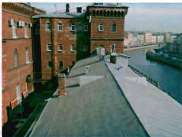
3. Северный дворовой фасад.
