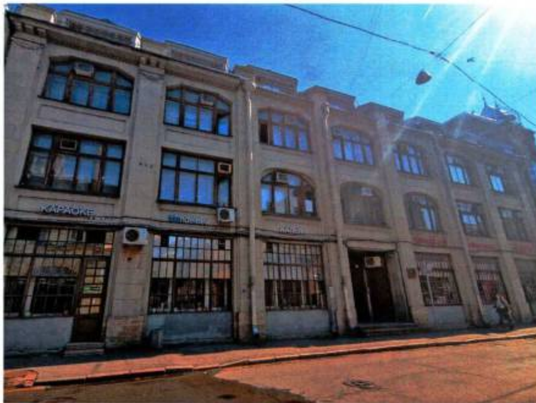
1. Лицевой фасад объекта культурного наследия.
