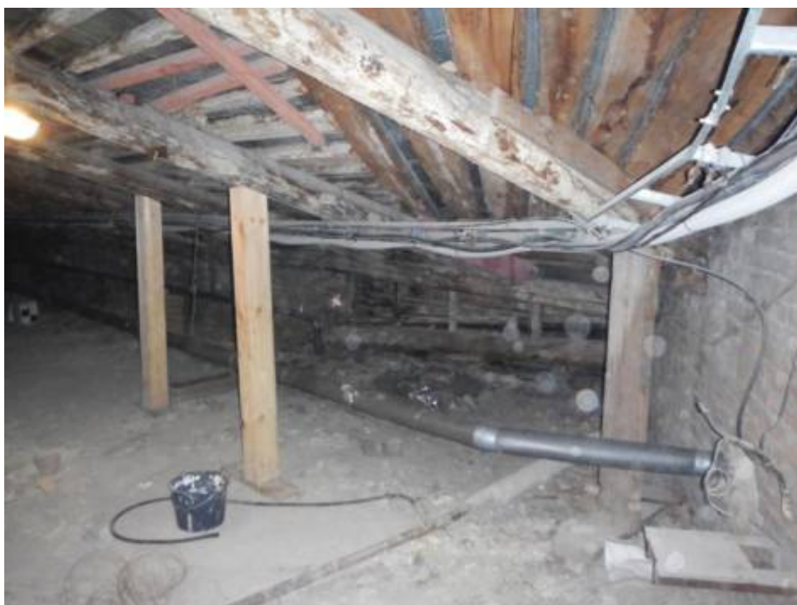
Фото 6. Общий вид чердачного помещения
