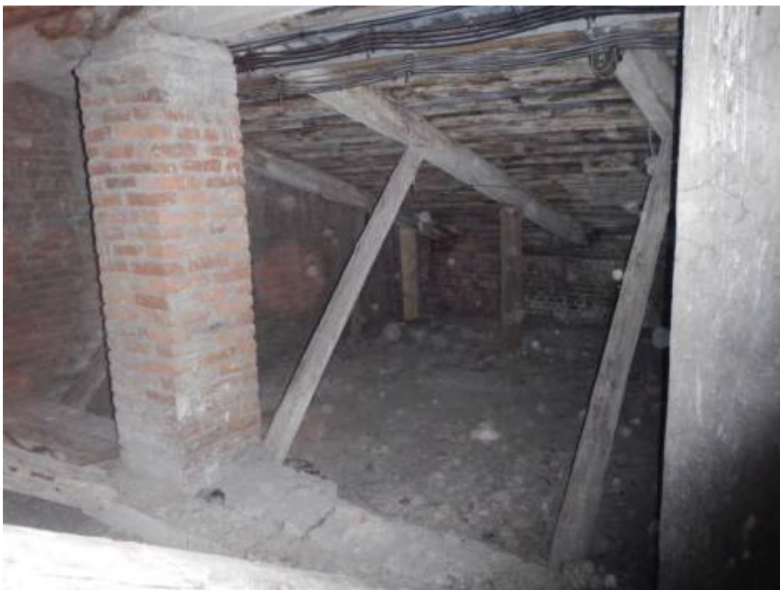
Фото 11. Общий вид стропильной системы крыши
