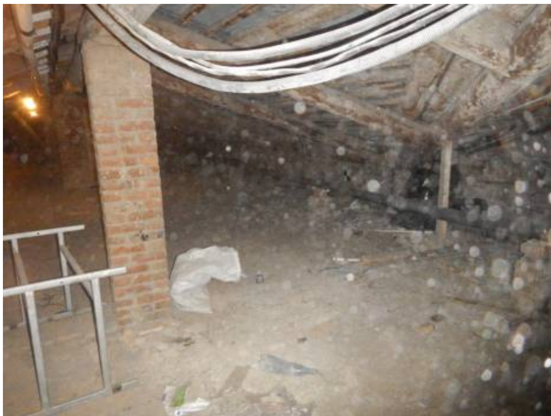
Фото 20. Фрагмент чердачного помещения.
