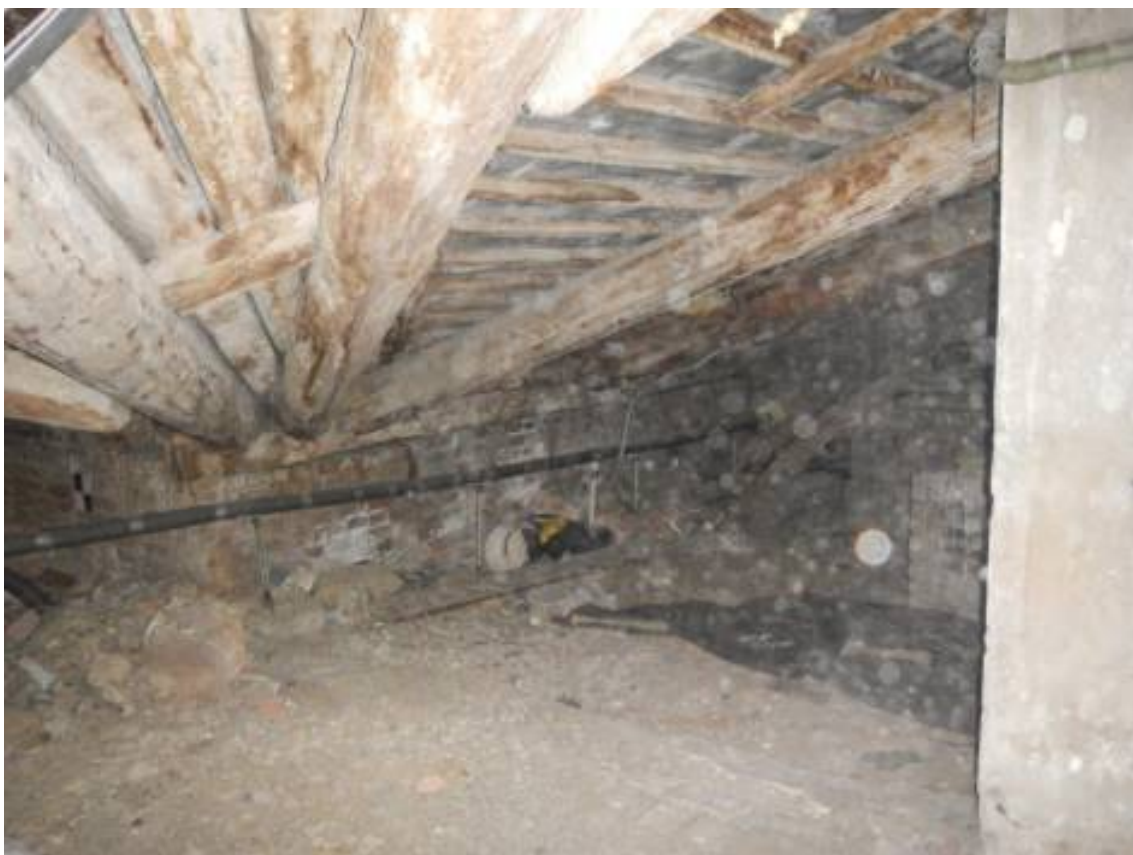
Фото 18. Устройство ендовы крыши.
