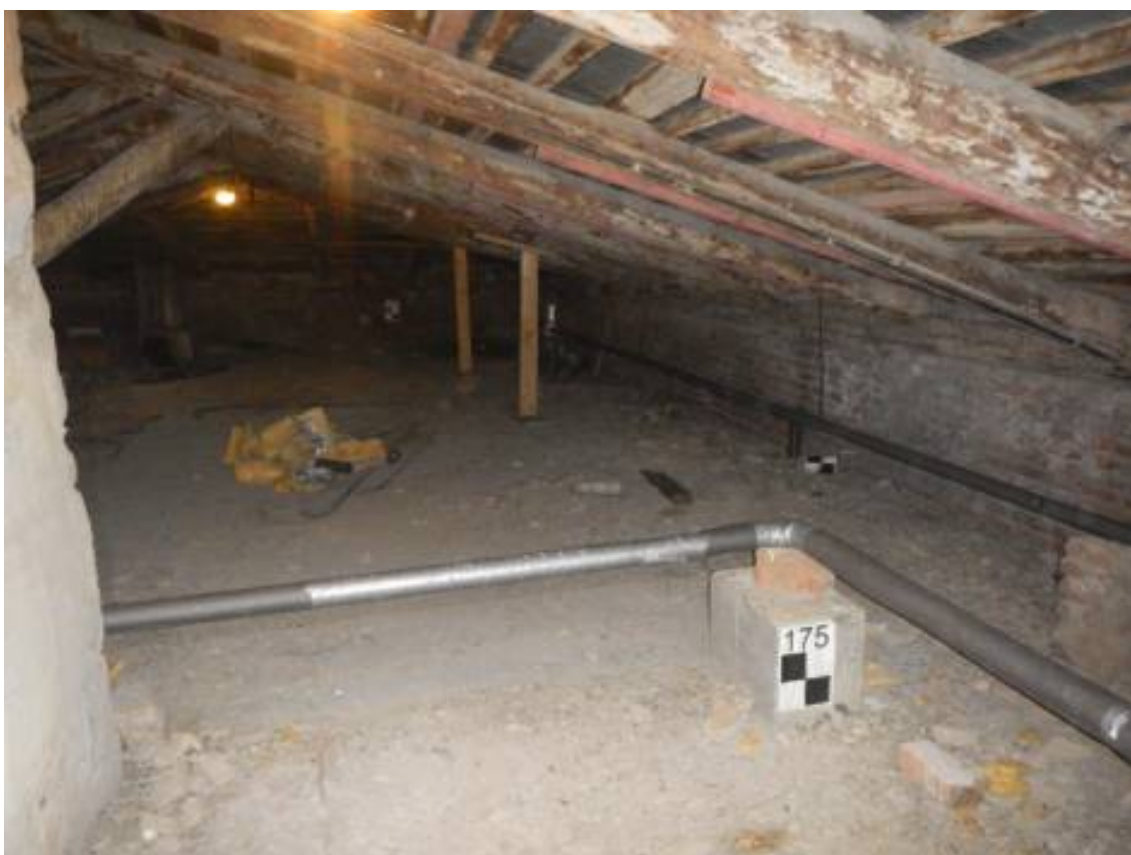
Фото 8. Общий вид чердачного помещения.
