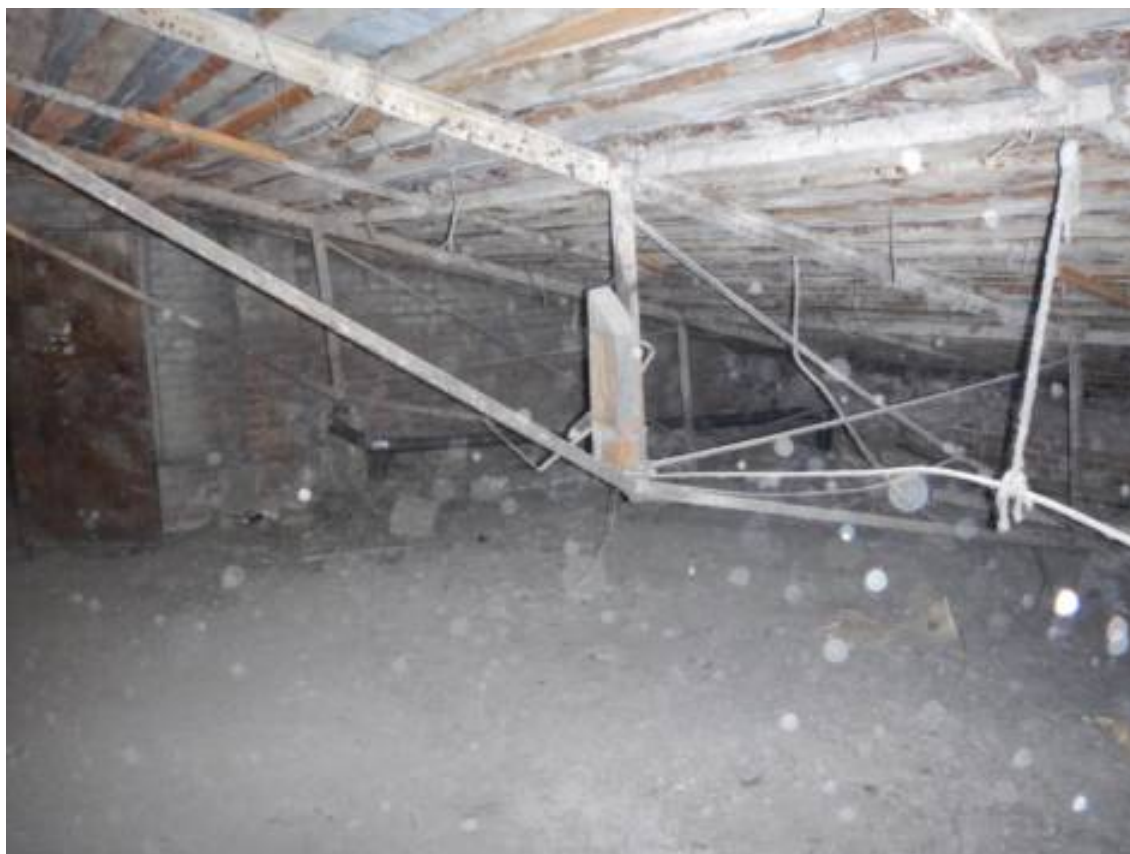
Фото 3. Общий вид стропильных конструкции крыши.
