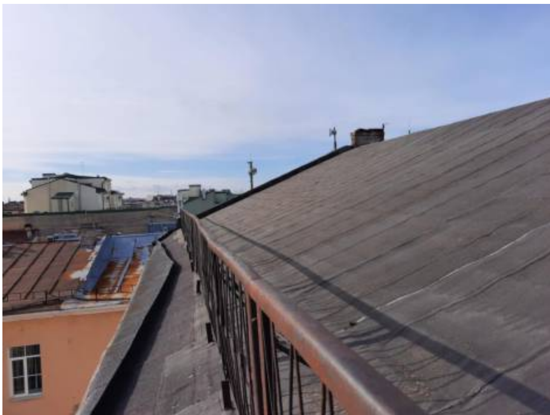
Фото 3. Общий вид кровли.
