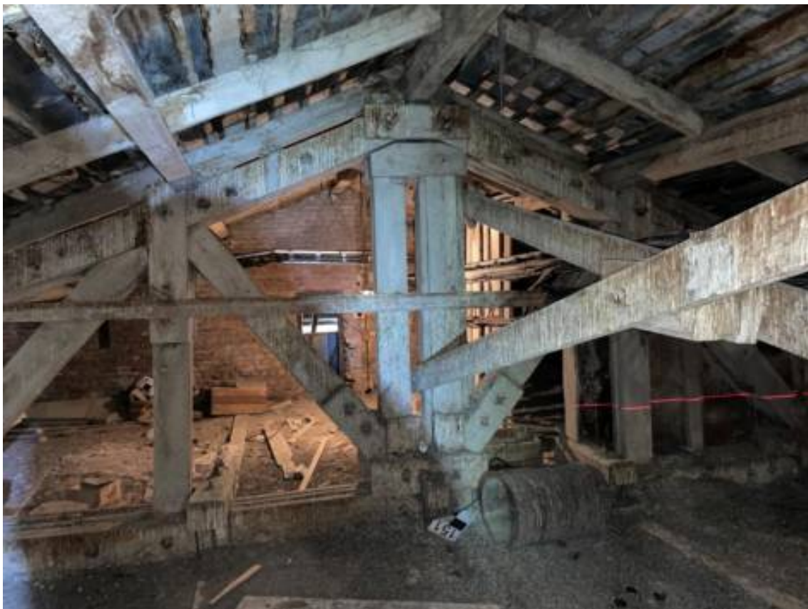
Фото 17. Общий вид стропильной системы крыши.
