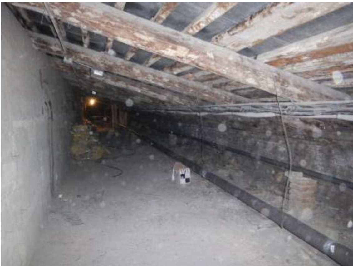
Фото 7. Общий вид чердачного помещения.
