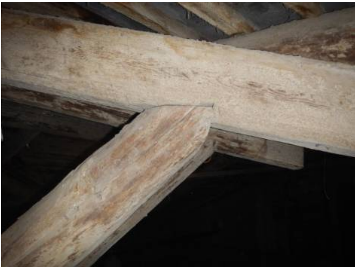
Фото 5. Общий вид сопряжения подкоса и стропильной ноги.
