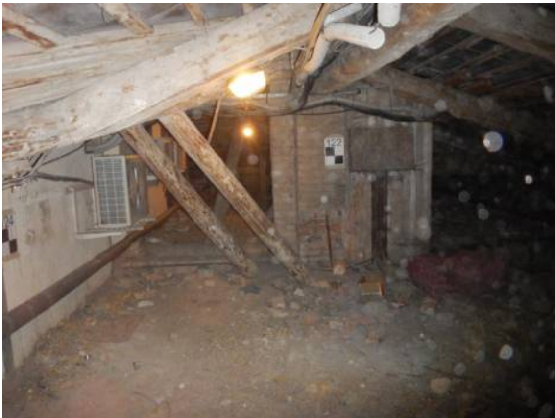
Фото 19. Устройство подкосов стропильной системы.
