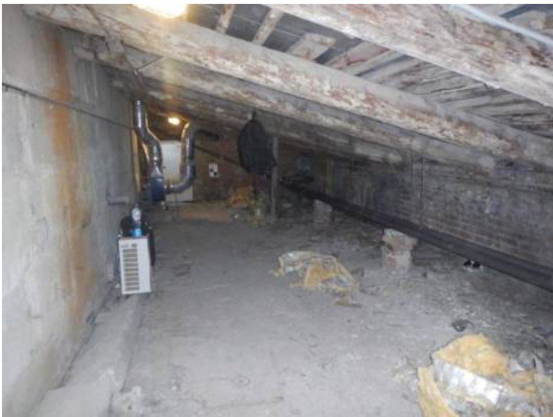
Фото 10. Общий вид чердачного помещения.
