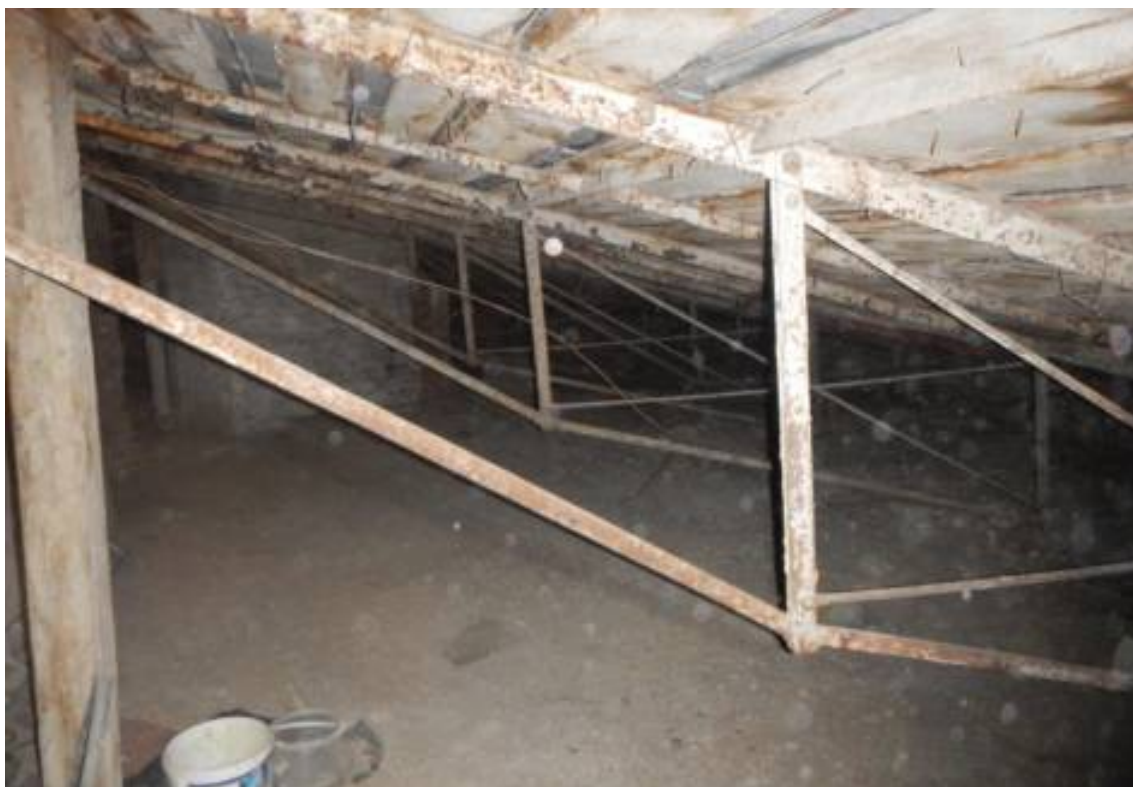
Фото 1. Общий вид стропильных конструкции крыши.
