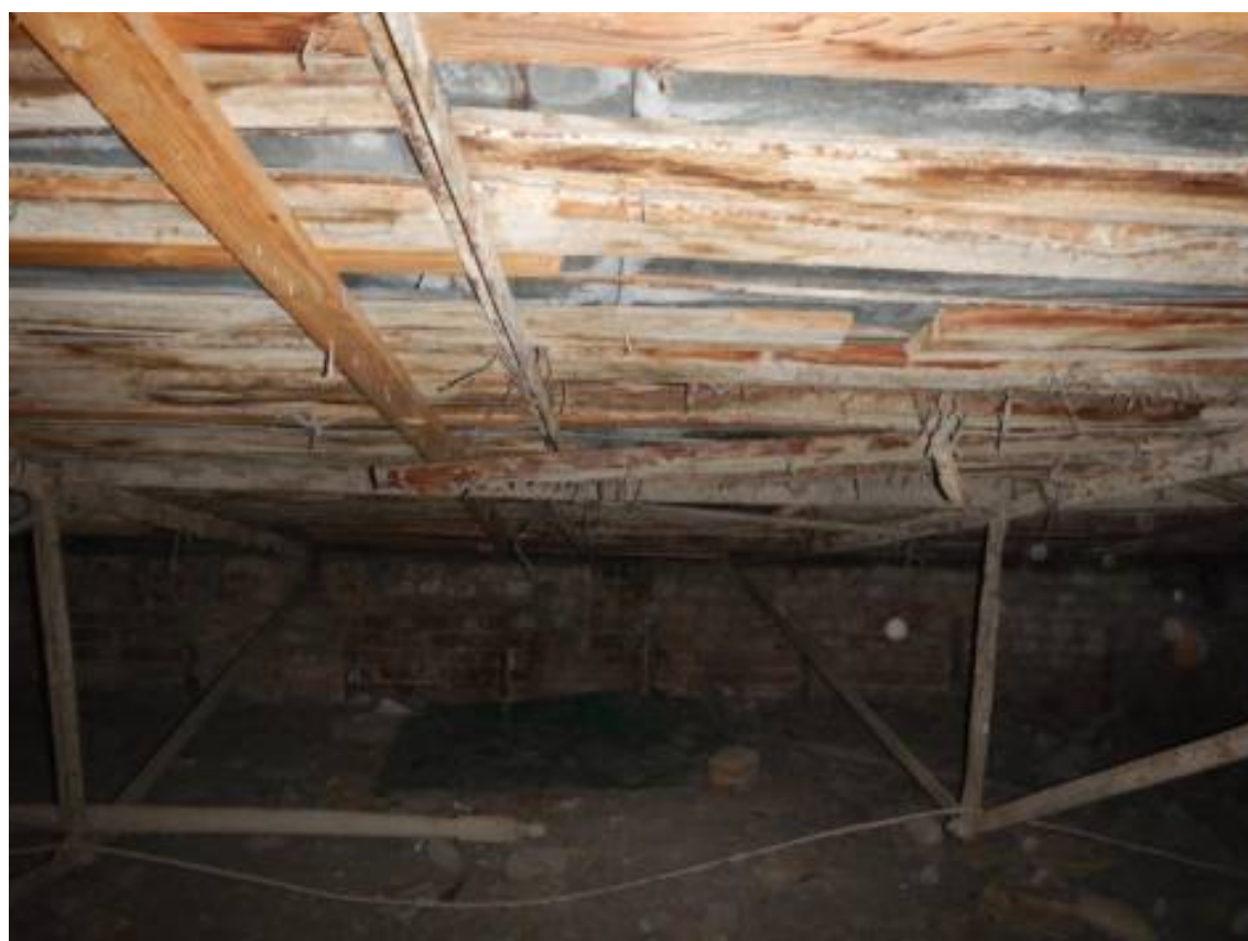
Фото 2. Общий вид стропильных конструкции крыши.
