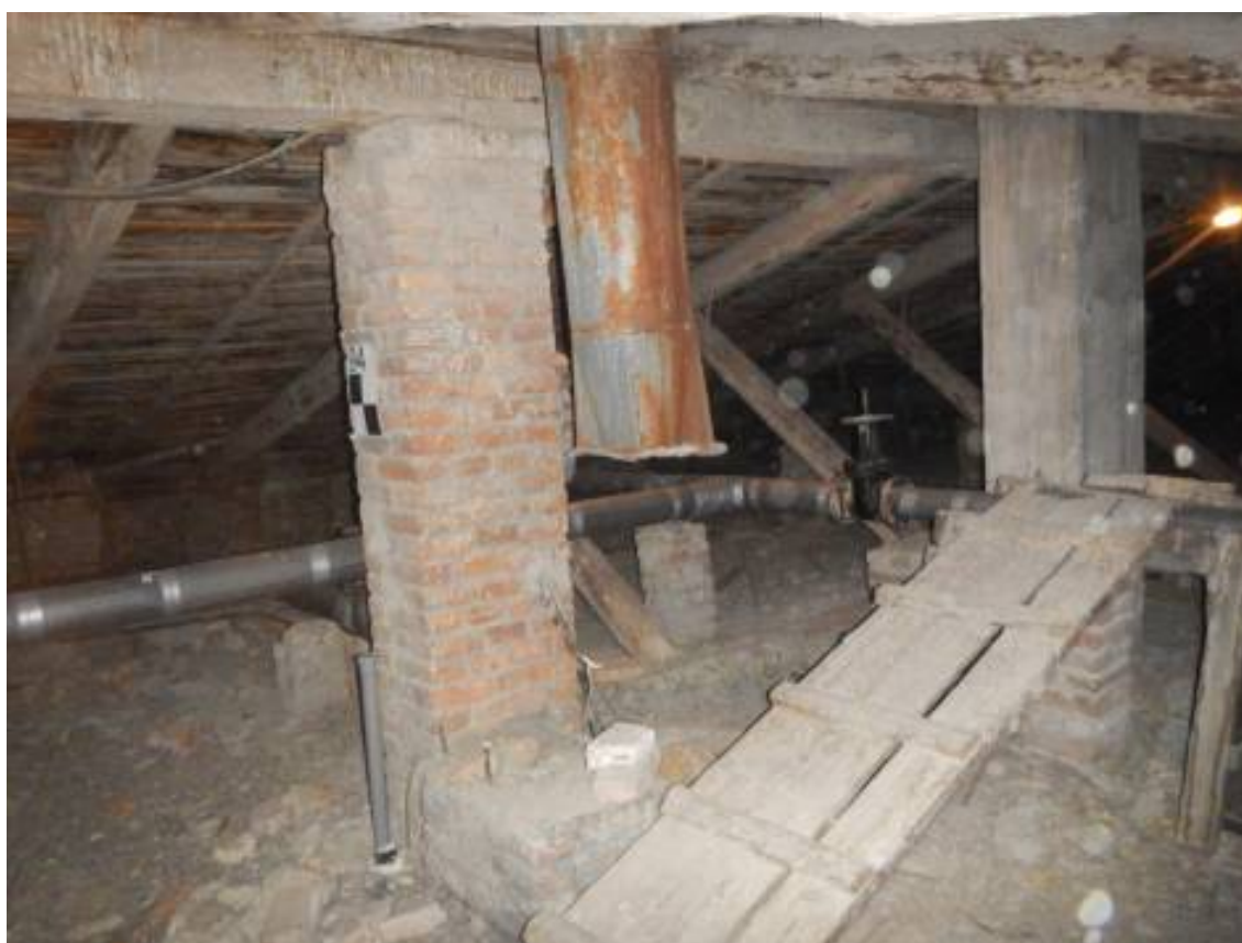
Фото 4. Общий вид чердачного помещения в осях «10-11//И/12-К/12».
