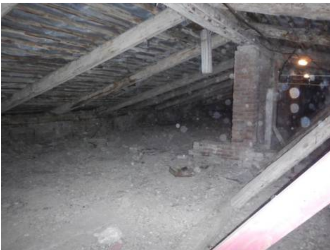
Фото 12. Общий вид чердачного помещения
