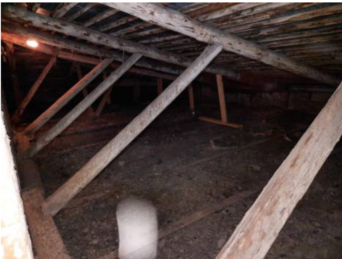
Фото 14. Общий вид стропильной системы крыши.
