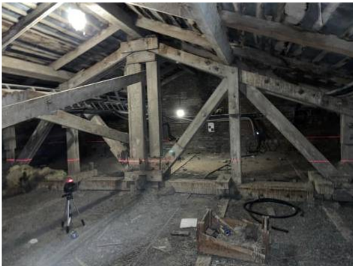
Фото 15. Общий вид стропильной системы крыши.
