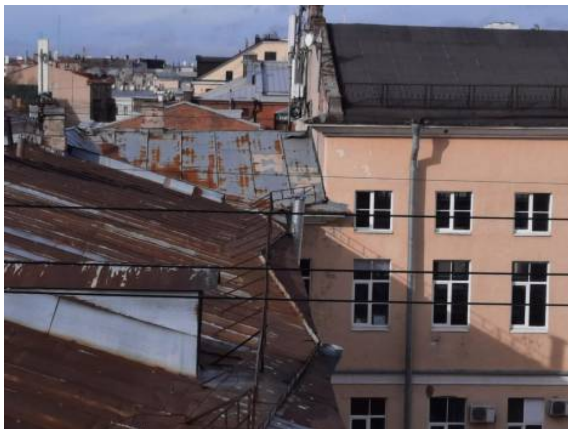
Фото 4. Общий вид кровли.
