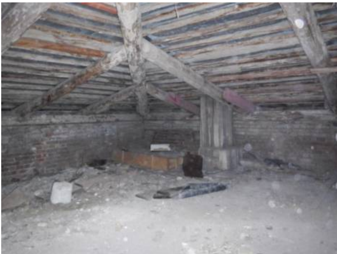
Фото 9. Общий вид чердачного помещения.
