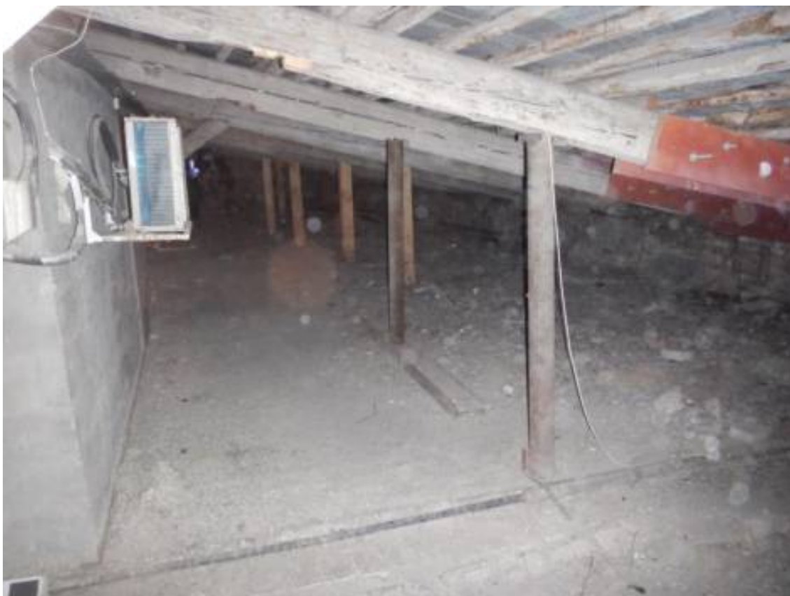
Фото 13. Общий вид стропильной системы крыши
