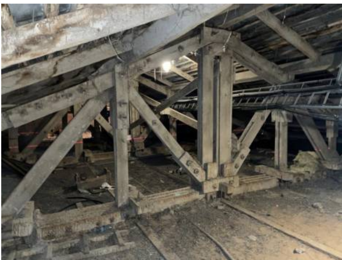
Фото 16. Общий вид стропильной системы крыши.
