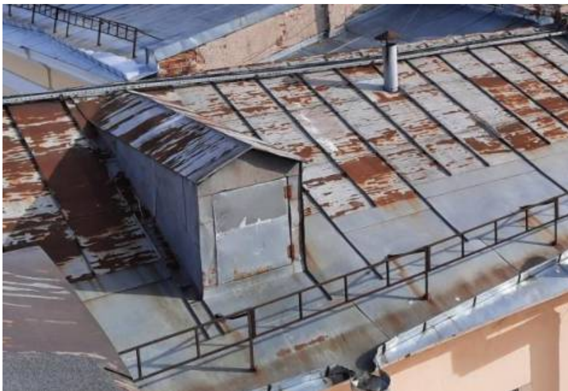
Фото 7. Общий вид слухового окна.
