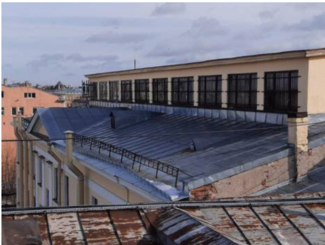
Фото 8. Общий вид кровли.
