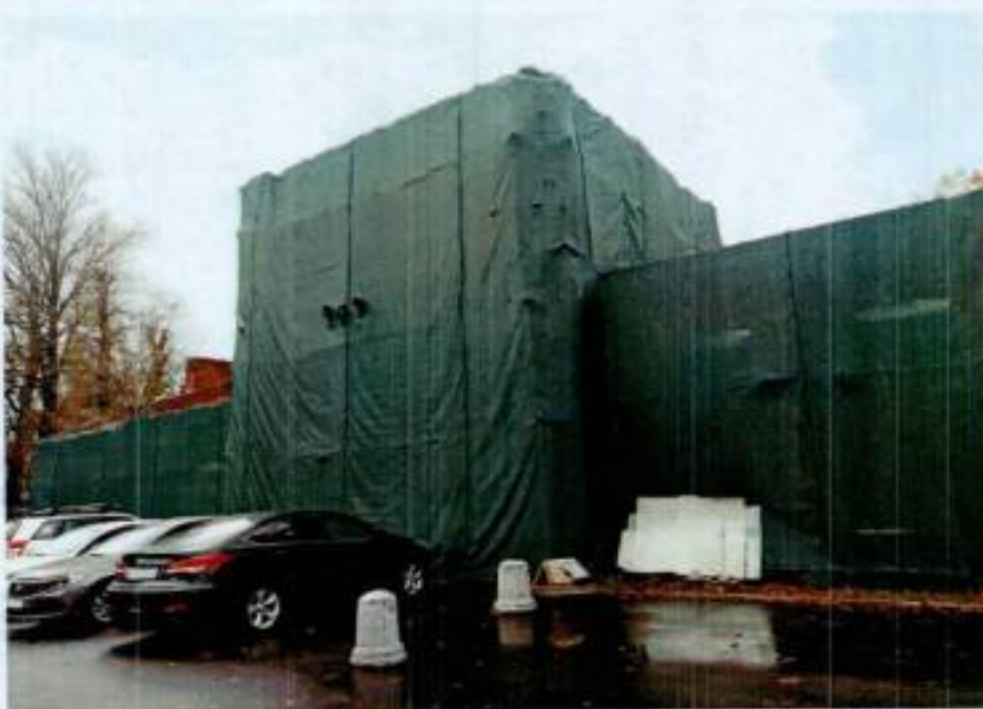
2. Общий вид. Юго-западный фасад объекта культурного наследия.
