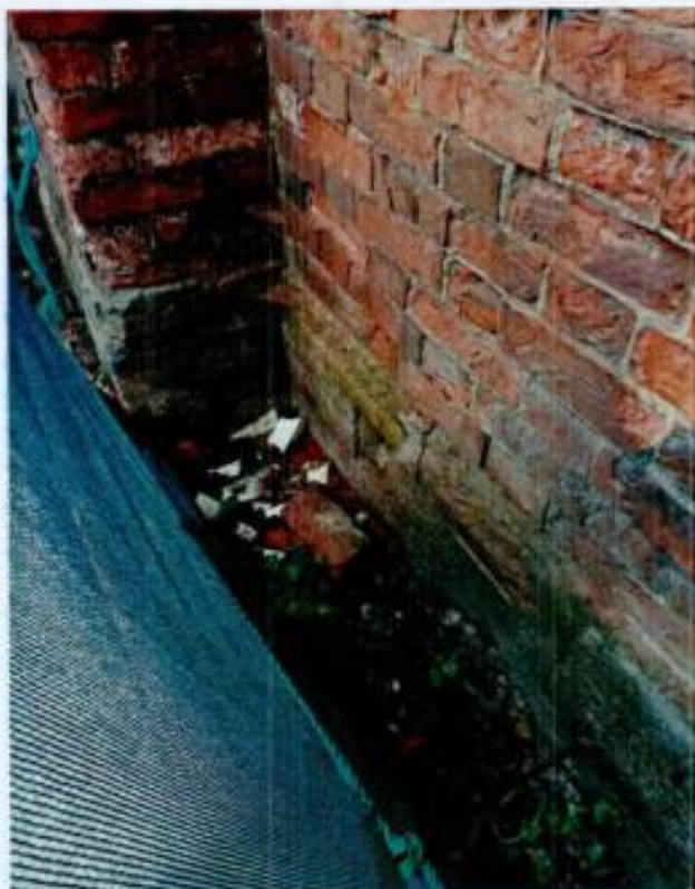
5. Фрагмент. Северо-восточный фасад объекта культурного наследия.
