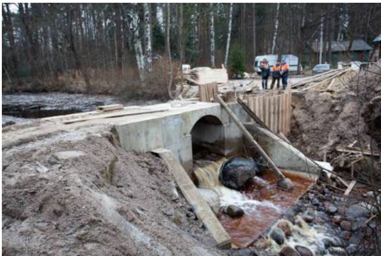
38. Фотография. Реконструкция плотины. 2009 г.
