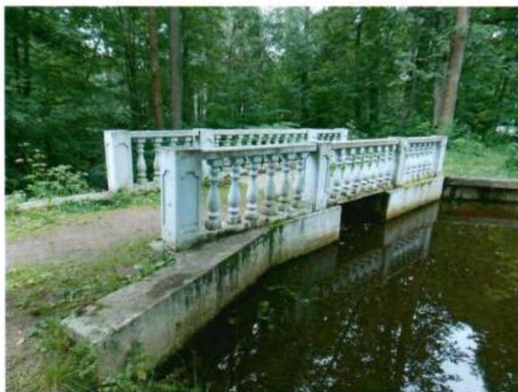
6. Мост-плотина. Верхний бьеф.
