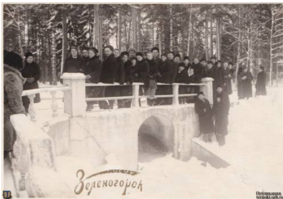
29. Фотография. Мост на территории гостиницы «Ривьера». Терийоки. 1954 г.
