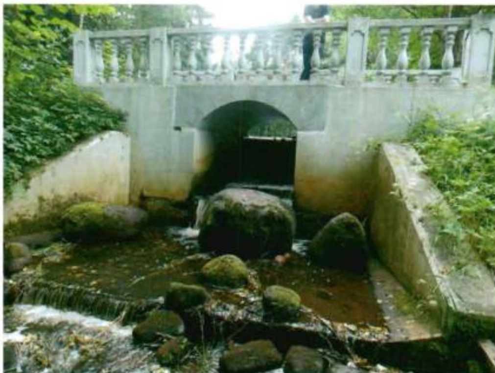
5. Мост-плотина. Нижний бьеф.
