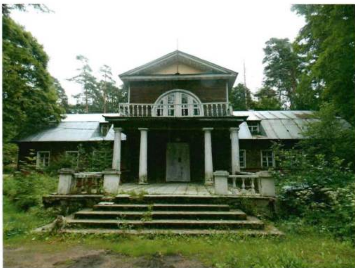
1. Общий вид. Западный фасад.
