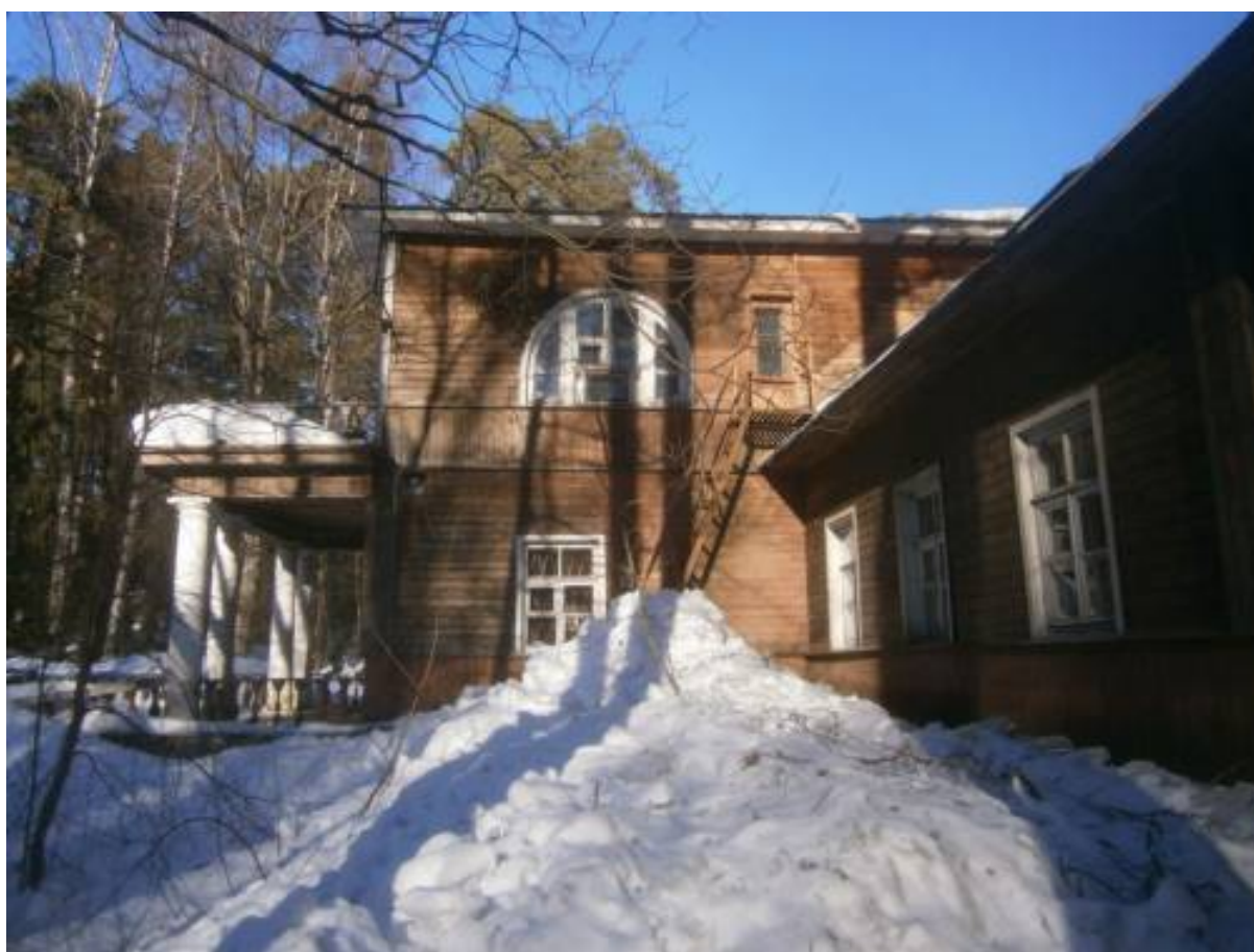
47. Фотография. Вилла «Айнола». Вид с юга на центральную часть. 2019 г.
