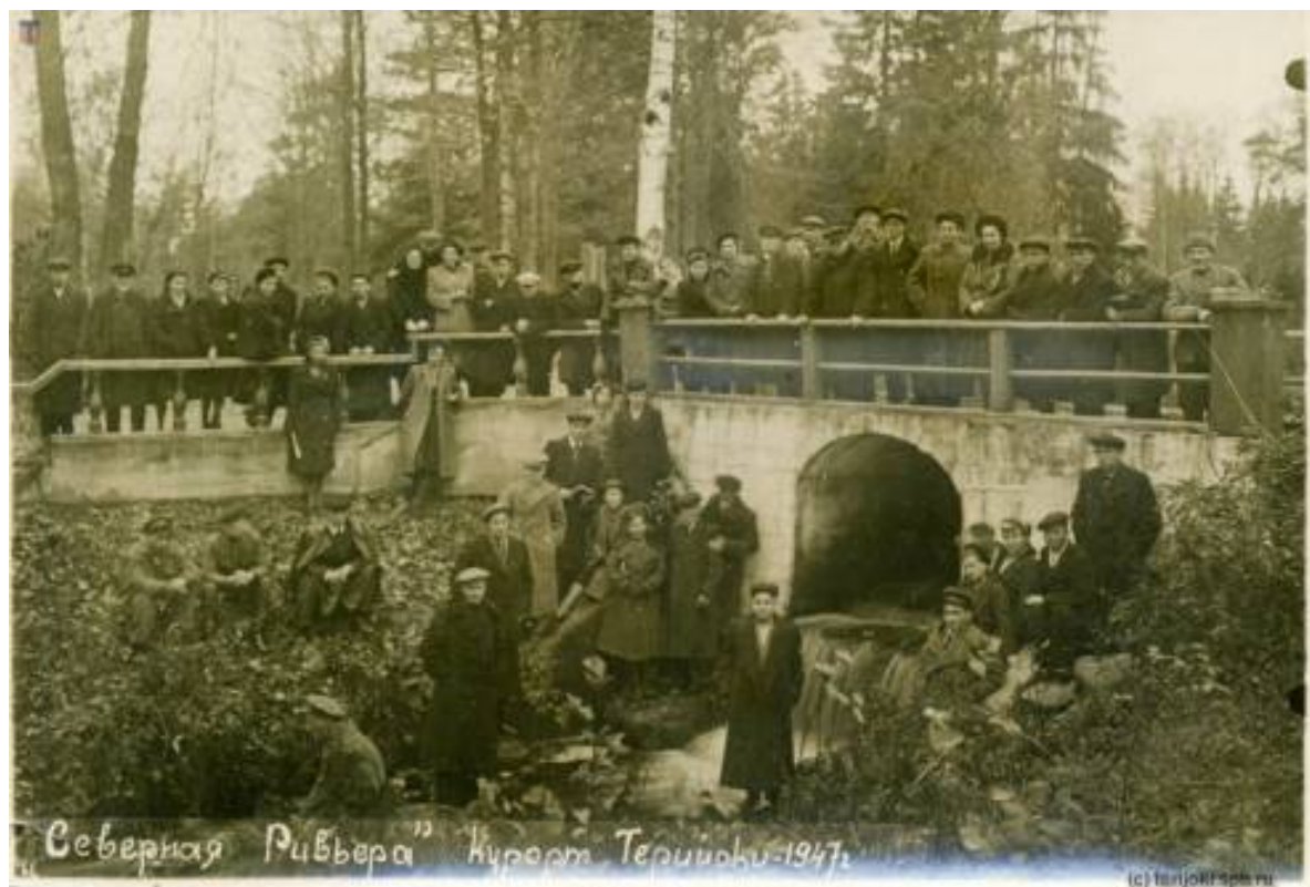
18. Фотография. «Северная Ривьера». Курорт Терийоки. Вид на мост. 1947 г.
