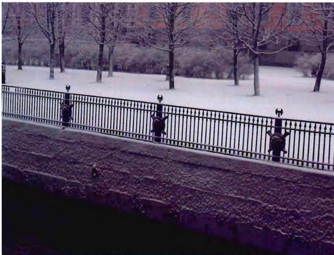
3. Ограждение набережной со стороны Михайловского (Инженерного) замка
