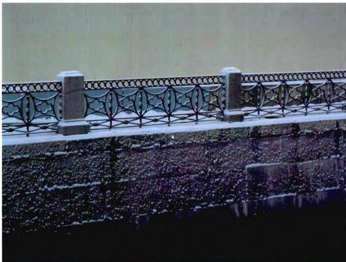
6. Ограждение набережной. Левобережная стенка
