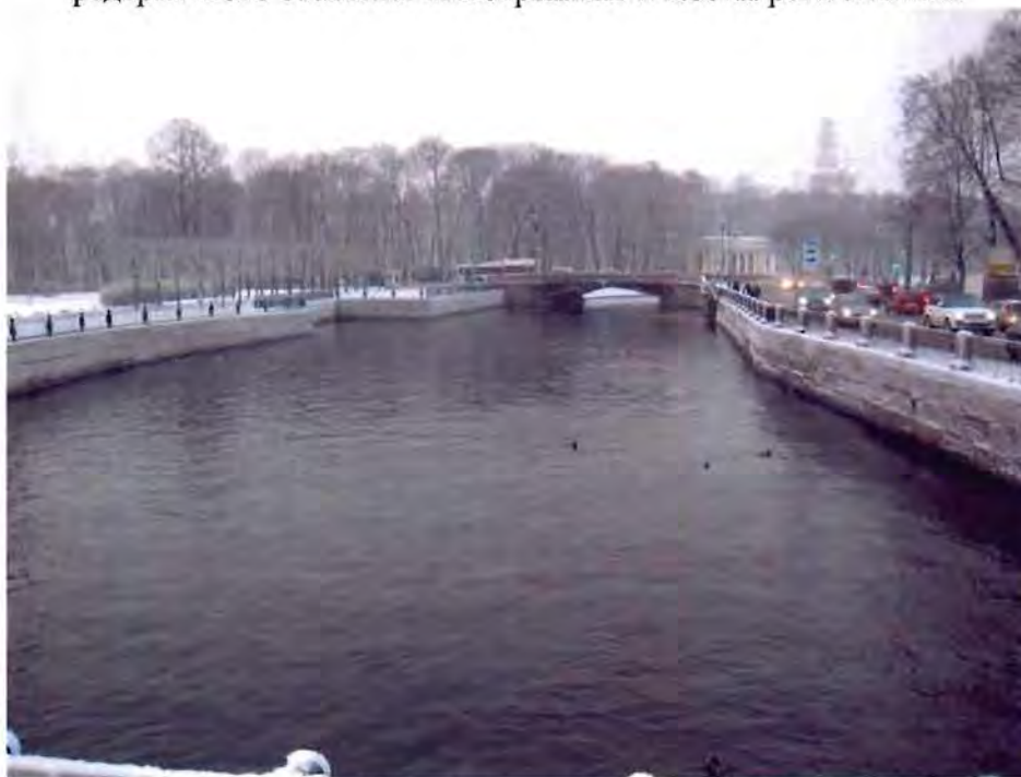
1. Набережные. Вид со стороны Инженерного Первого моста
