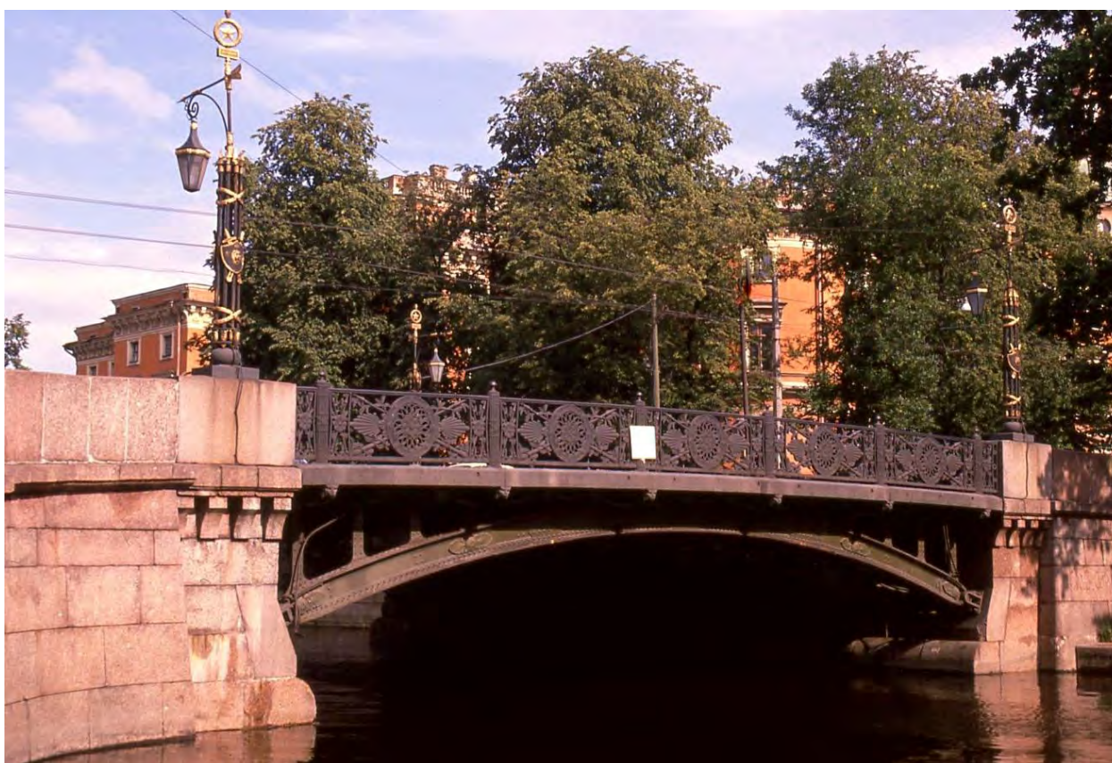
Илл. 15. 1-й Садовый мост. 1983-1990 г.
