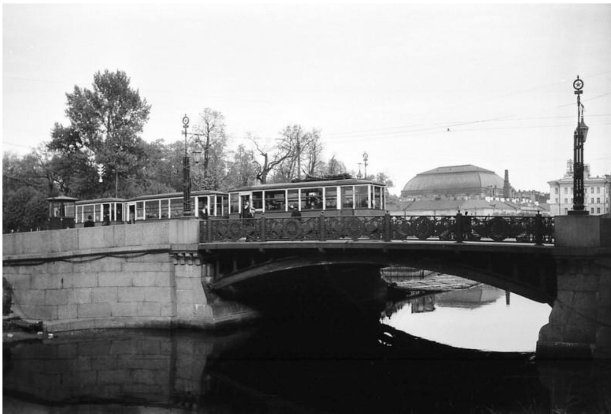
Илл. 14. 1-й Садовый мост. 1956 г.
