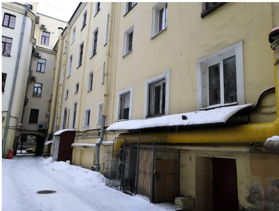
6. Объект культурного наследия федерального значения «Дом Демидова П.Г.», входящий в состав объекта культурного наследия федерального значения «Усадьба Демидовых», по адресу: г. Санкт-Петербург, пер. Гривцова, д. 5, лит. А (Гривцова пер., 1). Дворовый фасад. Фрагмент.
