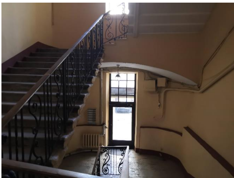
8. Объект культурного наследия федерального значения «Дом Демидова П.Г.», входящий в состав объекта культурного наследия федерального значения «Усадьба Демидовых», по адресу: г. Санкт-Петербург, пер. Гривцова, д. 5, лит. А (Гривцова пер., 1). Общий вид лестницы в здании.
