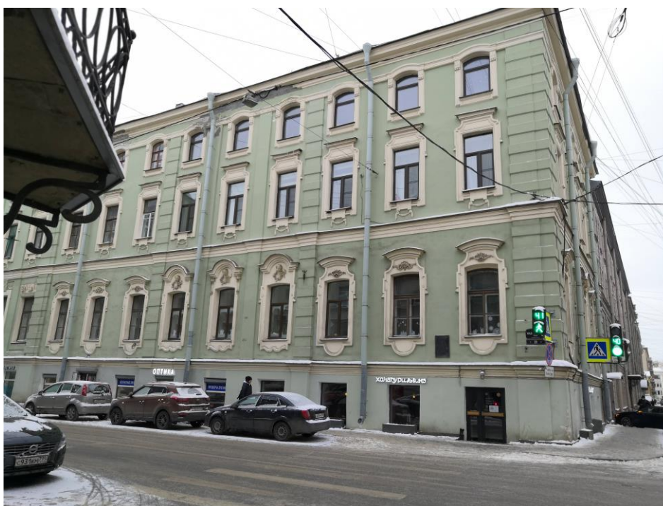
2. Объект культурного наследия федерального значения «Дом Демидова П.Г.», входящий в состав объекта культурного наследия федерального значения «Усадьба Демидовых», по адресу: г. Санкт-Петербург, пер. Гривцова, д. 5, лит. А (Гривцова пер., 1). Лицевой фасад по Казанской улице. Фрагмент фасада.
