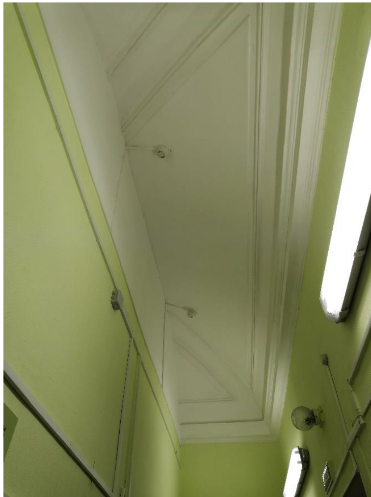
35. Объект культурного наследия федерального значения «Дом Демидова П.Г.», входящий в состав объекта культурного наследия федерального значения «Усадьба Демидовых», по адресу: г. Санкт-Петербург, пер. Гривцова, д. 5, лит. А (Гривцова пер., 1). Помещение 8-Н. В процессе эксплуатации в ряде помещений выполнена перепланировка с устройством перегородок и перебивкой отделки сводов помещений.
