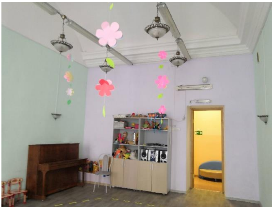
24. Объект культурного наследия федерального значения «Дом Демидова П.Г.», входящий в состав объекта культурного наследия федерального значения «Усадьба Демидовых», по адресу: г. Санкт-Петербург, пер. Гривцова, д. 5, лит. А (Гривцова пер., 1). Помещение 8-Н (помещение №16, общий вид).
