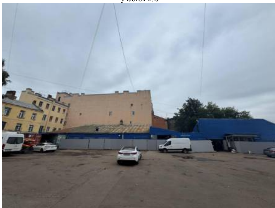
Фото 18. Фрагмент фасада объекта культурного наследия регионального значения «Сельдяной ряд Никольского рынка» и вид на территорию кадастрового участка 78:32:0001066:1815 по адресу: г.Санкт-Петербург, набережная Крюкова канала, земельный участок 25а
