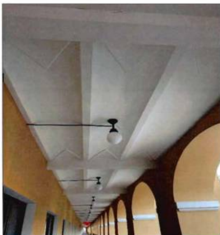
11. Фрагмент обходной галереи вдоль ул. Садовой. Своды
