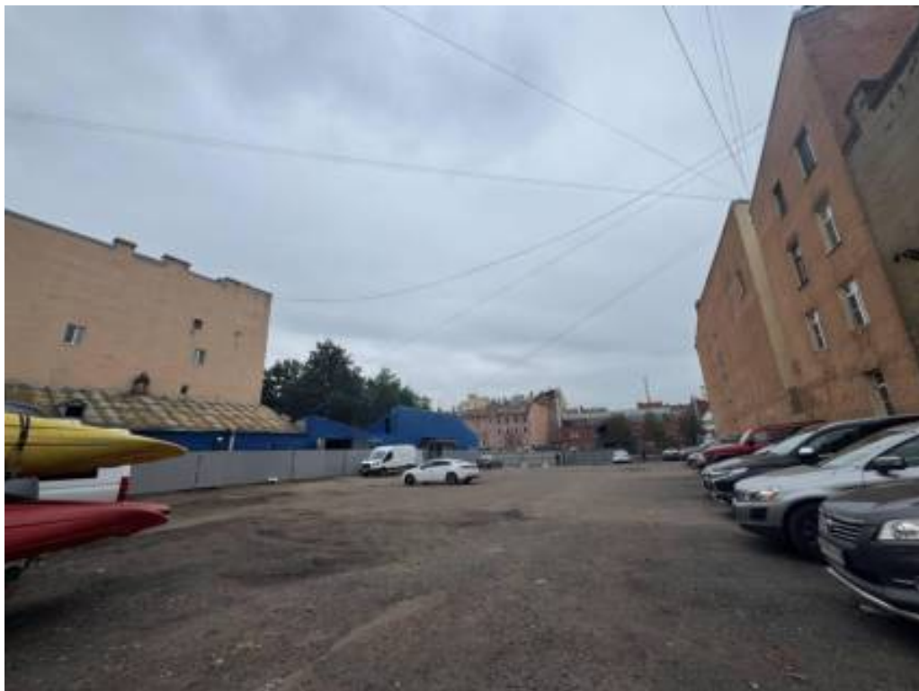
Фото 19. Фрагмент фасада объекта культурного наследия регионального значения «Сельдяной ряд Никольского рынка» и вид на территорию кадастрового участка 78:32:0001066:1815 по адресу: г.Санкт-Петербург, набережная Крюкова канала, земельный участок 25а
