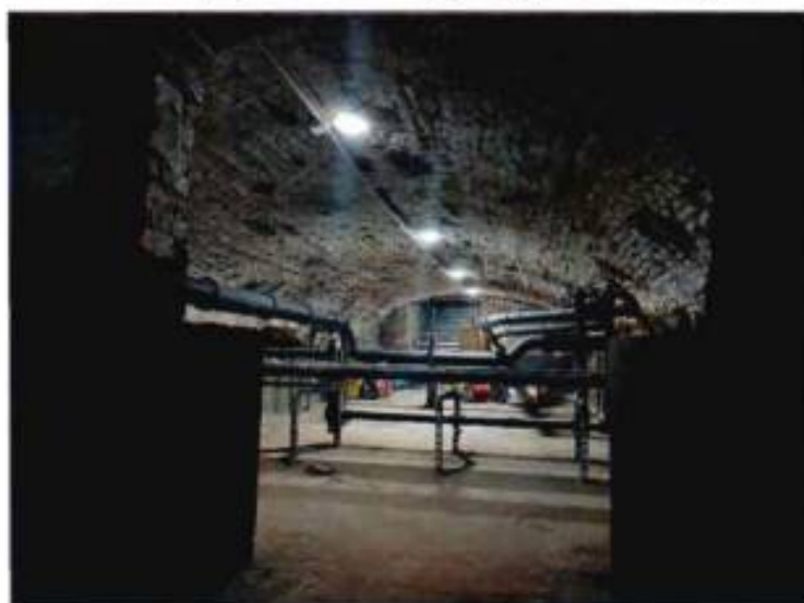
5. Подвалы объекта культурного наследия. Своды.
