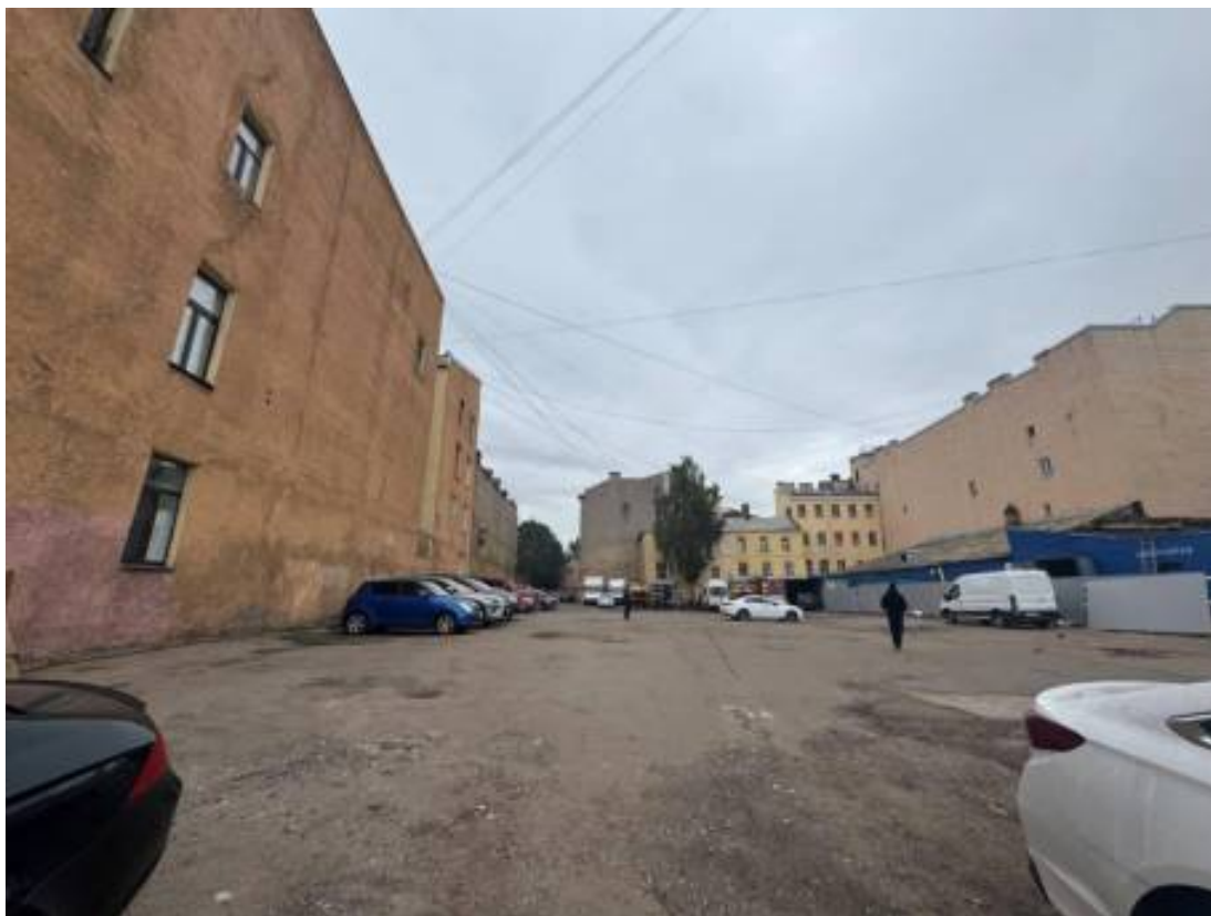
Фото 17. Фрагмент фасада объекта культурного наследия регионального значения «Сельдяной ряд Никольского рынка» и вид на территорию кадастрового участка 78:32:0001066:1815 по адресу: г.Санкт-Петербург, набережная Крюкова канала, земельный участок 25а
