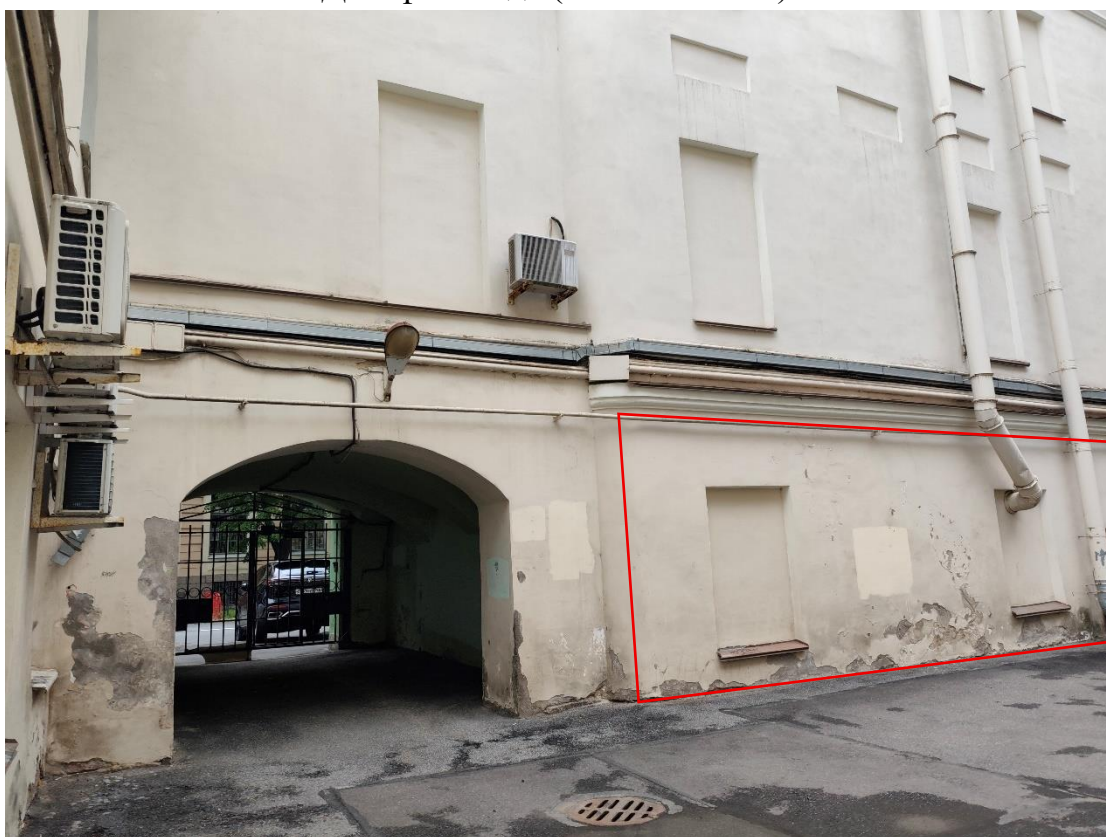
Фото 14. Вид на дворовые фасады выявленного объекта культурного наследия «Дом фон Лоде (А.Г. Елисеева)». Красным отмечены проемы помещения 1-Н.
