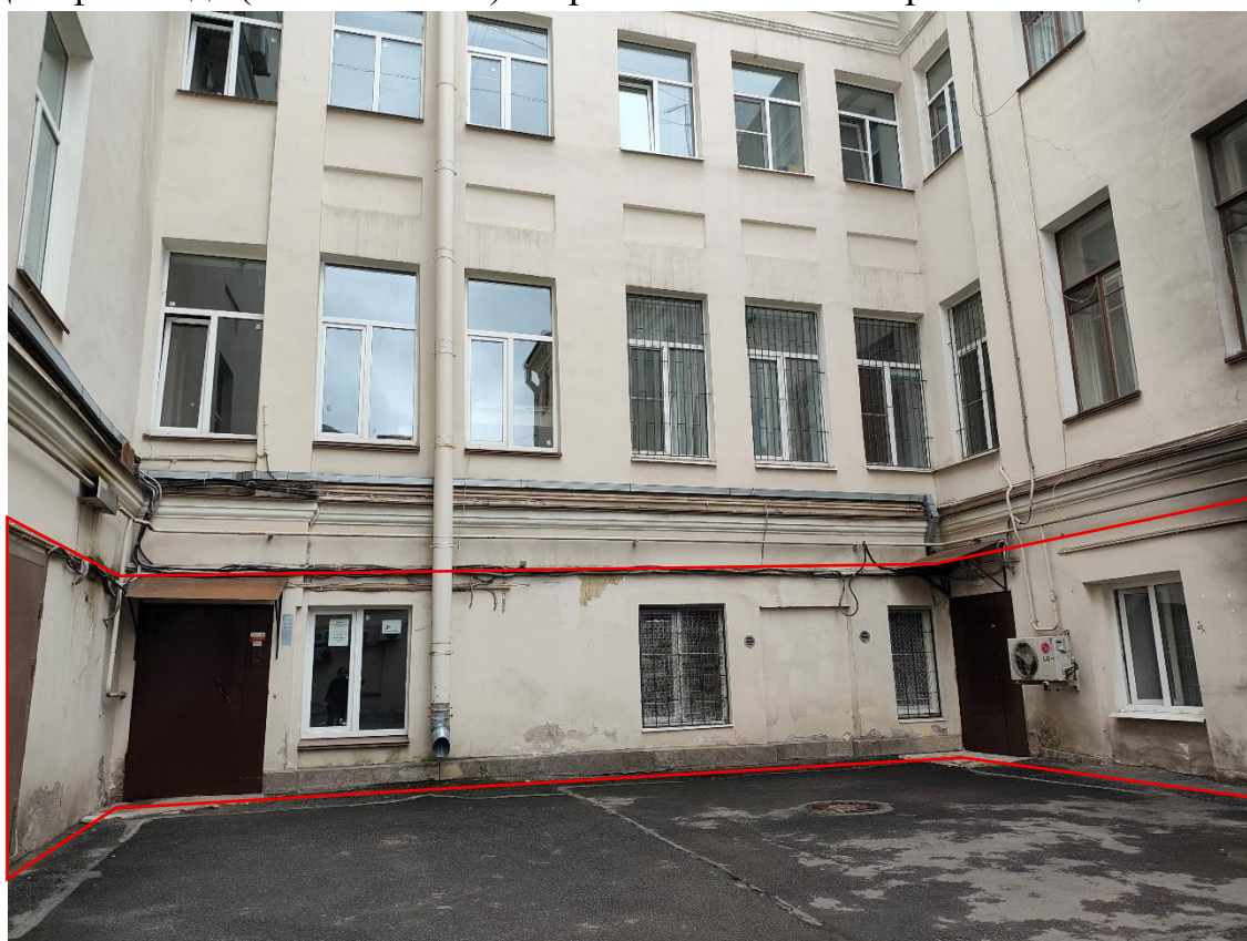
Фото 16. Вид на дворовые фасады выявленного объекта культурного наследия «Дом фон Лоде (А.Г. Елисеева)». Красным отмечены проемы помещения 1-Н.
