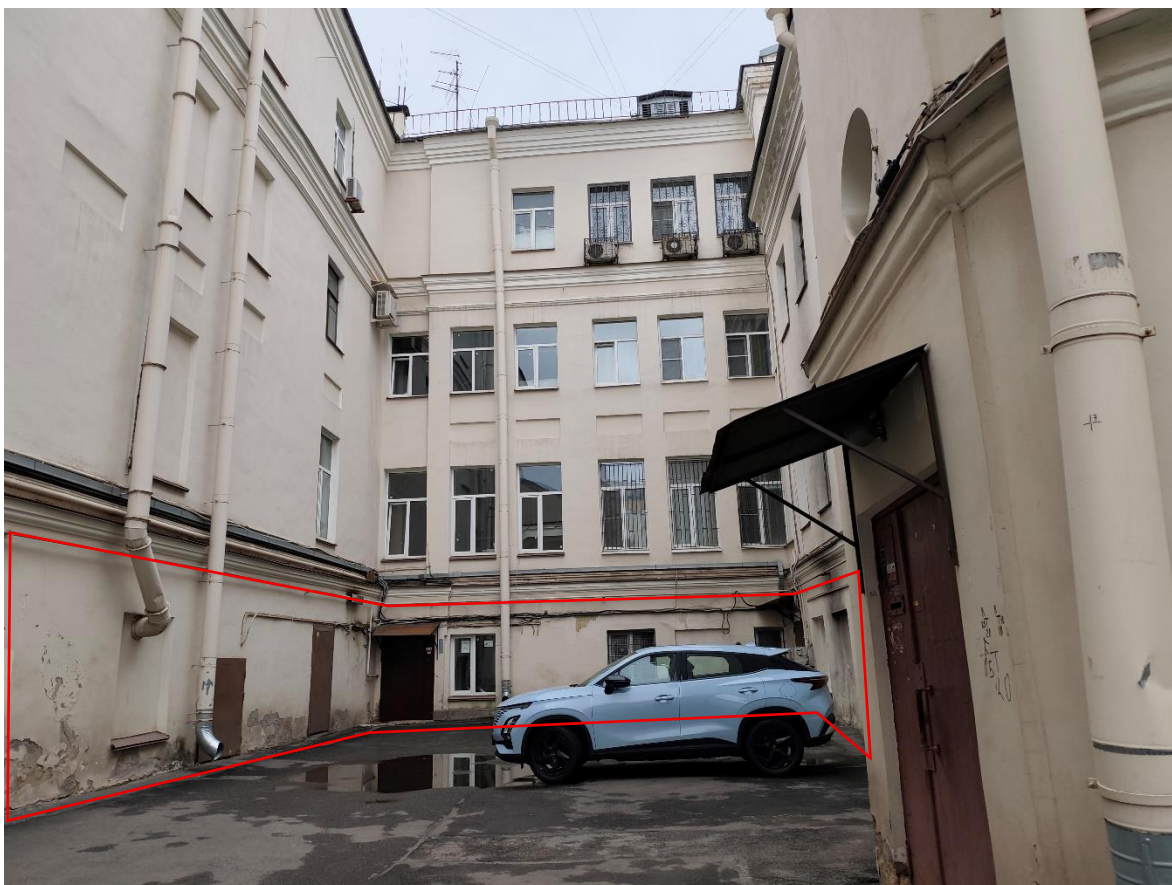
Фото 15. Вид на дворовые фасады выявленного объекта культурного наследия «Дом фон Лоде (А.Г. Елисеева)». Красным отмечены проемы помещения 1-Н.
