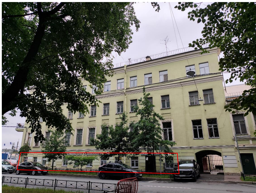
Фото 8. Вид на лицевой фасад выявленного объекта культурного наследия «Дом фон Лоде (А.Г. Елисеева) по 5-й линии В.О. Красным отмечены проемы помещения 1-Н.
