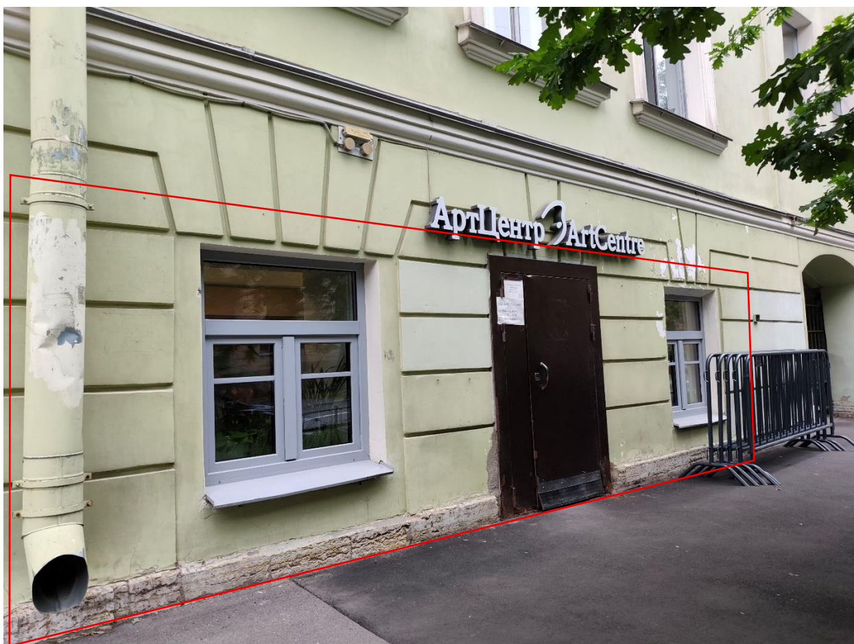
Фото 7. Вид на лицевой фасад выявленного объекта культурного наследия «Дом фон Лоде (А.Г. Елисеева) по 5-й линии В.О. Красным отмечены проемы помещения 1-Н.
