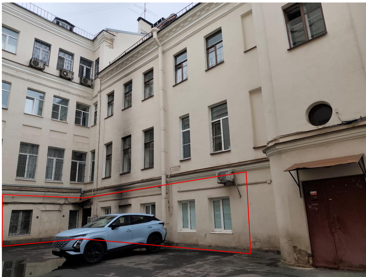
Фото 17. Вид на дворовые фасады выявленного объекта культурного наследия «Дом фон Лоде (А.Г. Елисеева)». Красным отмечены проемы помещения 1-Н.
