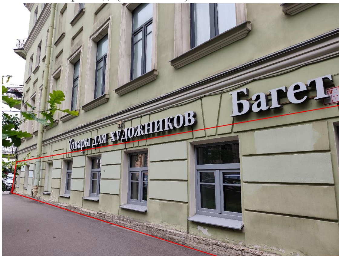
Фото 6. Вид на лицевой фасад выявленного объекта культурного наследия «Дом фон Лоде (А.Г. Елисеева) по 5-й линии В.О. Красным отмечены проемы помещения 1-Н.
