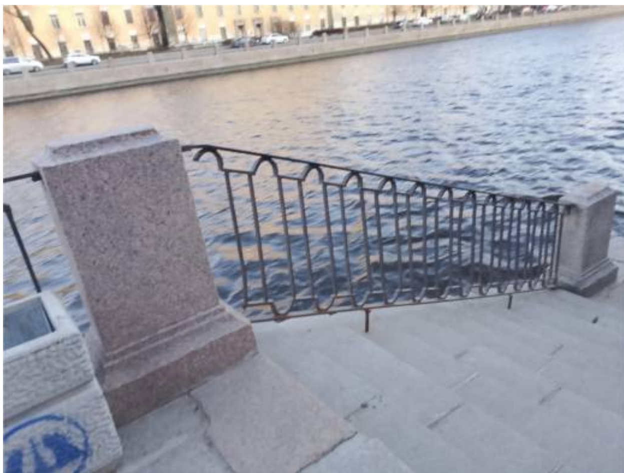
11. Ограждение восточной лестницы спуска: рисунок не согласован с расположением тумб, вместо фигурных опор использованы прямые стойки.
