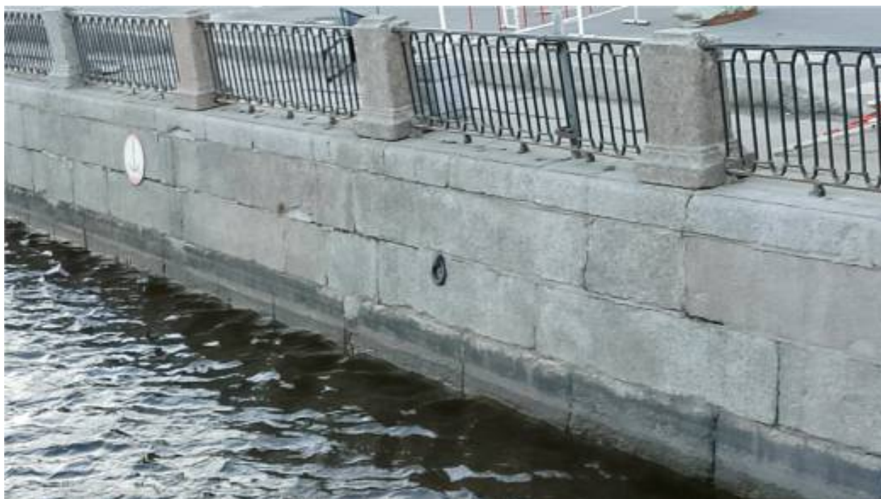
2. Восточная часть стенки набережной. Утраты шовного раствора, сколы блоков облицовки, намокание и биопоражение по границе с уровнем воды.
