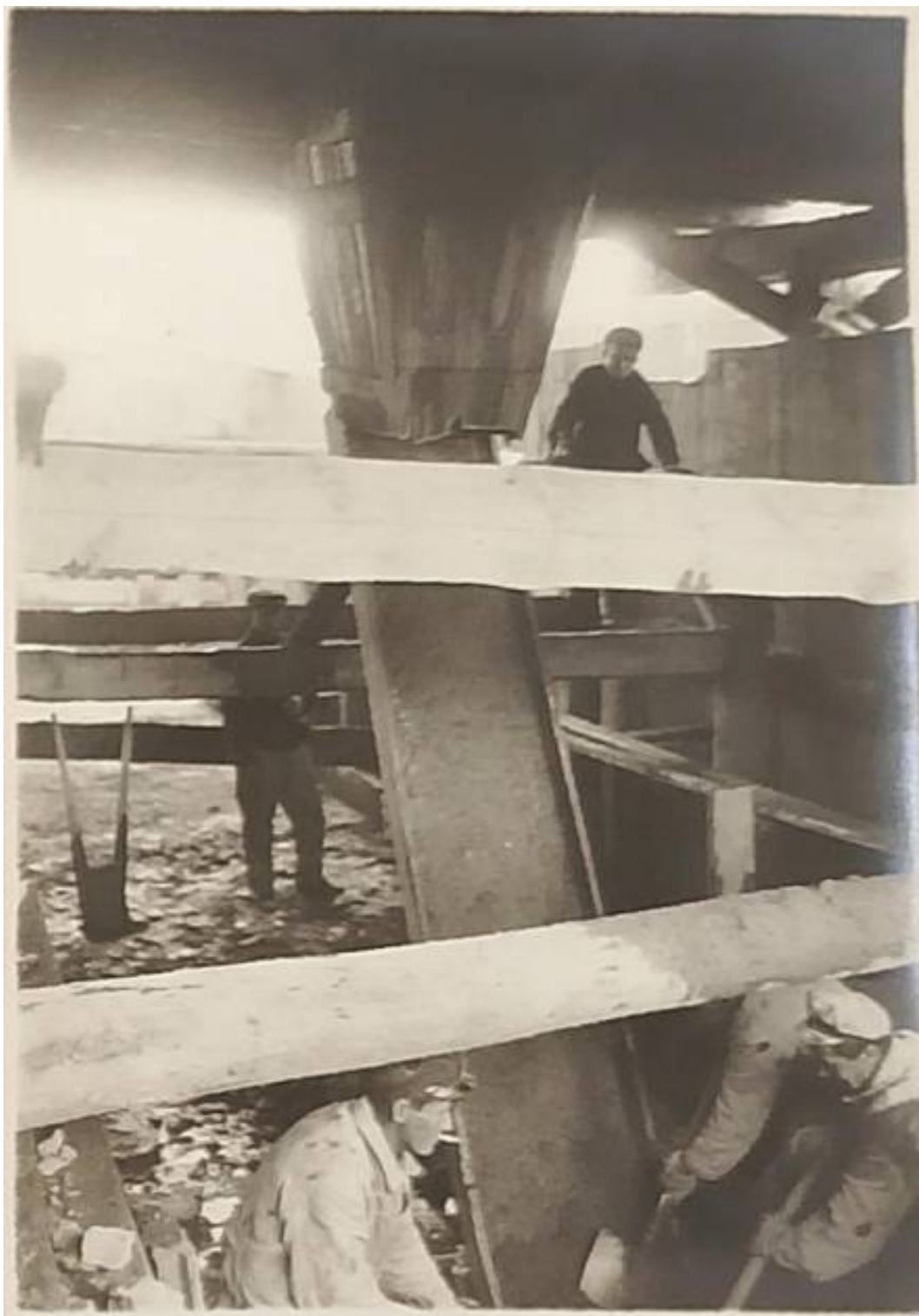
16. Бетонирование котлована (у д. 109). Автор фото Л.Г. Андреевский. 1928. Архив Мостотреста. Папка 98/5. №36.
