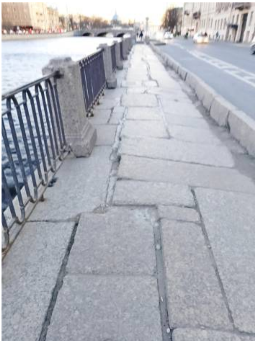
8. Тротуар к востоку от спуска. Плиты имеют выраженный неравномерный уклон в сторону проезжей части.
