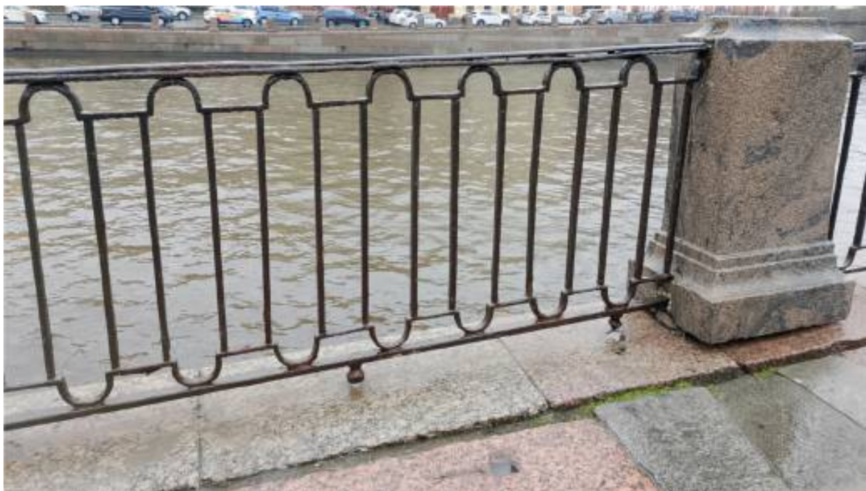
19. Зависание тумбы, утрата шовного заполнения и биопоражение швов между карнизным камнем и плитами тротуара.
