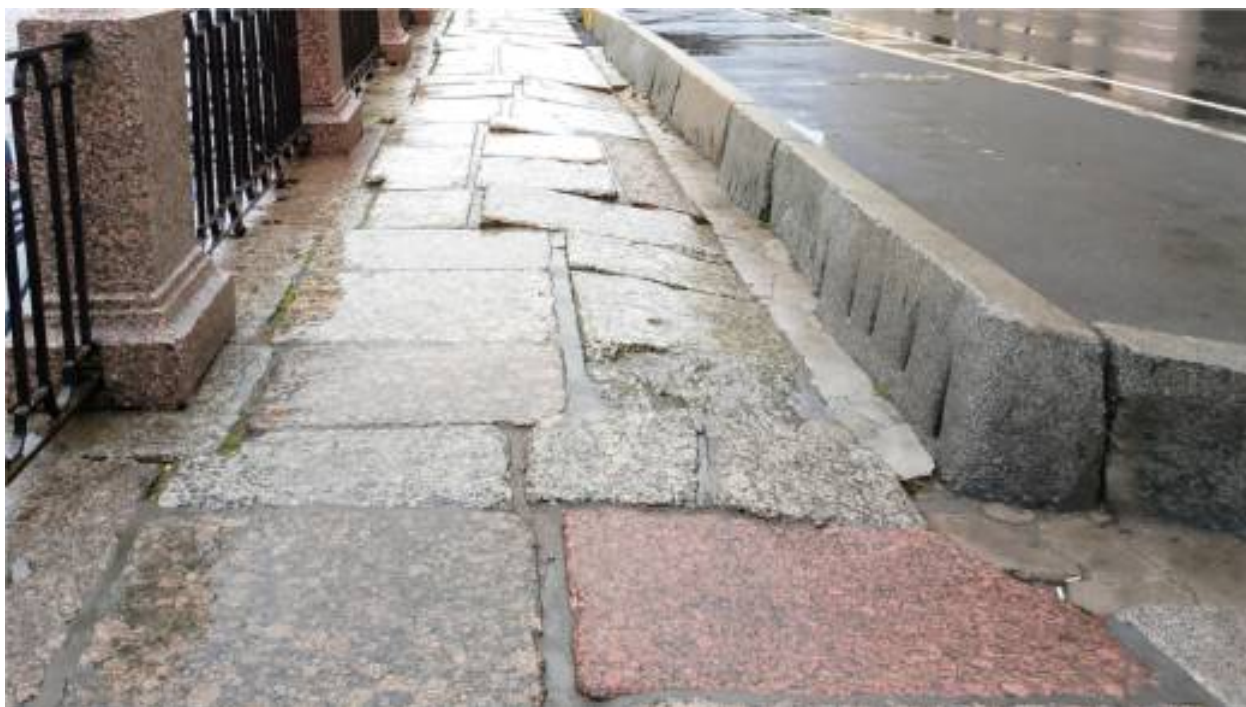
15. Западная часть тротуара, вид в сторону Обуховского моста. Плиты имеют выраженный наклон к проезжей части, один из блоков расколот. Имеются сколы, утраты шовного заполнения, биопоражение швов.
