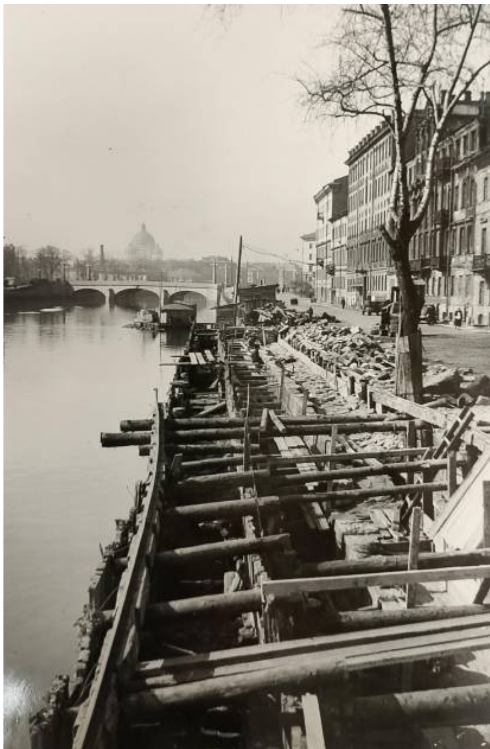
33. Капитальный ремонт набережной у д.93-101. 1957. Архив Мостотреста. Папка 98/4.
