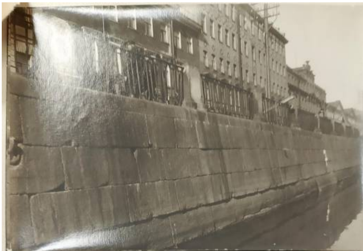
12. Разборка стенки набережной у домов 105-109. Автор фото Л.Г. Андреевский. 1928. Архив Мостотреста. Папка 98/5. №18.
