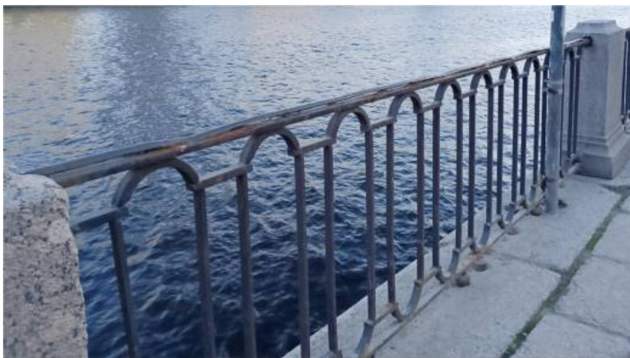
5. Металлическая секция ограждения: коррозия, утрата окрасочных слоёв, деформация поручня.
