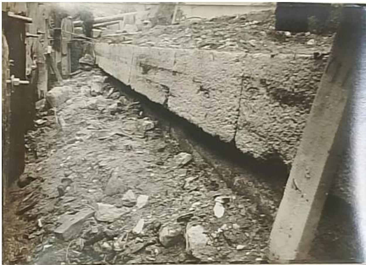
20. Разборка подпорной стенки наб. р Фонтанки у д. 105-109. Автор фото Л.Г. Андреевский. 1928. Архив Мостотреста. Папка 98/5. № 28.
