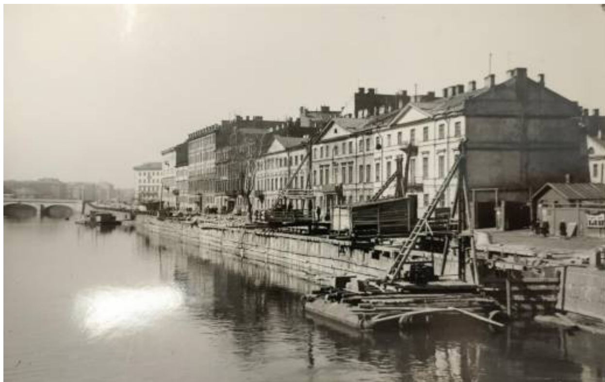
31. Капитальный ремонт набережной у д.93-101. 1957. Архив Мостотреста. Папка 98/4.
