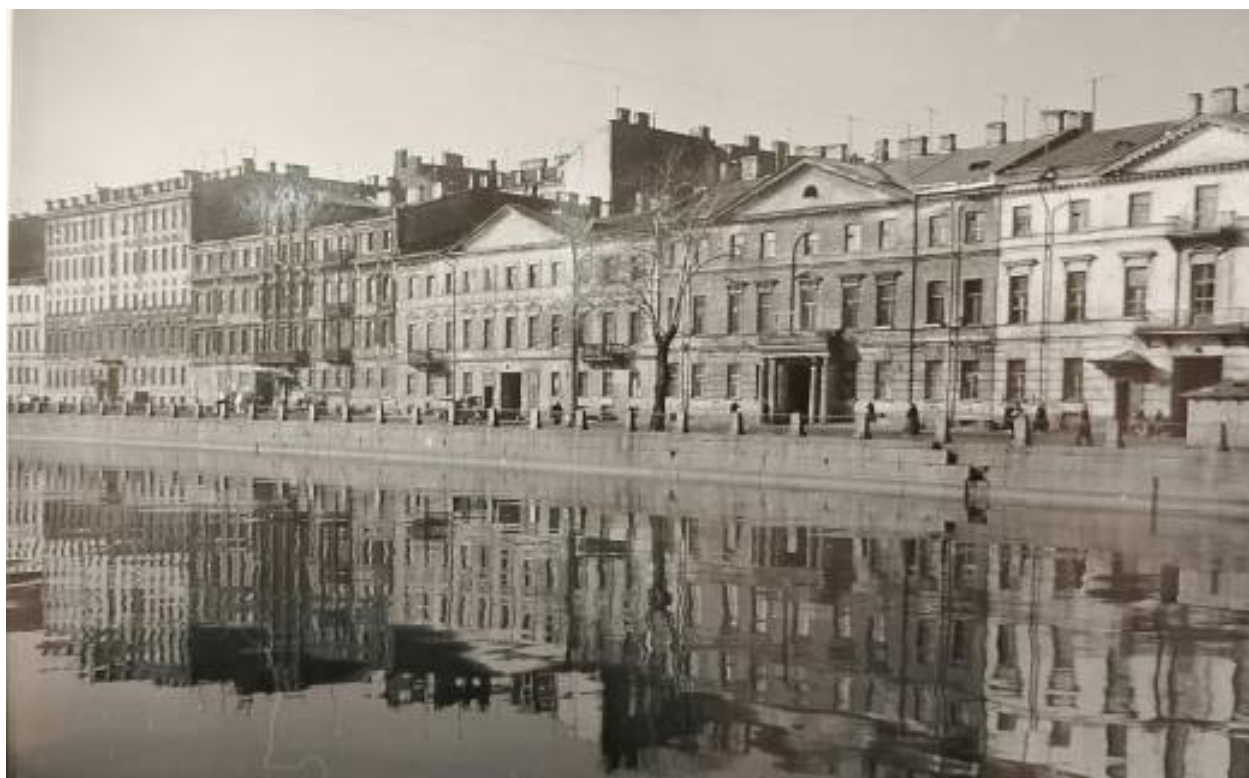
32. Капитальный ремонт набережной у д.93-101. 1957. Архив Мостотреста. Папка 98/4.
