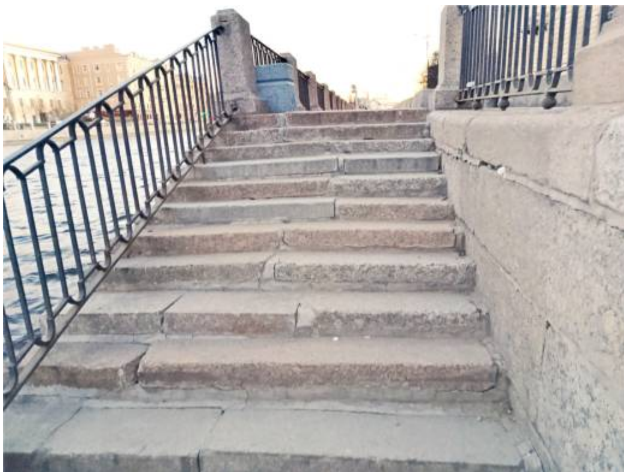
13. Западная лестница спуска: южные ступени имеют наклон в сторону воды, присутствует растрескивание швов, сколы в углах ступеней частично замастикованы цементным раствором.
