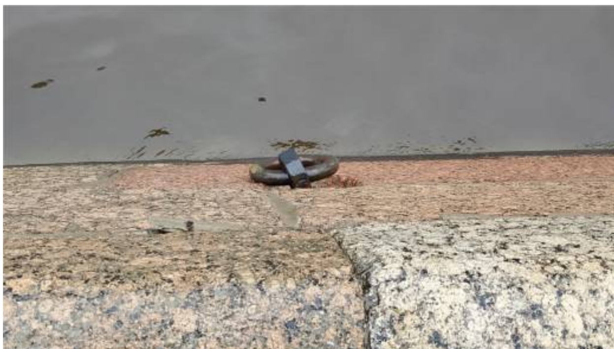
27. Рым: следы коррозии, загрязнение.
