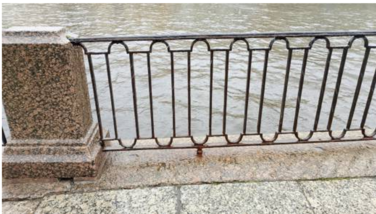
18. Историческая (кованая) секция ограждения. Опора корродирована и истёрта. В карнизном камне имеются многочисленные выбоины.
