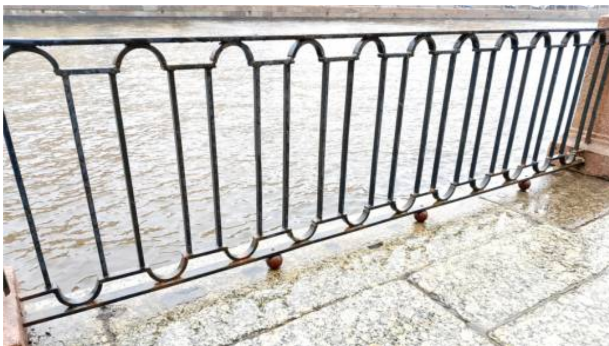
17. Поздняя (сварная) секция ограждения на опорах-шарах. Присутствуют следы коррозии.
