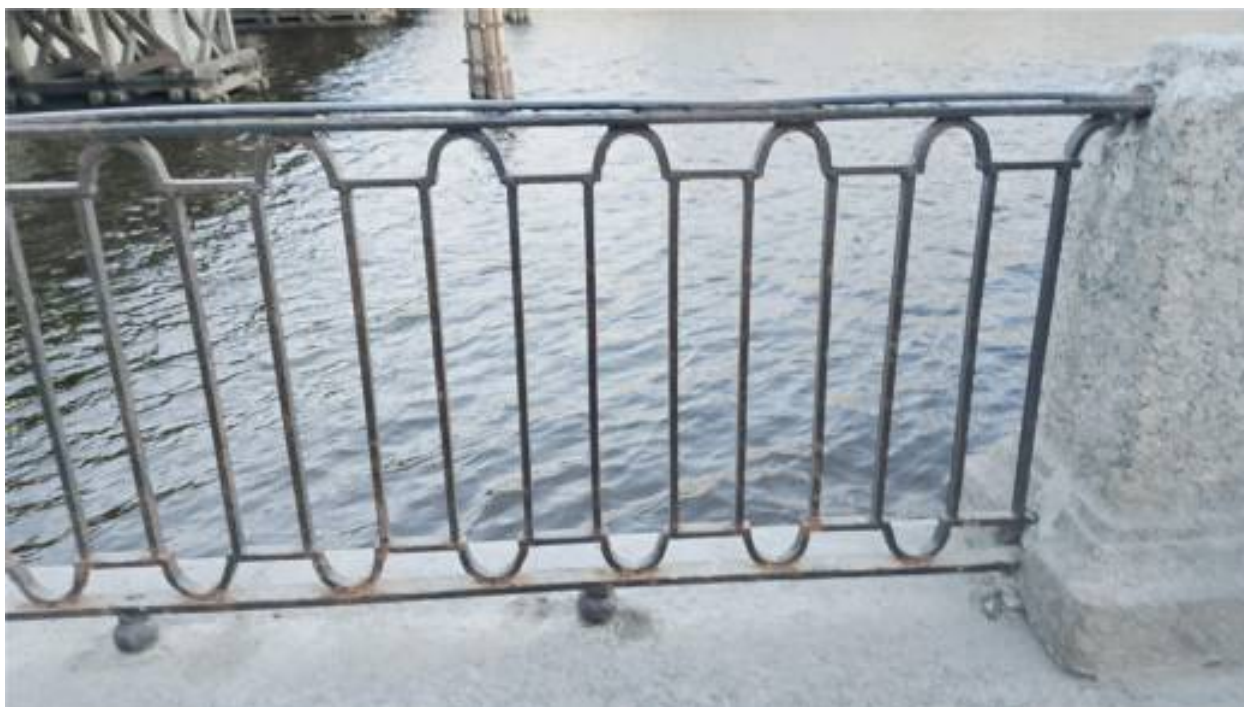
3. Металлическая секция ограждения: коррозия, утрата окрасочных слоёв, деформация поручня.
