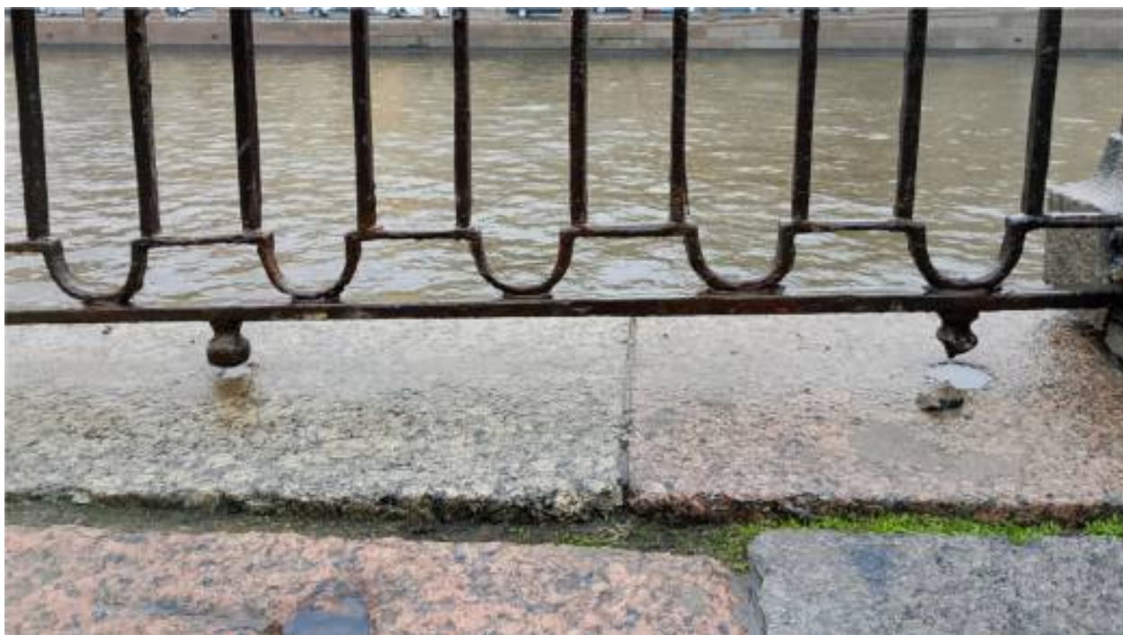
20. Историческая (кованая) секция ограждения. Коррозия, отслоение металла. Опоры корродированы и истёрты.
