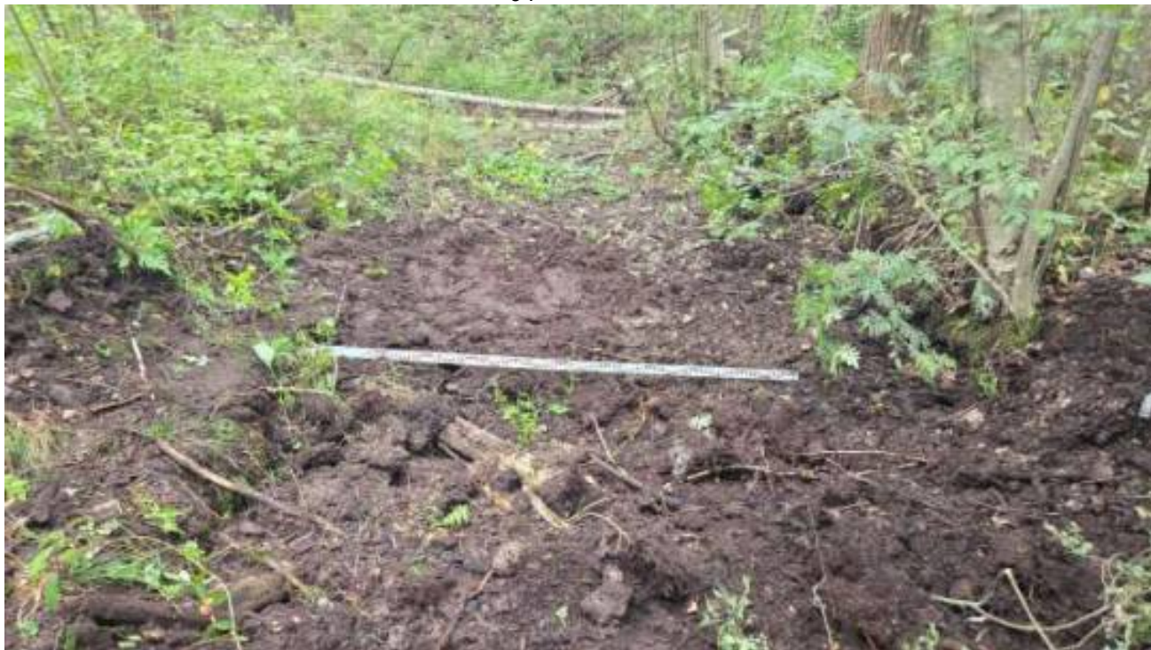
Рис. 29. ЛО-2026. Пушкинский район. Шушары. Шурф 2. Рекультивация. Вид с востока
