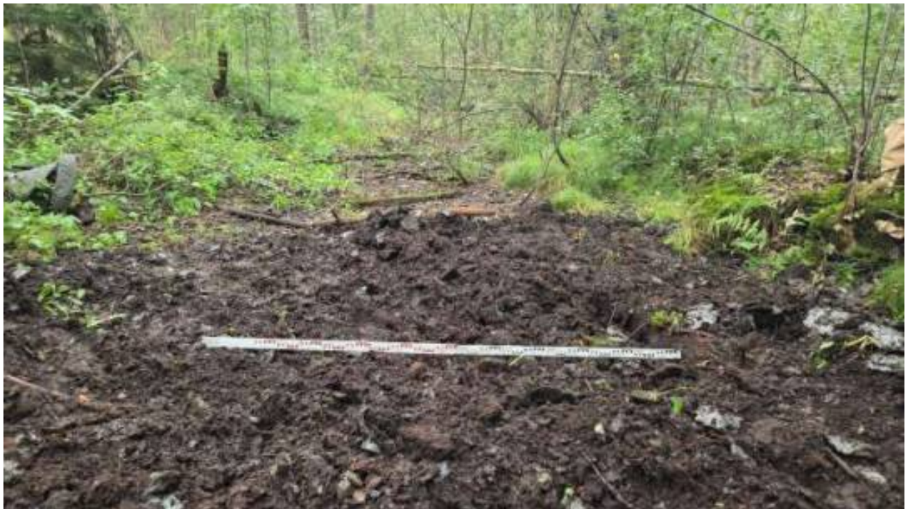
Рис. 34. ЛО-2026. Пушкинский район. Шушары. Шурф 3. Рекультивация. Вид с востока
