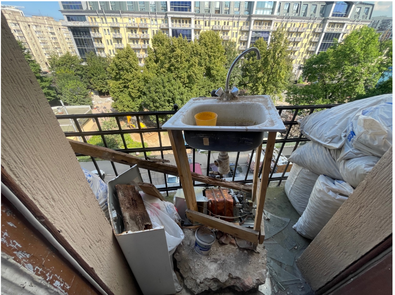
12.Общий вид балкона.
