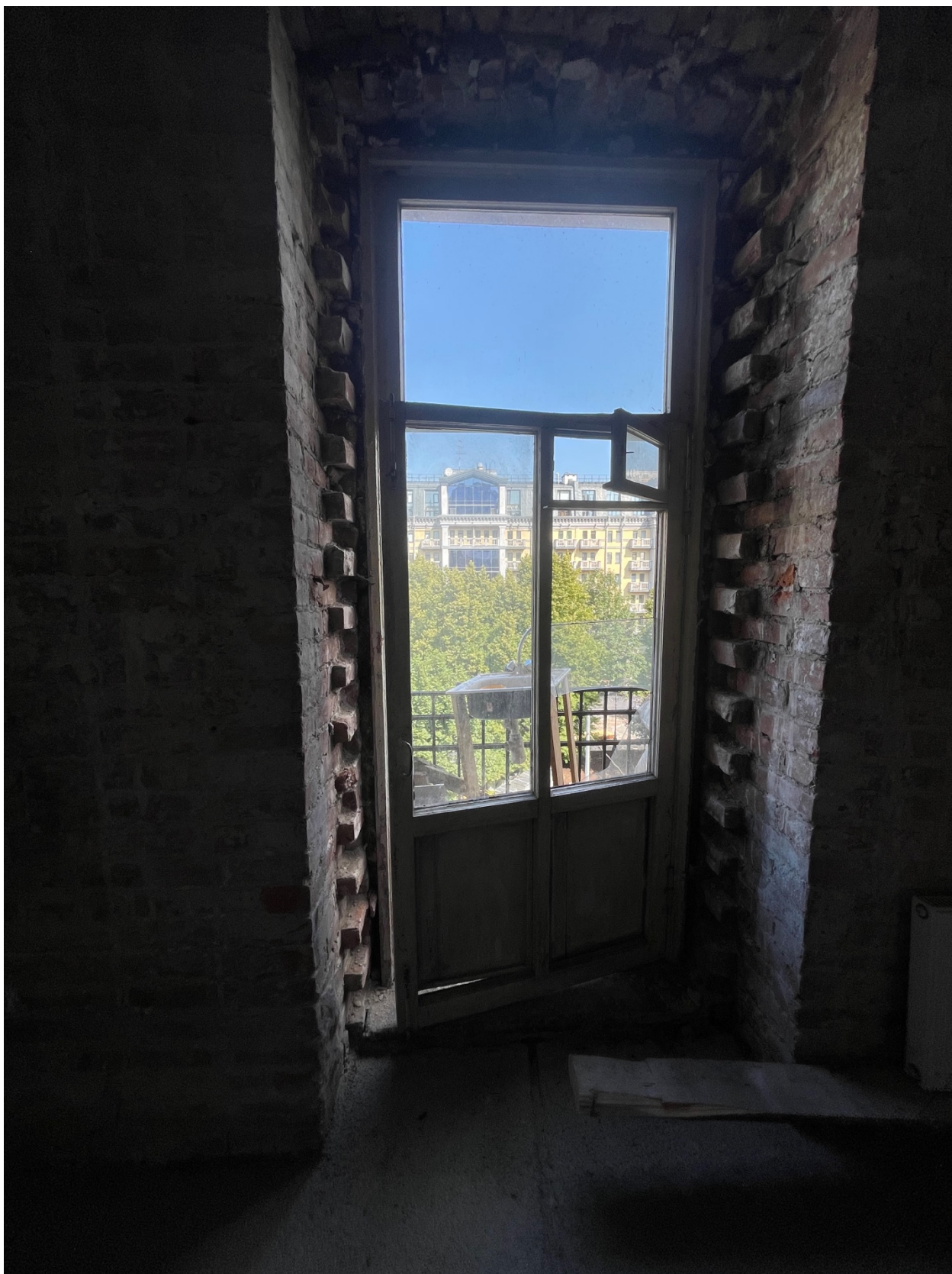
11.Балконное дверное заполнение.
