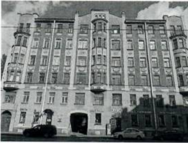
1. Фасад по 8-й линии В.О.
