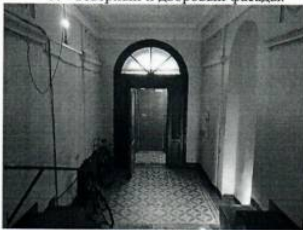
7. Интерьер. Вестибюль. Вид на входную дверь.
