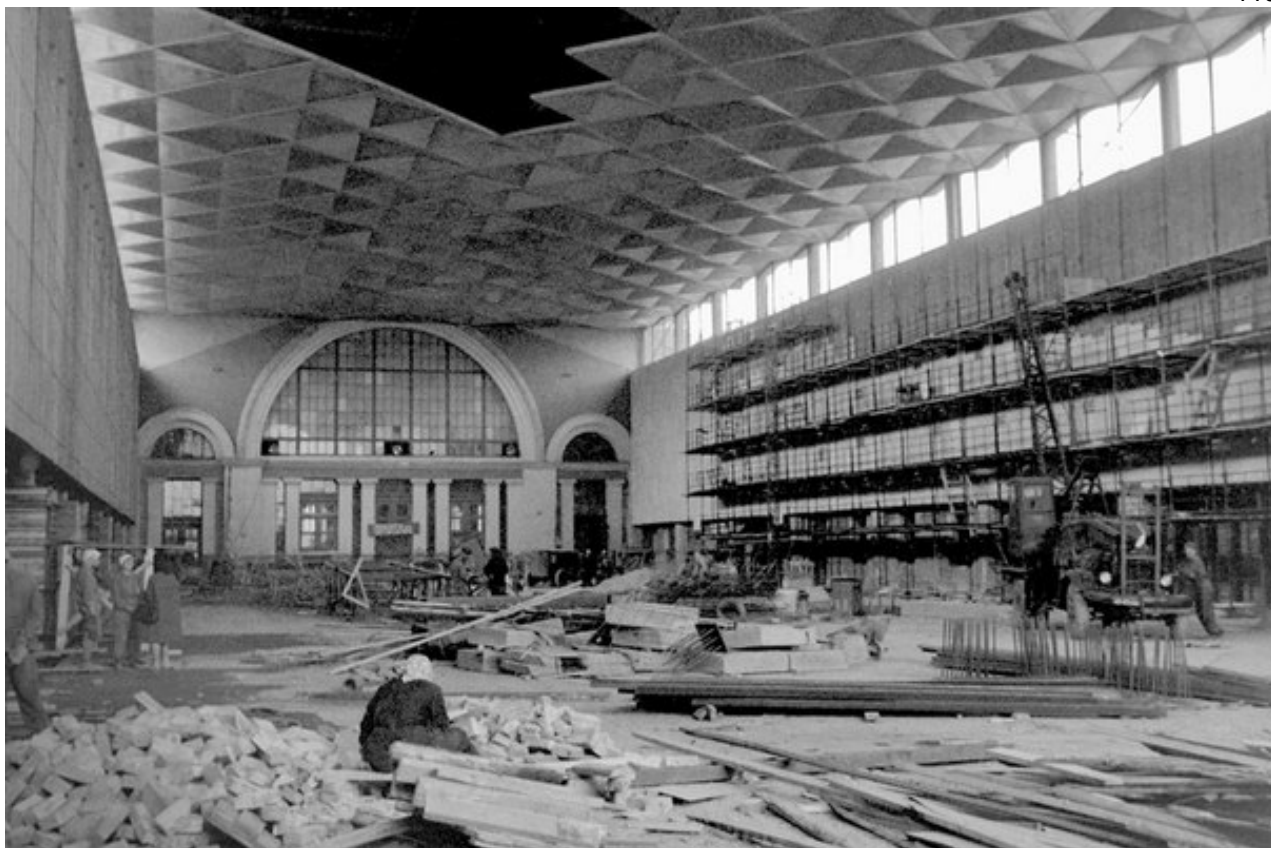
6. Здание Московского вокзала. 1967г. // Источник: https://pastvu.com/p/214820?utm_medium=organic&utm_source=yandexsmartcamera
