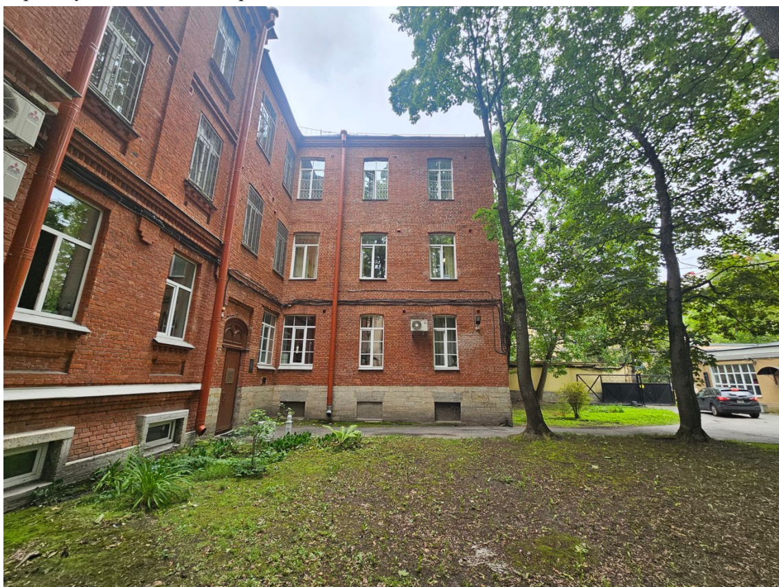
10. Фрагмент южного фасада «Флигеля» и фрагмент дворового фасада «Корпус южный», в составе объекта культурного наследия регионального значения «Лечебница для нервнодушевнобольных Бари А.Э.».
