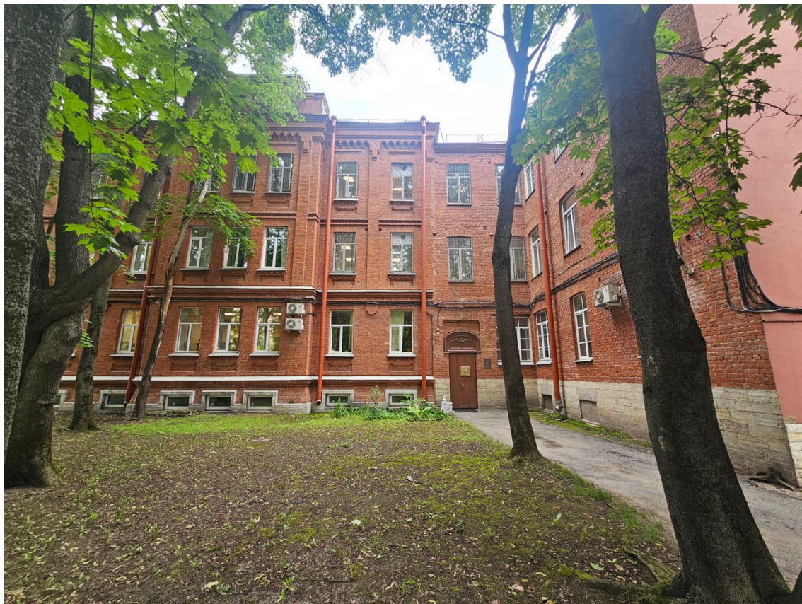
9. Фрагмент южного фасада «Флигеля» и фрагмент дворового фасада «Корпус южный», в составе объекта культурного наследия регионального значения «Лечебница для нервнодушевнобольных Бари А.Э.».
