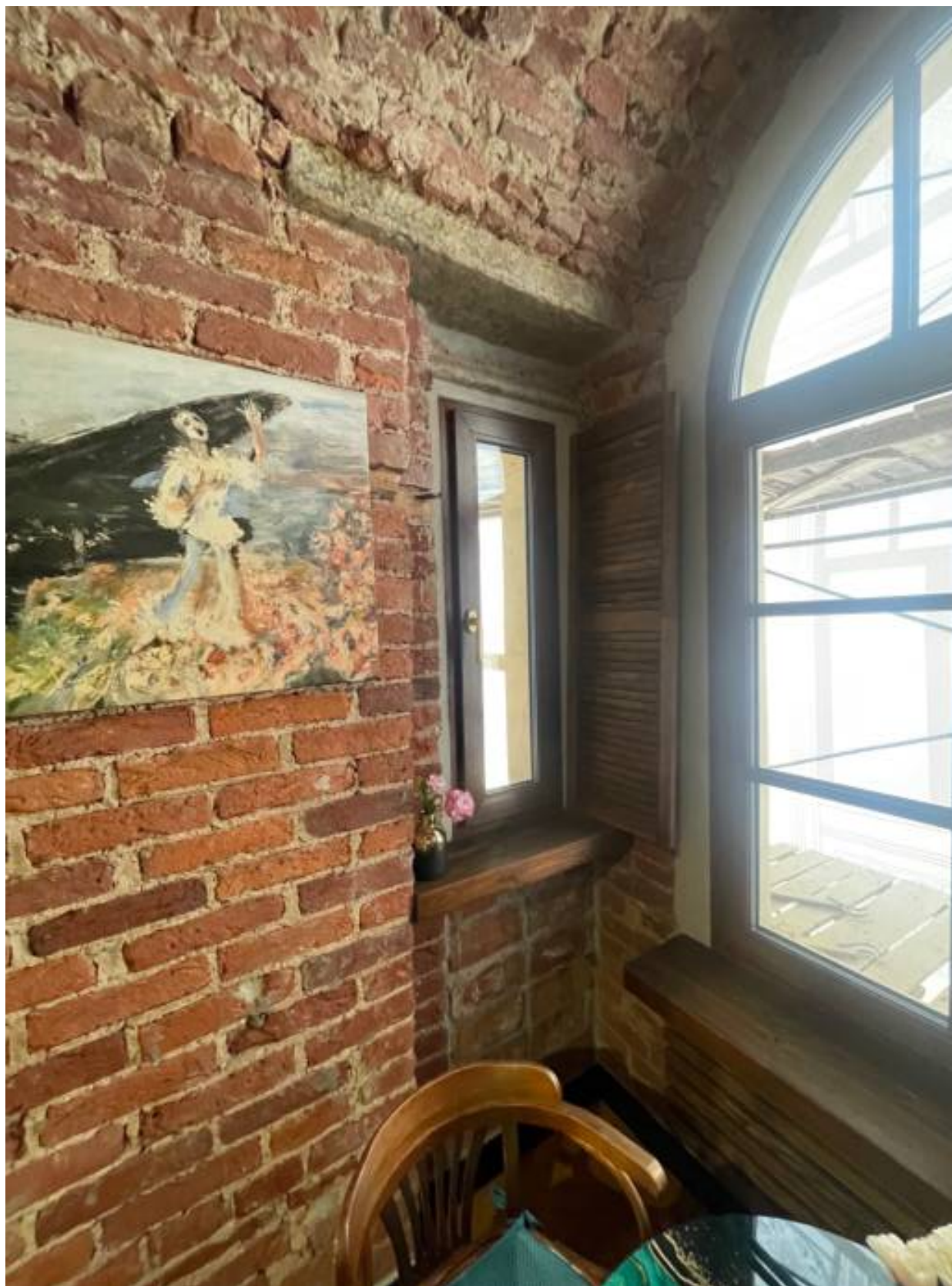
5. Вид на оконные заполнения в помещении 1.
