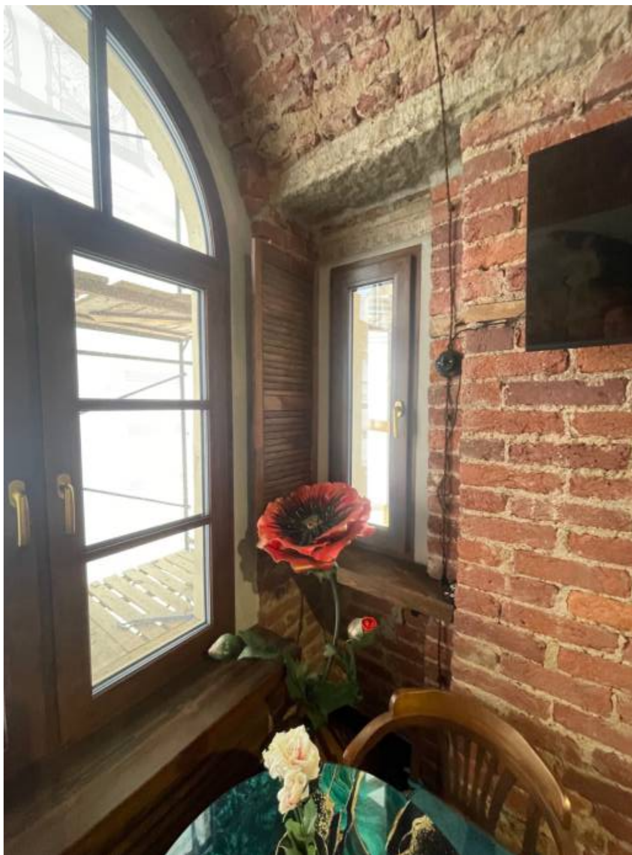
6. Вид на оконные заполнения в помещении 1.
