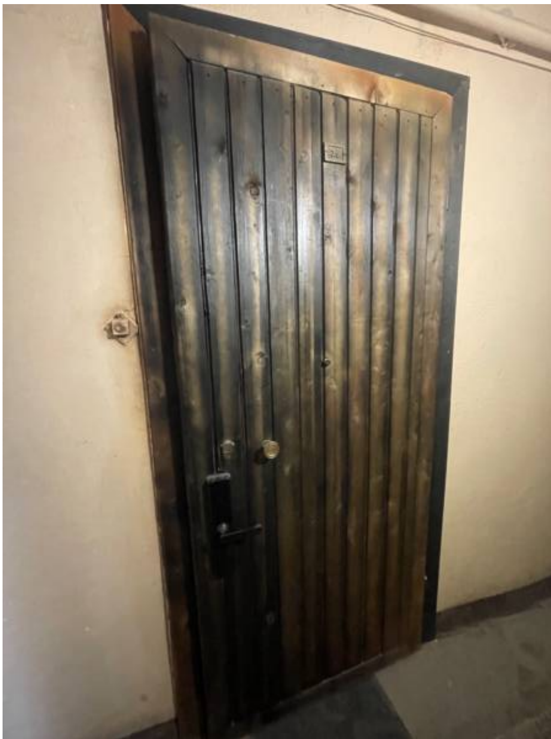
2. Вид на входную дверь в квартиру.
